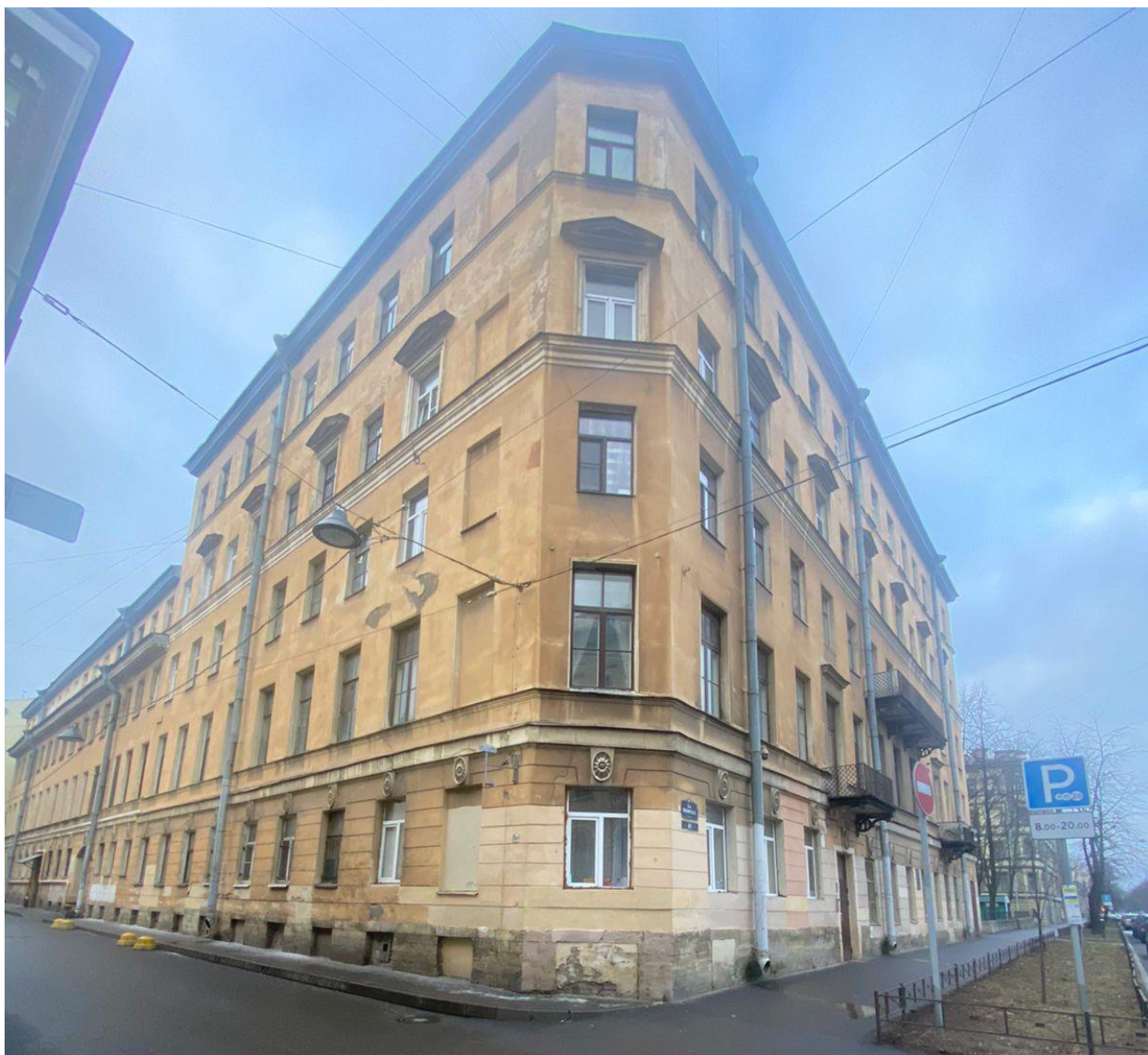
Фото 3. Фасад ОКН со стороны Академического переуллка и 5-я линия В.О
