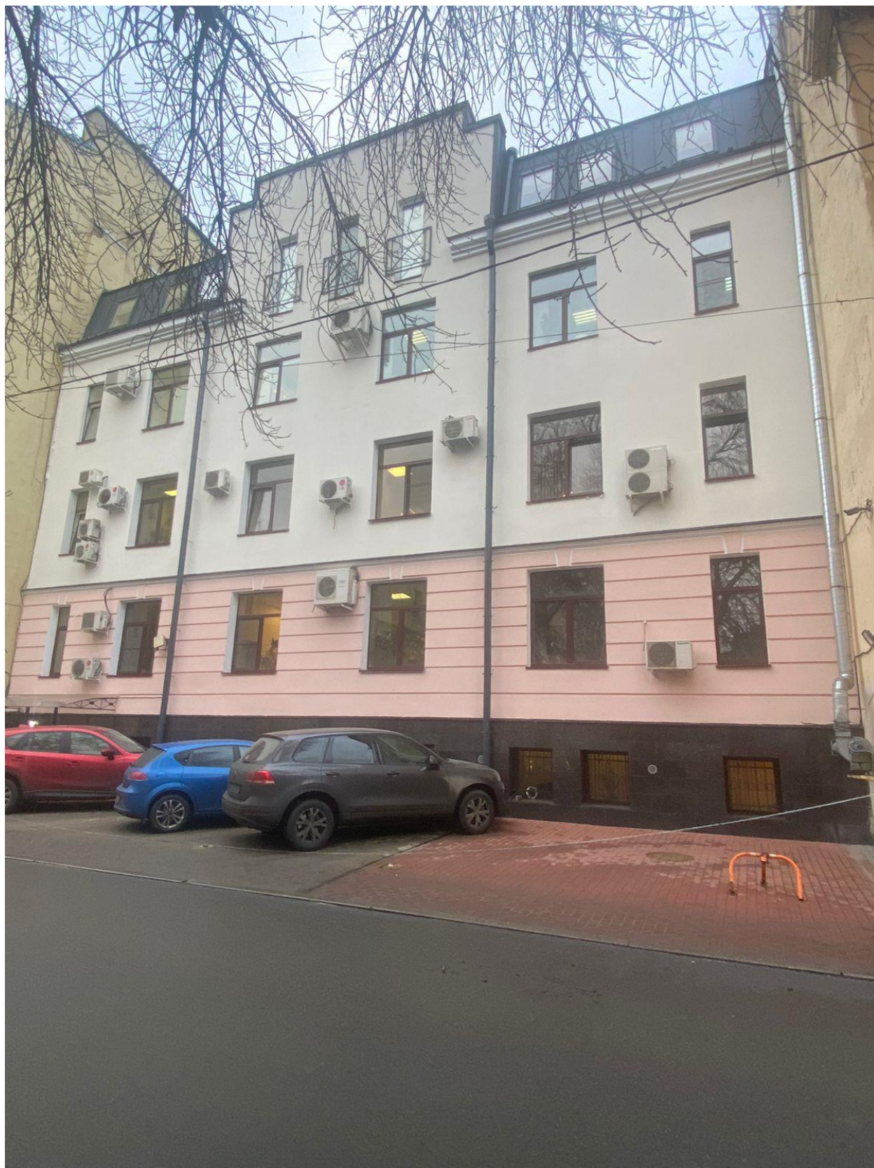
Фото 7. Общий вид фасада здания с Академического пер. по адресу: г.Санкт-Петербург, Бугский переулок, дом 4, литера А.
