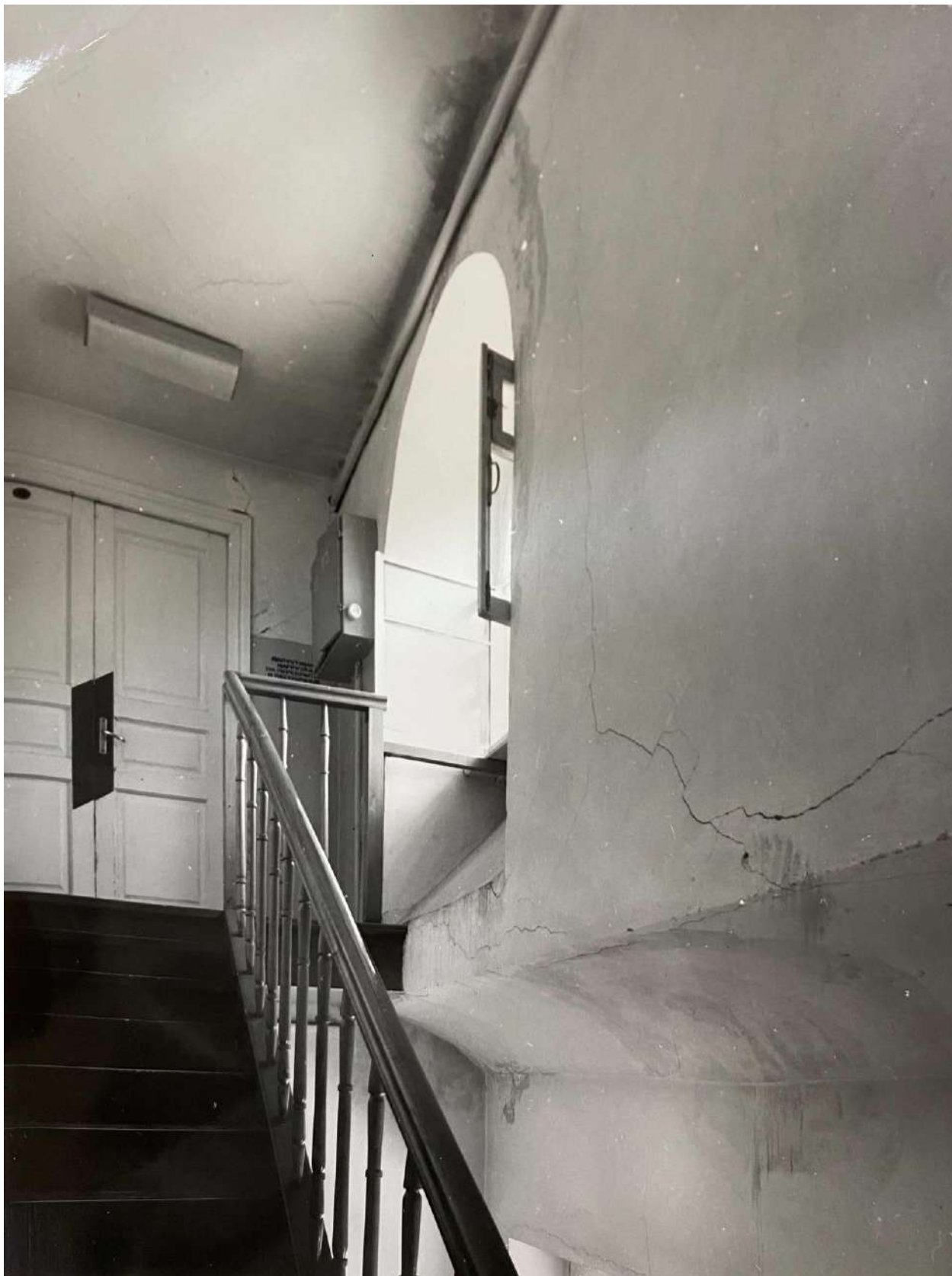
96. Ансамбль усадьбы Шуваловых. Малый дворец («Белый дом»). Фрагмент лестницы 3-го этажа. Дата: 1985 г. Автор: В.И. Шлакан // Архив КГИОП, № 55327/1-Н.
