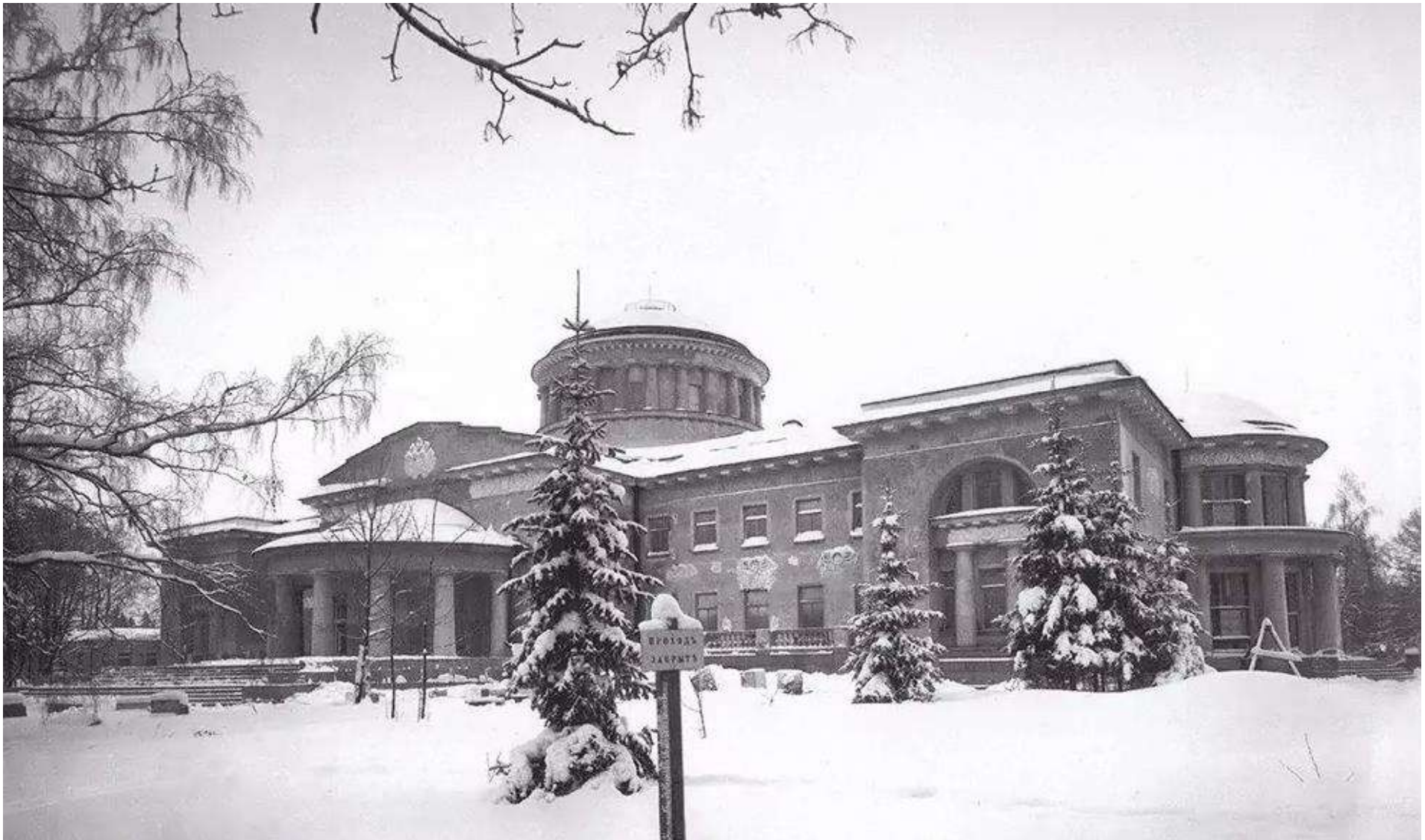
28. Большой дворец в Шуваловском парке. Дата: 1915 г. // С.Е. Глезерова «Парголово. Шуваловский парк».
