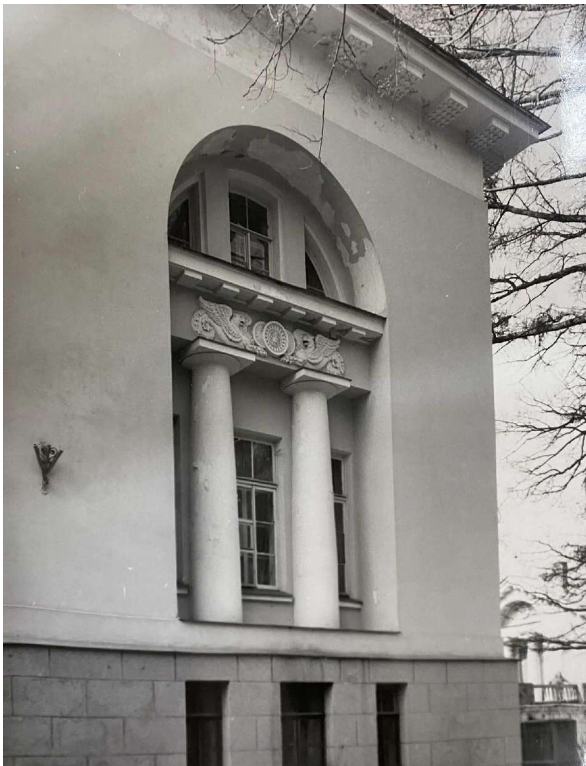
63. Ансамбль усадьбы Шуваловых (Е.А. Воронцовой-Дашковой). Большой дворец. Главный фасад (северный). Архитектурное оформление бокового ризалита. Дата: 1985 г. Автор: В.И. Шлакан // Архив КГИОП, № 55309/1-Н.
