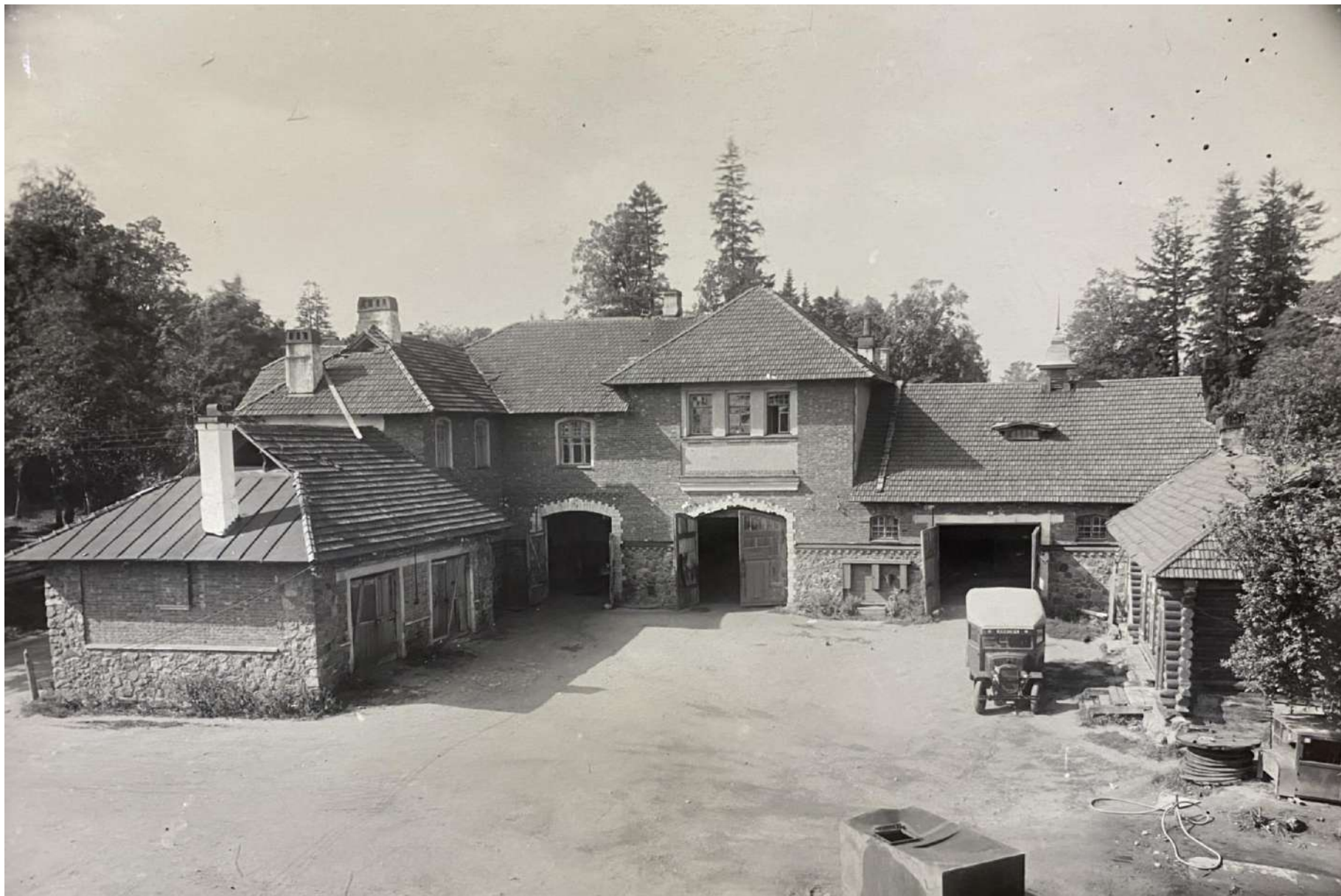
120. Шуваловский парк. Ферма. Восточный фасад. Дата: 1953 г. // Архив КГИОП, № 45209.
