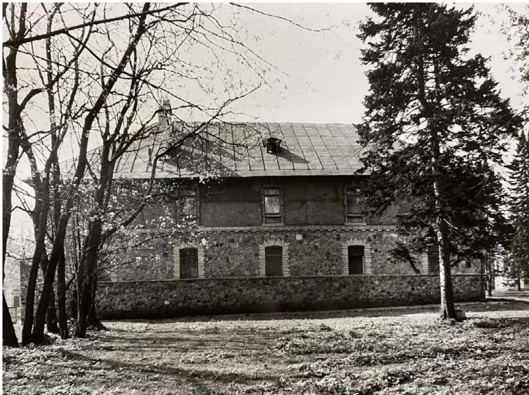
123. Ансамбль усадьбы Щуваловых. Ферма. Северный фасад. Дата: 1985 г. Автор: В.И. Шлакан // Архив КГИОП.
