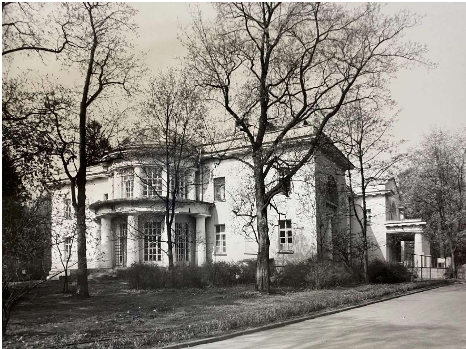
56. Ансамбль усадьбы Шуваловых (Е.А. Воронцовой-Дашковой). Большой дворец. Восточный фасад. Дата: 1985 г. Автор: В.И. Шлакан // Архив КГИОП, № 55303/1-Н.
