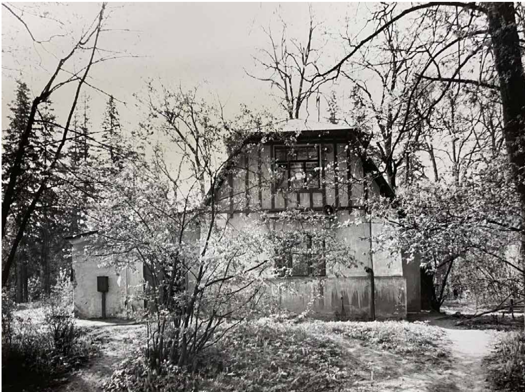
135. Ансамбль усадьбы Шуваловых. Дом садовника. Северный фасад. Дата: 1985 г. Автор: В.И. Шлакан // Архив КГИОП, № 55365/1-Н.
