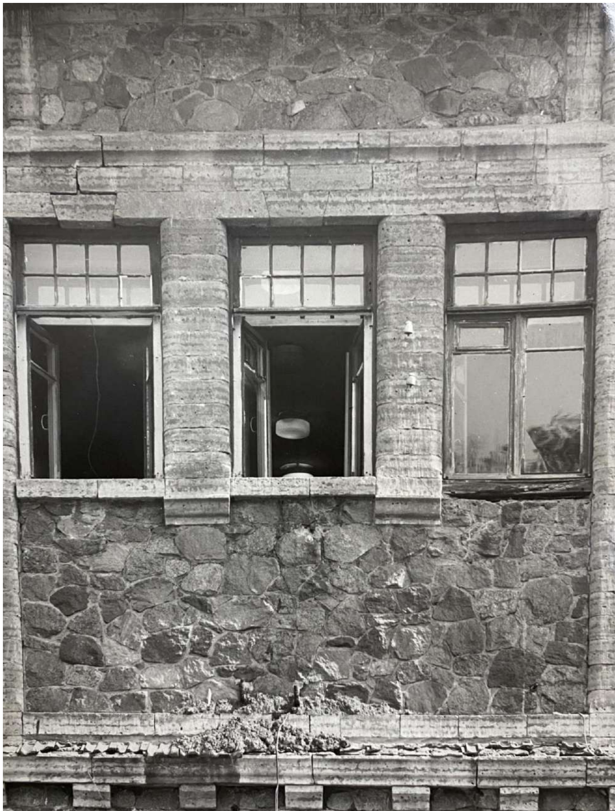
127. Ансамбль усадьбы Щуваловых. Ферма. Западный фасад. Центральный риаит. Окно 2-го этажа. Дата: 1985 г. Автор: В.И. Шлакан // Архив КГИОП, № 55334/1-Н.
