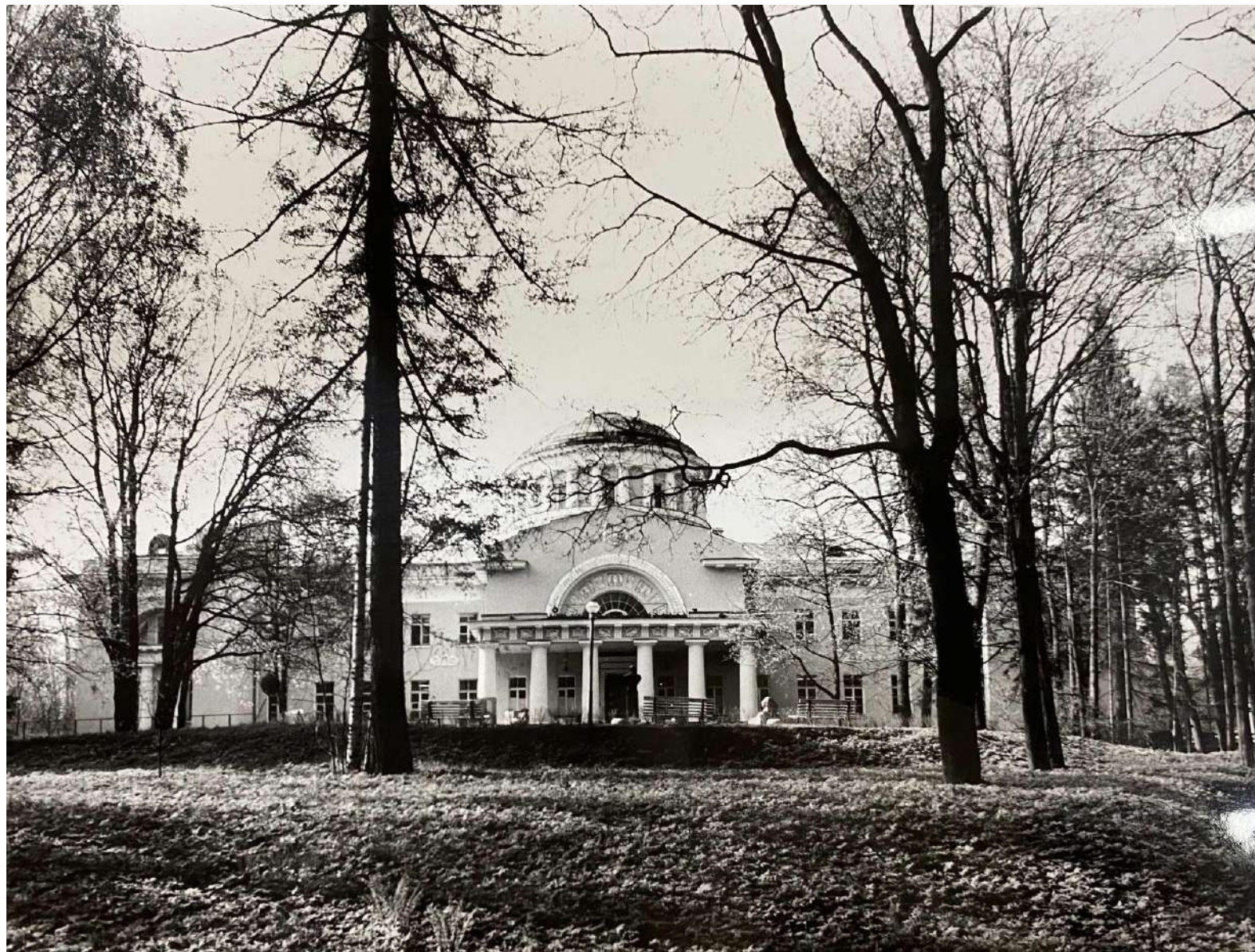
51. Ансамбль усадьбы Шуваловых (Е.А. Воронцовой-Дашковой). Большой дворец. Общий вид с севера. Дата: 1985 г. Автор: В.И. Шлакан // Архив КГИОП, № 55295/1-Н.
