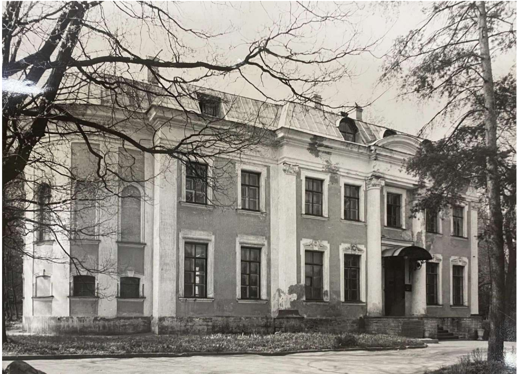
93. Ансамбль усадьбы Шуваловых. Малый дворец («Белый дом»). Главный фасад. Вид с северо-востока. Дата: 1985 г. Автор: В.И. Шлакан // Архив КГИОП, № 55333/1-Н.
