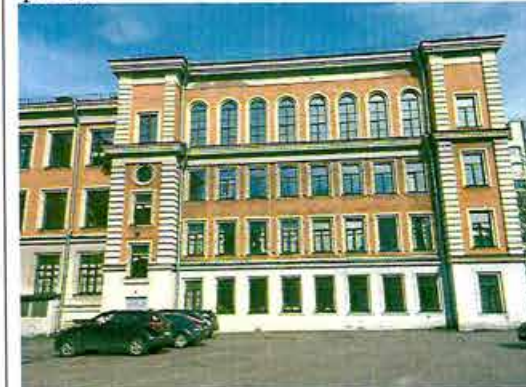
дворовый фасад северного флигеля
