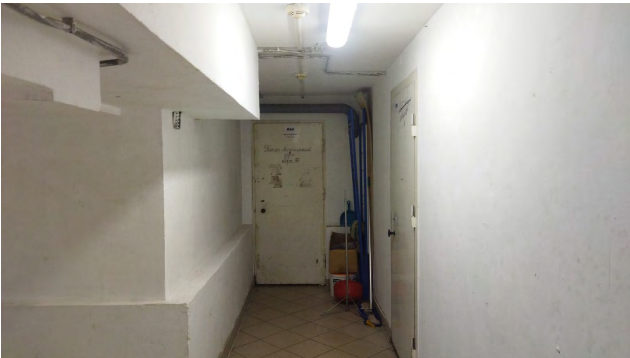
Фото 9. Апраксин двор с Мариинским рынком (б. Шукиным двором) - комплекс» расположенного по адресу: г. Санкт-Петербург, ул. Садовая, д.28-30, корп. 15 (фрагмент помещения).
