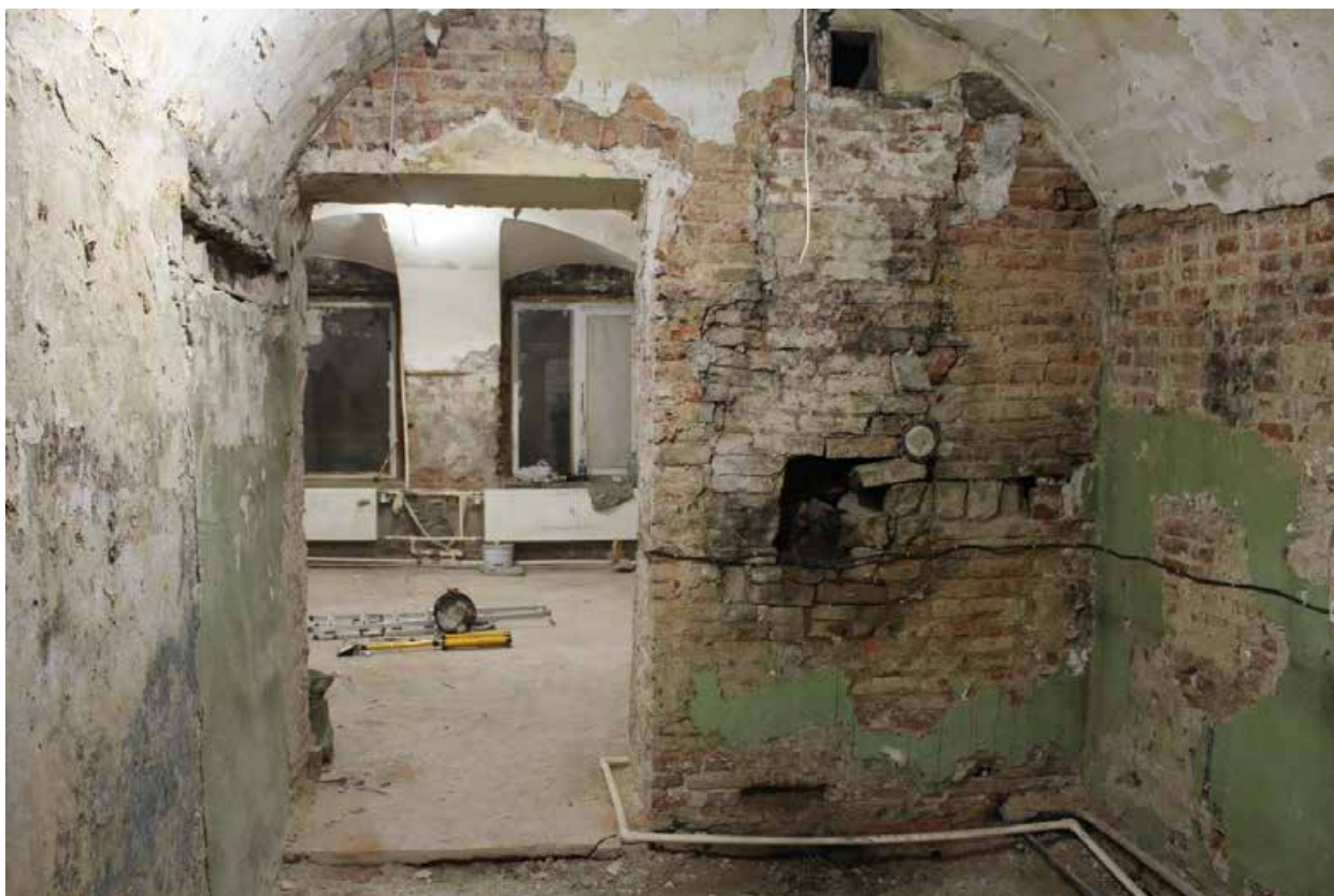
Фото 21. Интерьер помещения 3-Н объекта культурного наследия регионального значения «Дом О.Н. Варгуниной (В.В. Скаржинского)», ч.п. 3.
