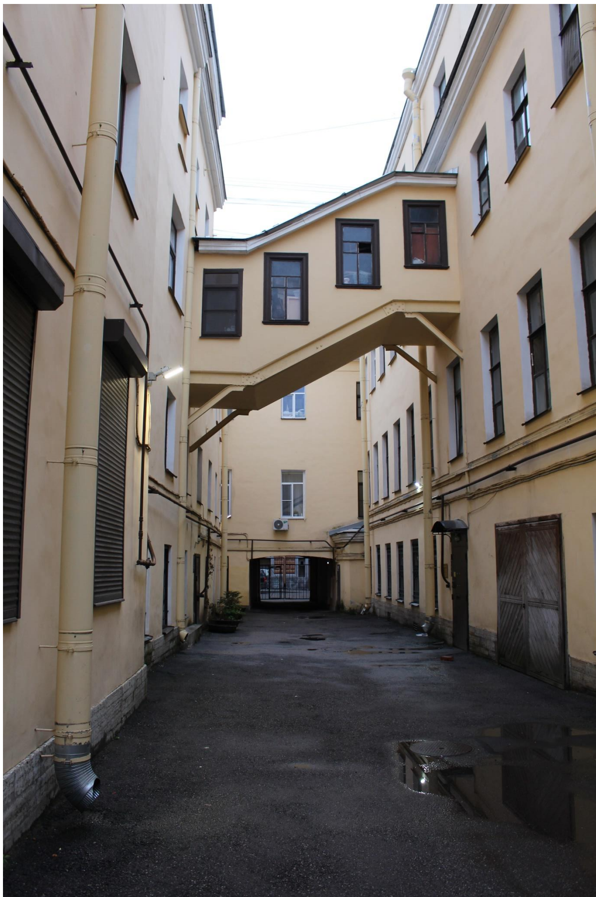
Фото 9. Вид на дворовые фасады объекта культурного наследия регионального значения «Дом О.Н. Варгуниной (В.В. Скаржинского)».
