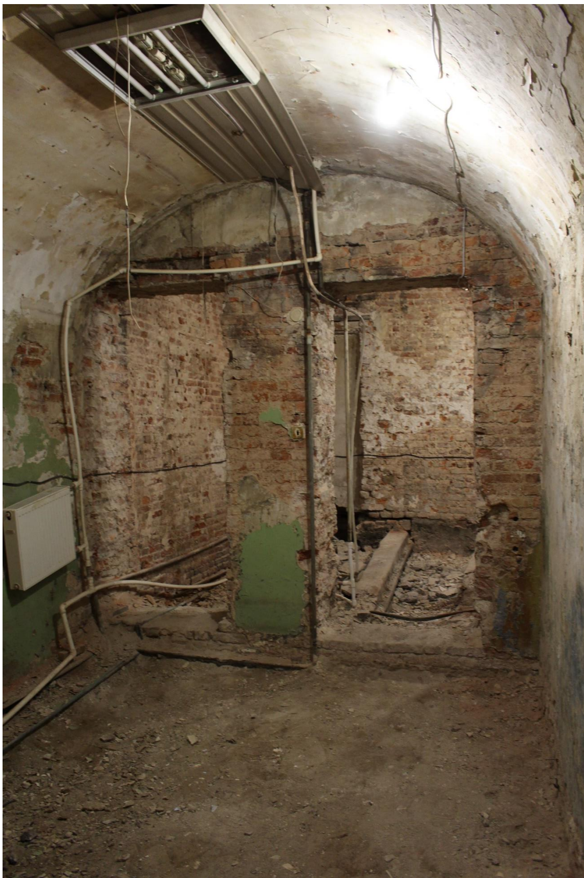
Фото 20. Интерьер помещения 3-Н объекта культурного наследия регионального значения «Дом О.Н. Варгуниной (В.В. Скаржинского)», ч.п. 3.
