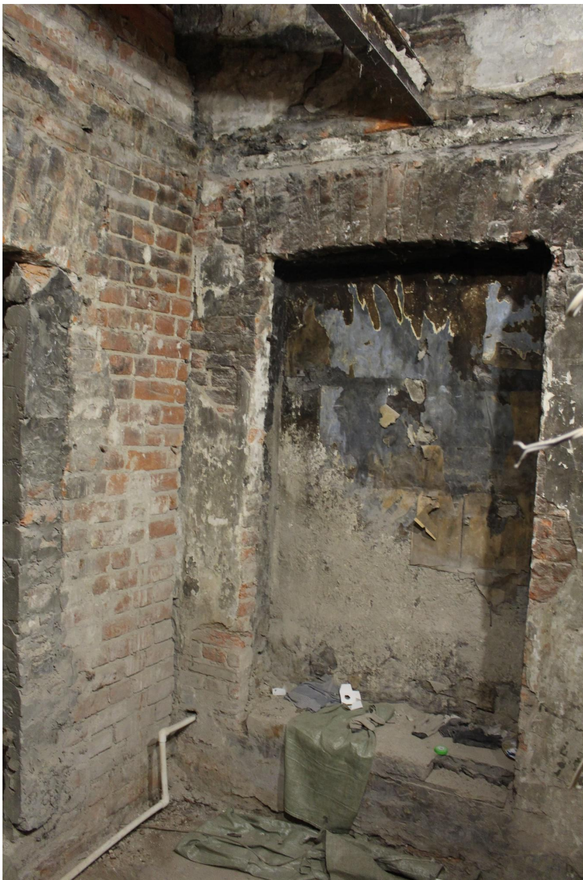
Фото 25. Интерьер помещения 3-Н объекта культурного наследия регионального значения «Дом О.Н. Варгуниной (В.В. Скаржинского)», ч.п. 6.
