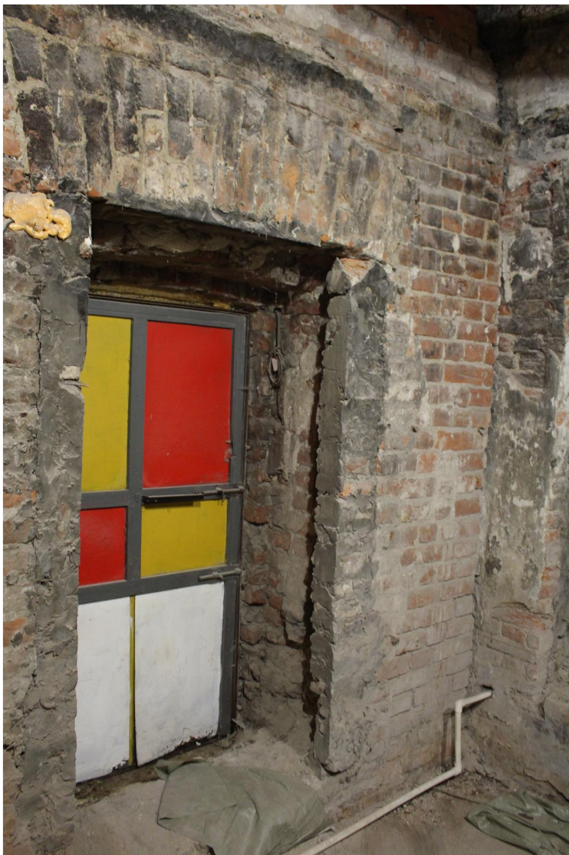
Фото 24. Интерьер помещения 3-Н объекта культурного наследия регионального значения «Дом О.Н. Варгуниной (В.В. Скаржинского)», ч.п. 6.
