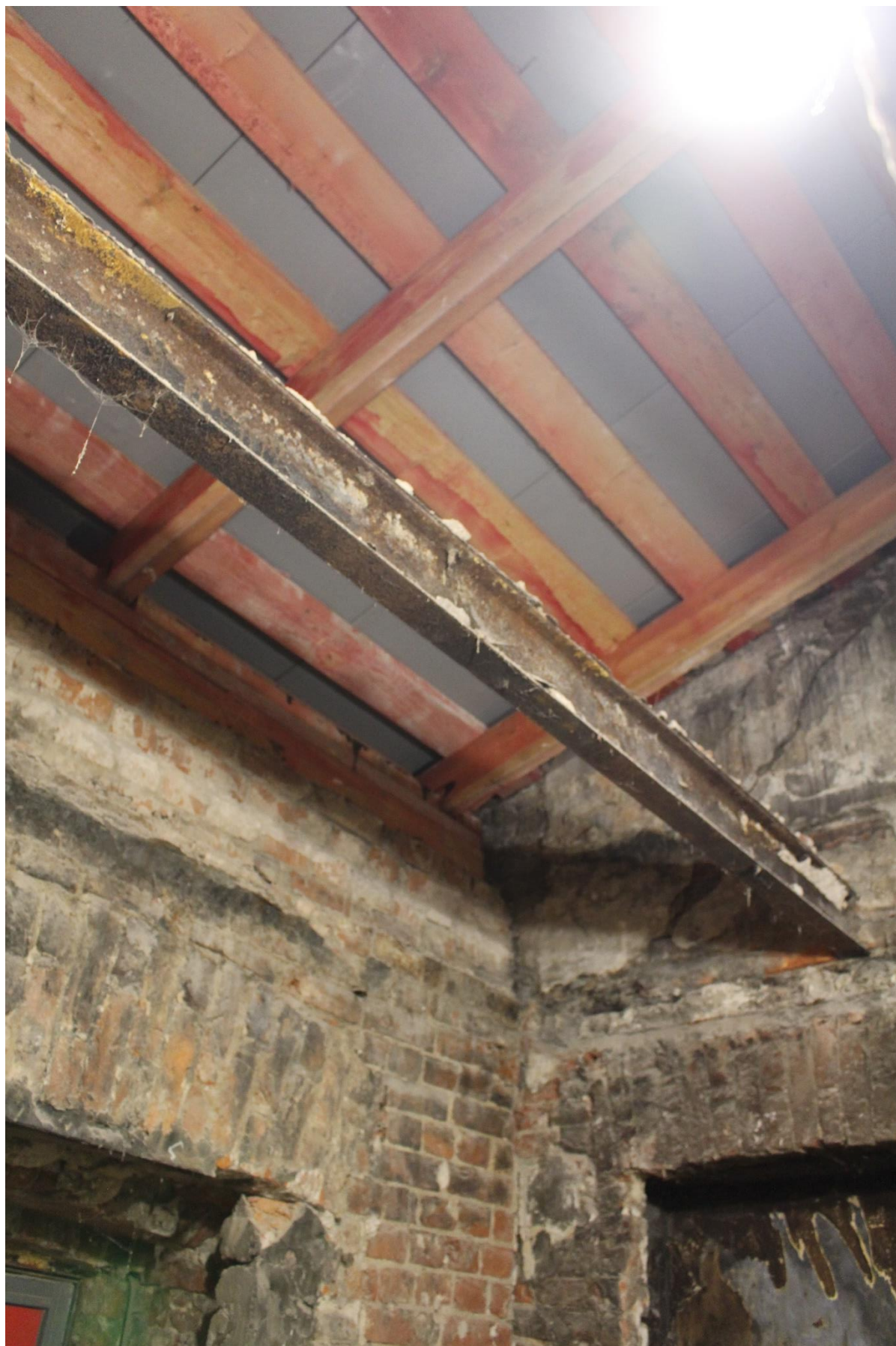
Фото 26. Интерьер помещения 3-Н объекта культурного наследия регионального значения «Дом О.Н. Варгуниной (В.В. Скаржинского)», ч.п. 6.
