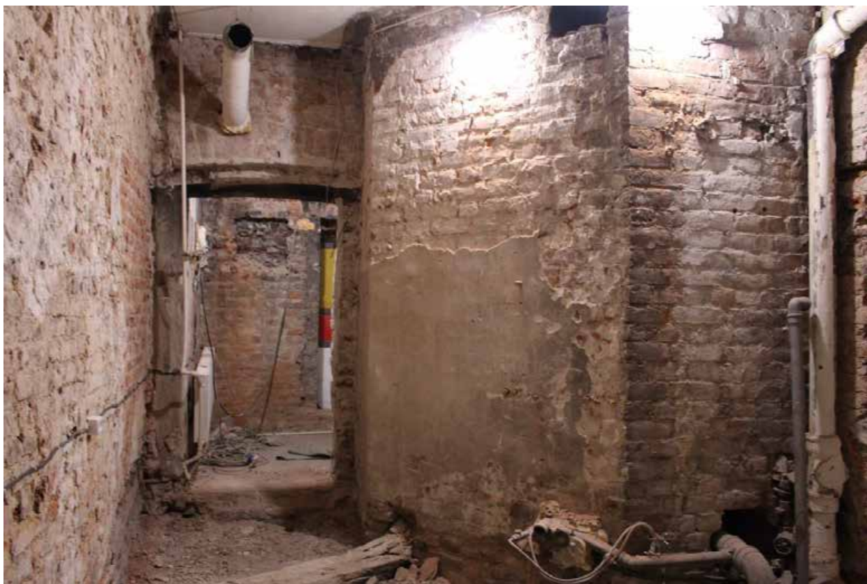
Фото 23. Интерьер помещения 3-Н объекта культурного наследия регионального значения «Дом О.Н. Варгуниной (В.В. Скаржинского)», ч.п. 4.
