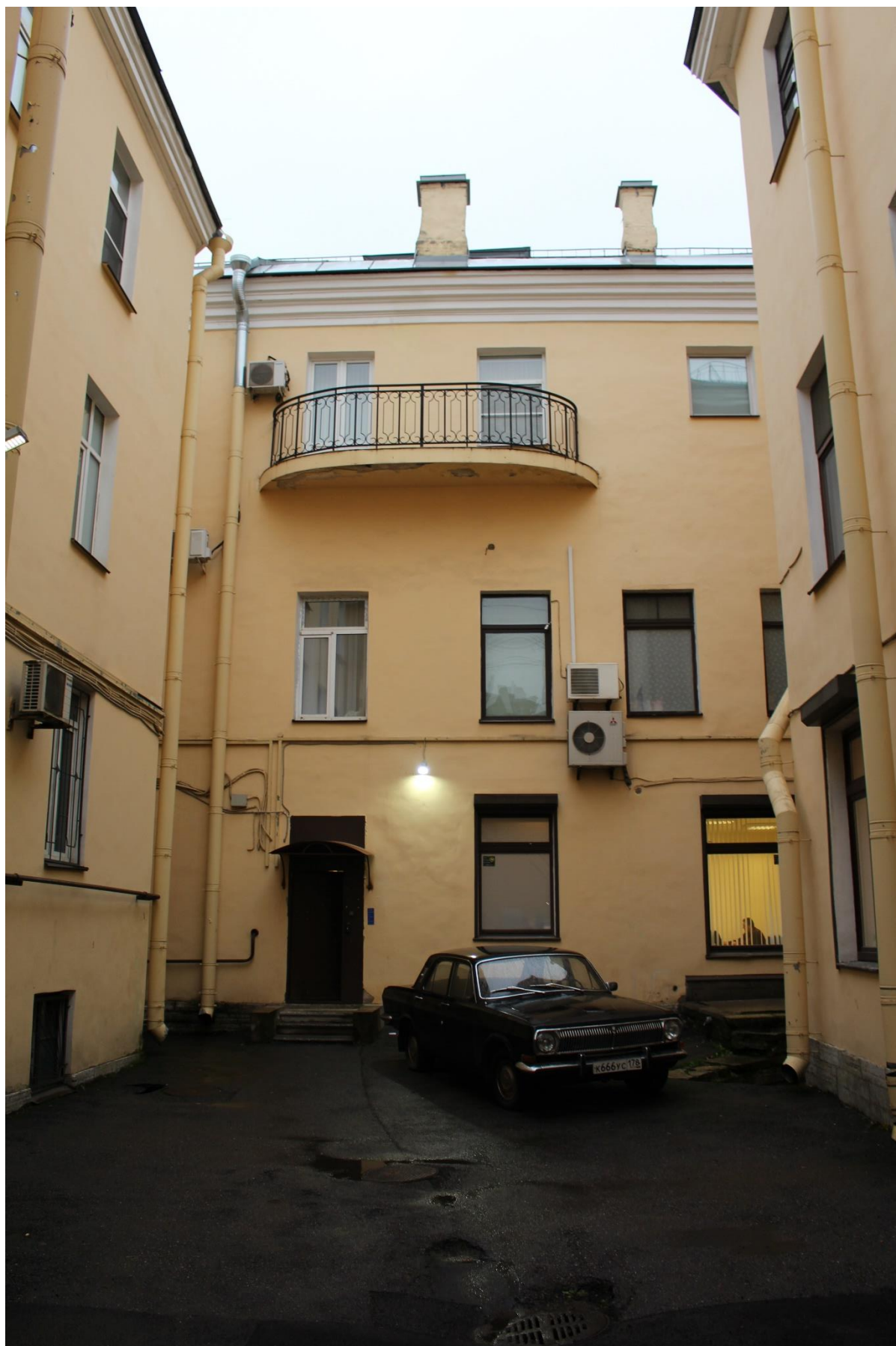
Фото 10. Вид на дворовый фасад лицевого корпуса по Английской набережной объекта культурного наследия регионального значения «Дом О.Н. Варгуниной (В.В. Скаржинского)».
