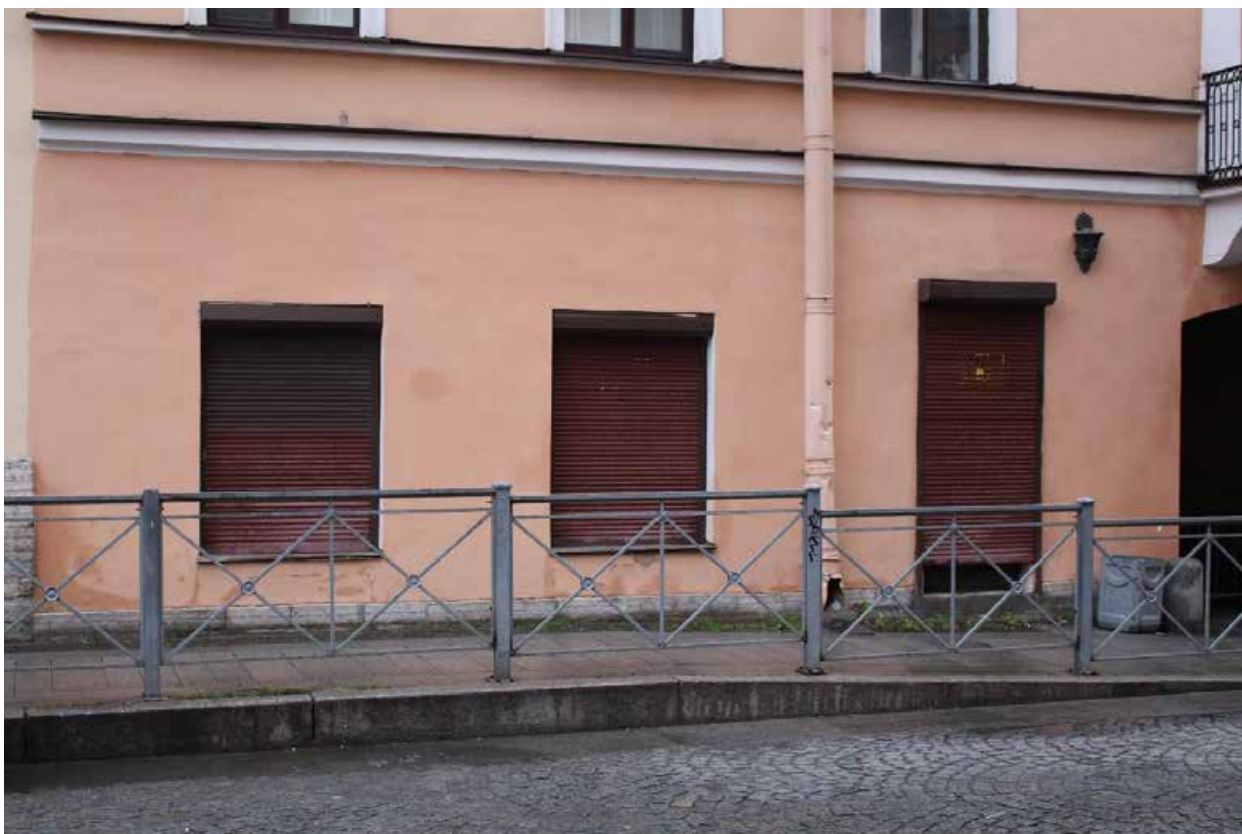
Фото 3. Вид на оконные и дверной проемы нежилого помещения 3-Н объекта культурного наследия регионального значения «Дом О.Н. Варгуниной (В.В. Скаржинского)» со стороны Галерной улицы.
