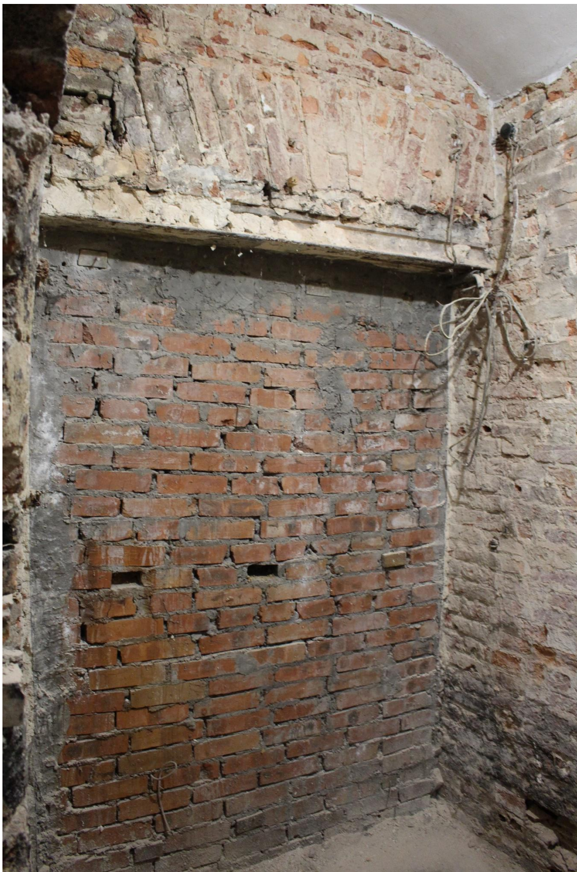
Фото 17. Интерьер помещения 3-Н объекта культурного наследия регионального значения «Дом О.Н. Варгуниной (В.В. Скаржинского)», ч.п. 7.
