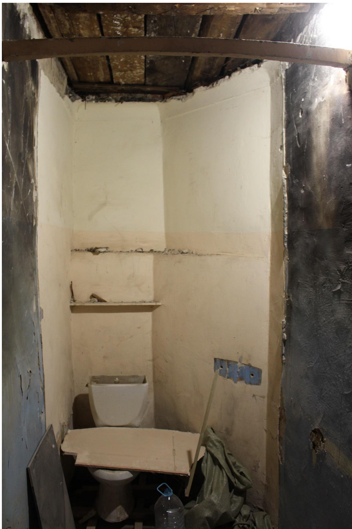
Фото 27. Интерьер помещения 3-Н объекта культурного наследия регионального значения «Дом О.Н. Варгуниной (В.В. Скаржинского)», ч.п. 5.
