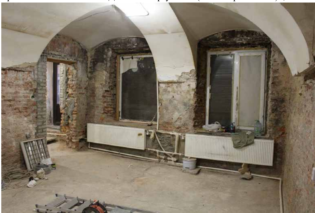
Фото 16. Интерьер помещения 3-Н объекта культурного наследия регионального значения «Дом О.Н. Варгуниной (В.В. Скаржинского)», ч.п. 2.
