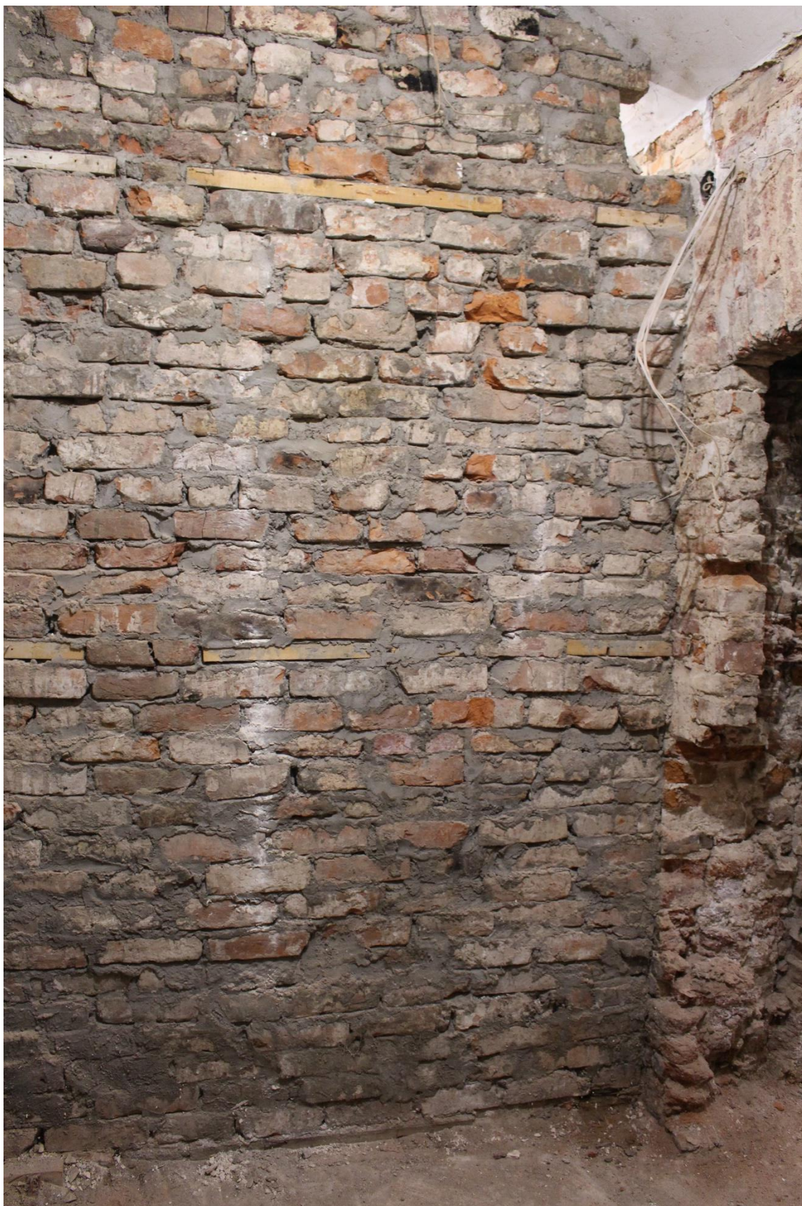
Фото 18. Интерьер помещения 3-Н объекта культурного наследия регионального значения «Дом О.Н. Варгуниной (В.В. Скаржинского)», ч.п. 7.
