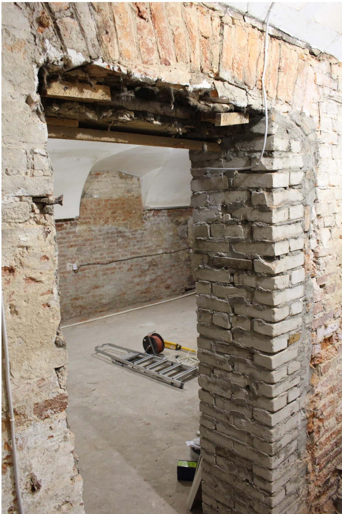
Фото 14. Интерьер помещения 3-Н объекта культурного наследия регионального значения «Дом О.Н. Варгуниной (В.В. Скаржинского)», дверной проем из ч.п. 1 в ч.п. 2.
