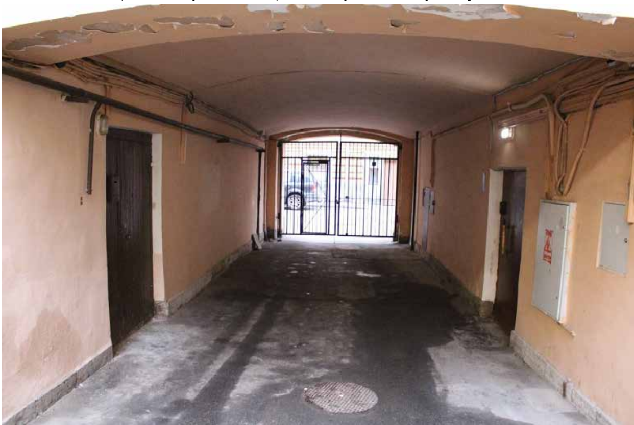
Фото 4. Вид на воротный проезд объекта культурного наследия регионального значения «Дом О.Н. Варгуниной (В.В. Скаржинского)».
