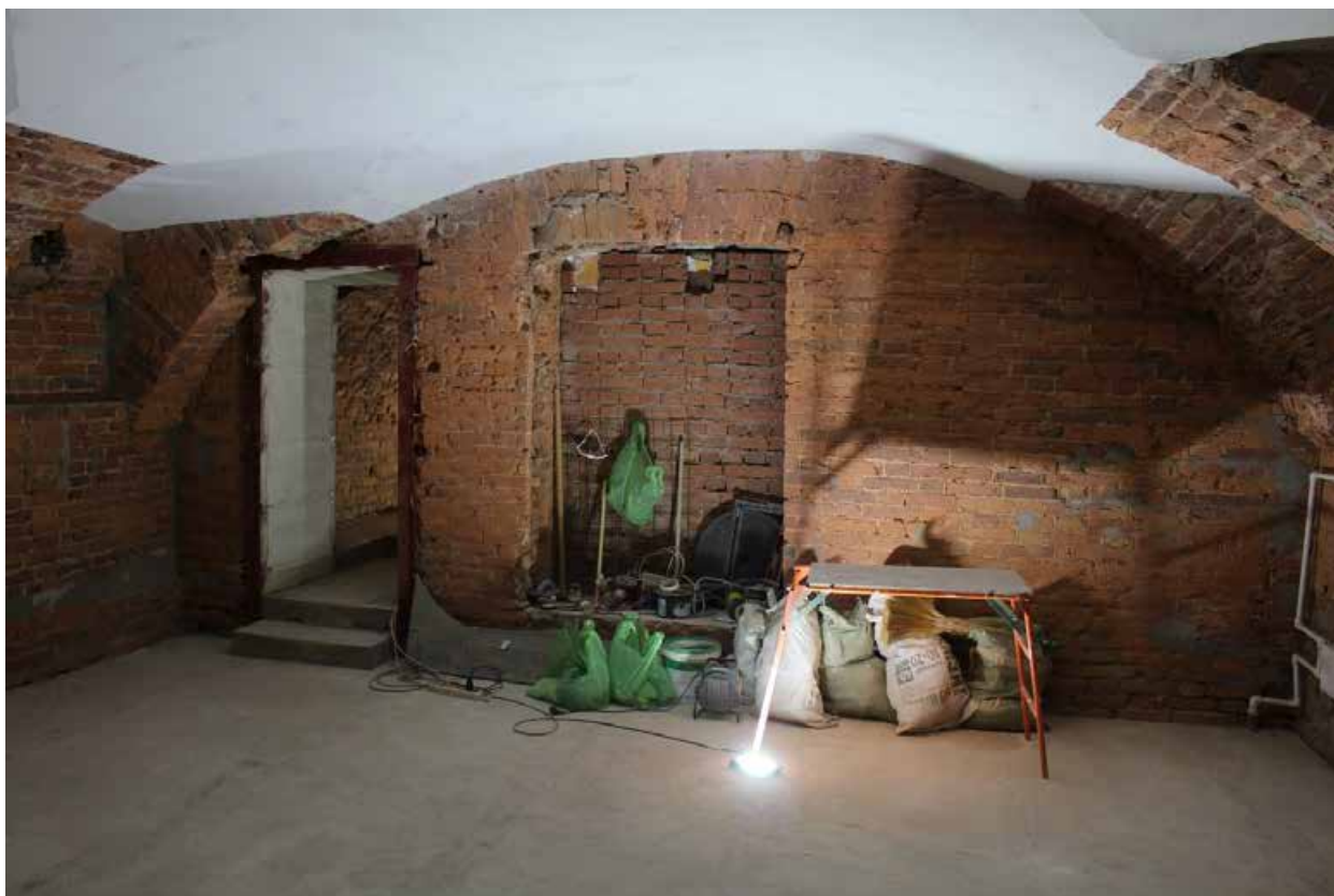
Фото 25. Объект культурного наследия федерального значения «Дом Антонова («дом Адамини»)». Нежилое помещение 43-Н, ч.п. 1.
