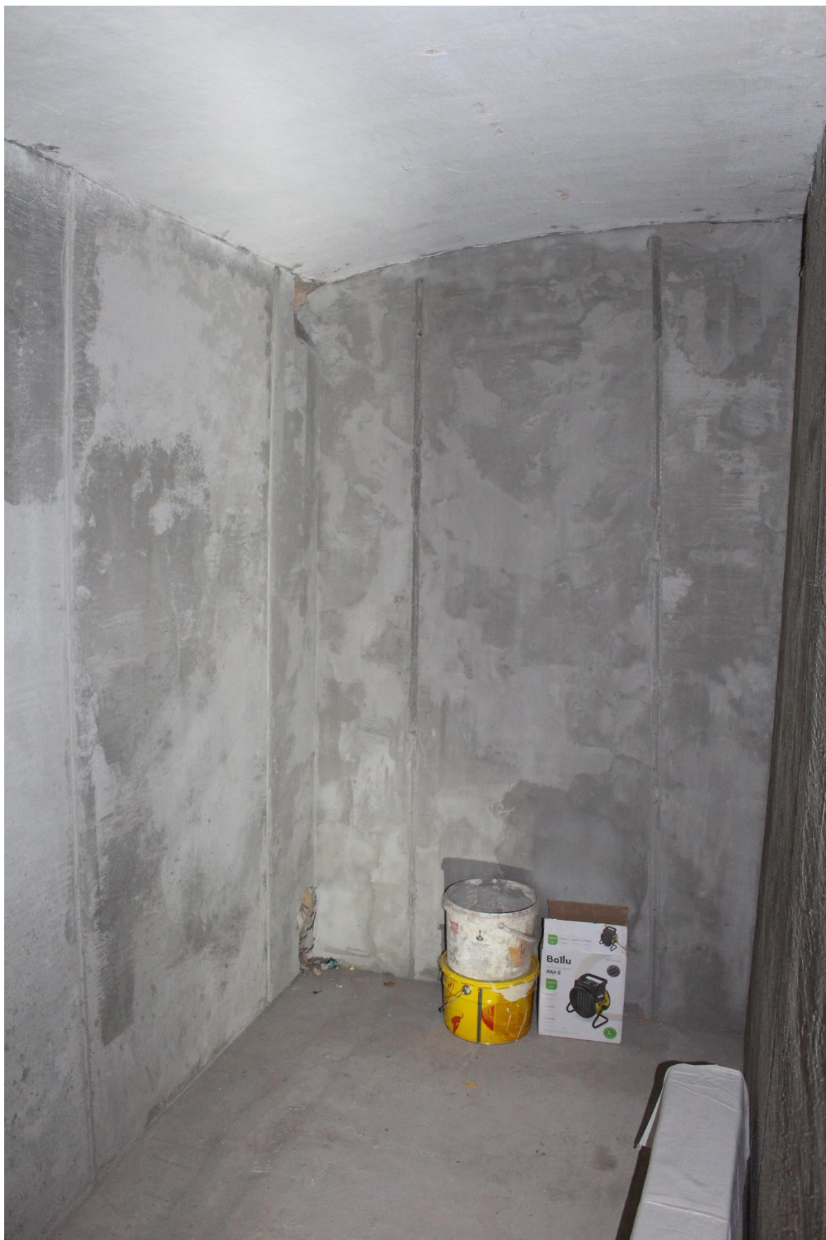
Фото 22. Объект культурного наследия федерального значения «Дом Антонова («дом Адамини»)». Нежилое помещение 43-Н, ч.п. 5.
