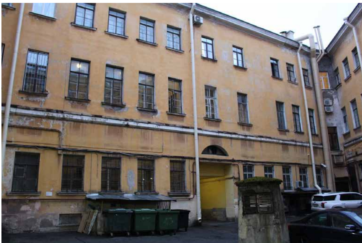
Фото 9. Вид на дворовый фасад лицевого корпуса по Марсовому полю объекта культурного наследия федерального значения «Дом Антонова («дом Адамини»)».
