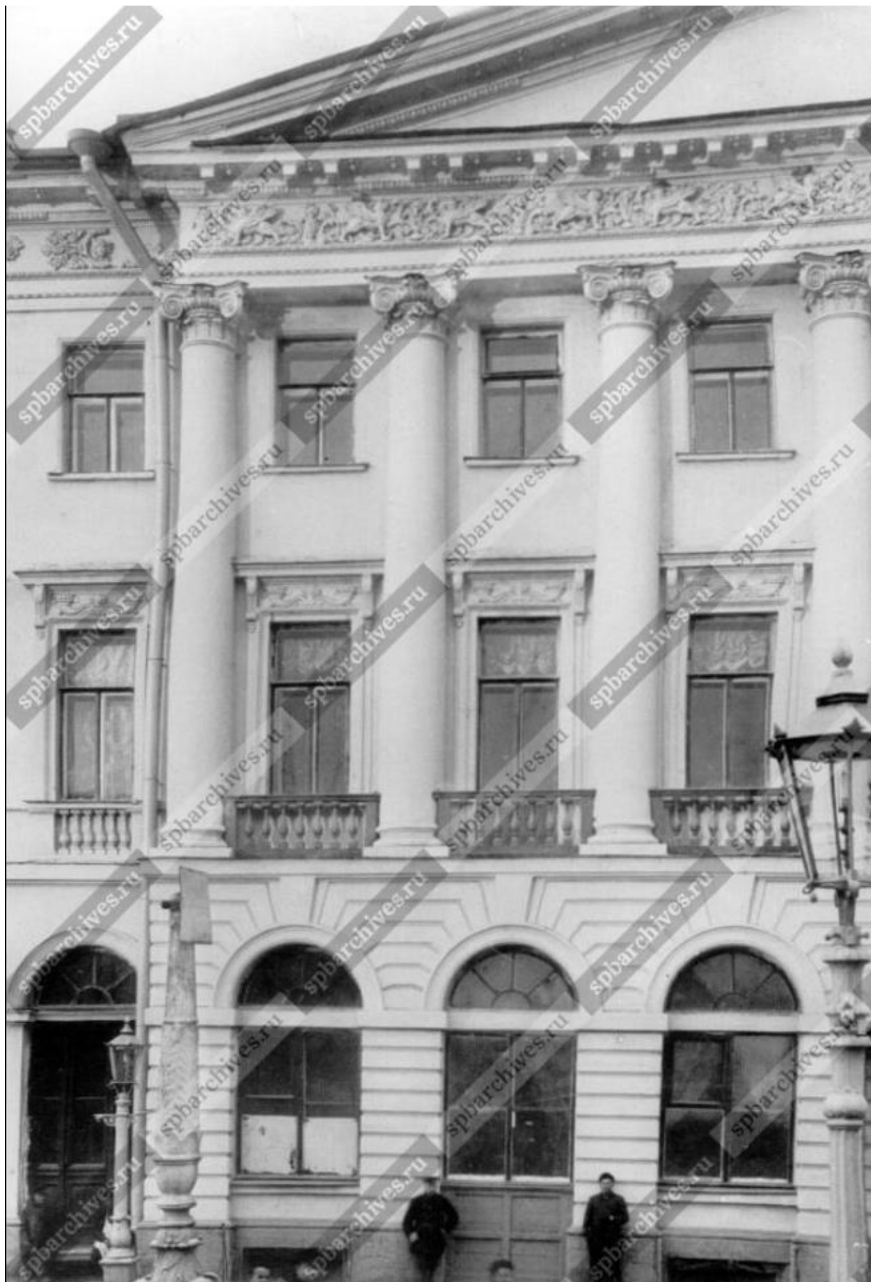
Илл. 36. Вид части портика южного фасада дома № 7 - дома Адамини (Марсово поле, 7, наб. р. Мойки, 1), обращенного на набережную реки Мойки. 1945 г. (источник: ЦГАКФФД СПб. Фотодокументы. Опись 1Б-2. Ед.хр.1643).
