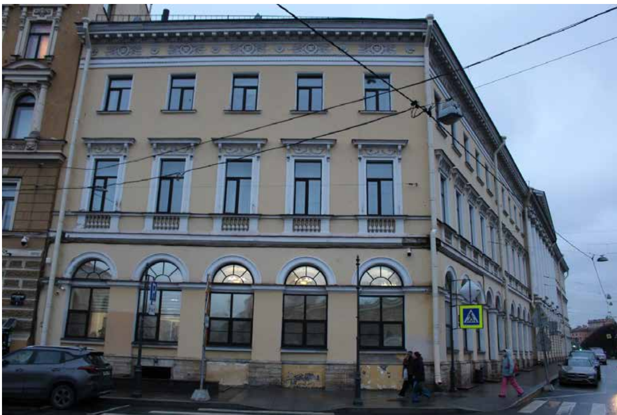
Фото 7. Вид на лицевой фасад объекта культурного наследия федерального значения «Дом Антонова («дом Адамини»)» со стороны Аптекарского переуллка.
