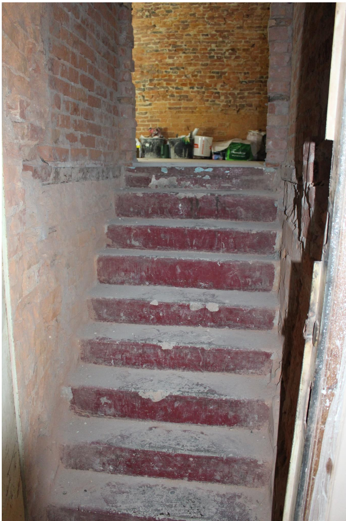
Фото 17. Объект культурного наследия федерального значения «Дом Антонова («дом Адамини»)». Вход в нежилое помещение 43-Н.
