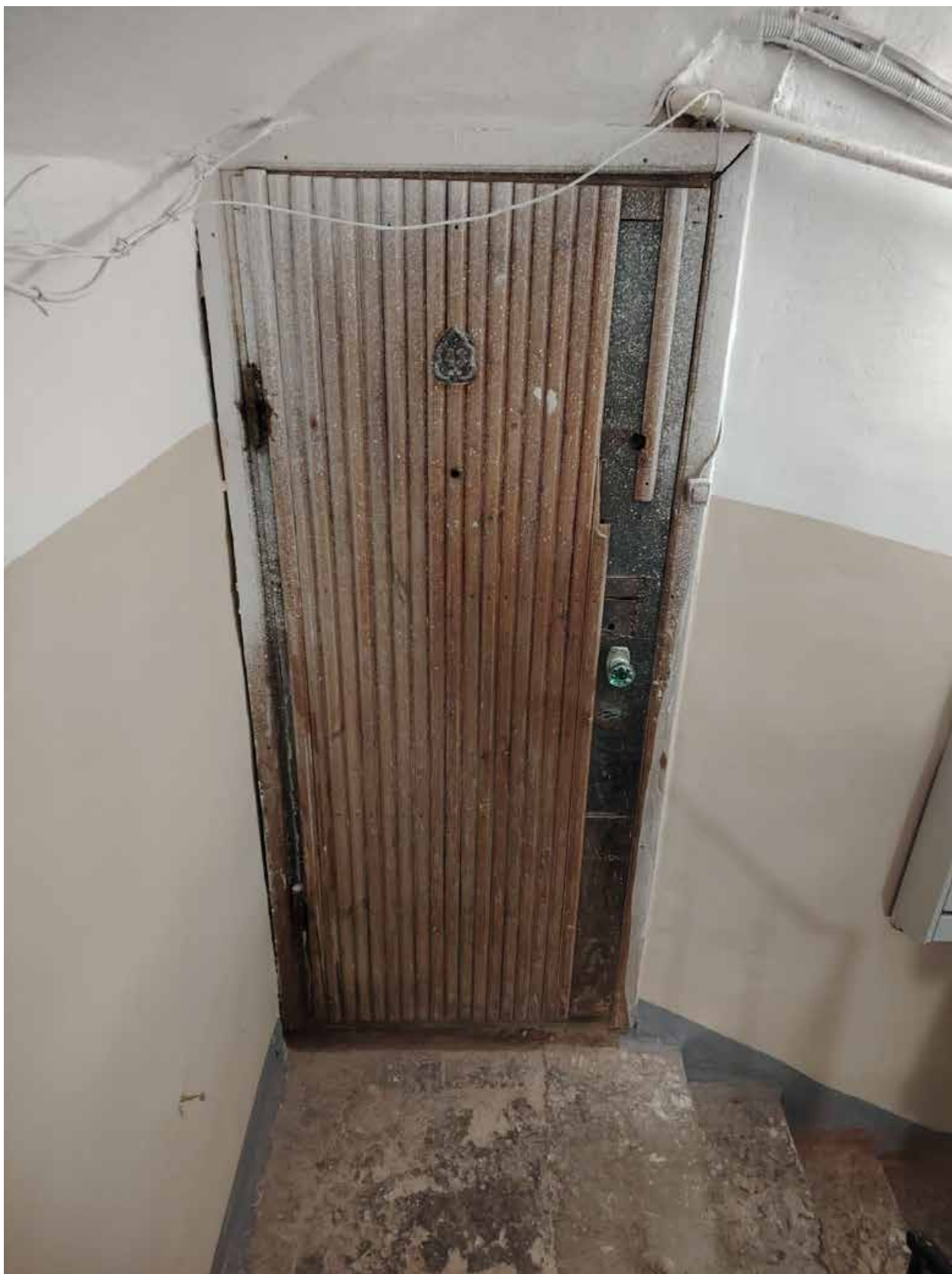
Фото 16. Объект культурного наследия федерального значения «Дом Антонова («дом Адамини»)». Вход в нежилое помещение 43-Н.
