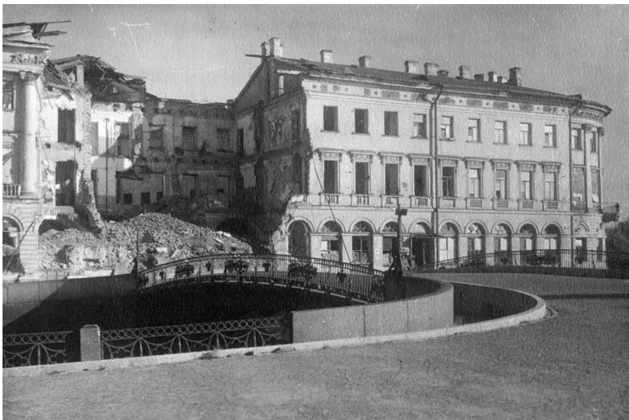
Илл. 30. Разрушенный дом Адамини. 1943 г. (источник: https://pastvu.com/p/1810750 ).
