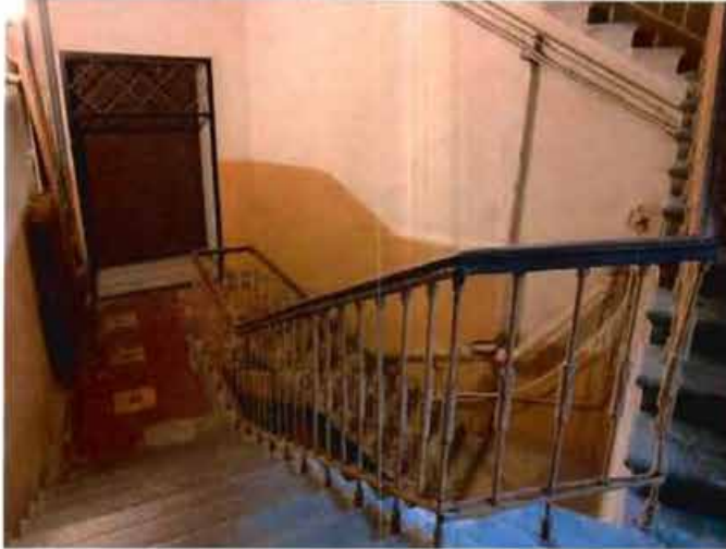
26-27. Лестничная клетка 2ЛК (17.11.2021).
