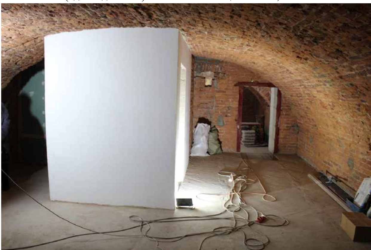
Фото 19. Объект культурного наследия федерального значения «Дом Антонова («дом Адамини»)». Нежилое помещение 43-Н, ч.п. 2.
