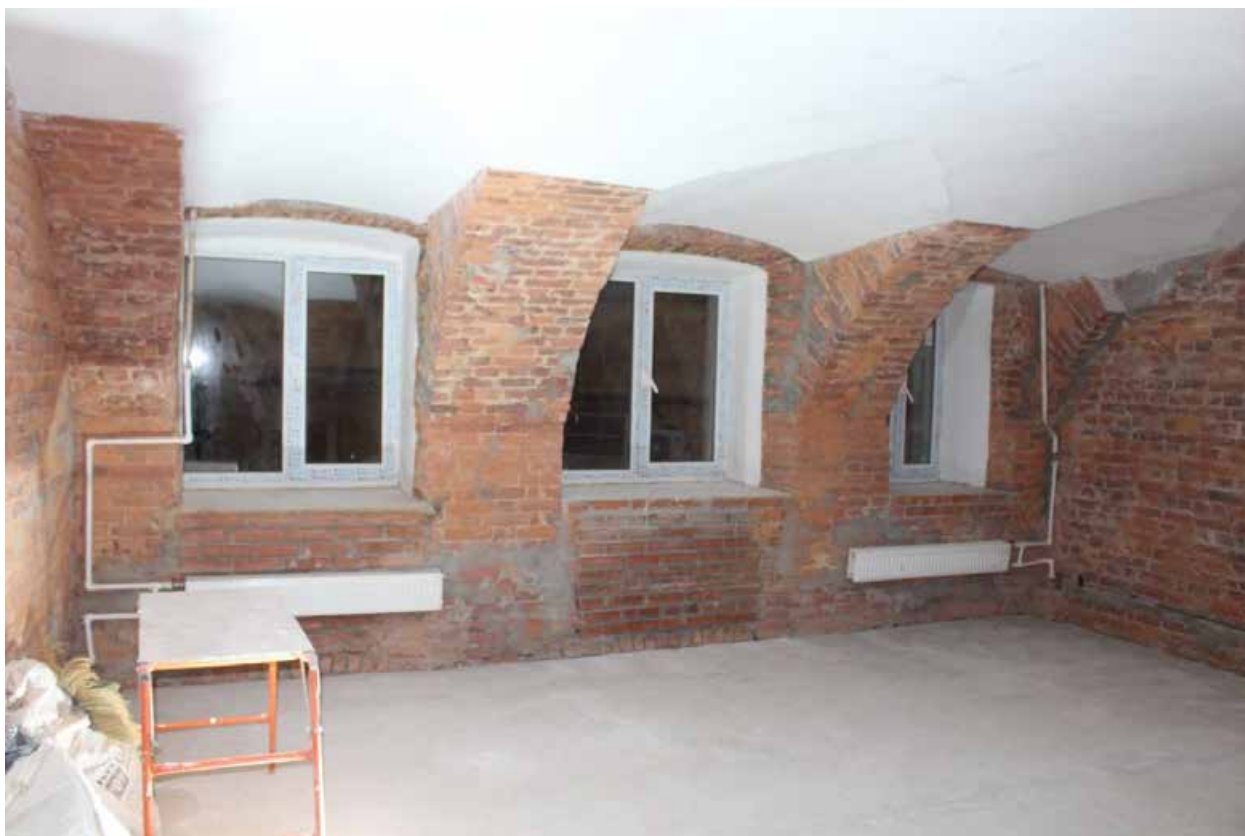
Фото 23. Объект культурного наследия федерального значения «Дом Антонова («дом Адамини»)». Нежилое помещение 43-Н, ч.п. 1.
