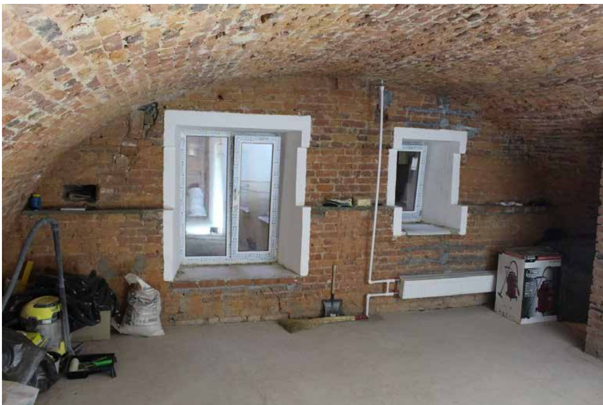
Фото 18. Объект культурного наследия федерального значения «Дом Антонова («дом Адамини»)». Нежилое помещение 43-Н, ч.п. 2.
