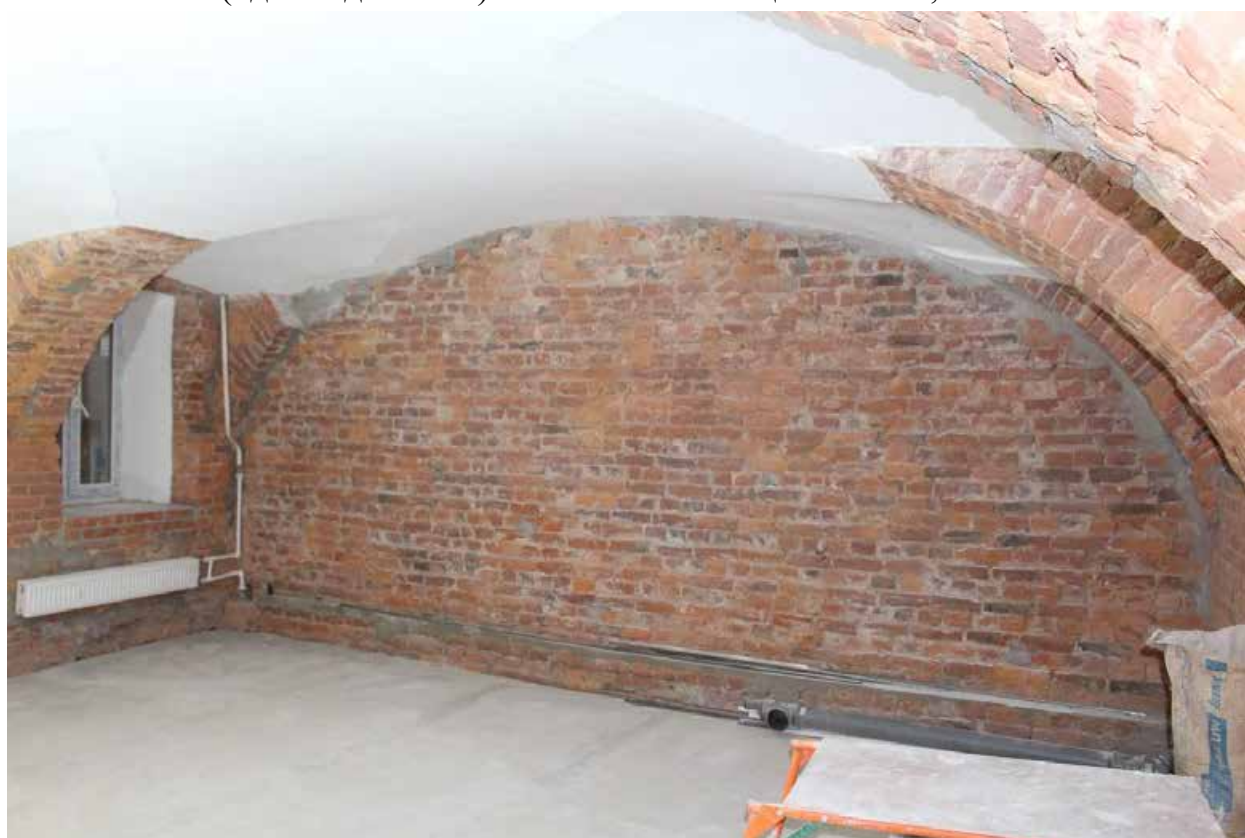
Фото 24. Объект культурного наследия федерального значения «Дом Антонова («дом Адамини»)». Нежилое помещение 43-Н, ч.п. 1.
