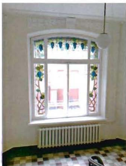
7. Главный корпус. Витражное заполнение оконных проёмов лестничной клетки парадной лестницы.
