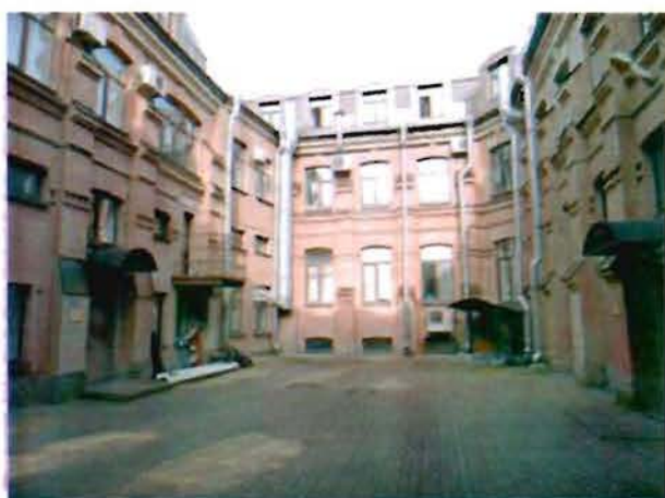
15. Дворовые флигеля. Фрагмент внутреннего дворового фасада.
