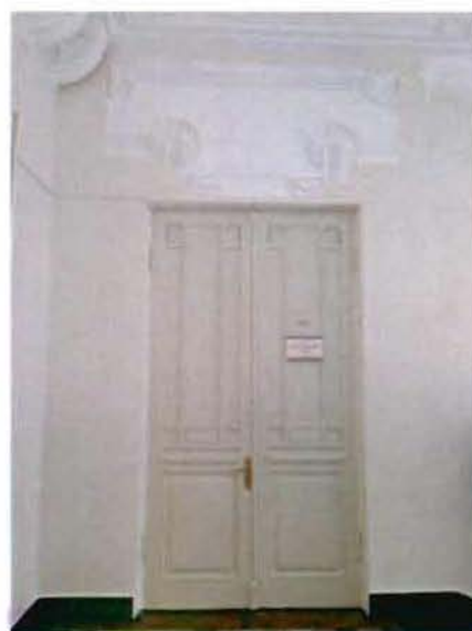
8. Главный корпус. Заполнение дверного проёма на лестничной площадке парадной лестницы.
