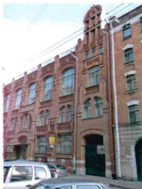
3. Лицевой корпус. Фрагмент главного фасада вдоль ул. Егорова.
