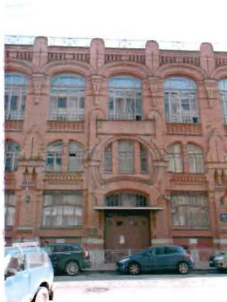
2. Лицевой корпус. Фрагмент главного фасада вдоль ул. Егорова.
