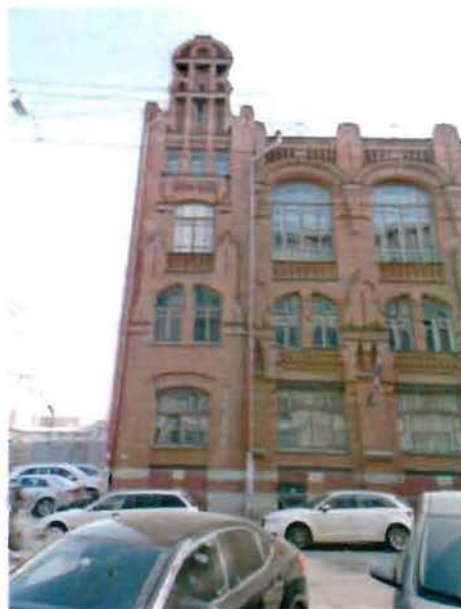
1. Лицевой корпус. Фрагмент главного фасада вдоль ул. Егорова.
