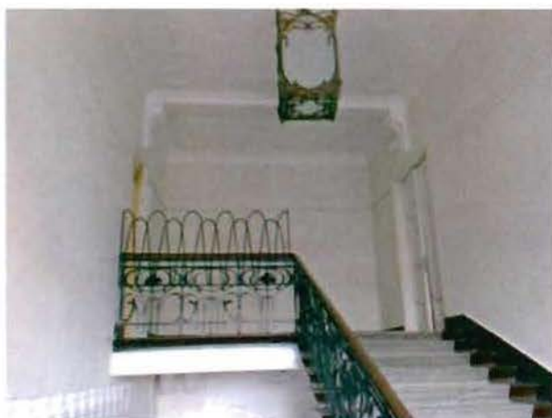
6. Главный корпус. Лестничная клетка парадной лестницы.
