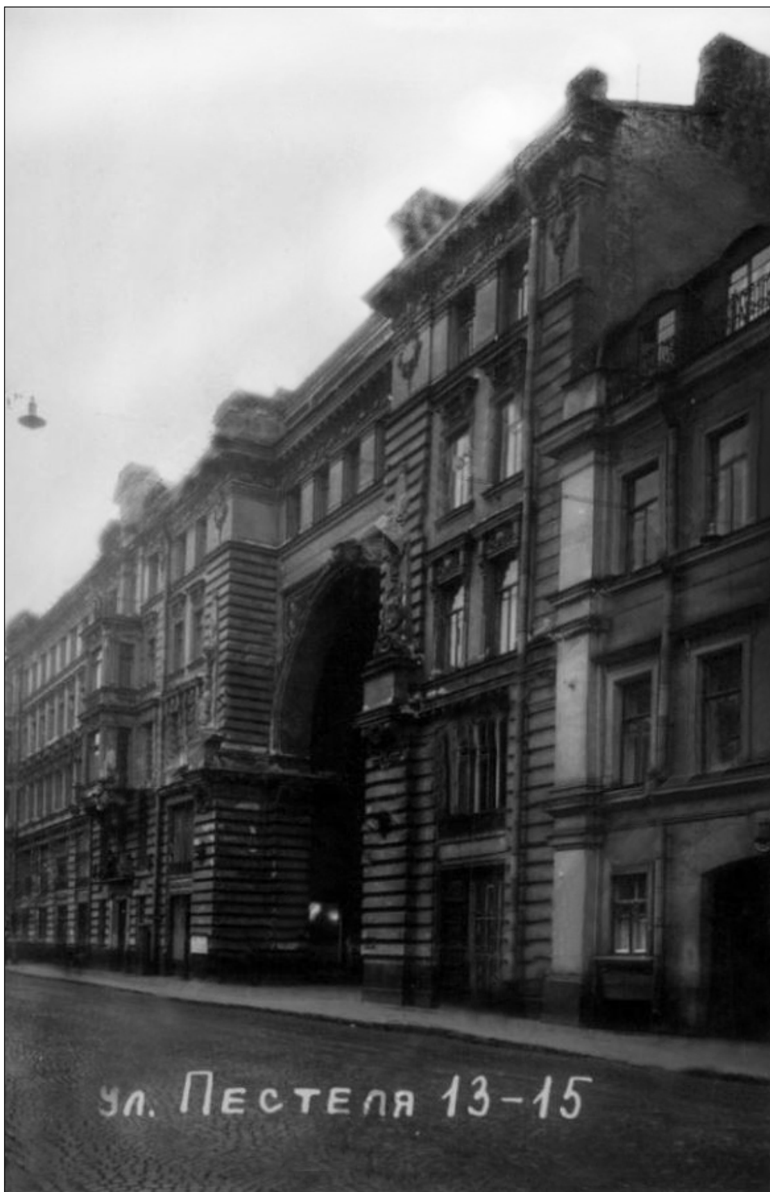
Илл. 19. Фасад дома № 13-15 по улице Пестеля. Арх. П.Ю. Сюзор. Фотография. Автор съемки: неизвестен.
