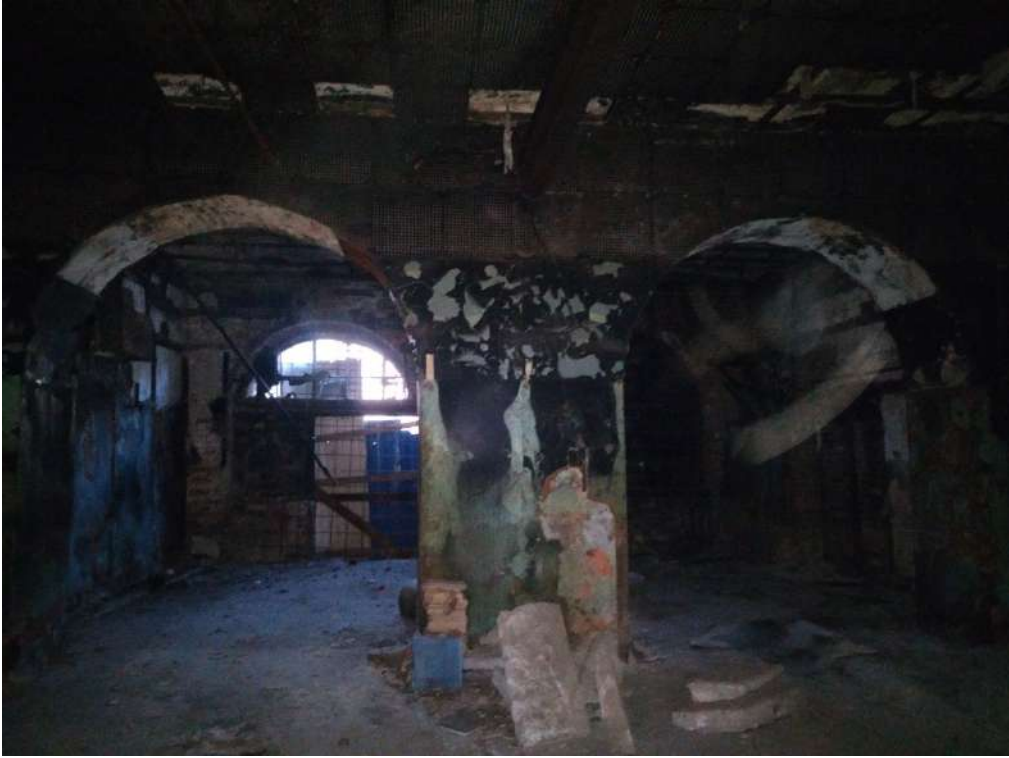
18. ОКНРЗ «Сельдяной ряд Никольского рынка», расположенный по адресу: Санкт-Петербург, Щепяной переулок, дом 4–6, литера А. Интерьеры первого этажа. Дата съемки: 19.11.2024г.
