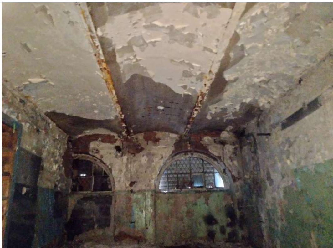
20. ОКНРЗ «Сельдяной ряд Никольского рынка», расположенный по адресу: Санкт-Петербург, Щепяной переулок, дом 4–6, литера А. Междуэтажные перекрытия. Дата съемки: 19.11.2024г.
