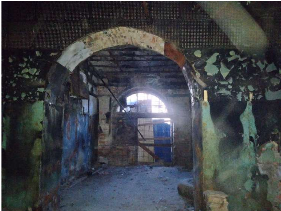
19. ОКНРЗ «Сельдяной ряд Никольского рынка», расположенный по адресу: Санкт-Петербург, Щепяной переулок, дом 4–6, литера А. Интерьеры первого этажа. Дата съемки: 19.11.2024г.
