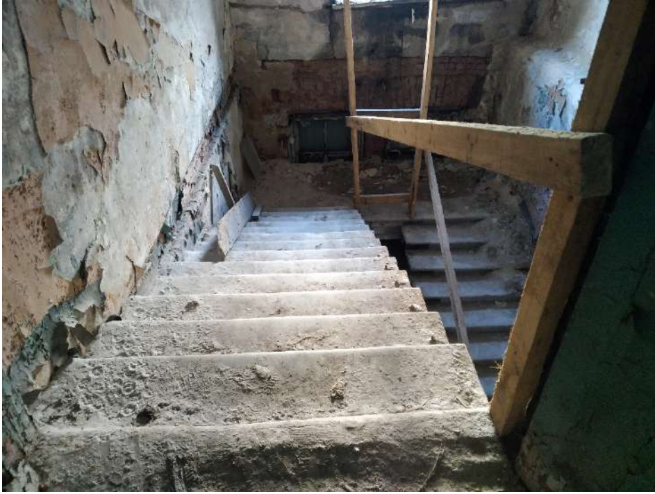
1. ОКНРЗ «Сельдяной ряд Никольского рынка», расположенный по адресу: Санкт-Петербург, Щепяной переулок, дом 4–6, литера А. Историческая межэтажная лестница 1ЛК (двухмаршевая, на металлических косоурах, со ступенями из известняка). Дата съемки: 19.11.2024г.
