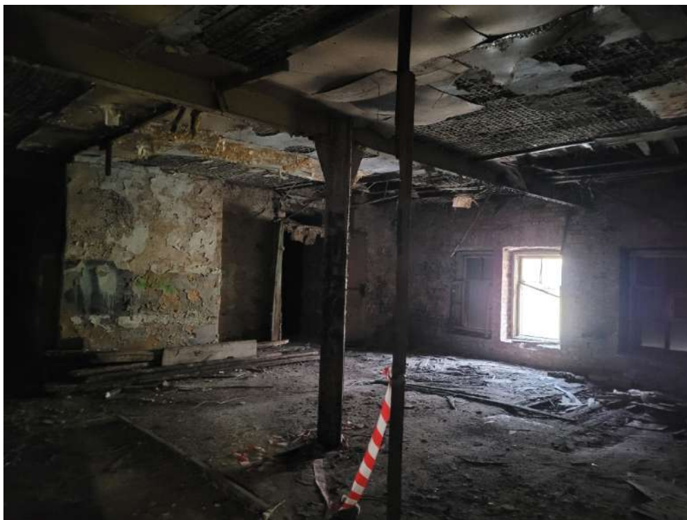
24. ОКНРЗ «Сельдяной ряд Никольского рынка», расположенный по адресу: Санкт-Петербург, Щепяной переулок, дом 4–6, литера А. Металлические колонны, поддерживающие металлические балки. Междуэтажные перекрытия. Дата съемки: 19.11.2024г.
