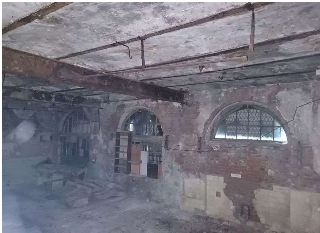
17. ОКНРЗ «Сельдяной ряд Никольского рынка», расположенный по адресу: Санкт-Петербург, Щепяной переулок, дом 4–6, литера А. Междуэтажные перекрытия. Дата съемки: 19.11.2024г.
