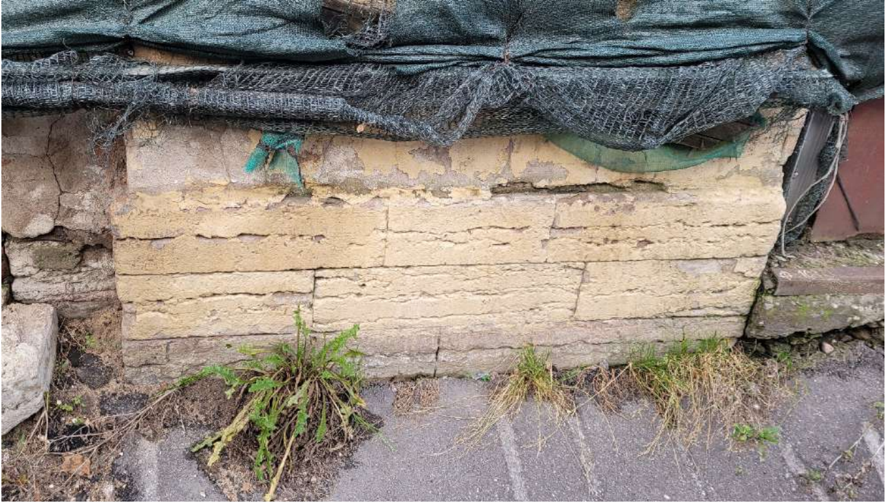
9. ОКНРЗ «Сельдяной ряд Никольского рынка», расположенный по адресу: Санкт-Петербург, Щепяной переулок, дом 4–6, литера А. Южный фасад со стороны Кустарного переуллка. Материал облицовки цоколя – известняк. Дата съемки: 19.11.2024г.
