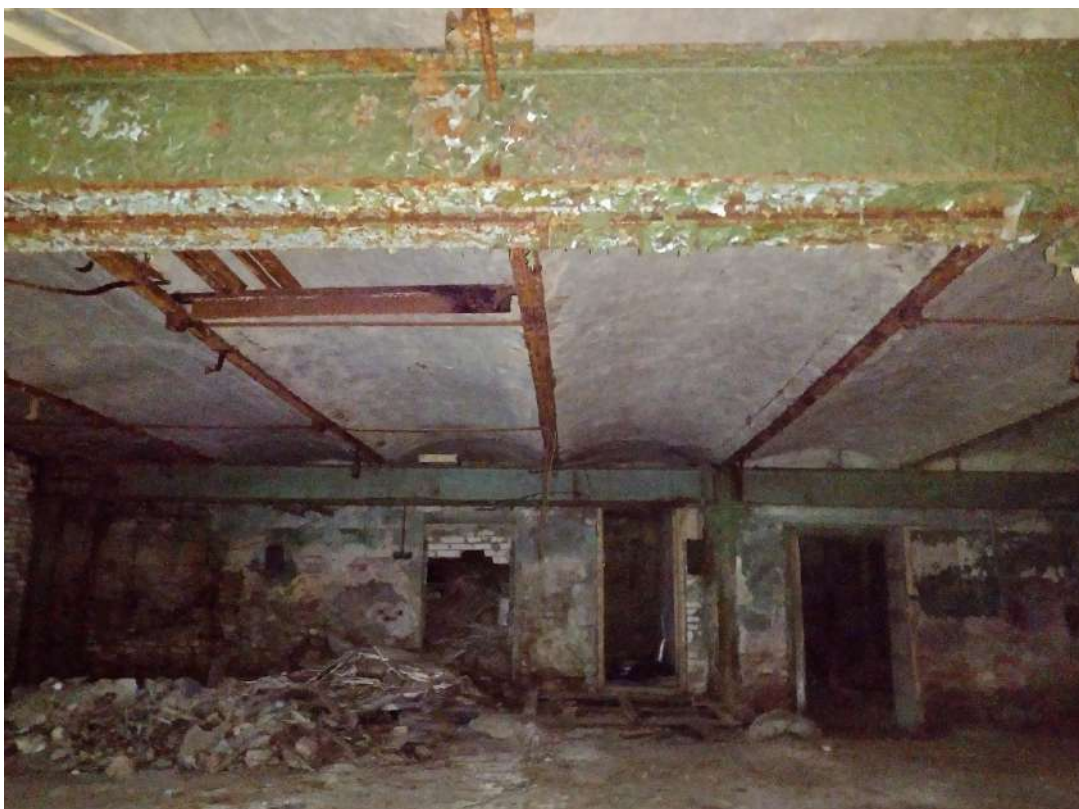
15. ОКНРЗ «Сельдяной ряд Никольского рынка», расположенный по адресу: Санкт-Петербург, Щепяной переулок, дом 4–6, литера А. Металлические колонны, поддерживающие металлические балки. Междуэтажные перекрытия. Дата съемки: 19.11.2024г.
