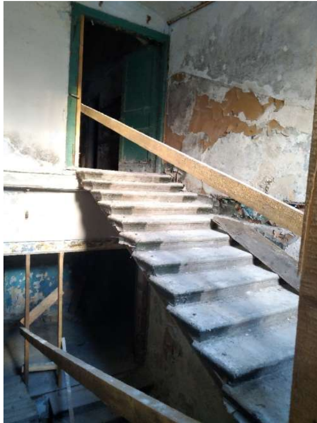
2. ОКНРЗ «Сельдяной ряд Никольского рынка», расположенный по адресу: Санкт-Петербург, Щепяной переулок, дом 4–6, литера А. Историческая межэтажная лестница 1ЛК (двухмаршевая, на металлических косоурах, со ступенями из известняка). Дата съемки: 19.11.2024г.
