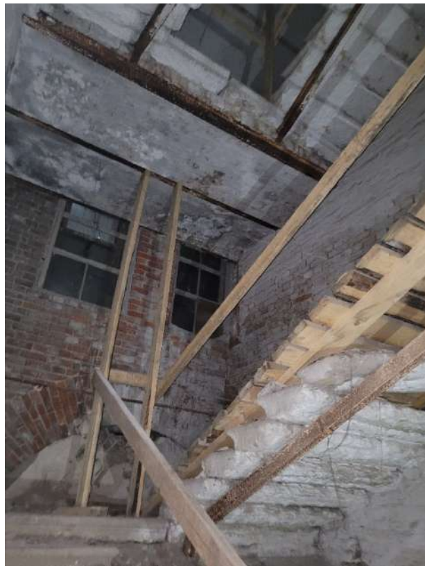
4. ОКНРЗ «Сельдяной ряд Никольского рынка», расположенный по адресу: Санкт-Петербург, Щепяной переулок, дом 4–6, литера А. Историческая межэтажная лестница 2ЛК (двухмаршевая, на металлических косоурах, со ступенями из известняка). Дата съемки: 19.11.2024г.
