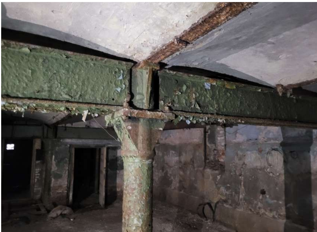
16. ОКНРЗ «Сельдяной ряд Никольского рынка», расположенный по адресу: Санкт-Петербург, Щепяной переулок, дом 4–6, литера А. Фрагмент сочленения металлической колонны, поддерживающей металлическую балку. Дата съемки: 19.11.2024г.
