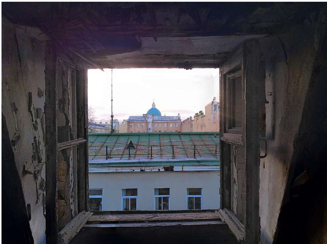
26. ОКНРЗ «Сельдяной ряд Никольского рынка», расположенный по адресу: Санкт-Петербург, Щепяной переулок, дом 4–6, литера А. Прямоугольный оконный проем мансардного этажа. Дата съемки: 19.11.2024г.
