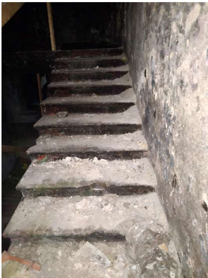
3. ОКНРЗ «Сельдяной ряд Никольского рынка», расположенный по адресу: Санкт-Петербург, Щепяной переулок, дом 4–6, литера А. Историческая межэтажная лестница 1ЛК (двухмаршевая, на металлических косоурах, со ступенями из известняка). Дата съемки: 19.11.2024г.
