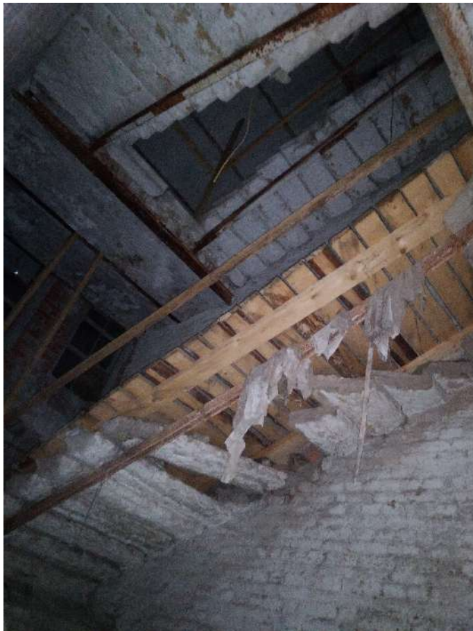
9. ОКНРЗ «Сельдяной ряд Никольского рынка», расположенный по адресу: Санкт-Петербург, Щепяной переулок, дом 4–6, литера А. Историческая межэтажная лестница 4ЛК (двухмаршевая, на металлических косоурах, со ступенями из известняка). Дата съемки: 19.11.2024г.
