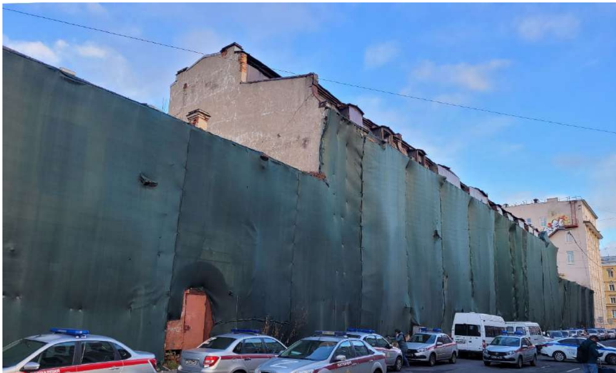
1. ОКНРЗ «Сельдяной ряд Никольского рынка», расположенный по адресу: Санкт-Петербург, Щепяной переулок, дом 4–6, литера А. Южный фасад со стороны Кустарного переуллка. Общий вид. Дата съемки: 19.11.2024г.
