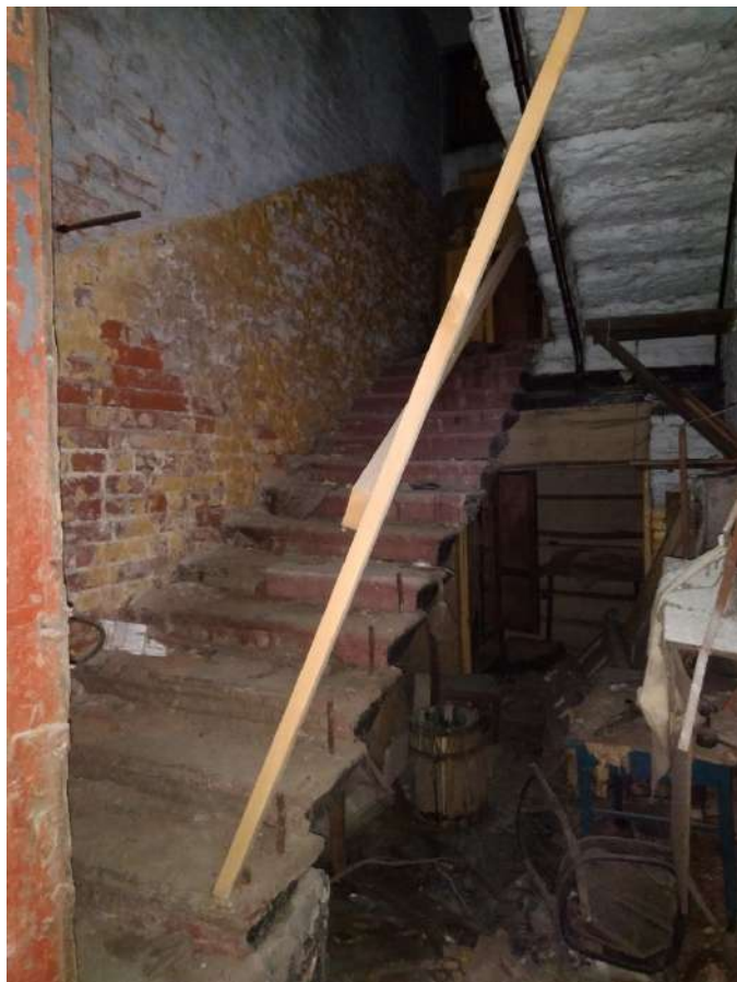
8. ОКНРЗ «Сельдяной ряд Никольского рынка», расположенный по адресу: Санкт-Петербург, Щепяной переулок, дом 4–6, литера А. Историческая межэтажная лестница 3ЛК (двухмаршевая, на металлических косоурах, со ступенями из известняка). Дата съемки: 19.11.2024г.
