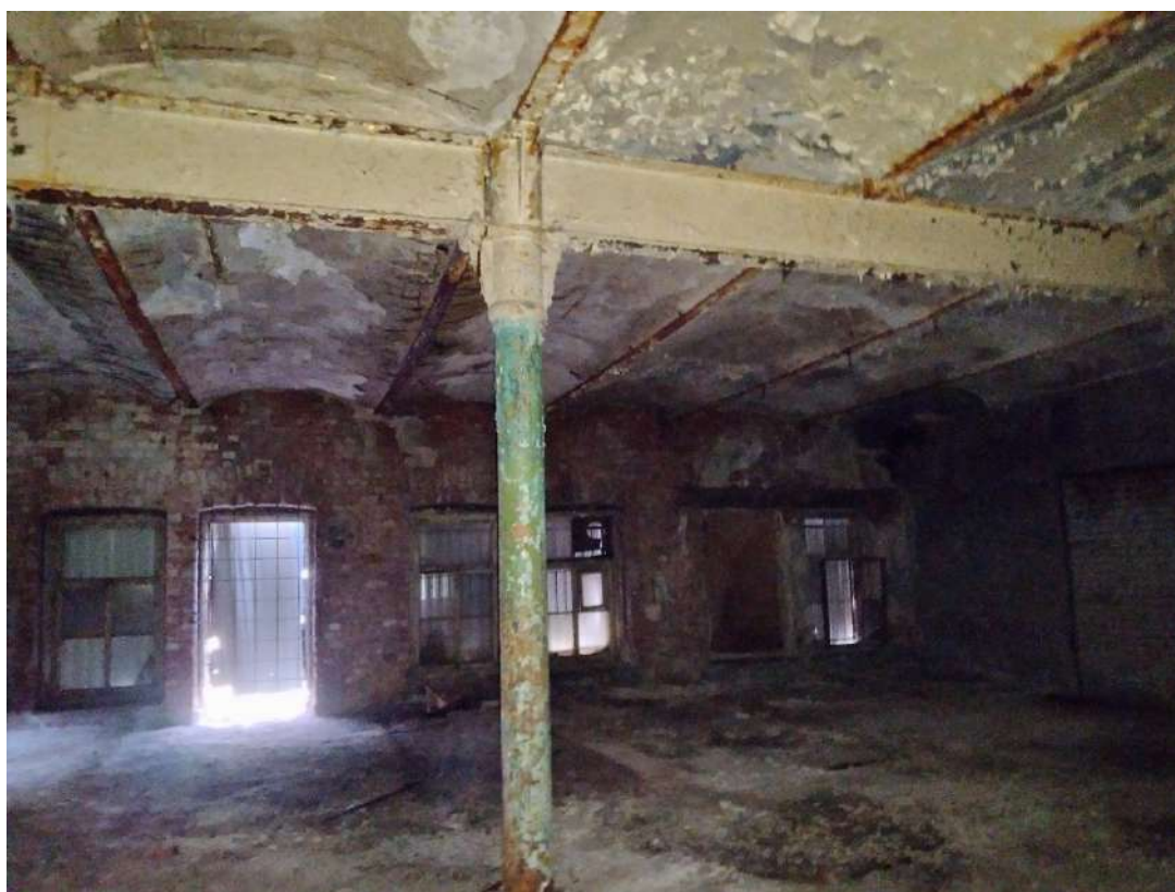
21. ОКНРЗ «Сельдяной ряд Никольского рынка», расположенный по адресу: Санкт-Петербург, Щепяной переулок, дом 4–6, литера А. Металлические колонны, поддерживающие металлические балки. Междуэтажные перекрытия. Дата съемки: 19.11.2024г.
