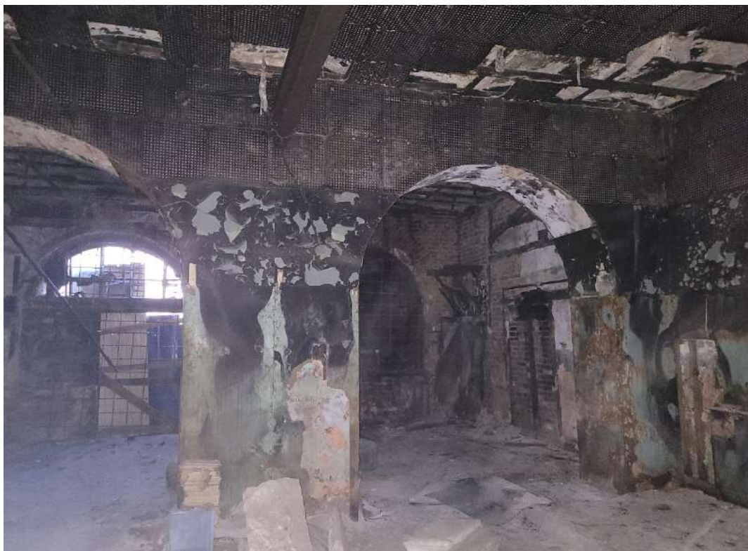
12. ОКНРЗ «Сельдяной ряд Никольского рынка», расположенный по адресу: Санкт-Петербург, Щепяной переулок, дом 4–6, литера А. Интерьеры первого этажа. Дата съемки: 19.11.2024г.
