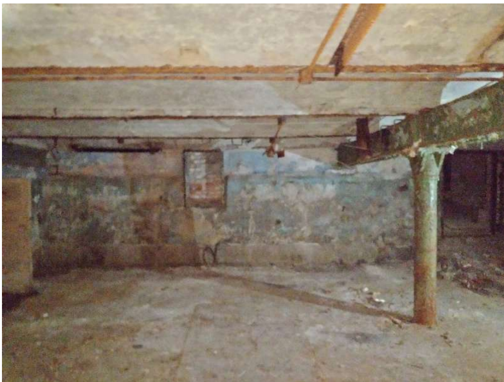
14. ОКНРЗ «Сельдяной ряд Никольского рынка», расположенный по адресу: Санкт-Петербург, Щепяной переулок, дом 4–6, литера А. Металлические колонны, поддерживающие металлические балки. Междуэтажные перекрытия. Дата съемки: 19.11.2024г.
