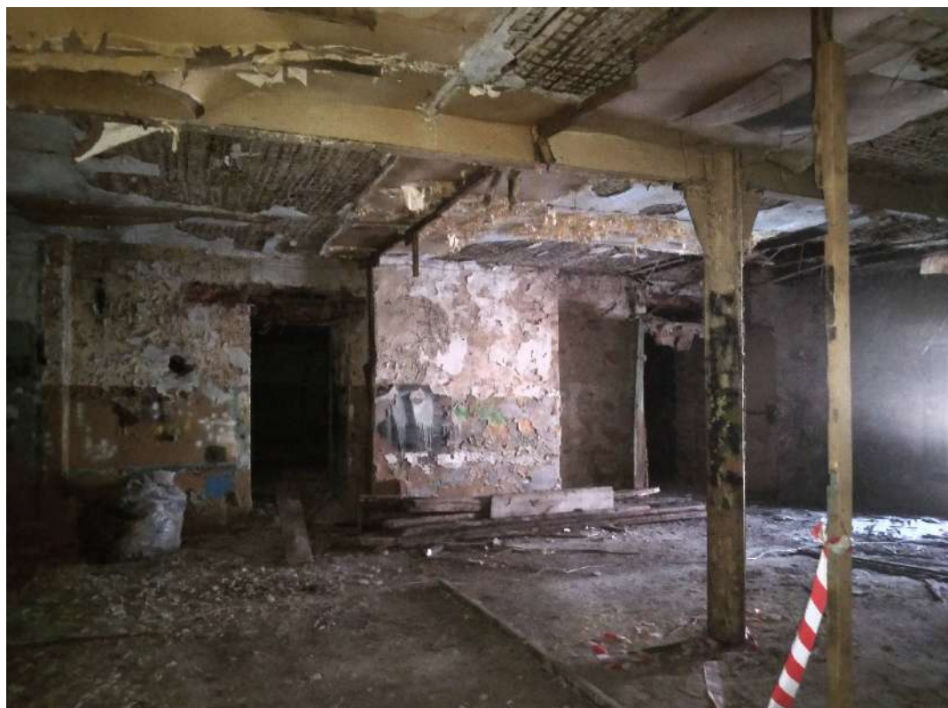
23. ОКНРЗ «Сельдяной ряд Никольского рынка», расположенный по адресу: Санкт-Петербург, Щепяной переулок, дом 4–6, литера А. Металлические колонны, поддерживающие металлические балки. Междуэтажные перекрытия. Дата съемки: 19.11.2024г.
