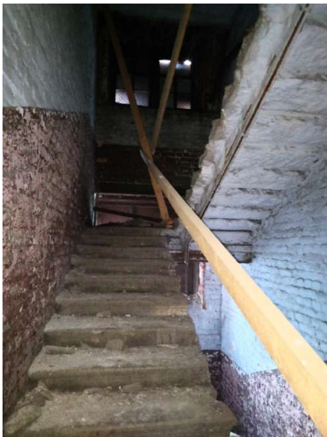
6. ОКНРЗ «Сельдяной ряд Никольского рынка», расположенный по адресу: Санкт-Петербург, Щепяной переулок, дом 46, литера А. Историческая межэтажная лестница 2ЛК (двухмаршевая, на металлических косоурах, со ступенями из известняка). Дата съемки: 19.11.2024г.
