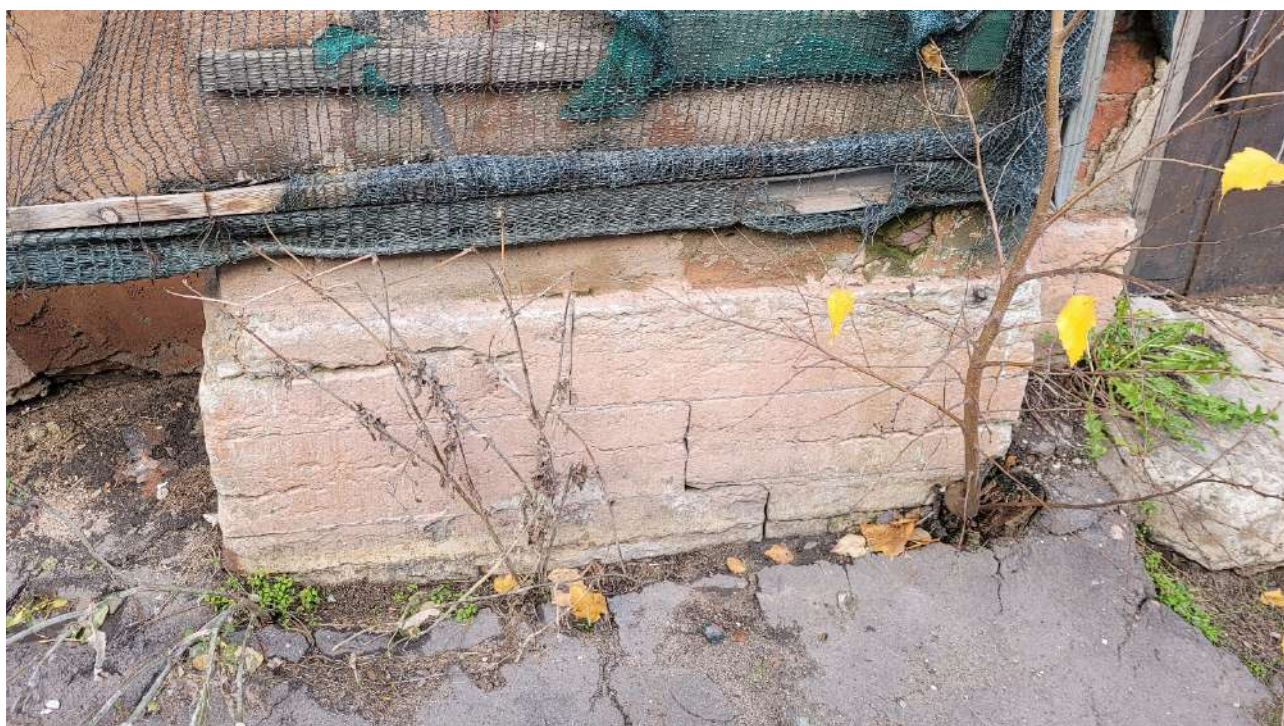
8. ОКНРЗ «Сельдяной ряд Никольского рынка», расположенный по адресу: Санкт-Петербург, Щепяной переулок, дом 4–6, литера А. Южный фасад со стороны Кустарного переуллка. Материал облицовки цоколя – известняк. Дата съемки: 19.11.2024г.
