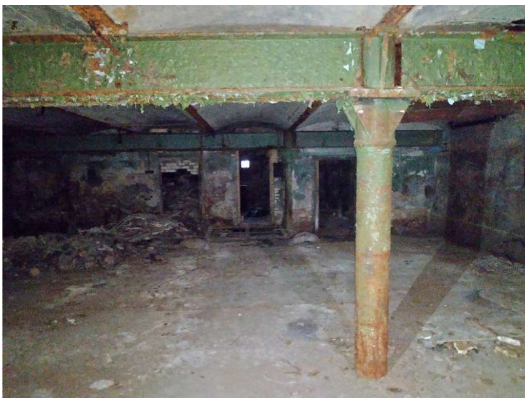
13. ОКНРЗ «Сельдяной ряд Никольского рынка», расположенный по адресу: Санкт-Петербург, Щепяной переулок, дом 4–6, литера А. Металлические колонны, поддерживающие металлические балки. Дата съемки: 19.11.2024г.
