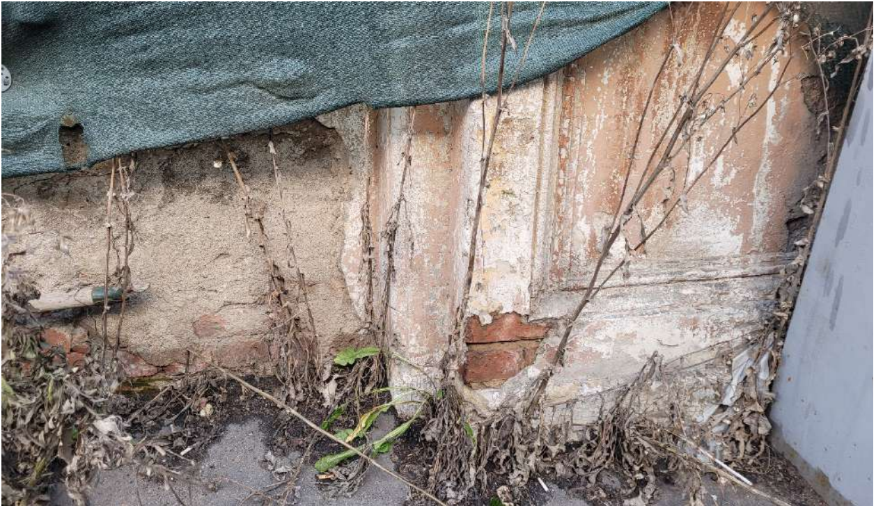
3. ОКНРЗ «Сельдяной ряд Никольского рынка», расположенный по адресу: Санкт-Петербург, Щепяной переулок, дом 4–6, литера А. Южный фасад со стороны Кустарного переуллка. Материал и характер обработки фасадной поверхности – гладкая окрашенная штукатурка. Дата съемки: 19.11.2024г.
