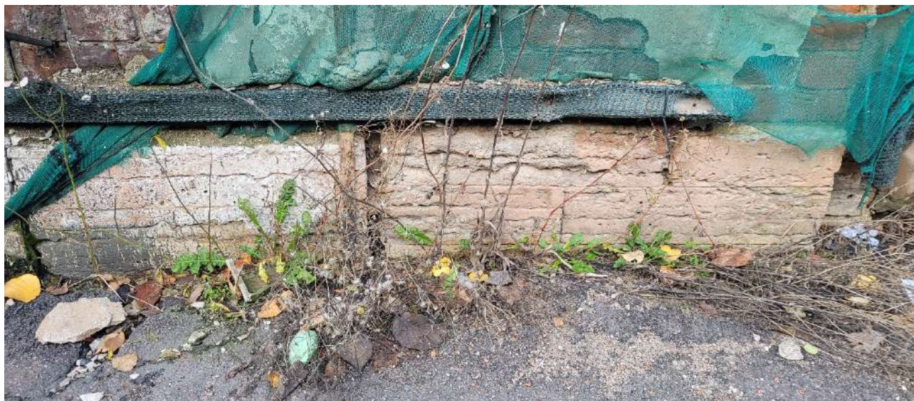
7. ОКНРЗ «Сельдяной ряд Никольского рынка», расположенный по адресу: Санкт-Петербург, Щепяной переулок, дом 4–6, литера А. Южный фасад со стороны Кустарного переуллка. Материал облицовки цоколя – известняк. Дата съемки: 19.11.2024г.
