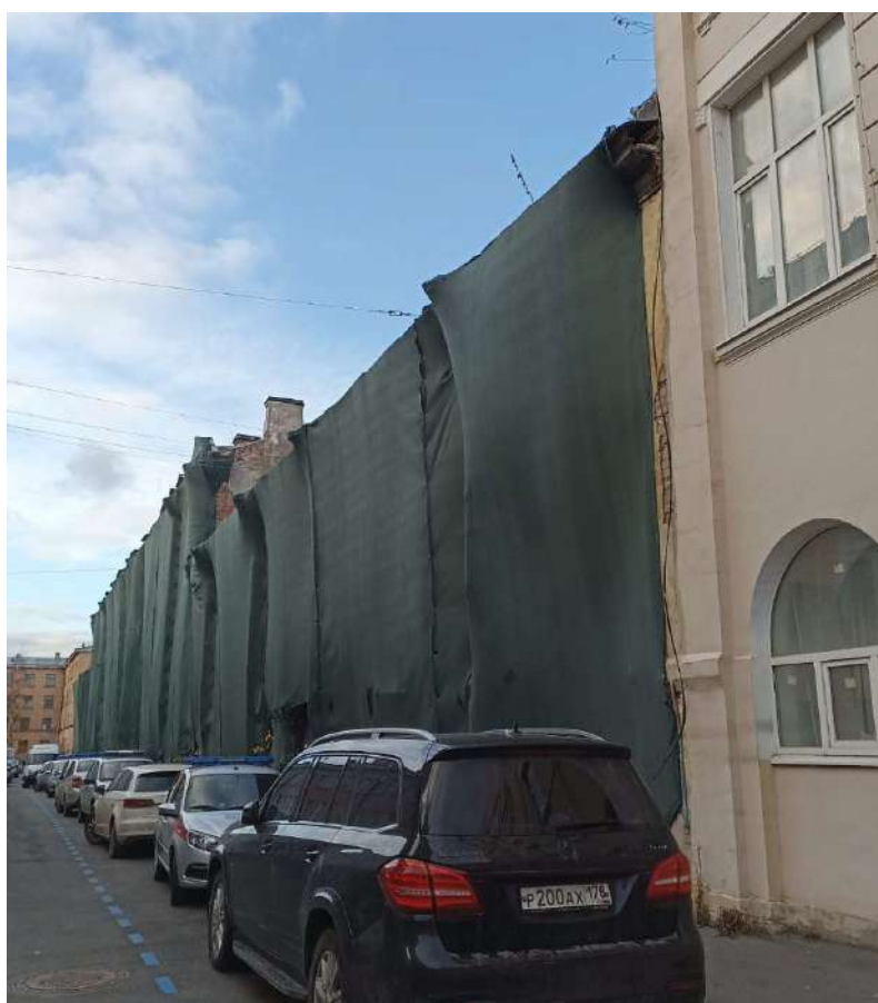
2. ОКНРЗ «Сельдяной ряд Никольского рынка», расположенный по адресу: Санкт-Петербург, Щепяной переулок, дом 4–6, литера А. Южный фасад со стороны Кустарного переуллка. Общий вид. Дата съемки: 19.11.2024г.
