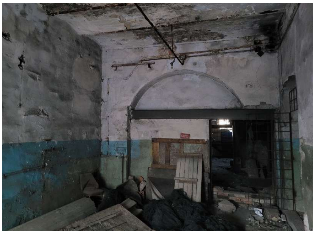
11. ОКНРЗ «Сельдяной ряд Никольского рынка», расположенный по адресу: Санкт-Петербург, Щепяной переулок, дом 4–6, литера А. Интерьеры первого этажа. Дата съемки: 19.11.2024г.
