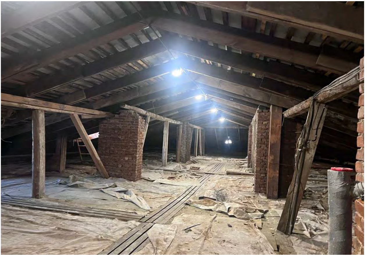
Фото 10. Выявленный ОКН «Гидротехнический институт им. Б.Е. Веденеева (лицевой корпус с примыкающими дворовыми флигелями)», расположенного по адресу: Санкт-Петербург, Гжатская д. 21, лит. А. Крыша. Стропильная система. Фрагмент. Съемка 16.08.2024 г.
