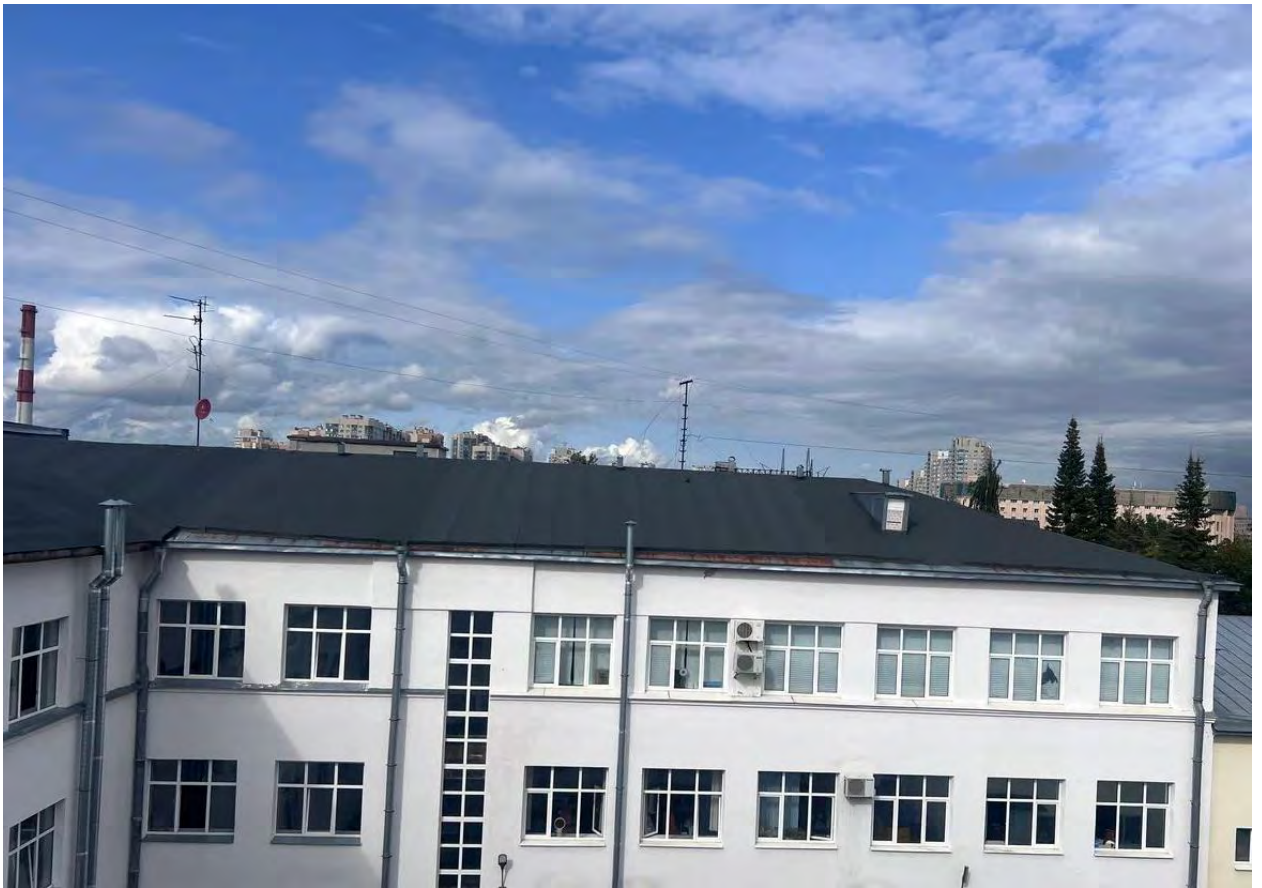
Фото 02. Выявленный ОКН «Гидротехнический институт им. Б.Е. Веденеева (лицевой корпус с примыкающими дворовыми флигелями)», расположенного по адресу: Санкт-Петербург, Гжатская д. 21, лит. А. Кровля. Фрагмент. Съёмка 16.08.2024 г.
