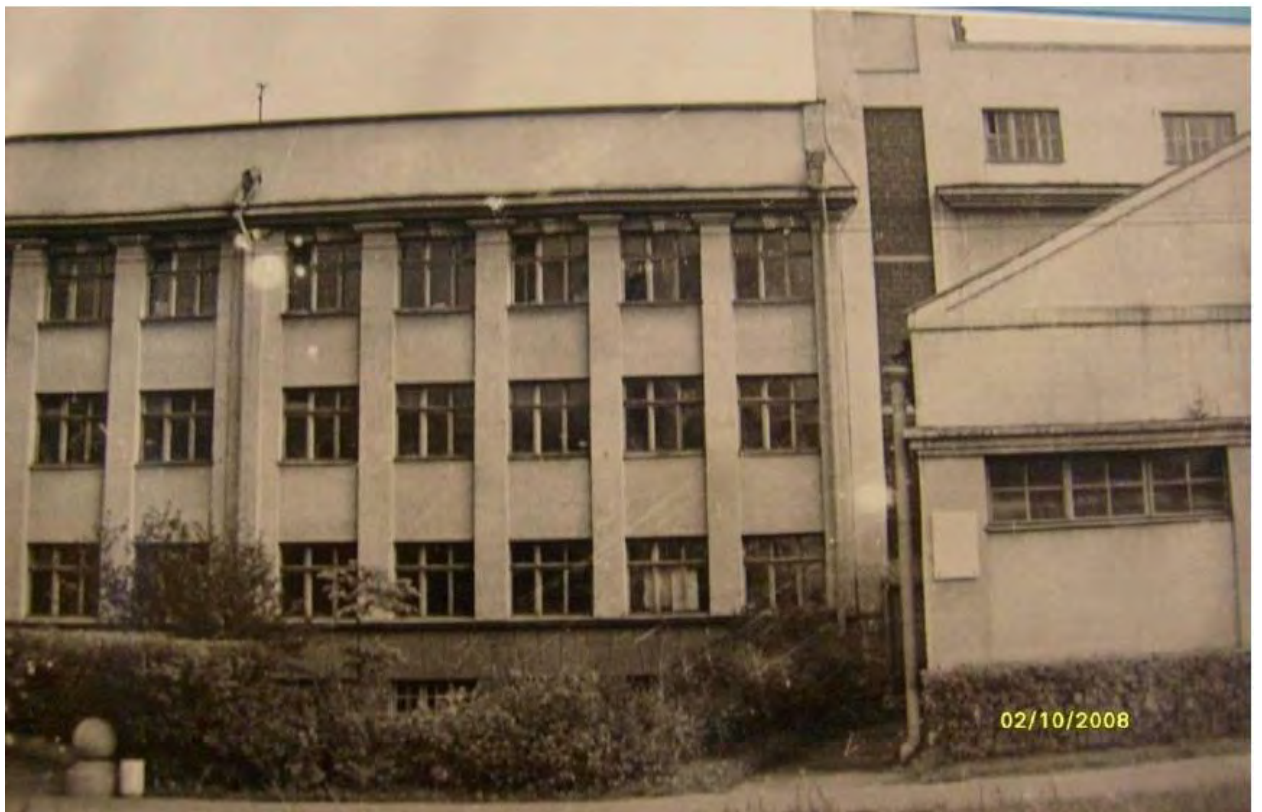
36. ВНИИГ им. Веденева. Лицевой корпус. Фото 1960-х.гг. По материалам музея ОАО ВНИИГ им. Б.Е. Веденева
