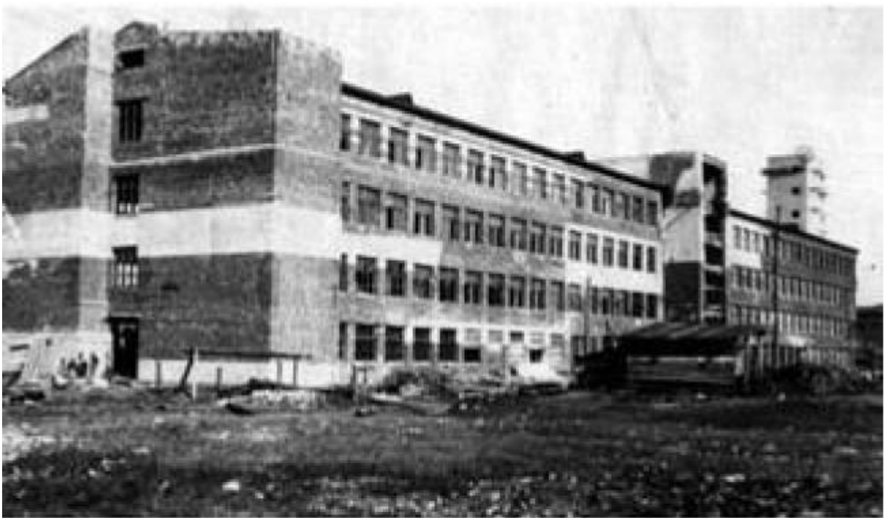
60. Учебный корпус в процессе строительства. 1934 г.
