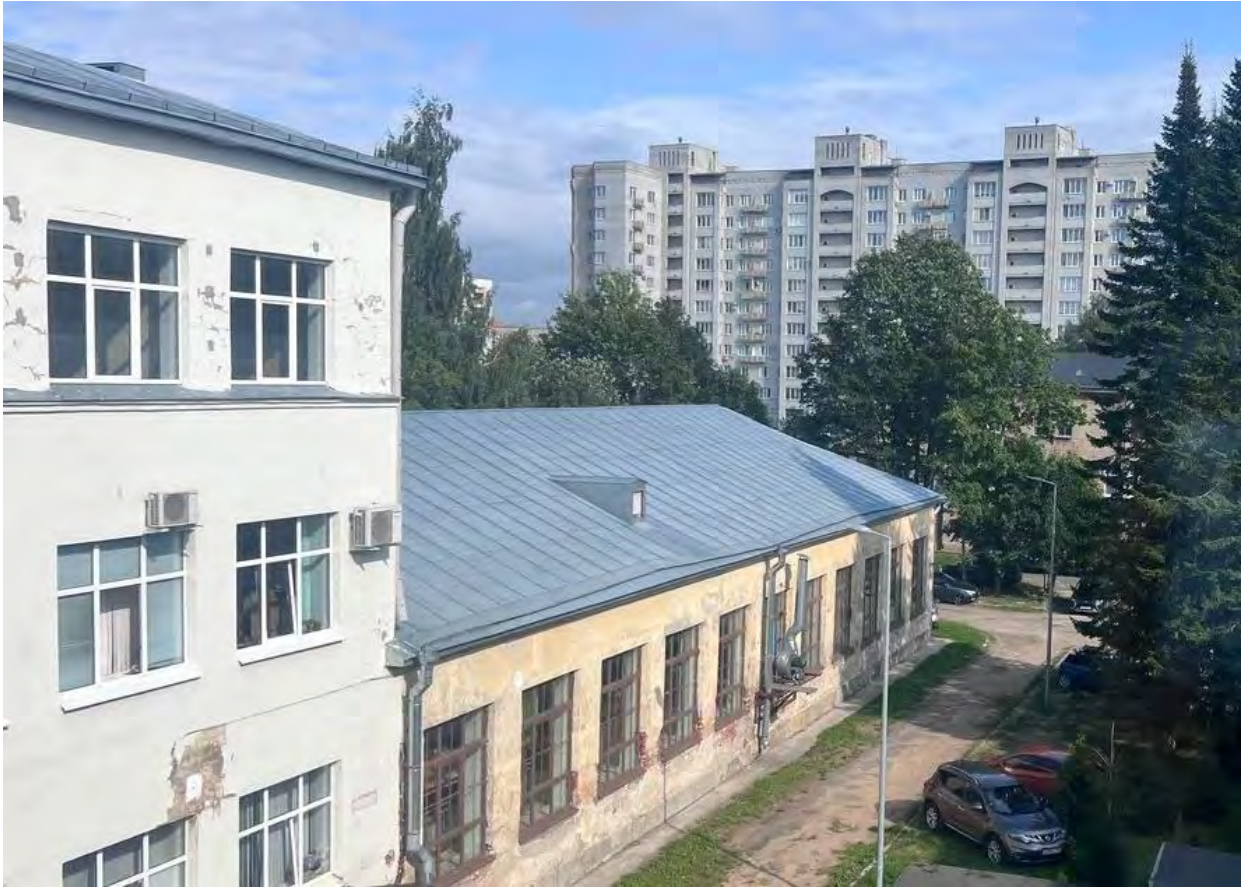
Фото 05. Выявленный ОКН «Гидротехнический институт им. Б.Е. Веденеева (лицевой корпус с примыкающими дворовыми флигелями)», расположенного по адресу: Санкт-Петербург, Гжатская д. 21, лит. А. Кровля. Фрагмент. Съёмка 16.08.2024 г.
