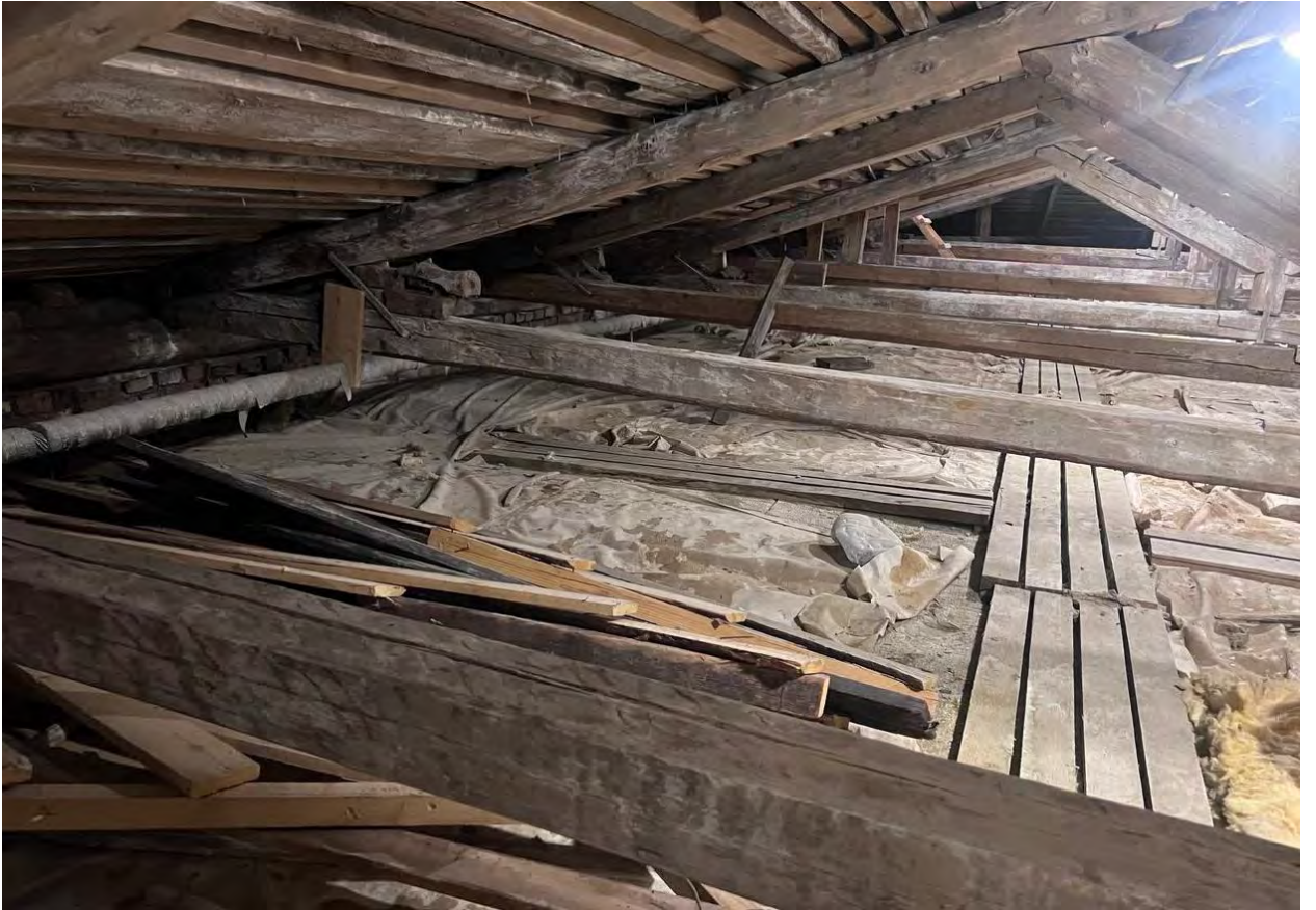
Фото 09. Выявленный ОКН «Гидротехнический институт им. Б.Е. Веденеева (лицевой корпус с примыкающими дворовыми флигелями)», расположенного по адресу: Санкт-Петербург, Гжатская д. 21, лит. А. Крыша. Стропильная система. Фрагмент. Съёмка 16.08.2024 г.
