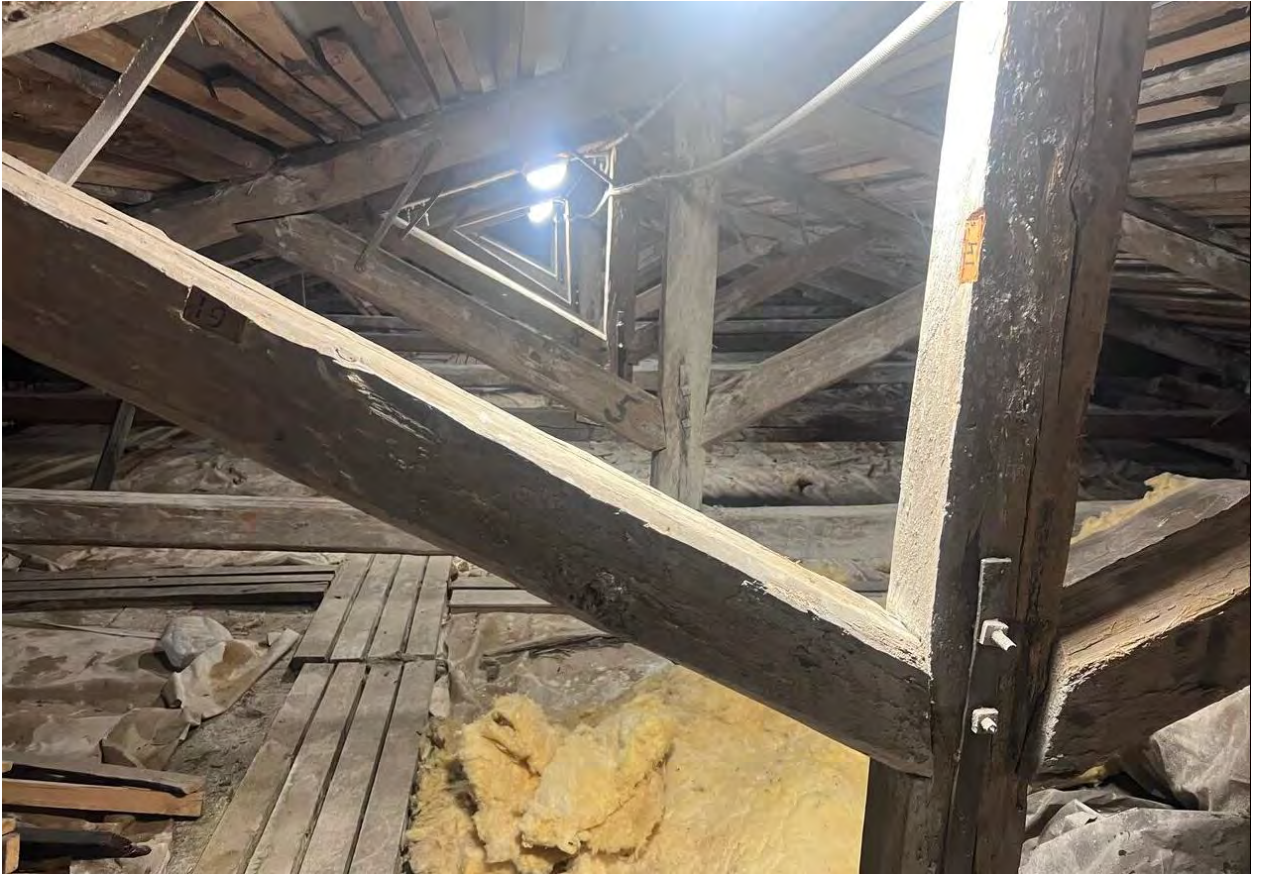
Фото 08. Выявленный ОКН «Гидротехнический институт им. Б.Е. Веденеева (лицевой корпус с примыкающими дворовыми флигелями)», расположенного по адресу: Санкт-Петербург, Гжатская д. 21, лит. А. Крыша. Стропильная система. Фрагмент. Съёмка 16.08.2024 г.
