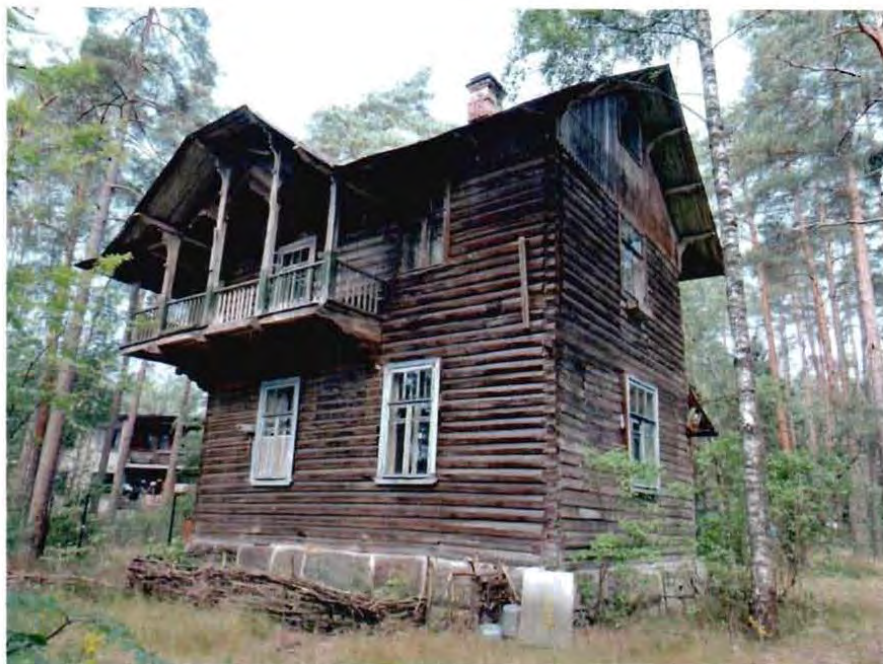
4. Вид на южный фасад объекта культурного наследия
