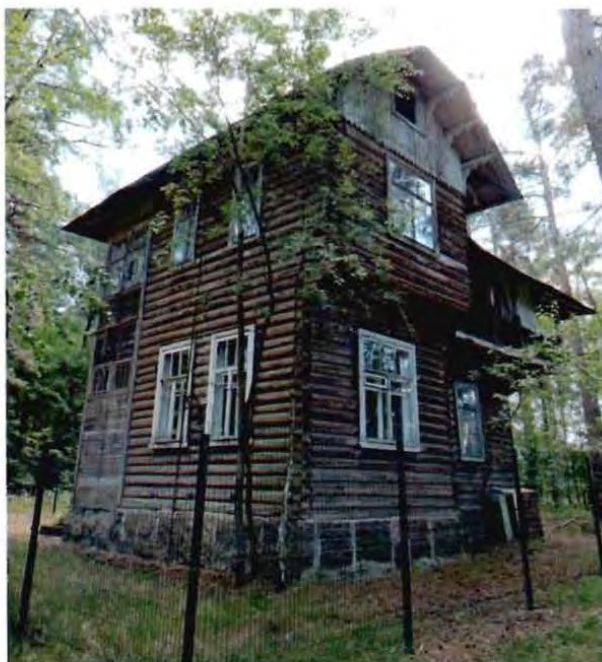
3. Вид на северный и западный фасады объекта культурного наследия
