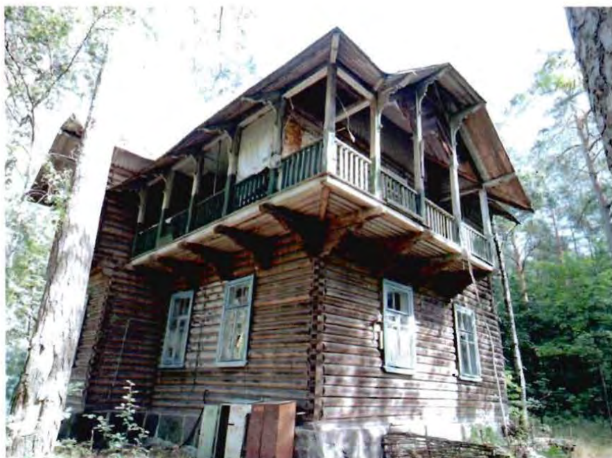
5. Вид на западный и южный фасад объекта культурного наследия. Балкон на резных кронштейнах
