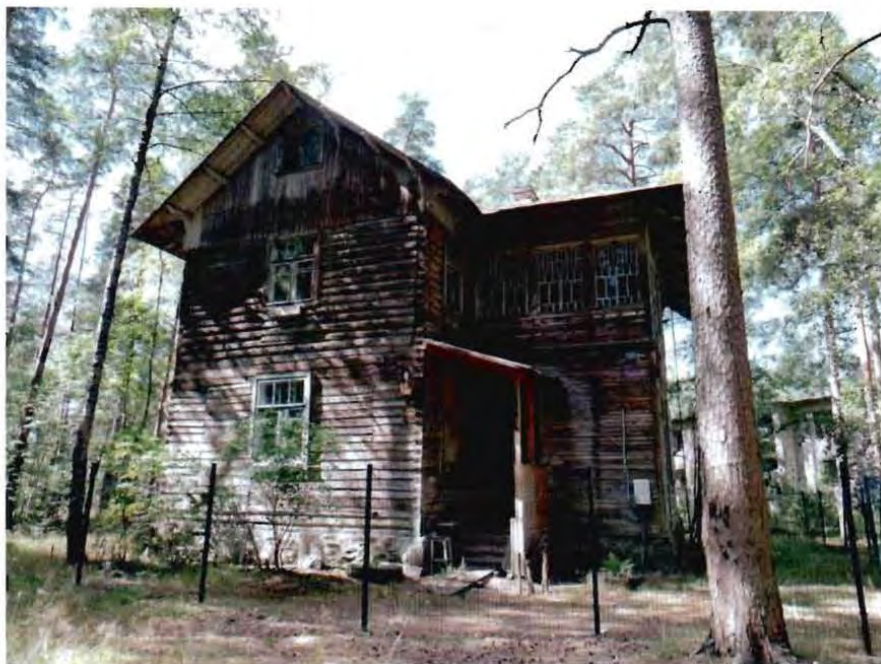
2. Вид на восточный фасад объекта культурного наследия
