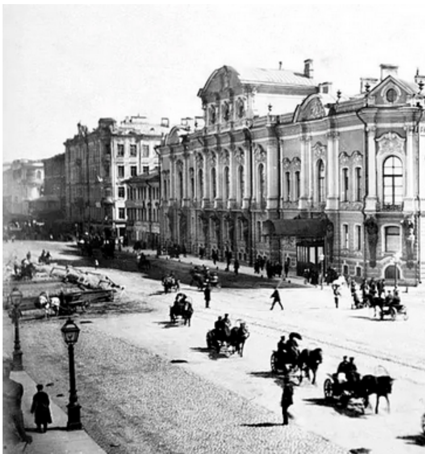
16. Фото 1881-1882 гг. (фрагмент). — Дом Кожевникова // Citywalls.ru – архитектурный сайт Петербурга [Электронный ресурс]. URL: https://www.citywalls.ru/house2008.html .
