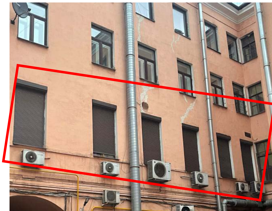
Фото 3. Фрагмент дворового фасада (окна помещения 14-Н) выявленного объекта культурного наследия «Дом Кожевникова»
