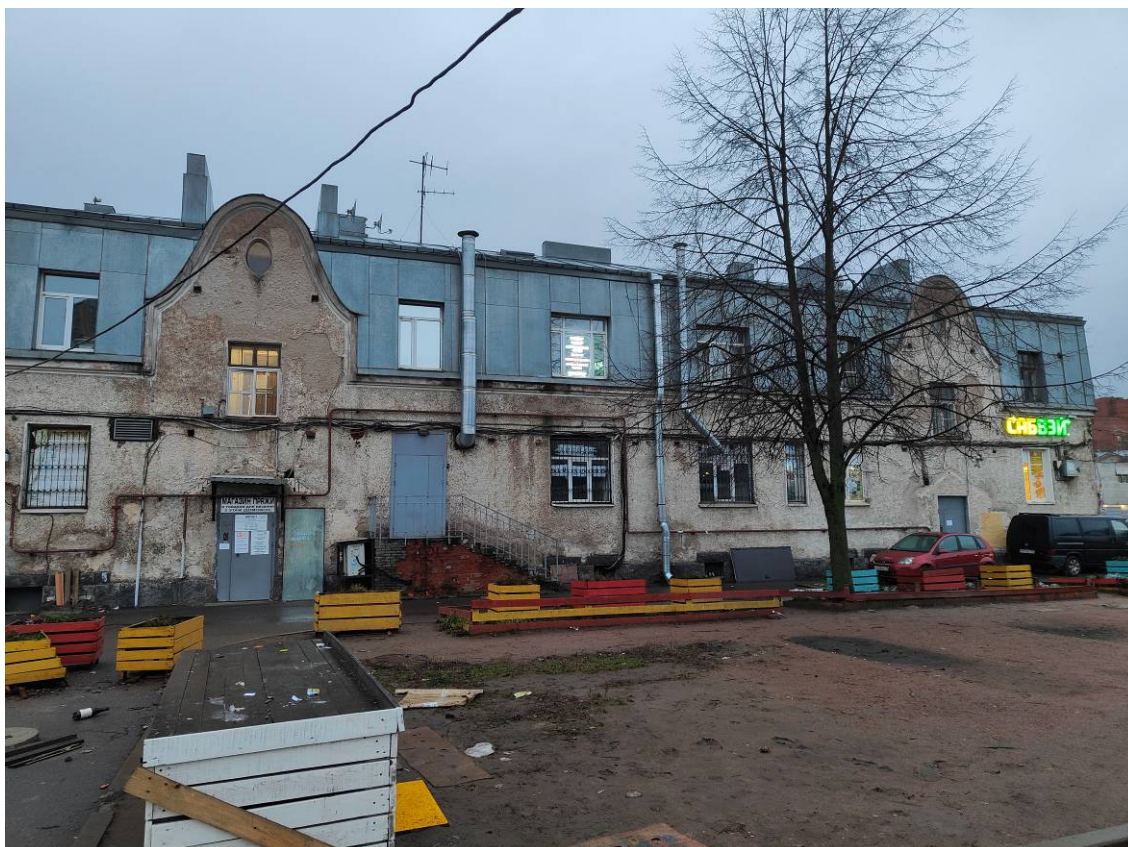
Фото 5 Фасад объекта культурного наследия «Жилой дом», входящего в состав объекта культурного наследия регионального значения «Железнодорожная станция Удельная»
