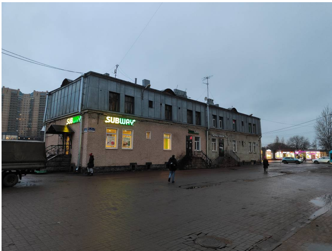
Фото 1 Фасад объекта культурного наследия «Жилой дом», входящего в состав объекта культурного наследия регионального значения «Железнодорожная станция Удельная»
