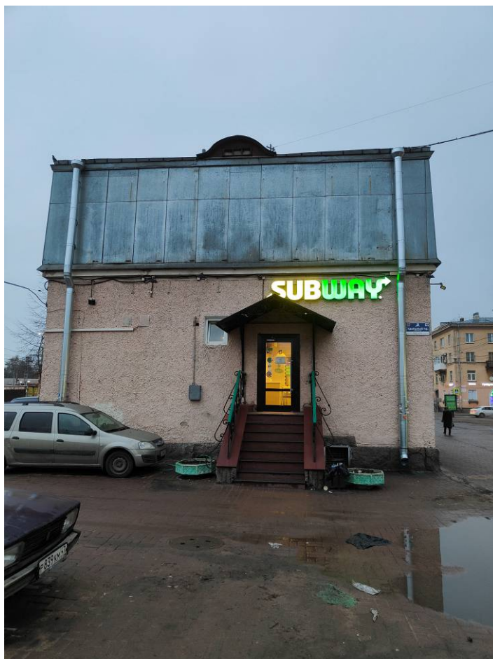
Фото 3 Фасад объекта культурного наследия «Жилой дом», входящего в состав объекта культурного наследия регионального значения «Железнодорожная станция Удельная»
