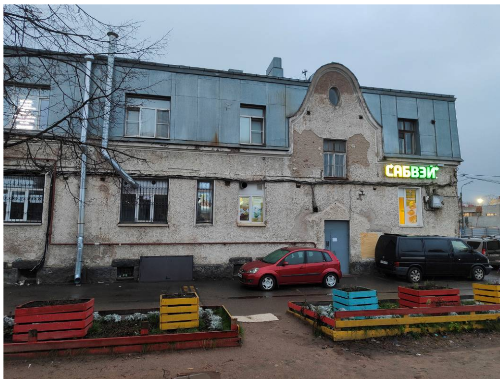
Фото 4 Фрагмент фасада объекта культурного наследия «Жилой дом», входящего в состав объекта культурного наследия регионального значения «Железнодорожная станция Удельная»
