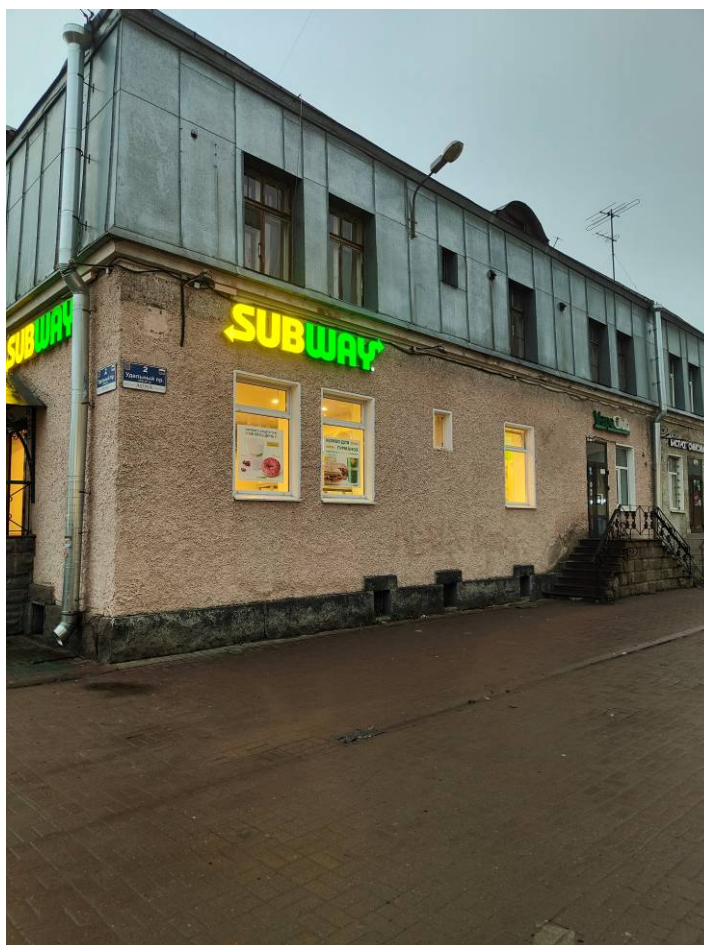
Фото 2 Фрагмент фасада объекта культурного наследия «Жилой дом», входящего в состав объекта культурного наследия регионального значения «Железнодорожная станция Удельная»
