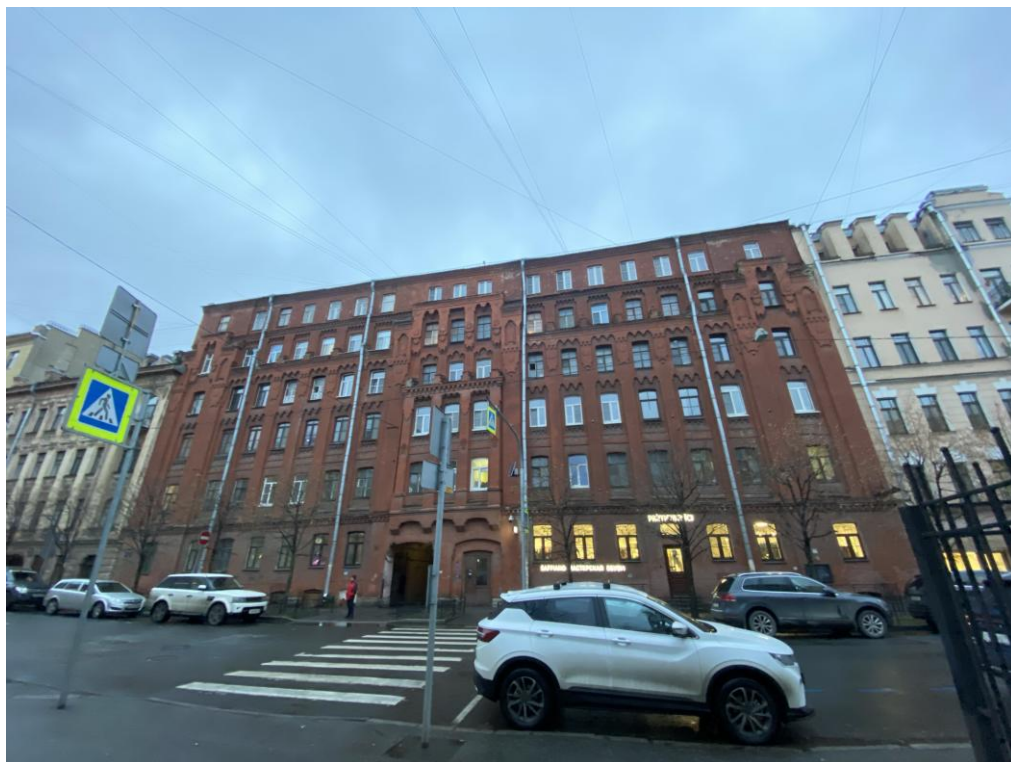
Фото 1. Лицевой фасад выявленного объекта культурного наследия «Дом Николаева» (по Кавалергардской ул.)
