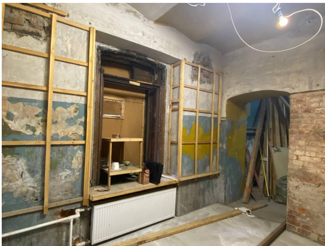
Фото 6. Интерьер пом. 8-Н выявленного объекта культурного наследия «Дом Николаева»
