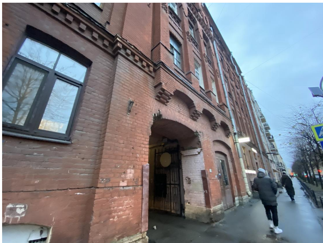
Фото 2. Фрагмент лицевого фасада выявленного объекта культурного наследия «Дом Николаева» (по Кавалергардской ул.), воротный проезд
