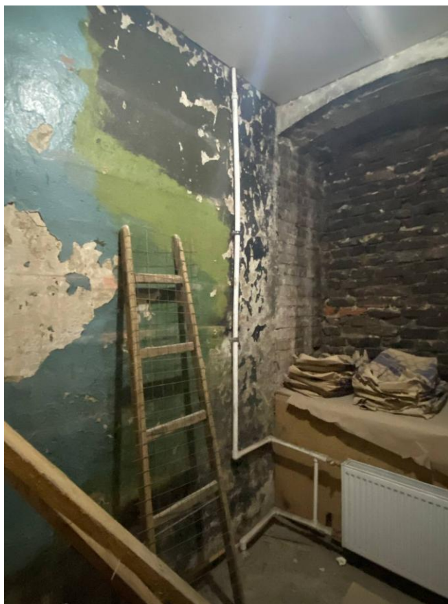
Фото 8. Интерьер пом. 8-Н выявленного объекта культурного наследия «Дом Николаева»
