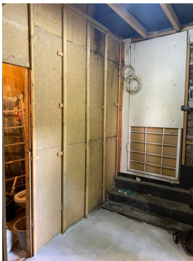
Фото 10. Интерьер пом. 8-Н выявленного объекта культурного наследия «Дом Николаева»
