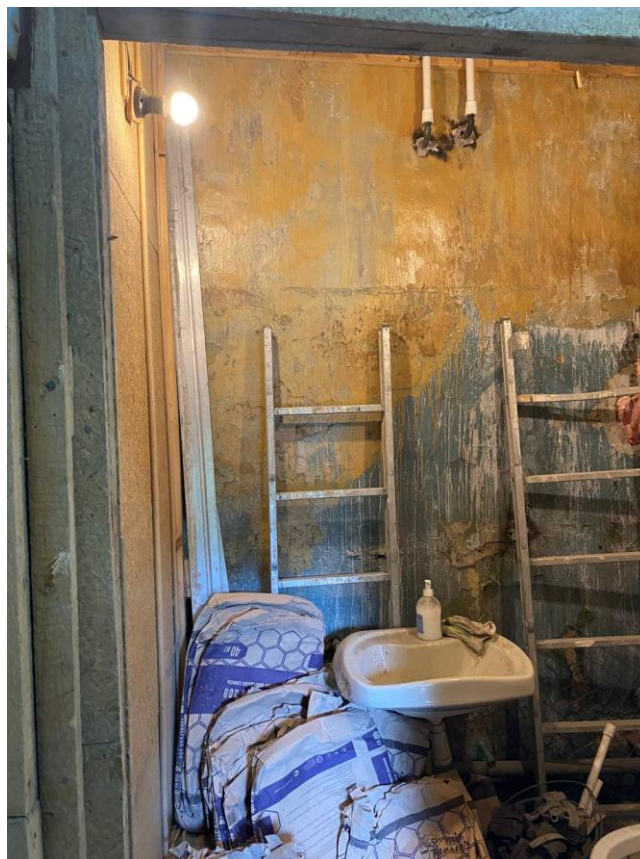
Фото 11. Интерьер пом. 8-Н выявленного объекта культурного наследия «Дом Николаева»
