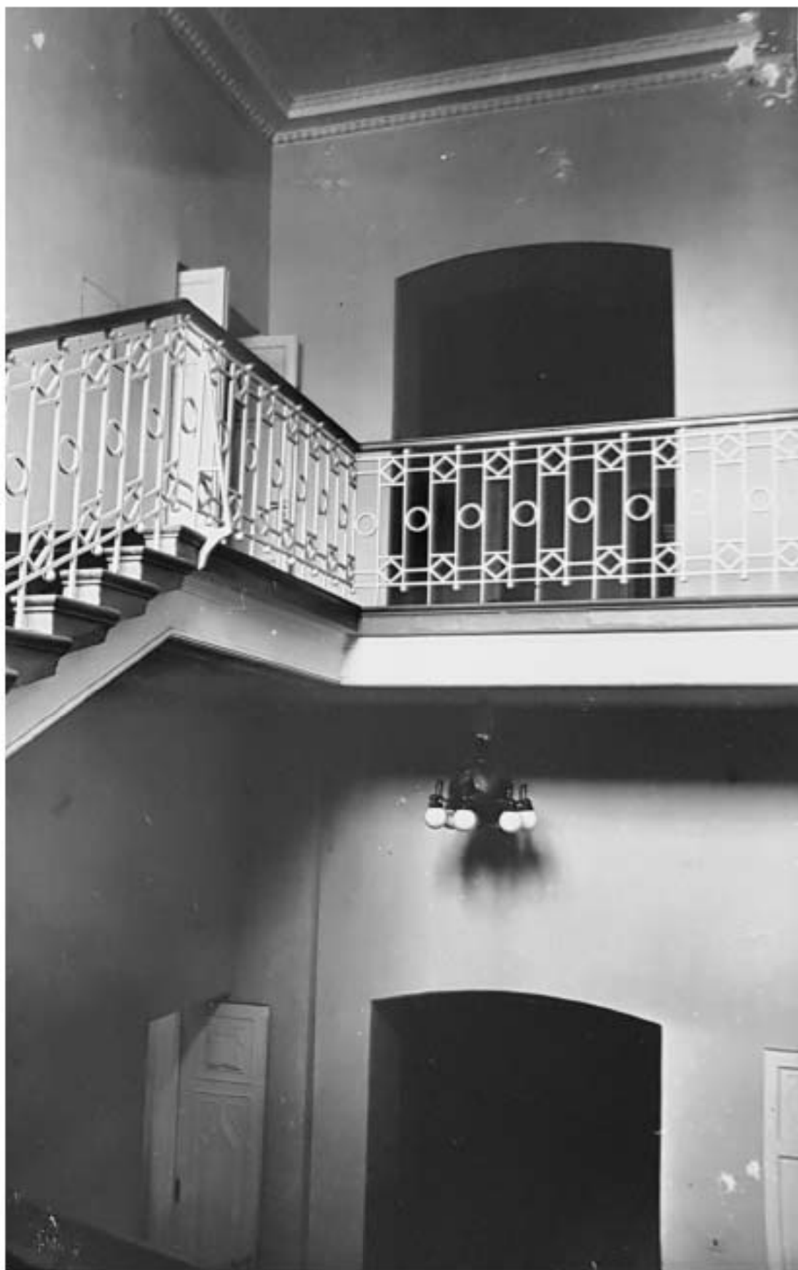
29. Лестница. Фото 1985 г. Архив КТИОП, П.226-Г-8. Н-2055-1.
