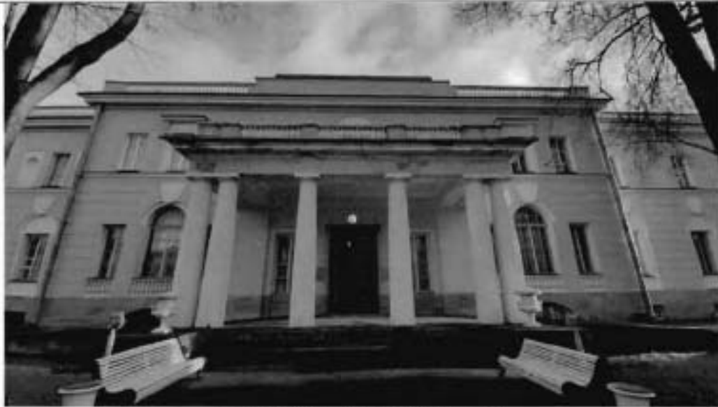
1. Фрагмент западного фасада
