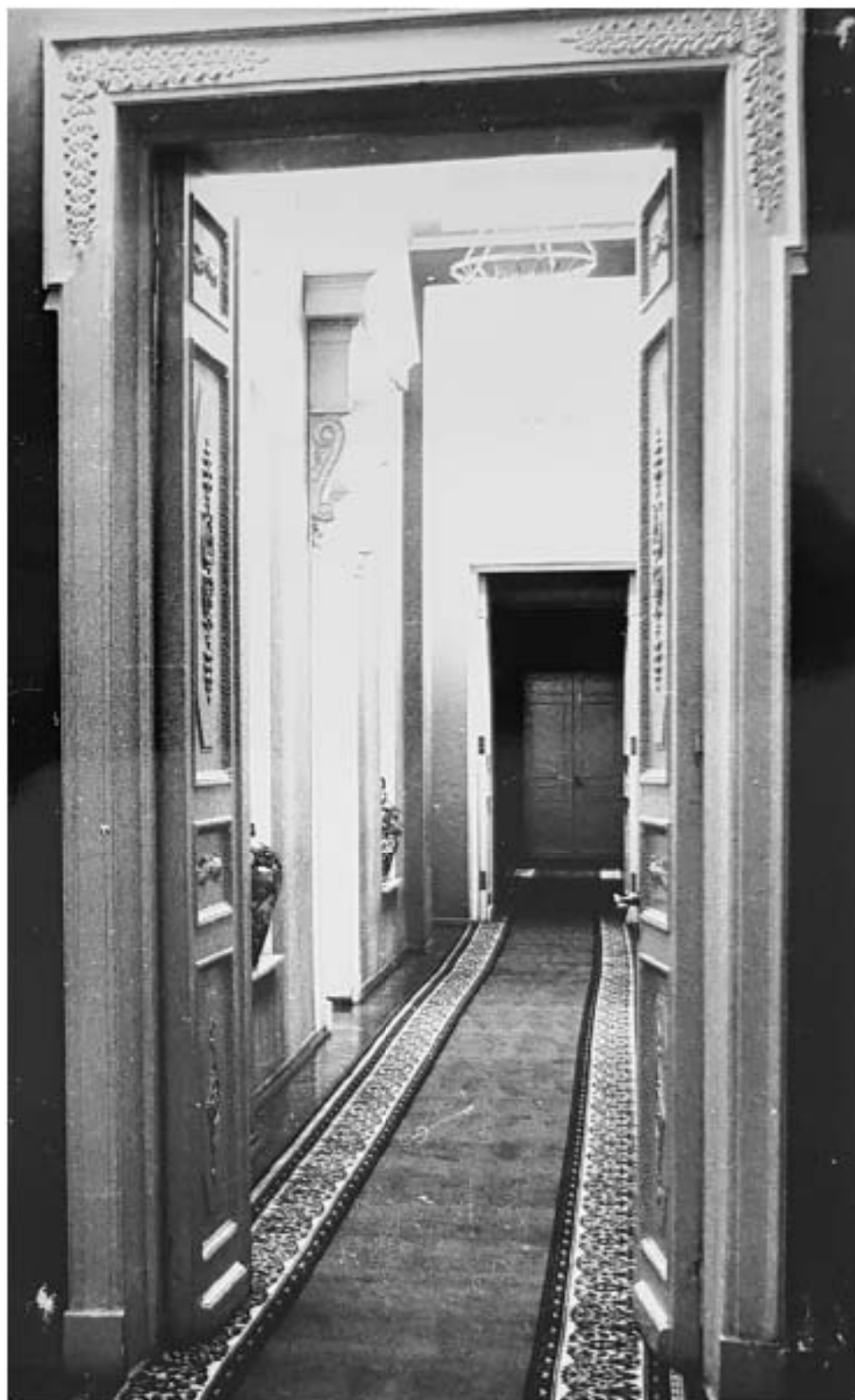
26. Коридор 1-го этажа. Фото 1985 г. Архив КГИОП, П.226-Г-8. Н-2055-1.
