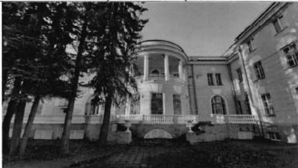
2. Фрагмент восточного фасада
