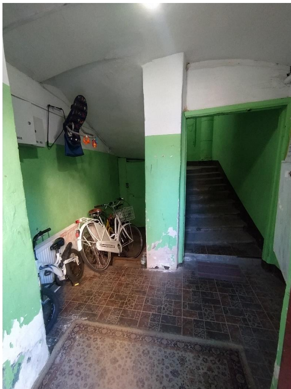
Фото 6. Вид на дворовую лестницу № 4 со стороны входа.
