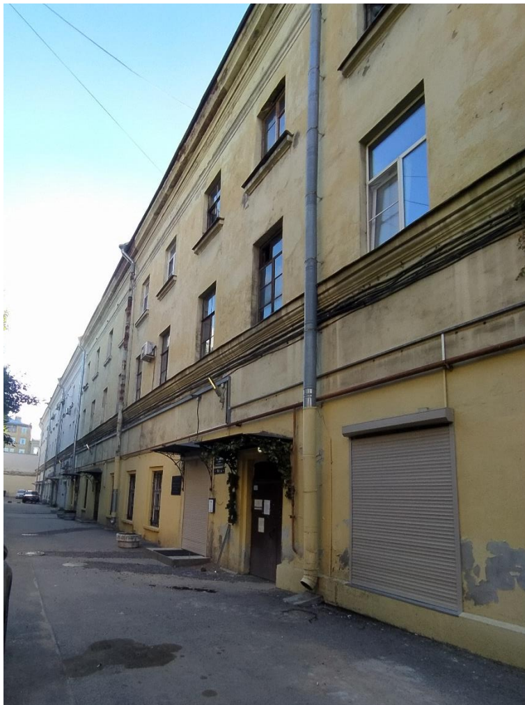
Фото 4. Вид на дворовый (южный) фасад здания в западном направлении .
