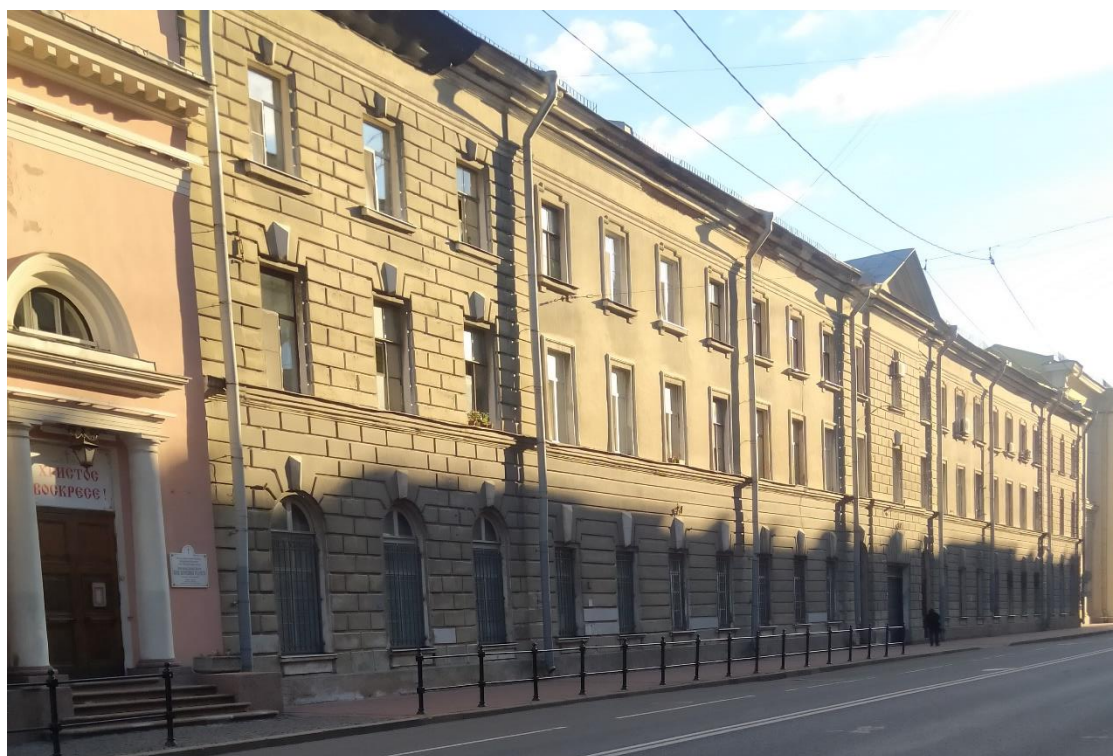
Фото 1. Выявленный объект культурного наследия «Конторский дом» (в составе «Комплекс зданий Конторского двора Гоф-интендантской конторы») Общий вид лицевого (северного) фасада здания по Шпалерной улице.
