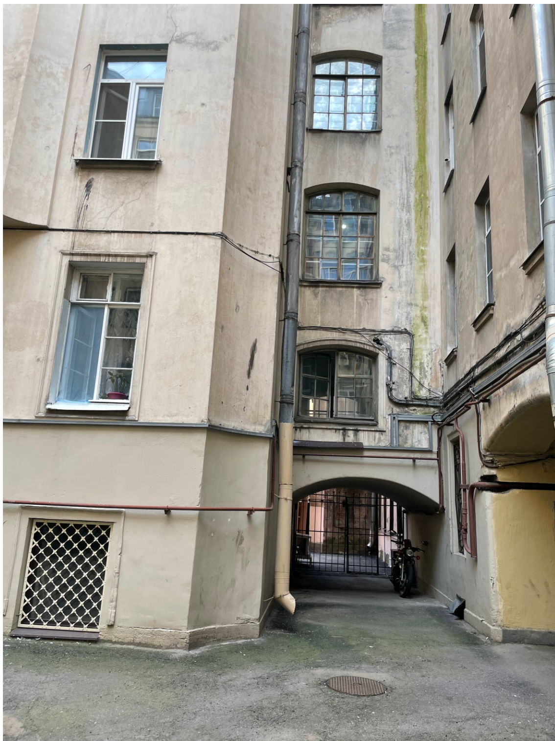
2. “Дом В.В. Фофановой”. Санкт-Петербург, 6-я Красноармейская ул., дом 3, лит.А. 1-й двор. Дворовой восточный фасад. Фрагмент. Фото: 02.09.2024.
