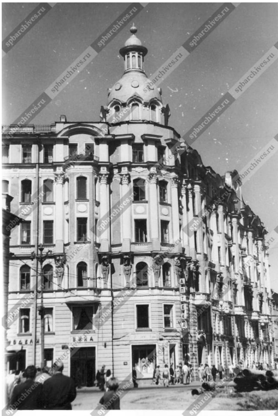
Илл. 26. Вид углового фасада, завершенного башней - ротондой дома № 96 на Большом проспекте Петроградской стороны (бывший доходный дом В.Г. и О.М.Чубаковых, архитектор В.И.Ван - дер - Гюхт, 1910 -1911 гг.). Дата: 1977 г. Источник: ЦГАКФФД СПб. Фотодокументы. Оп.1АР-152. Ед.хр.211609.
