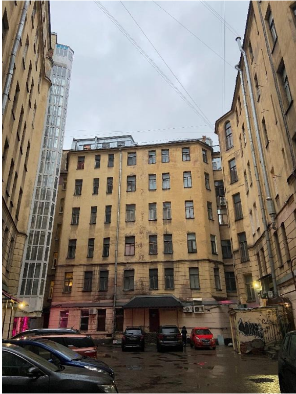
Фото 5. Вид на дворовый фасад.
