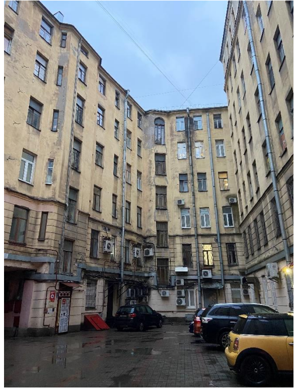
Фото 6. Вид на дворовый фасад.
