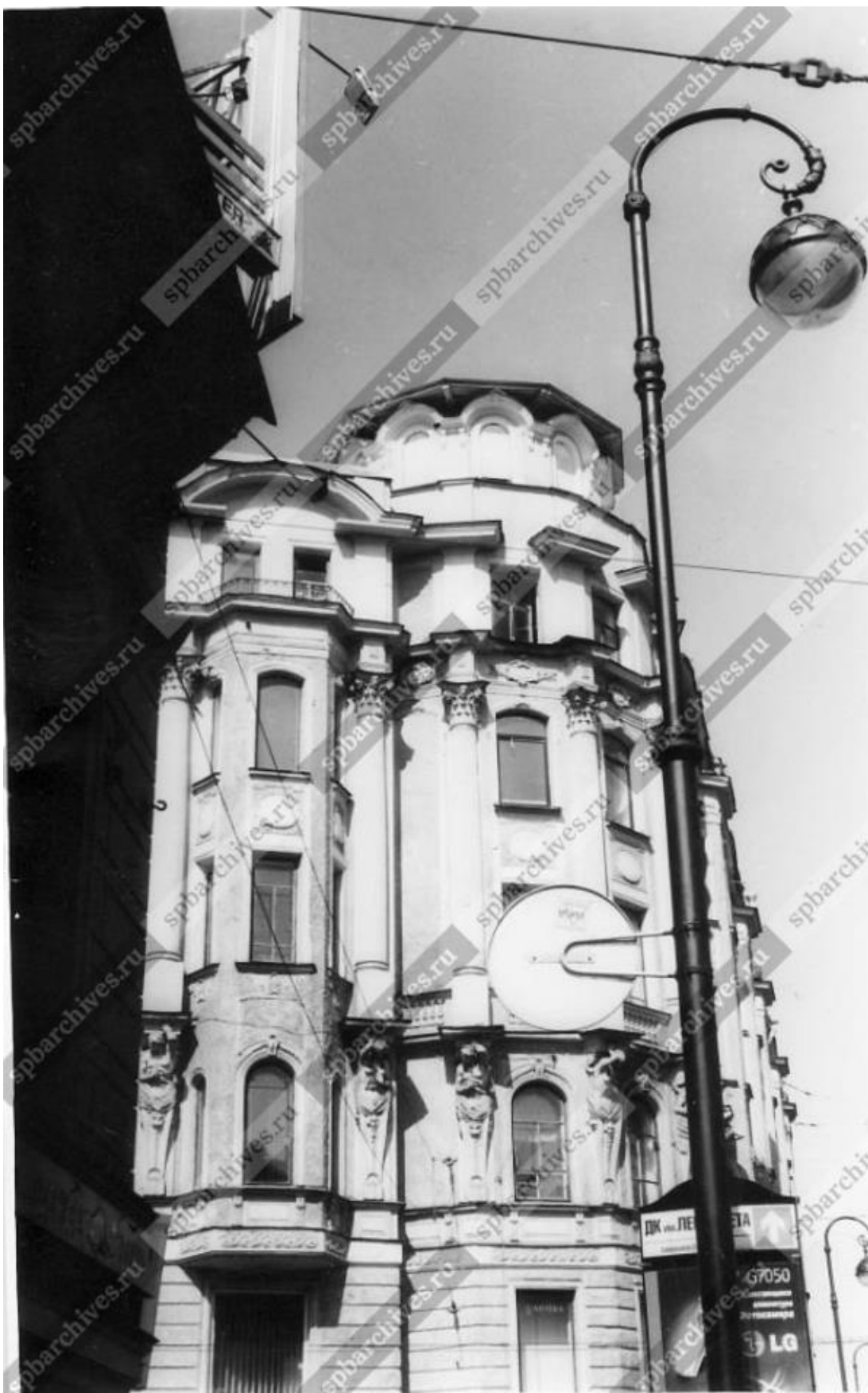
Илл. 27. Угловой фасад дома № 96/38 на Большом проспекте Петроградской стороны и Каменноостровского проспекта (купол угловой башни сгорел в 2001 г., бывший доходный дом В.Г.и О.М.Чубаковых, архитектор Ван-дер-Гюхт, 1910-1911 гг.). Дата: 2004 г. Источник: ЦГАКФФД СПб. Фотодокументы. Оп.1АР-156. Ед.хр.222304.
