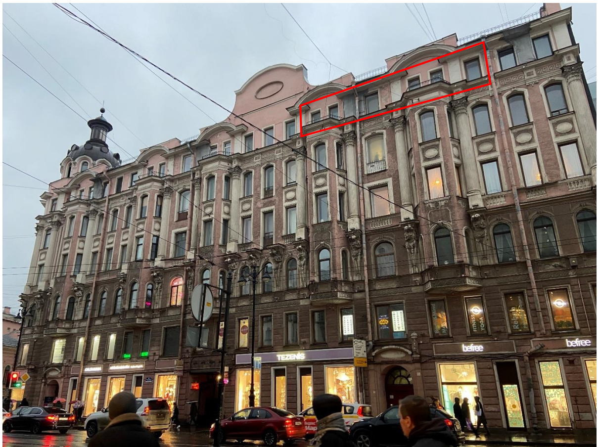
Фото 2. Лицевой фасада дома № 38 по Каменноостровскому проспекту.
