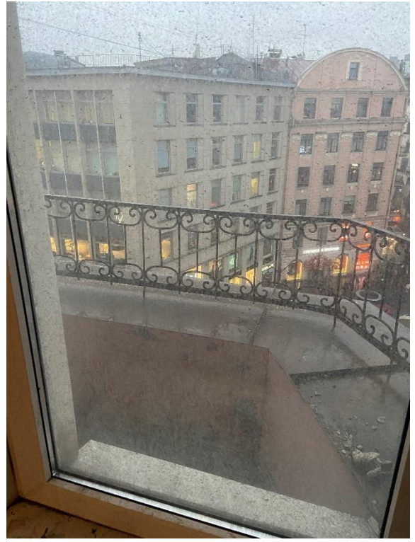
Фото 13. Вид на балкон из пом. № 4.
