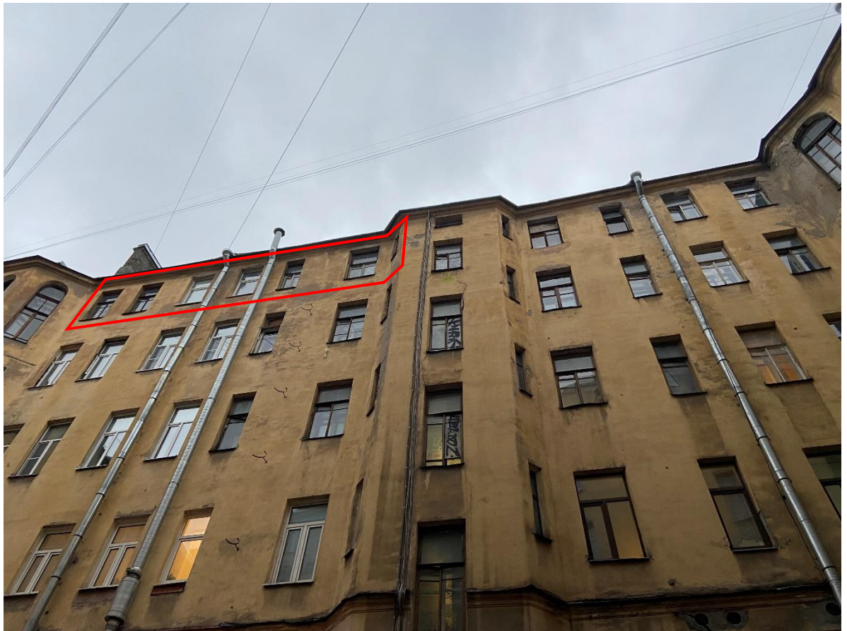
Фото 4. Вид на дворový фасад.
