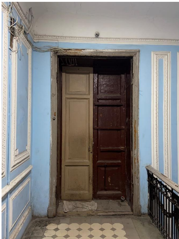
Фото 1. Вид на вход в квартиру № 19 с парадной лестницы.
