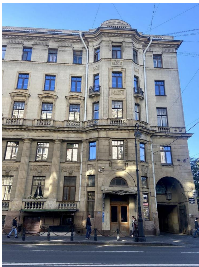
Фото 5. Фрагмент лицевого фасада со стороны Каменноостровского проспекта
