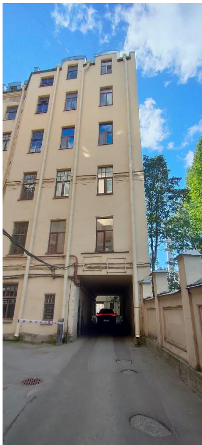
Фото 22. Фрагмент северо-западного фасада
