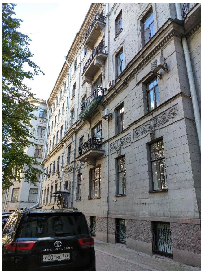
Фото 10. Фрагмент дворового фасада
