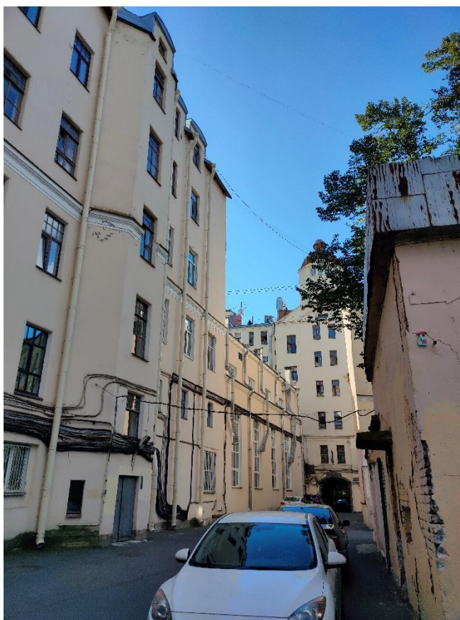
Фото 19. Фрагмент северо-западного фасада со стороны сада Андрея Петрова
