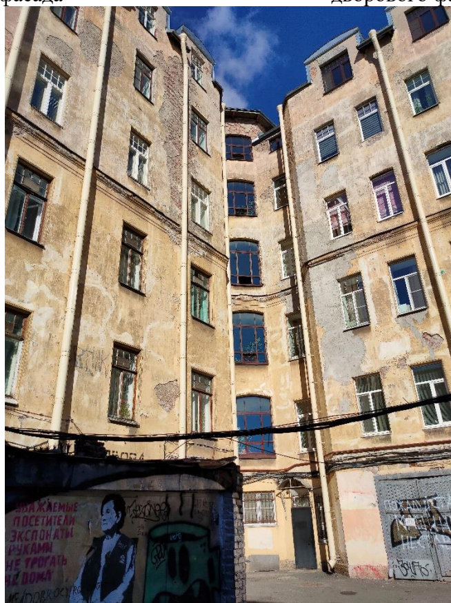
Фото 30. Фрагмент юго-западного дворового фасада
