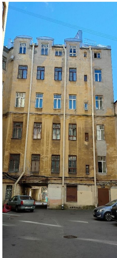
Фото 23. Фрагмент юго-западного дворового фасада
