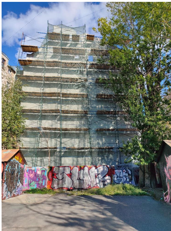
Фото 1. Фрагмент западного фасада
