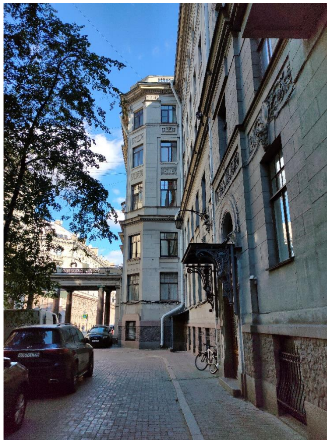
Фото 13. Фрагмент дворового фасада
