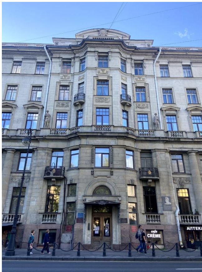
Фото 2. Фрагмент фасада со стороны Каменноостровского проспекта
