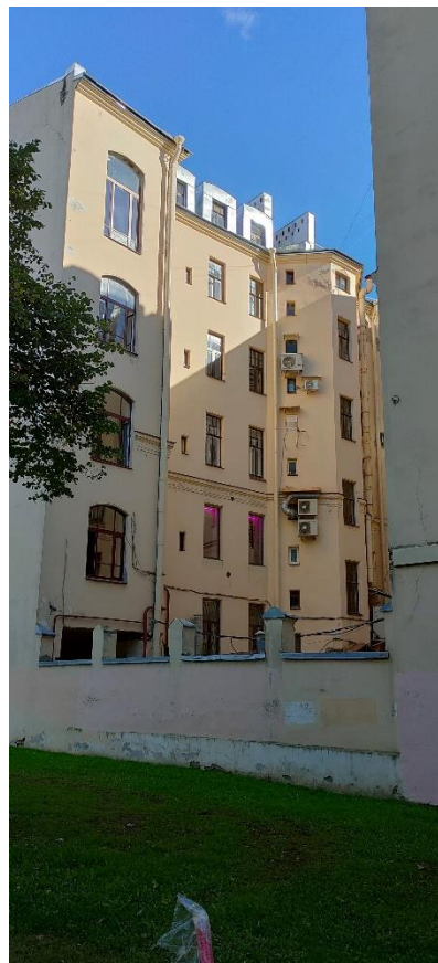
Фото 16. Фрагмент северо-западного фасада со стороны сада Андрея Петрова
