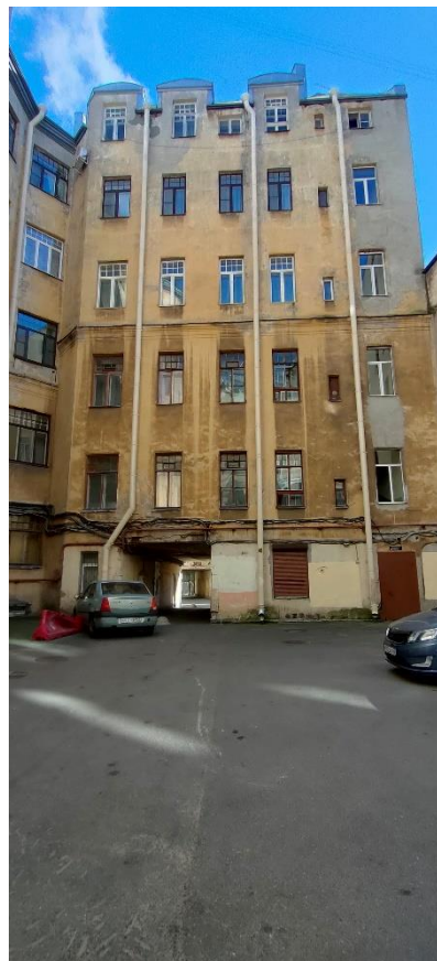
Фото 26. Фрагмент юго-западного дворового фасада
