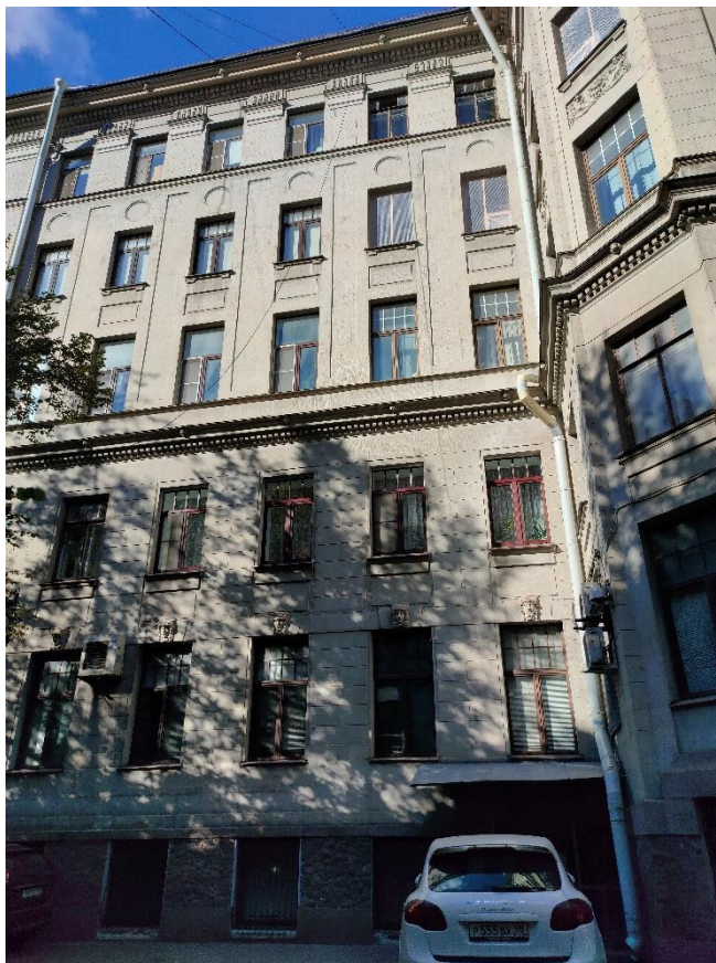
Фото 9. Фрагмент дворового фасада
