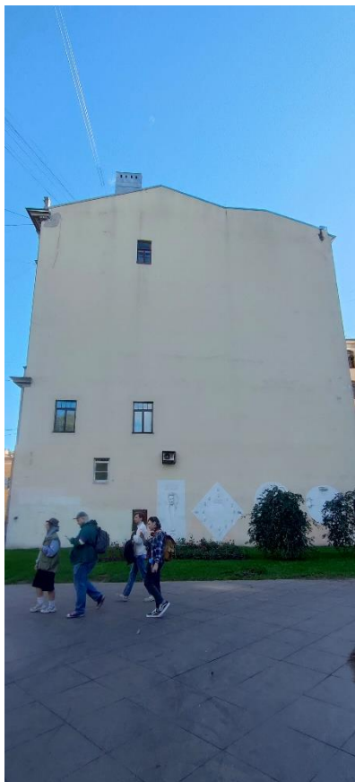
Фото 15. Фрагмент северо-западного фасада со стороны сада Андрея Петрова
