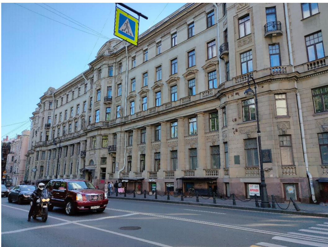
Фото 2. Фрагмент лицевого фасада со стороны Каменноостровского проспекта
