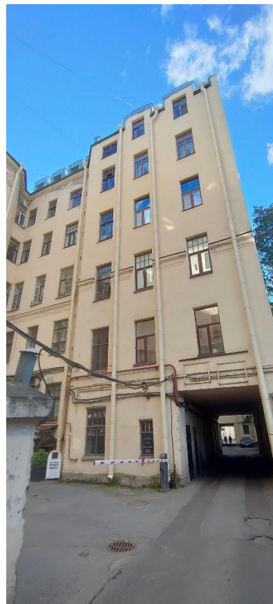
Фото 23. Фрагмент северо-западного дворового фасада
