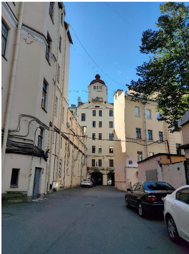
Фото 18. Фрагмент северо-западного фасада со стороны сада Андрея Петрова
