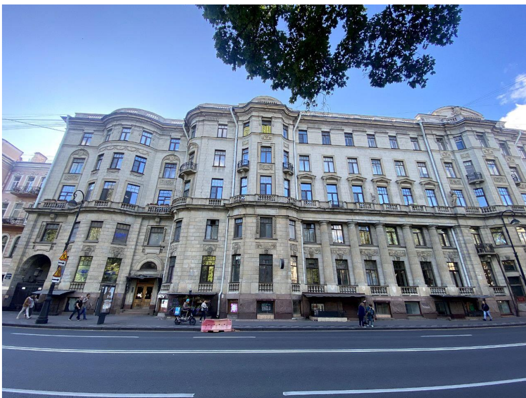
Фото 3. Фрагмент лицевого фасада со стороны Каменноостровского проспекта
