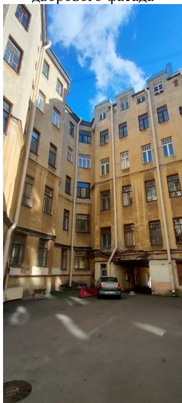
Фото 24. Фрагмент юго-западного дворового фасада
