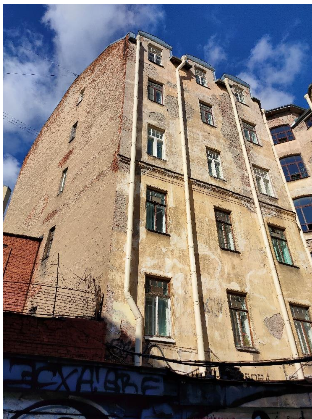
Фото 29. Фрагмент юго-западного дворового фасада
