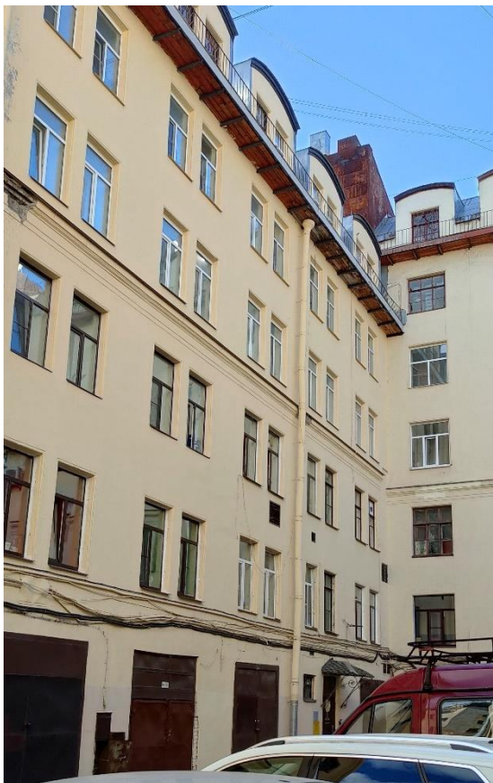
Фото 26. Фрагмент юго-западного дворового фасада
