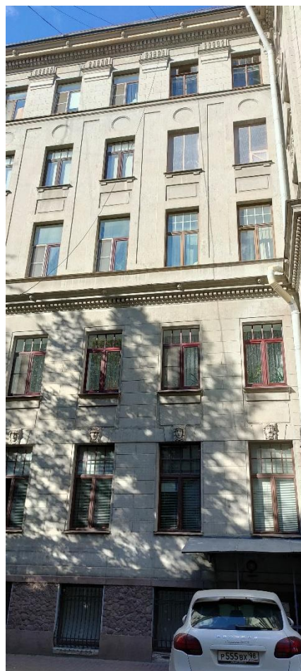
Фото 9. Фрагмент дворового фасада
