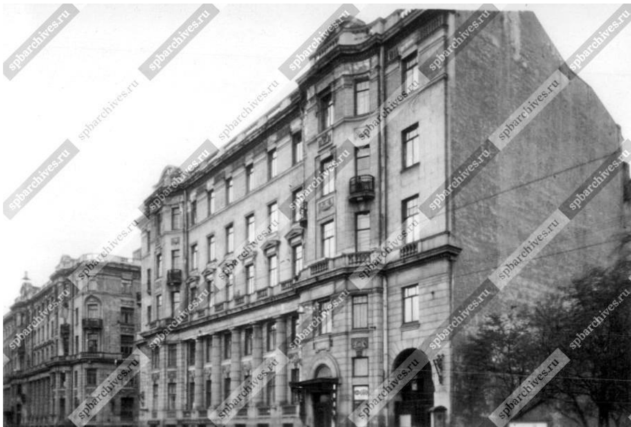
Илл. 34. Угловой фасад дома №26/28 на Кировском проспекте. Архитекторы: Л.Н. Бенуа, Ю.Ю. Бенуа, А.Н. Бенуа, 1911-1914 гг. Фотография 1960 г. ЦГАКФФД СПб. Гр 74101.
