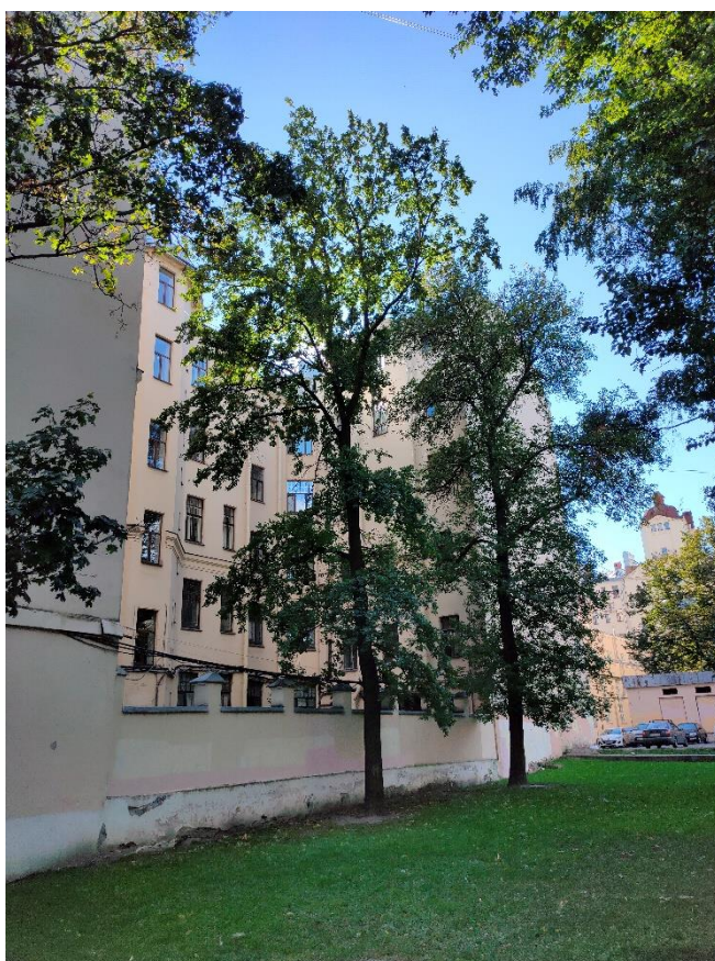
Фото 17. Фрагмент северо-западного фасада со стороны сада Андрея Петрова
