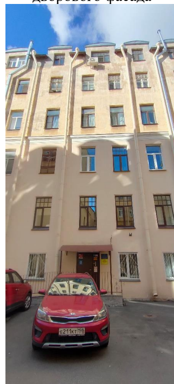
Фото 25. Фрагмент юго-западного дворового фасада
