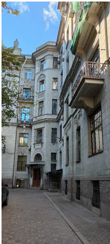
Фото 10. Фрагмент дворового фасада
