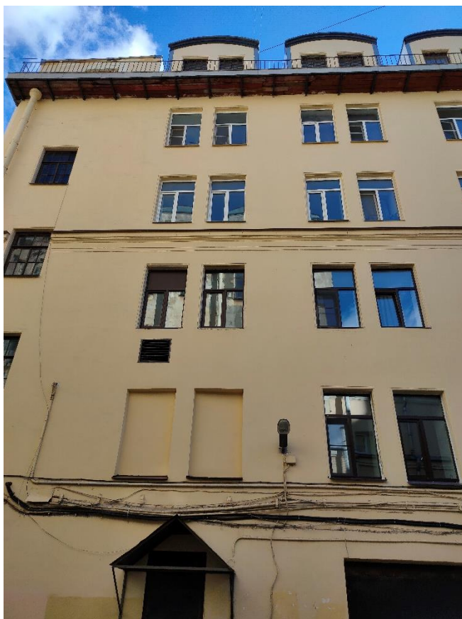
Фото 27. Фрагмент юго-западного дворового фасада
