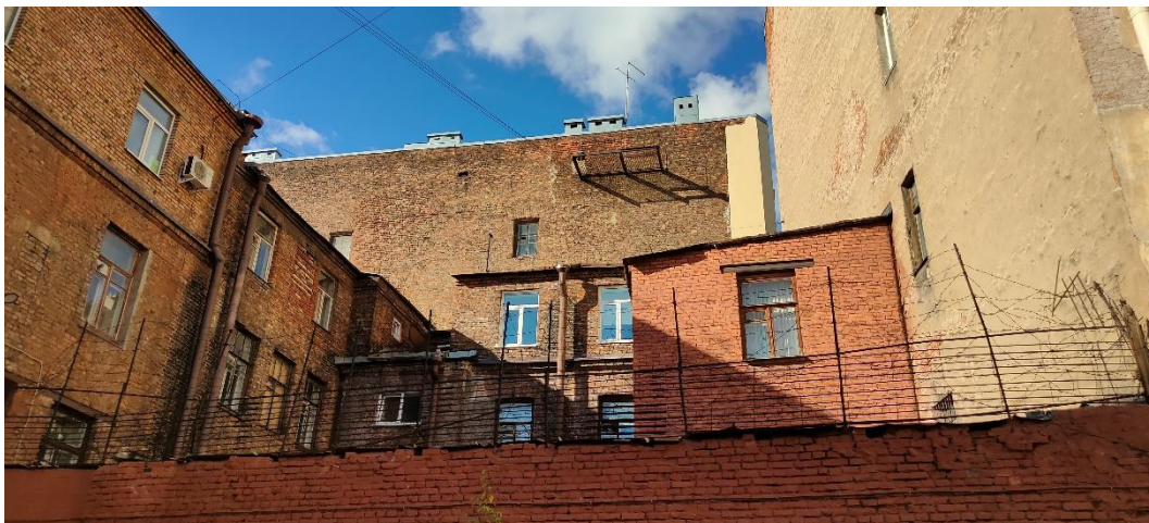
Фото 31. Фрагмент юго-западного дворового фасада
