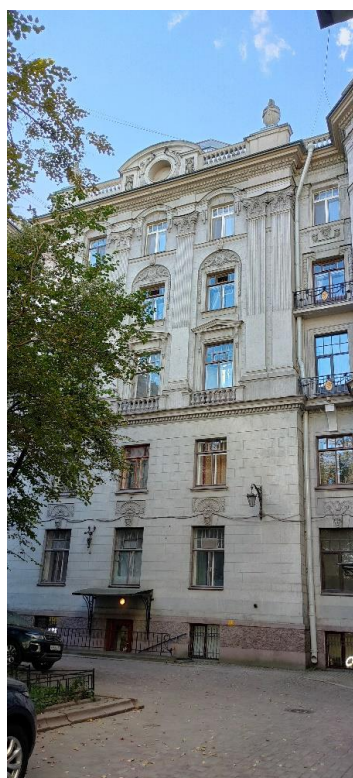
Фото 12. Фрагмент дворового фасада
