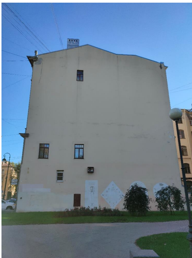
Фото 15. Фрагмент северо-западного фасада со стороны сада Андрея Петрова
