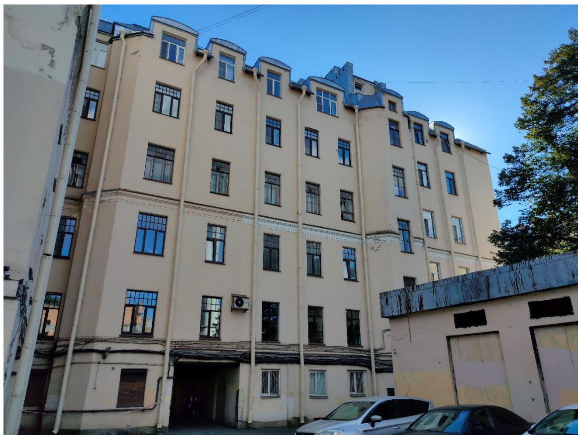
Фото 19. Фрагмент северо-западного фасада
