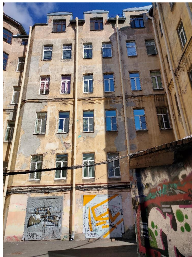
Фото 30. Фрагмент юго-западного дворового фасада
