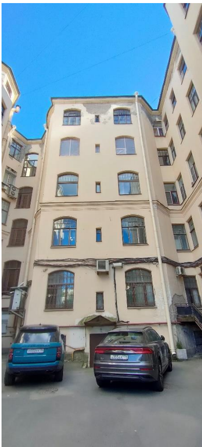
Фото 22. Фрагмент северо-западного дворового фасада
