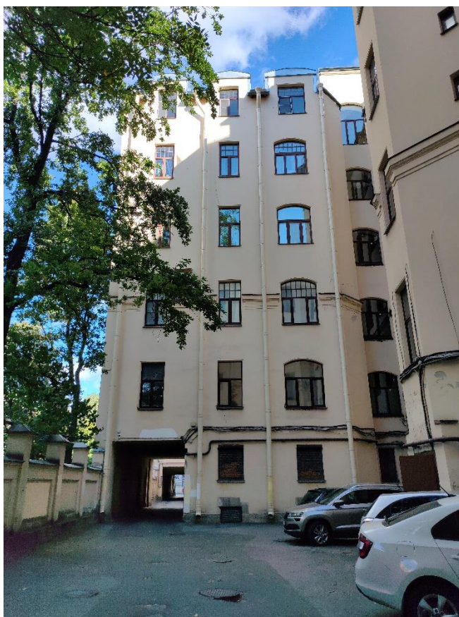
Фото 21 Фрагмент северо-западного фасада
