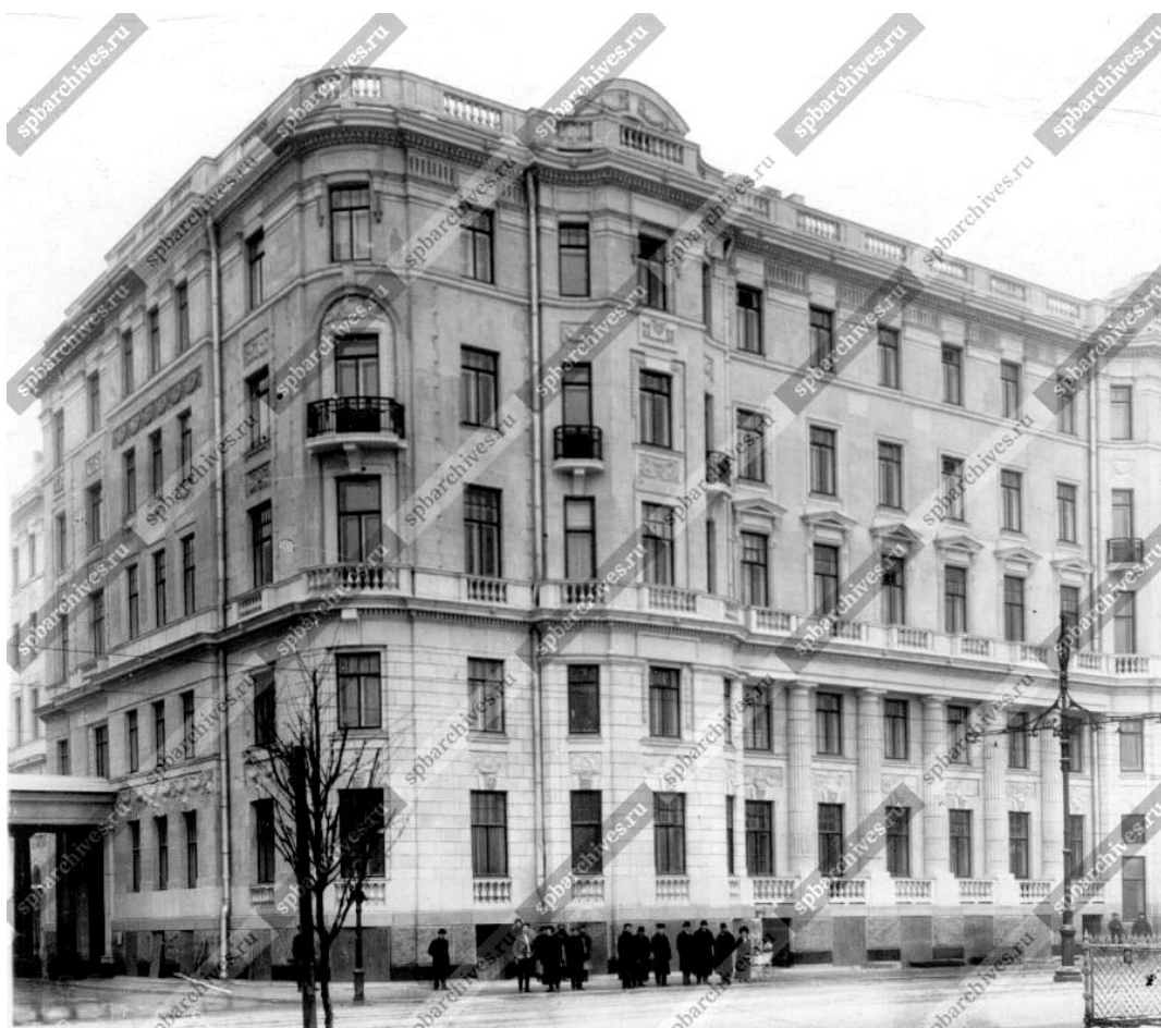
Илл. 29. Часть правой стороны фасада дома №26-28 со стороны Каменноостровского проспекта - дом Первого Российского страхового общества (архитекторы Л.Н. Бенуа, Ю.Ю. Бенуа. Фотография до 1914-1916 гг. ЦГАКФФД СПб. Е 12531.
