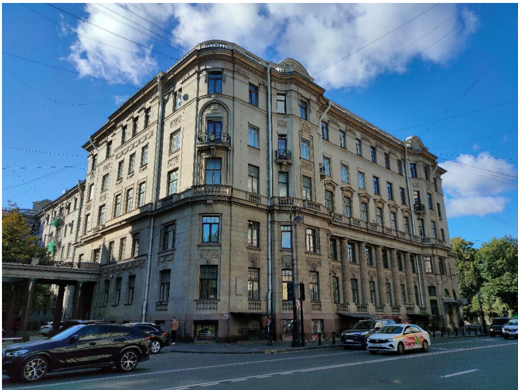
Фото 1. Фрагмент лицевого фасада со стороны Каменноостровского проспекта
