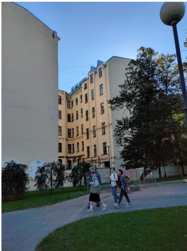
Фото 16. Фрагмент северо-западного фасада со стороны сада Андрея Петрова
