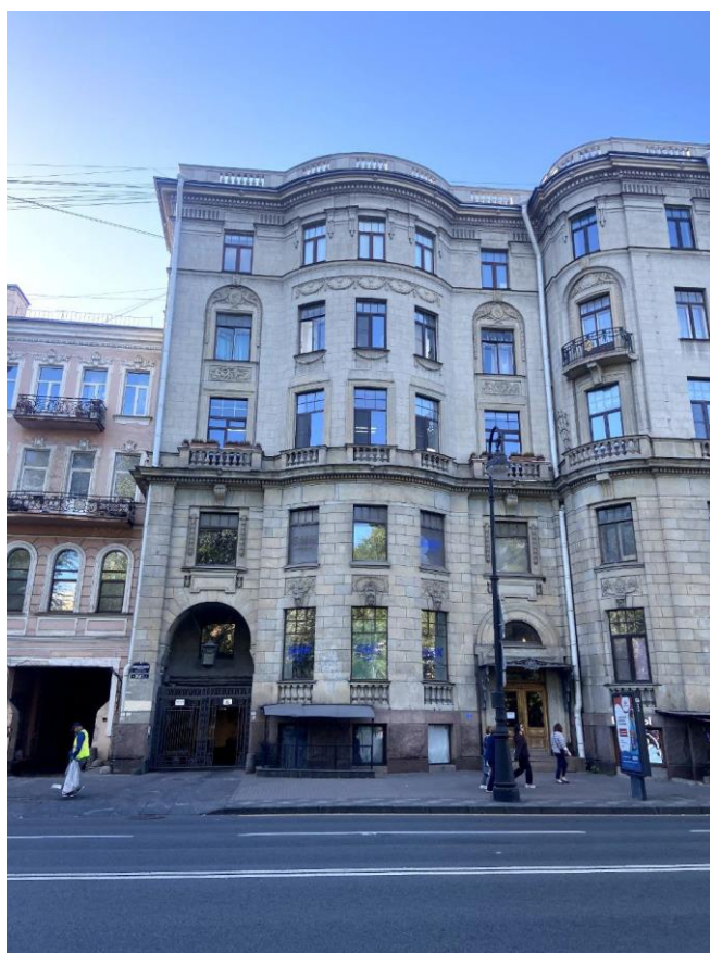
Фото 4. Фрагмент лицевого фасада со стороны Каменноостровского проспекта
