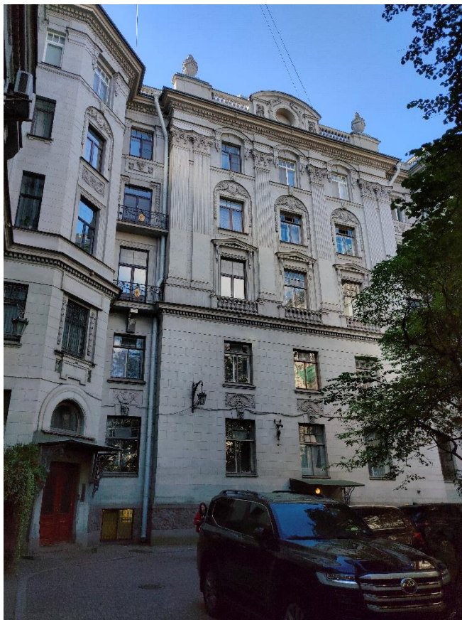
Фото 14. Фрагмент дворового фасада
