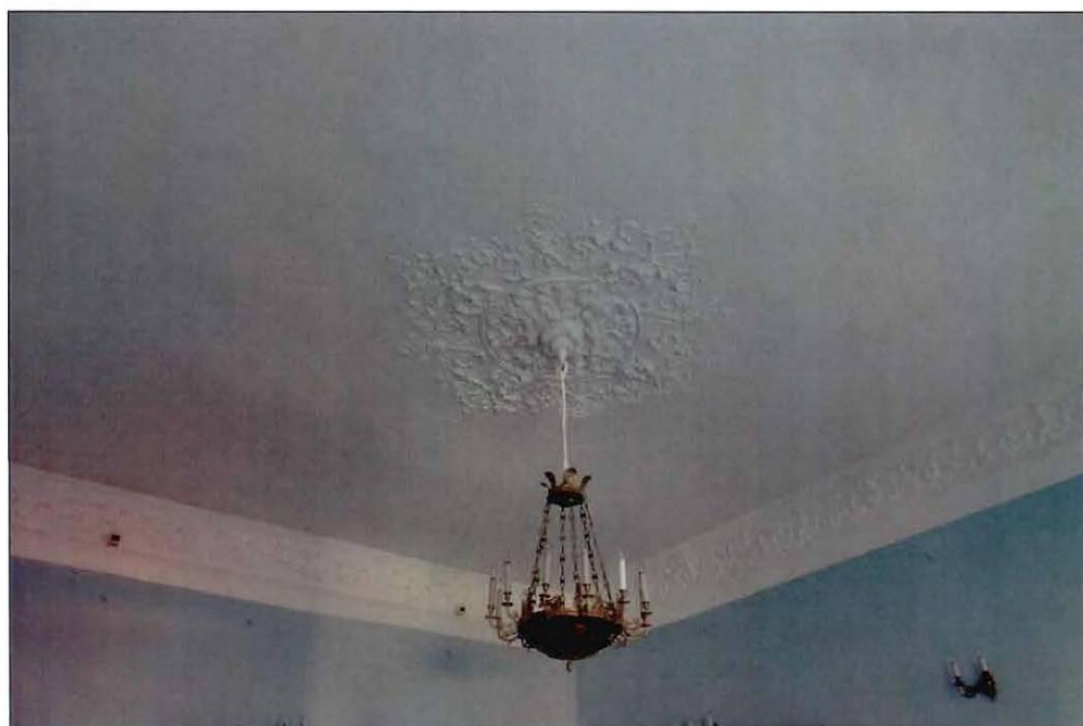
11. Интерьер. Фрагмент. Пом. 12-Н (3).
