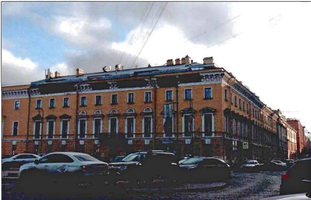
1. Общий вид с юго-востока.
