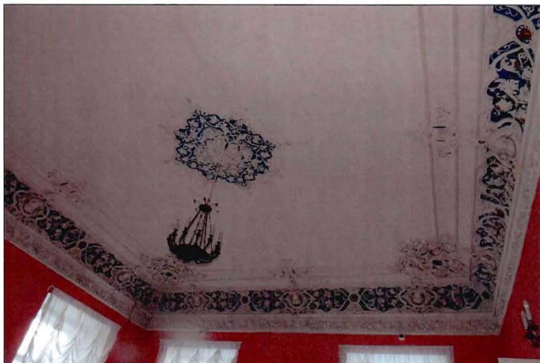
10. Интерьер. Фрагмент. Пом. 12-Н (16).
