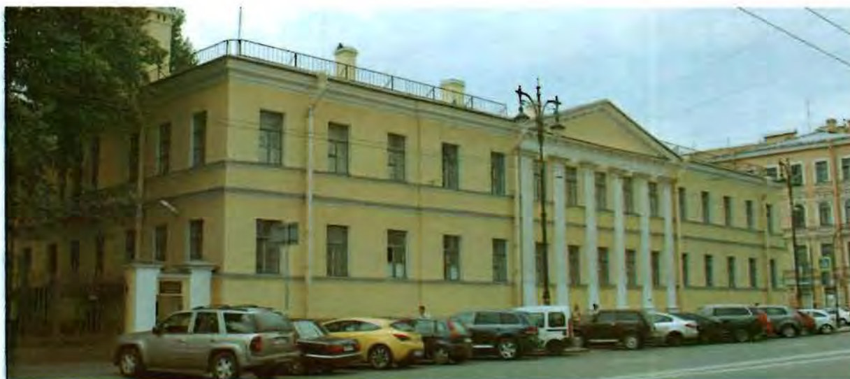
Фото №1. Вид на северный фасад со стороны ул. Кирочной.
