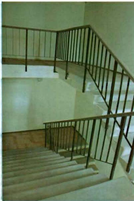
Фото №7. Двухмаршевая межэтажная лестница.
