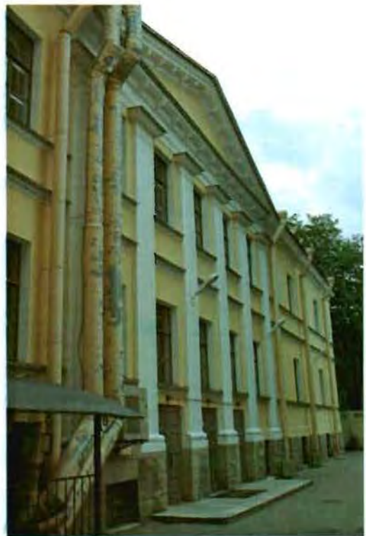
Фото №5. Фрагмент южного фасада, вид со стороны внутреннего двора.
