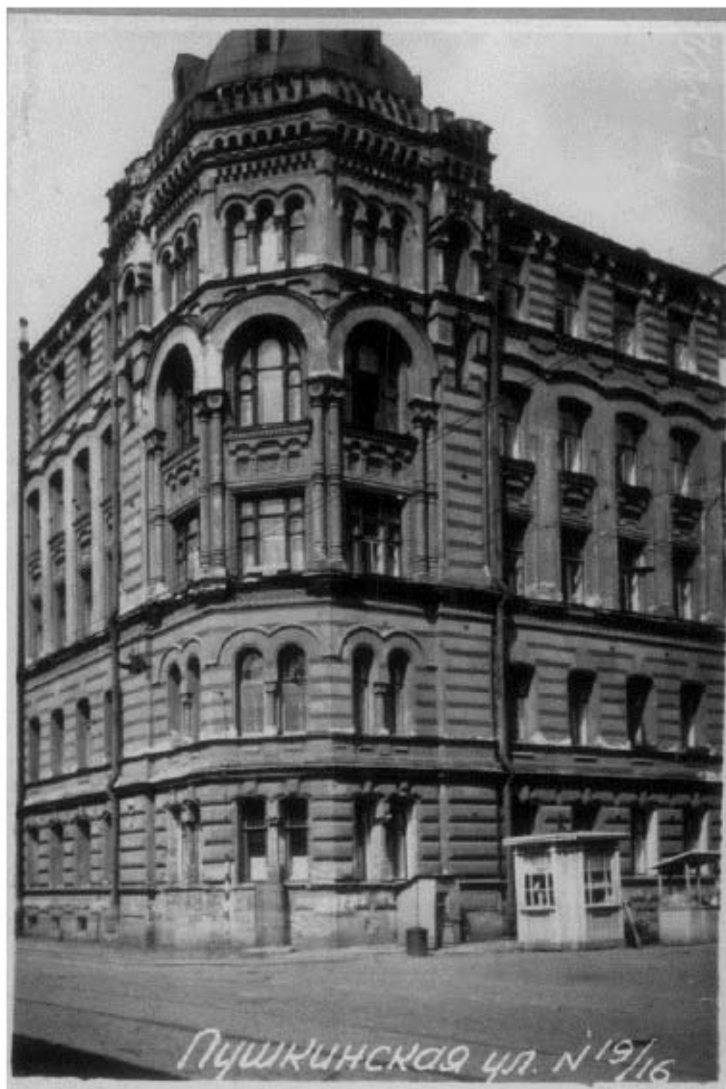
Угловой фасад дома №19 на Пушкинской улице. 1949 г., ЦГАКФФД СПб, Гр 72257
