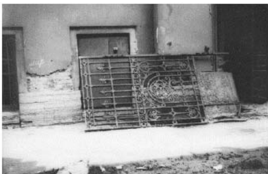
Вид решетки створки ворот дома № 15 на Пушкинской улице (архитектор Э.Г.Юргенс, 1876 г., ворота сняты в 1990-е годы), 15.04.1984. ЦГАКФФД СПб Ар 217826
