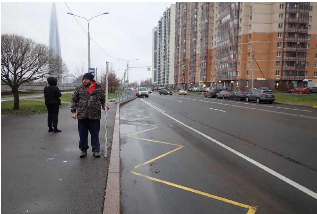
Рис. 22 Земельный участок Санкт-Петербург. Приморский район. Муниципальный округ 65. Улица Беговая. Точка фотофиксации 2, вид с юго-востока.
