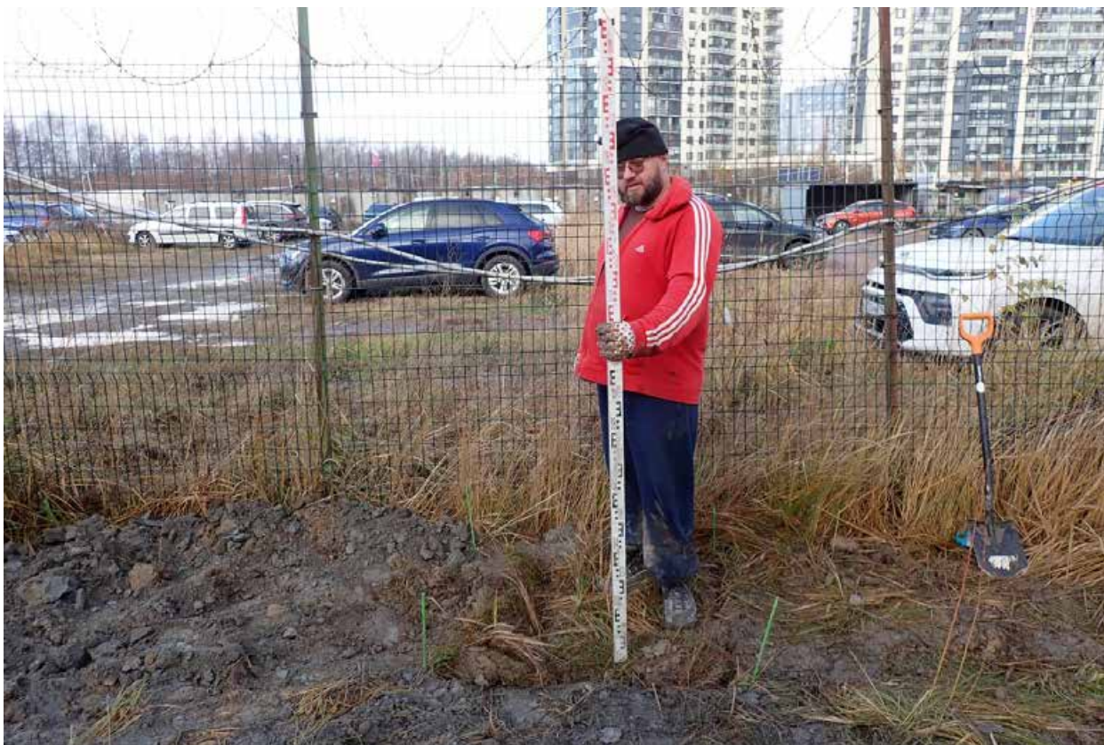
Рис. 34. Земельный участок Санкт-Петербург. Приморский район. Муниципальный округ 65. Улица Беговая. Шурф № 1 после рекультивации, вид с юго-запада.
