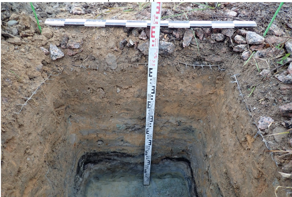
Рис. 18. Земельный участок Санкт-Петербург. Колпино. Загородная улица, участок 72 к/н 78:37:1722003:5. Северная стенка шурфа № 1 после прокопки, вид с юга
