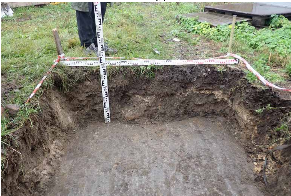
Рис. 44. Земельный участок Санкт-Петербург, набережная реки Екатерингофки, дом 18, корпус 1, литера А к/н 78:15:0008106:3147. Северная стенка шурфа № 3, вид с юга
