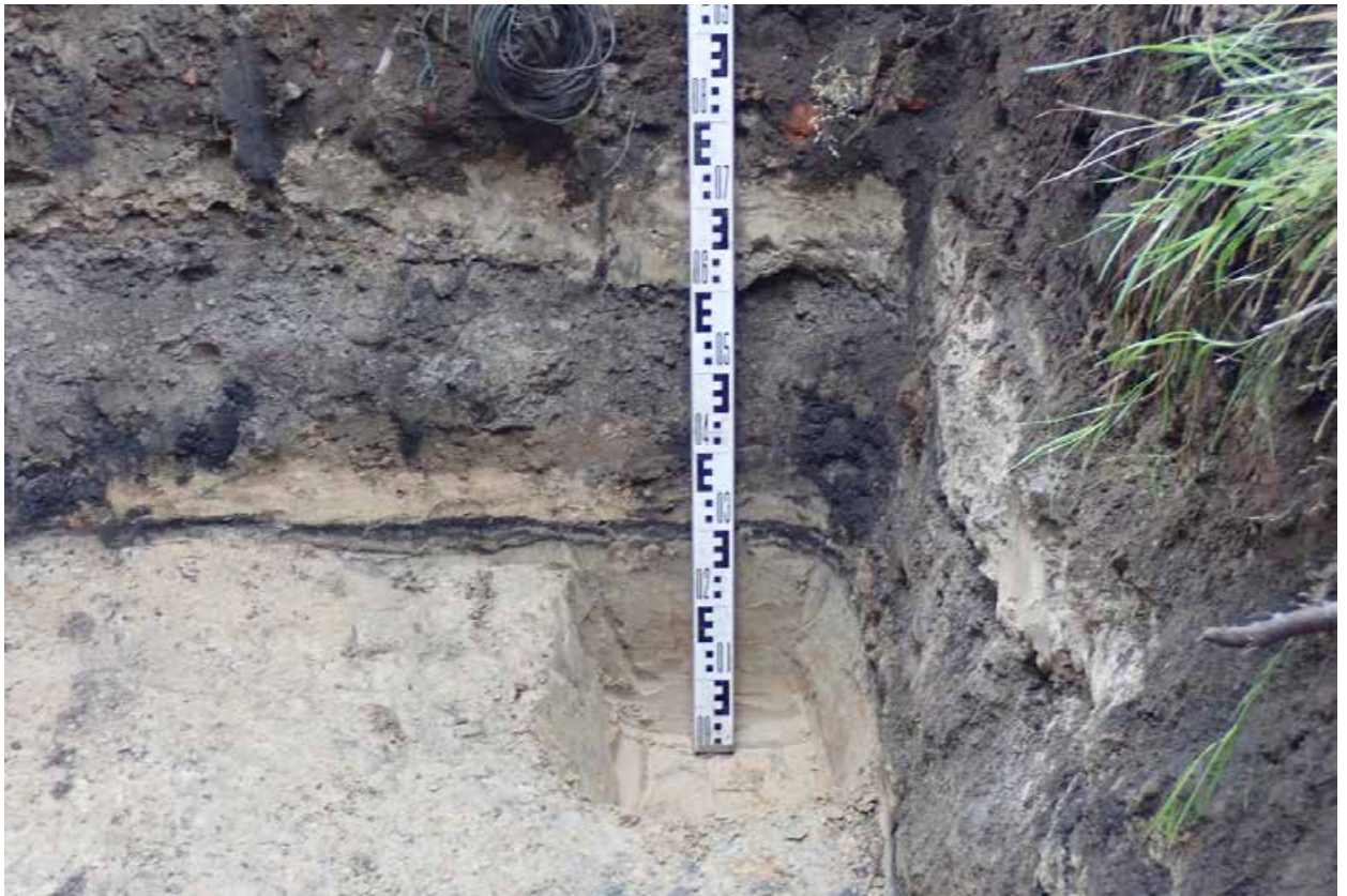
Рис. 33. Земельный участок Санкт-Петербург, набережная реки Екатерингофки, дом 18, корпус 1, литера А к/н 78:15:0008106:3147. Северная стенка шурфа № 1 после прокопки, вид с юга
