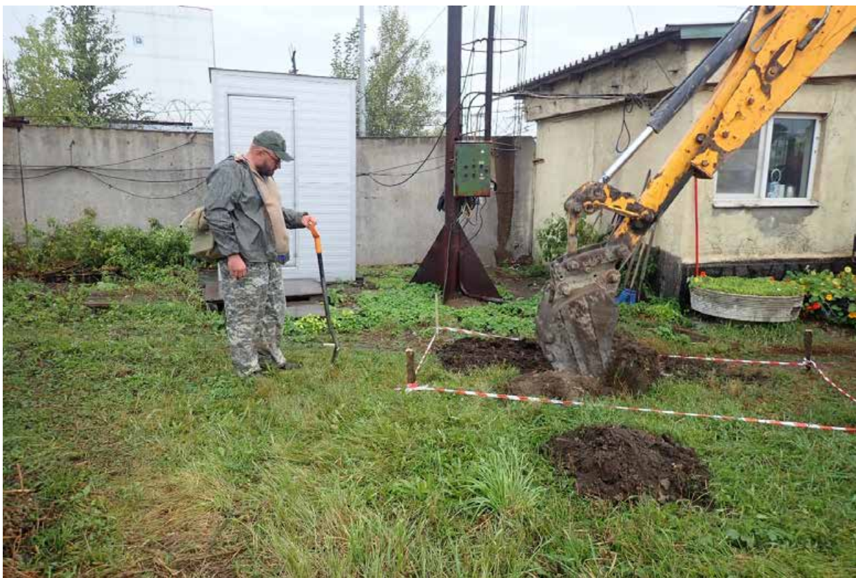
Рис. 17. Земельный участок Санкт-Петербург, набережная реки Екатерингофки, дом 18, корпус 1, литера А к/н 78:15:0008106:3147. Выборка балластных напластований с помощью землеройной техники под руководством специалиста археолога, вид с северо-востока
