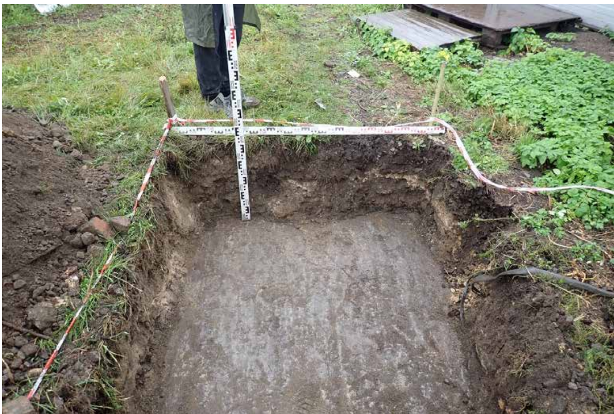
Рис. 43 Земельный участок Санкт-Петербург, набережная реки Екатерингофки, дом 18, корпус 1, литера А к/н 78:15:0008106:3147. Шурф № 3, вид с юга.
