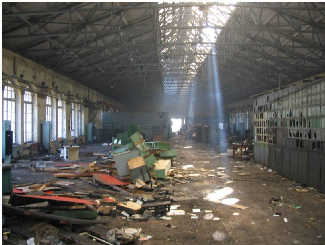
50. ВОКН «Здание инструментального цеха». Интерьер основного здания литер Н. Фотография начала 2000-х гг.
