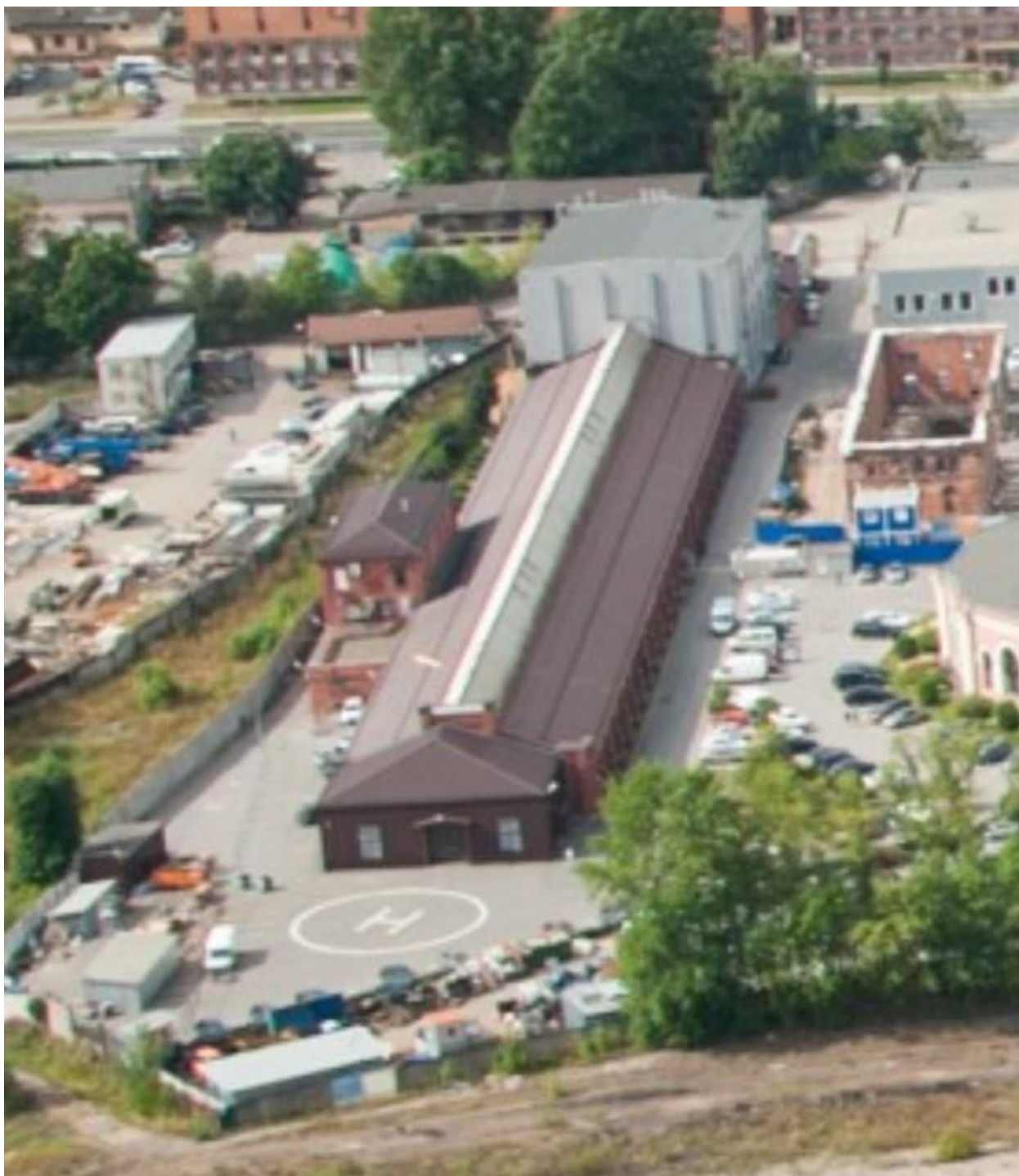
54. «Здание инструментального цеха». Вид с востока. Фото 2014 года. // URL: https://panevin.ru/uploads/photo/2014/muзей_zheleznodorozhnoy_tehniki_na_varshavskom_1024.jpg (дата обращения: 15.08.2024).
