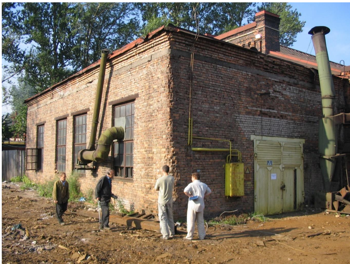
45. ВОКН «Здание инструментального цеха». Восточная пристройка н-1. Вид с северо-востока. Фотография начала 2000-х гг.
