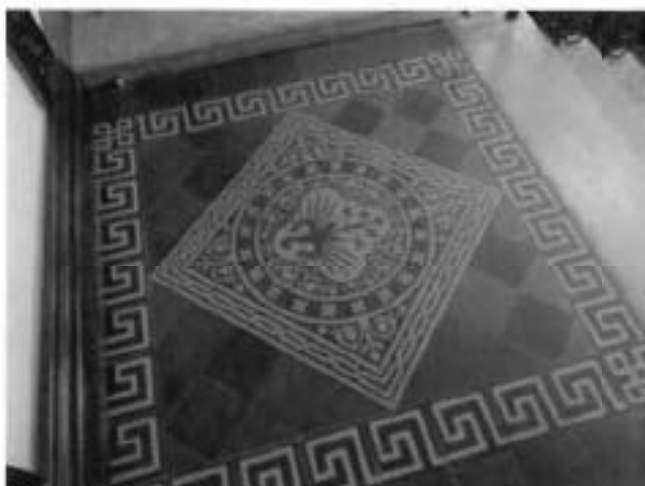
5. Покрытие пола верхнего уровня вестибюля.
