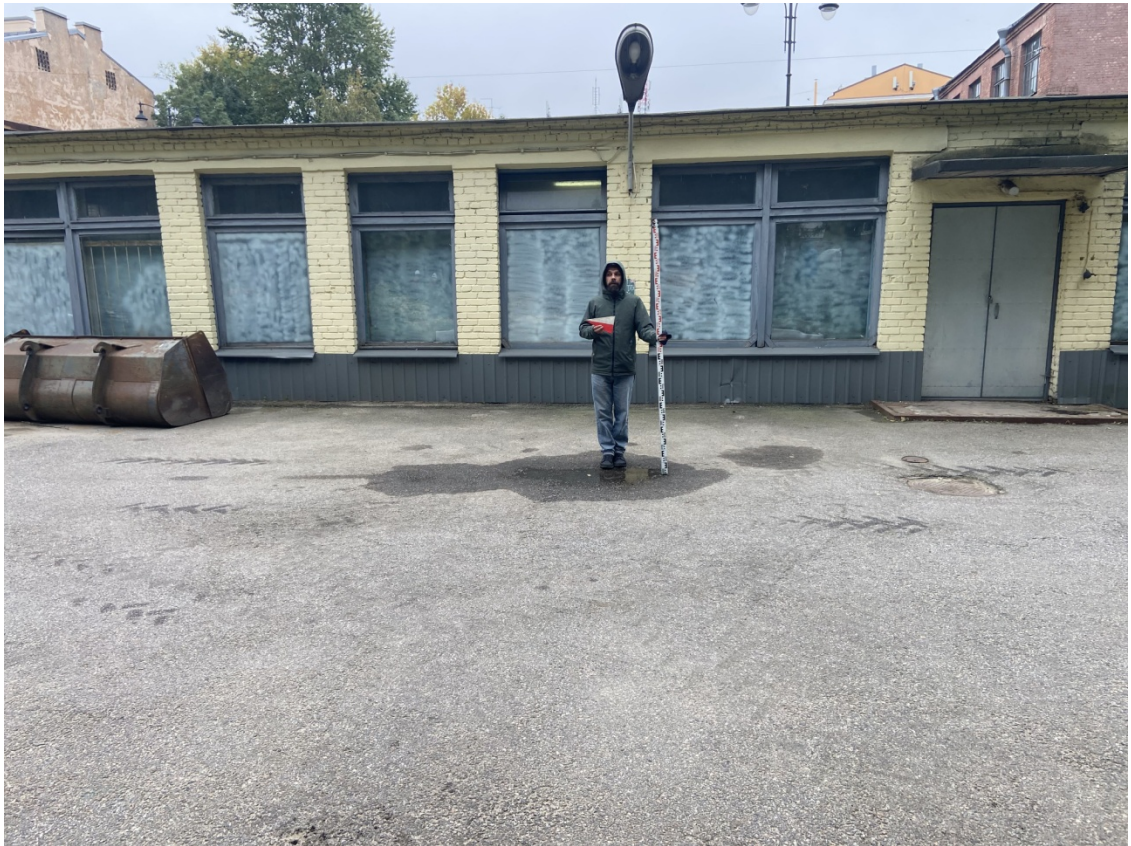
Рис. 33. г. Санкт-Петербург, Адмиралтейский район, муниципальный округ «Коломна», наб. реки Фонтанки, 203. Photo 10. Общий вид территории обследования. Вид с СЗ.
