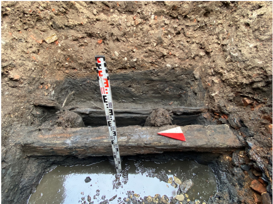
Рис. 41. г. Санкт-Петербург, Адмиралтейский район, муниципальный округ «Коломна», наб. реки Фонтанки, 203. Шурф 1. Фрагмент деревянных конструкций. Вид с СЗ.
