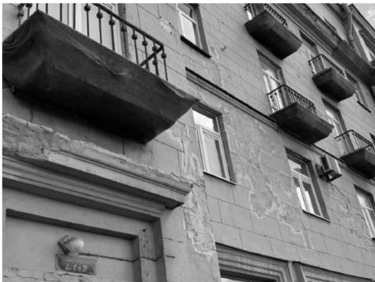
Фото 15. Объект культурного наследия регионального значения «Комплекс жилых домов (6 зданий)», расположенный по адресу: Санкт-Петербург, Малоохтинский проспект, дом 84, литера А, дом 86, литера А, дом 88, литера А, дом 92, литера А, дом 94, литера А, дом 96/2, литера А. Фото Васильева Н. В. (09.07.2024 г.)
