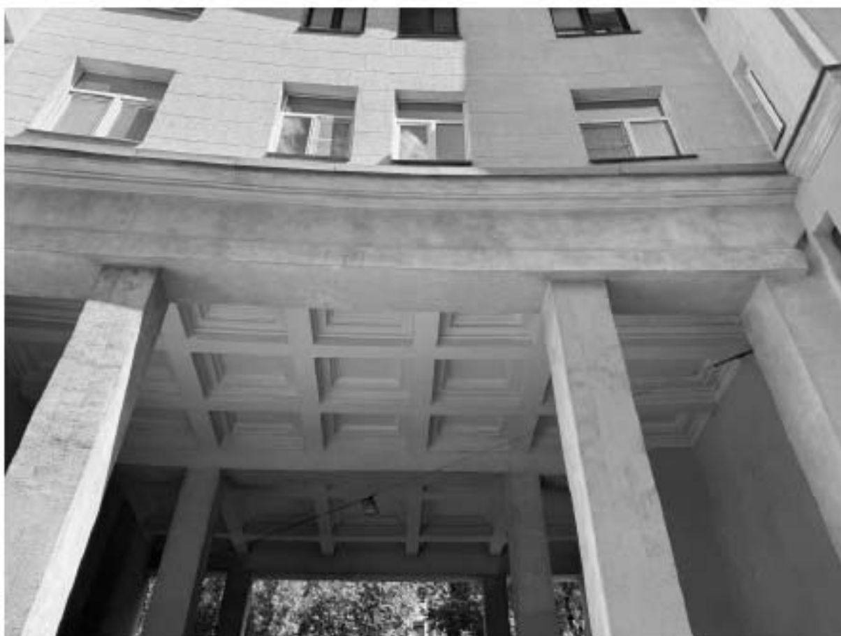
Фото 18. Объект культурного наследия регионального значения «Комплекс жилых домов (6 зданий)», расположенный по адресу: Санкт-Петербург, Малоохтинский проспект, дом 84, литера А, дом 86, литера А, дом 88, литера А, дом 92, литера А, дом 94, литера А, дом 96/2, литера А. Фото Васильева Н. В. (09.07.2024 г.)
