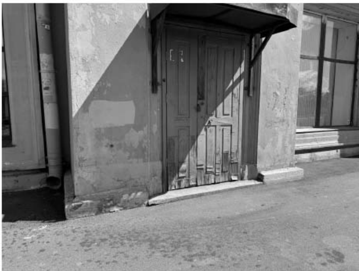
Фото 21. Объект культурного наследия регионального значения «Комплекс жилых домов (6 зданий)», расположенный по адресу: Санкт-Петербург, Малоохтинский проспект, дом 84, литера А, дом 86, литера А, дом 88, литера А, дом 92, литера А, дом 94, литера А, дом 96/2, литера А. Фото Васильева Н. В. (09.07.2024 г.)
