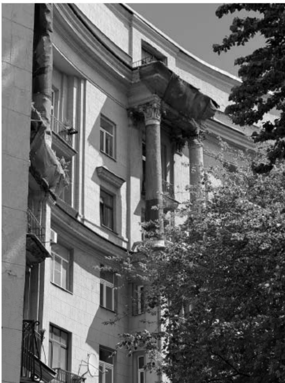
Фото 9. Объект культурного наследия регионального значения «Комплекс жилых домов (6 зданий)», расположенный по адресу: Санкт-Петербург, Малоохтинский проспект, дом 84, литера А, дом 86, литера А, дом 88, литера А, дом 92, литера А, дом 94, литера А, дом 96/2, литера А. Фото Васильева Н. В. (09.07.2024 г.)
