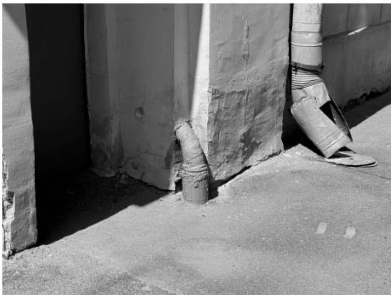
Фото 26. Объект культурного наследия регионального значения «Комплекс жилых домов (6 зданий)», расположенный по адресу: Санкт-Петербург, Малоохтинский проспект, дом 84, литера А, дом 86, литера А, дом 88, литера А, дом 92, литера А, дом 94, литера А, дом 96/2, литера А. Место ввода газовой трубы. Фото Васильева Н. В. (09.07.2024 г.)
