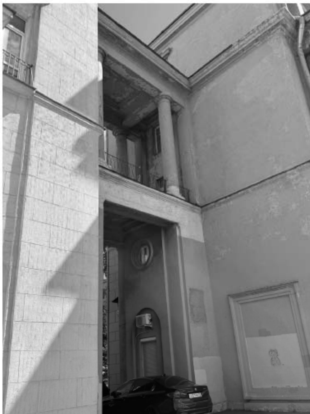
Фото 19. Объект культурного наследия регионального значения «Комплекс жилых домов (6 зданий)», расположенный по адресу: Санкт-Петербург, Малоохтинский проспект, дом 84, литера А, дом 86, литера А, дом 88, литера А, дом 92, литера А, дом 94, литера А, дом 96/2, литера А. Фото Васильева Н. В. (09.07.2024 г.)
