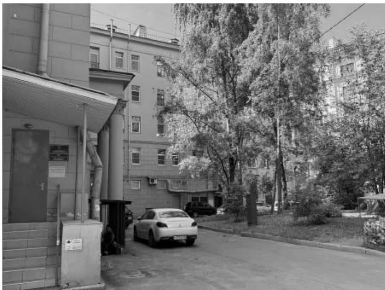
Фото 23. Объект культурного наследия регионального значения «Комплекс жилых домов (6 зданий)», расположенный по адресу: Санкт-Петербург, Малоохтинский проспект, дом 84, литера А, дом 86, литера А, дом 88, литера А, дом 92, литера А, дом 94, литера А, дом 96/2, литера А. Фото Васильева Н. В. (09.07.2024 г.)
