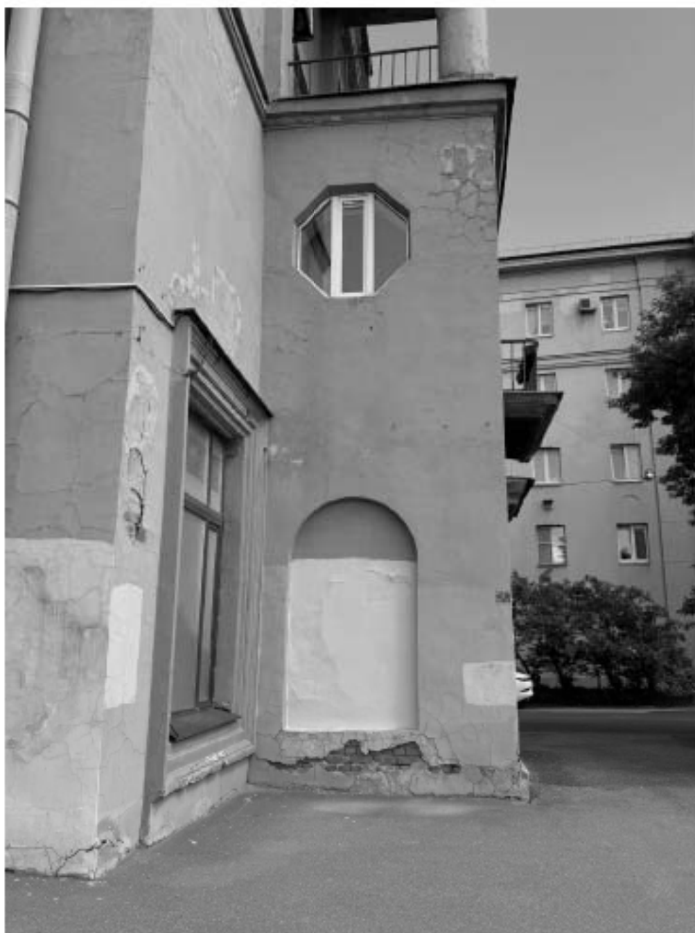
Фото 16. Объект культурного наследия регионального значения «Комплекс жилых домов (6 зданий)», расположенный по адресу: Санкт-Петербург, Малоохтинский проспект, дом 84, литера А, дом 86, литера А, дом 88, литера А, дом 92, литера А, дом 94, литера А, дом 96/2, литера А. Фото Васильева Н. В. (09.07.2024 г.)
