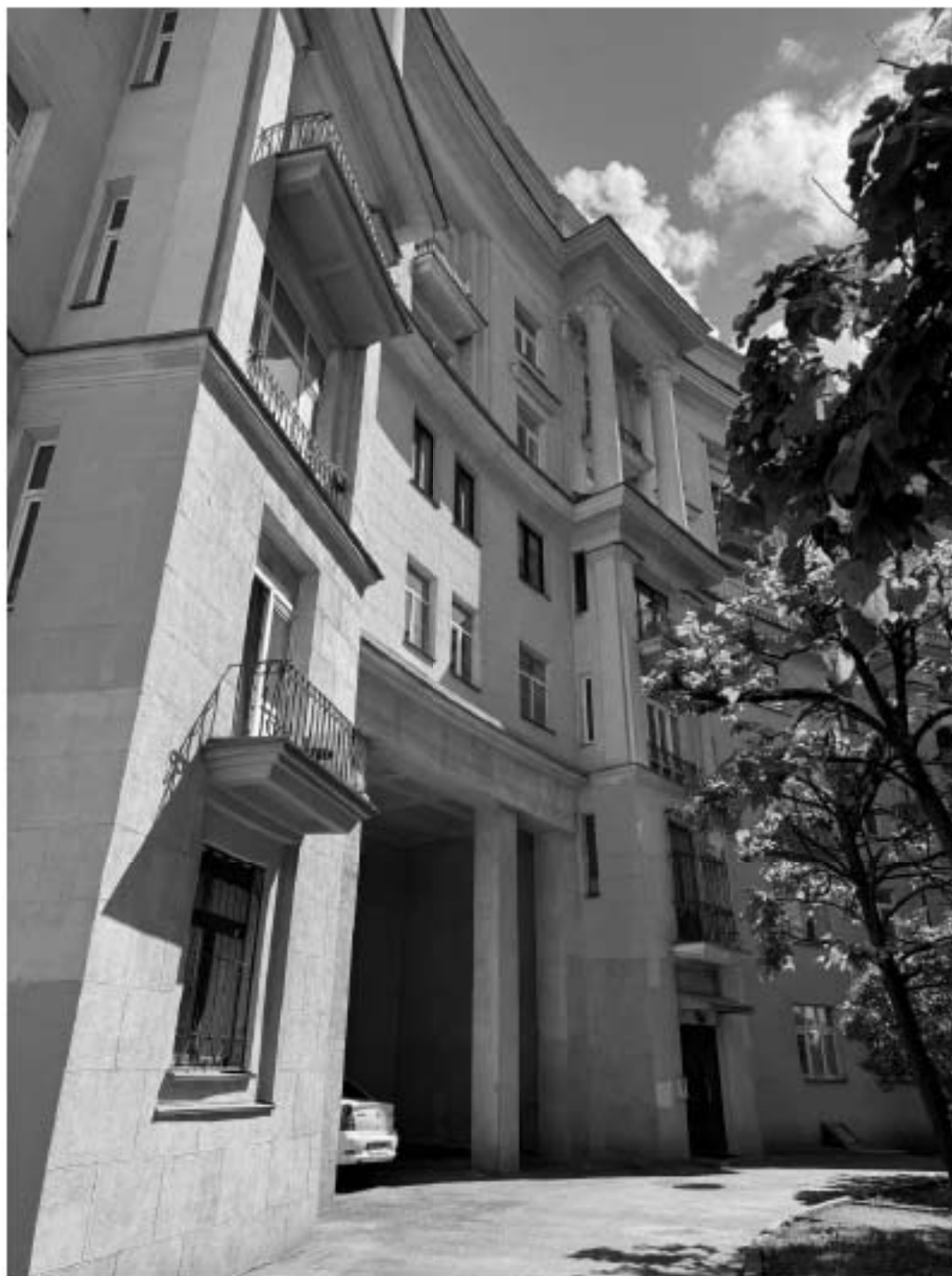
Фото 17. Объект культурного наследия регионального значения «Комплекс жилых домов (6 зданий)», расположенный по адресу: Санкт-Петербург, Малоохтинский проспект, дом 84, литера А, дом 86, литера А, дом 88, литера А, дом 92, литера А, дом 94, литера А, дом 96/2, литера А. Фото Васильева Н. В. (09.07.2024 г.)
