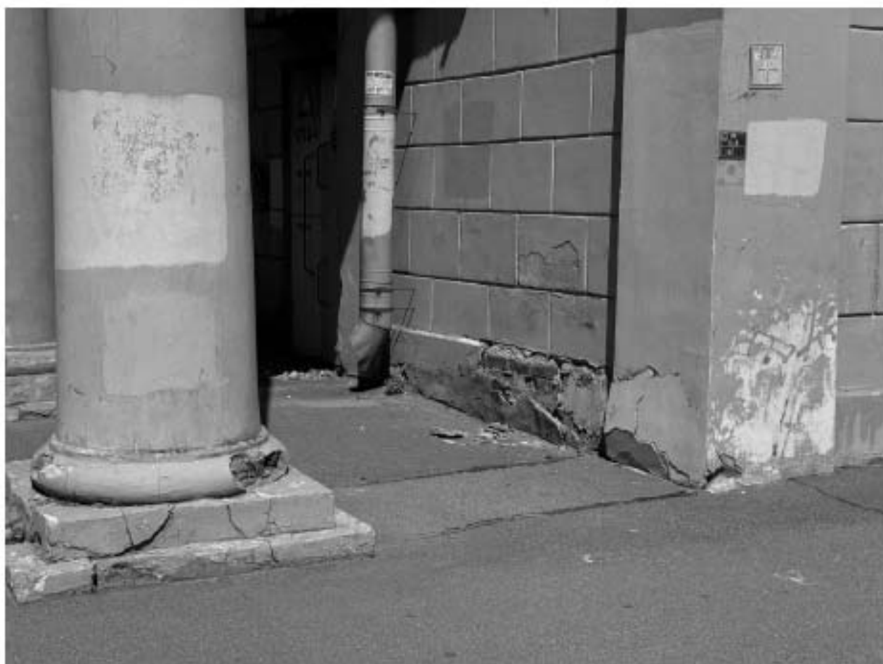
Фото 22. Объект культурного наследия регионального значения «Комплекс жилых домов (6 зданий)», расположенный по адресу: Санкт-Петербург, Малоохтинский проспект, дом 84, литера А, дом 86, литера А, дом 88, литера А, дом 92, литера А, дом 94, литера А, дом 96/2, литера А. Фото Васильева Н. В. (09.07.2024 г.)
