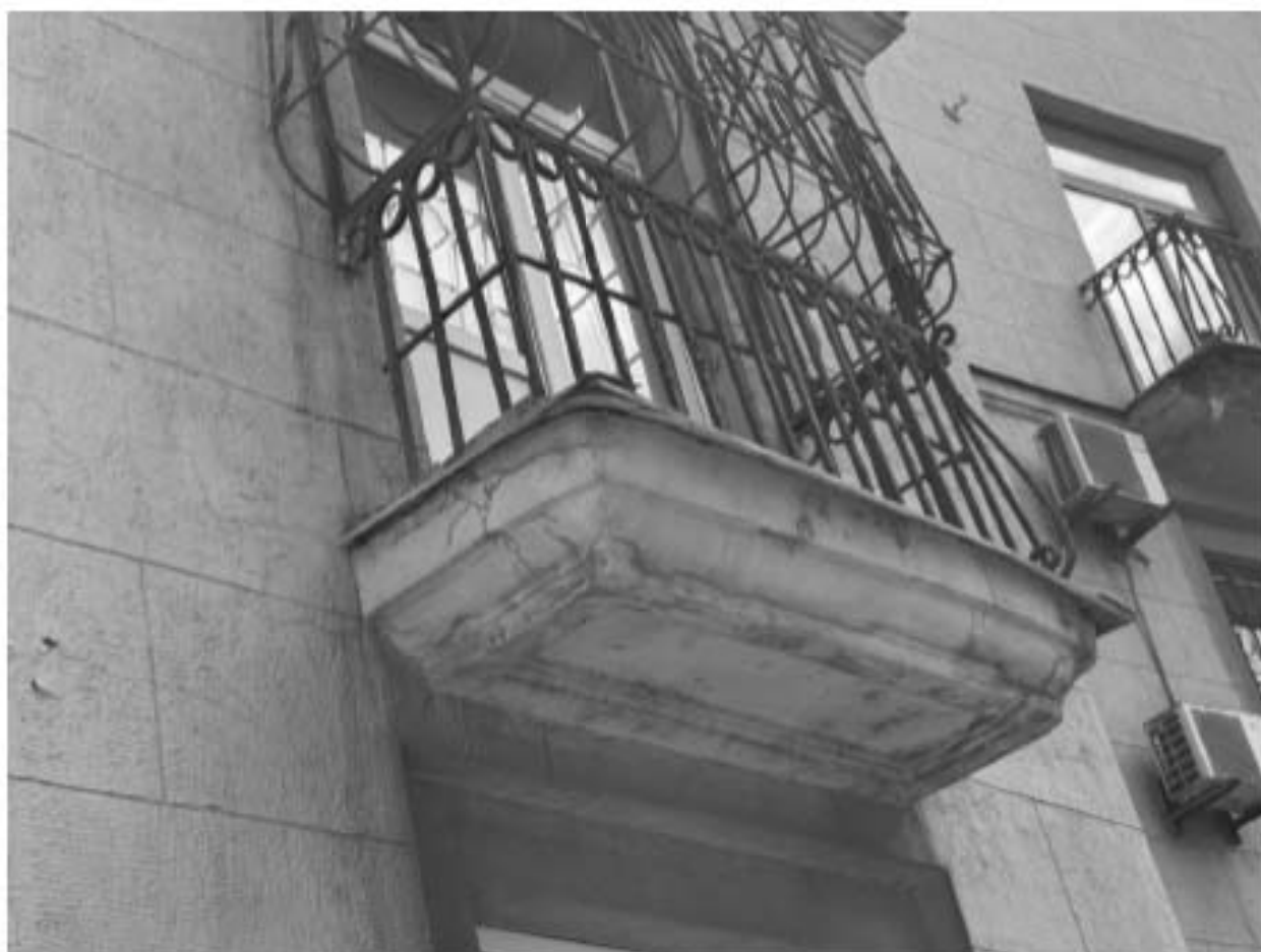
Фото 12. Объект культурного наследия регионального значения «Комплекс жилых домов (6 зданий)», расположенный по адресу: Санкт-Петербург, Малоохтинский проспект, дом 84, литера А, дом 86, литера А, дом 88, литера А, дом 92, литера А, дом 94, литера А, дом 96/2, литера А. Фото Васильева Н. В. (09.07.2024 г.)
