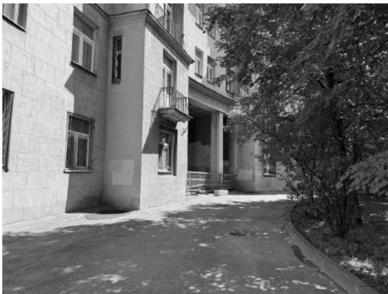
Фото 11. Объект культурного наследия регионального значения «Комплекс жилых домов (6 зданий)», расположенный по адресу: Санкт-Петербург, Малоохтинский проспект, дом 84, литера А, дом 86, литера А, дом 88, литера А, дом 92, литера А, дом 94, литера А, дом 96/2, литера А. Фото Васильева Н. В. (09.07.2024 г.)
