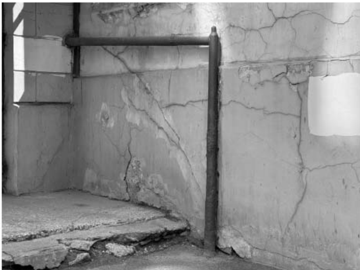
Фото 29. Объект культурного наследия регионального значения «Комплекс жилых домов (6 зданий)», расположенный по адресу: Санкт-Петербург, Малоохтинский проспект, дом 84, литера А, дом 86, литера А, дом 88, литера А, дом 92, литера А, дом 94, литера А, дом 96/2, литера А. Фото Васильева Н. В. (09.07.2024 г.)
