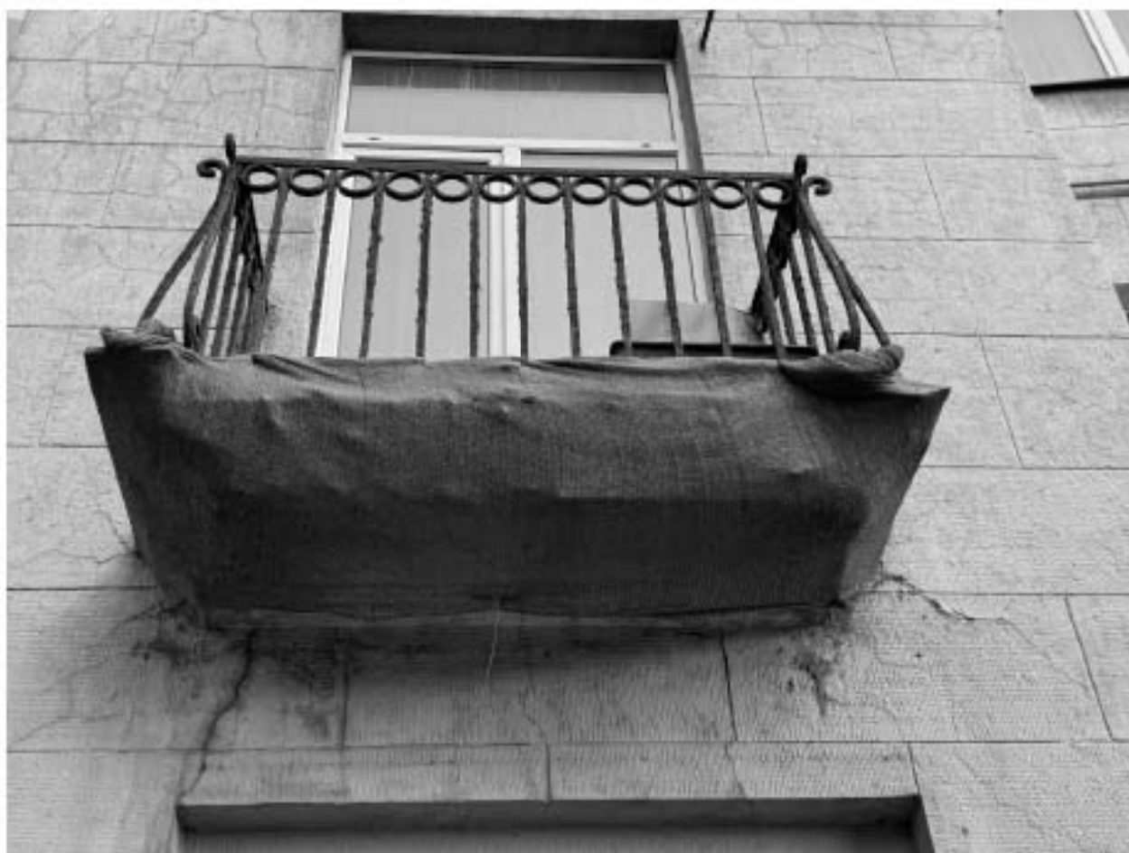
Фото 13. Объект культурного наследия регионального значения «Комплекс жилых домов (6 зданий)», расположенный по адресу: Санкт-Петербург, Малоохтинский проспект, дом 84, литера А, дом 86, литера А, дом 88, литера А, дом 92, литера А, дом 94, литера А, дом 96/2, литера А. Фото Васильева Н. В. (09.07.2024 г.)
