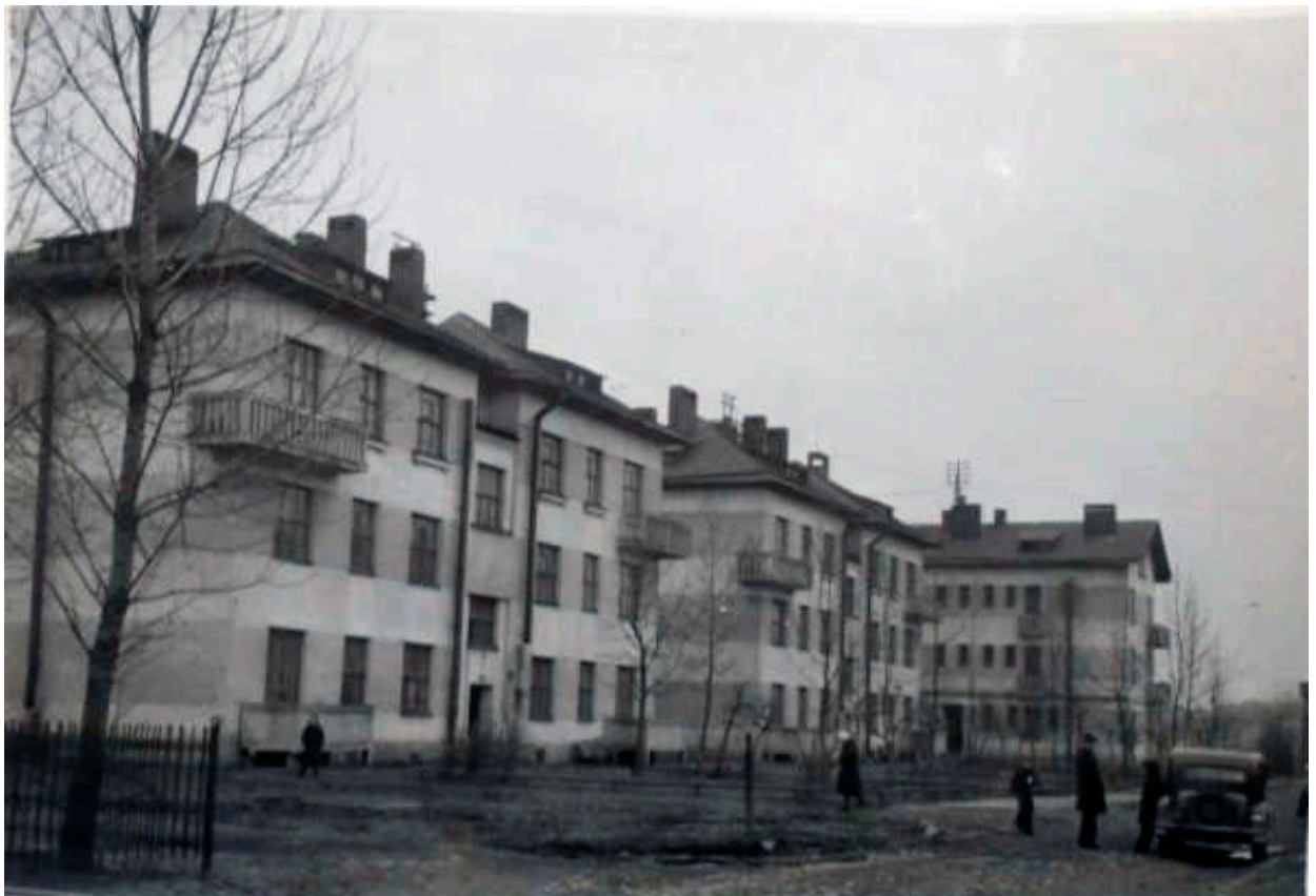
Илл. 10. Невский район. Рабочий поселок 5-й ГЭС. Перспектива фасада. Конец 1920-х - 1940-е гг. ФГБУК «Государственный научно-исследовательский музей архитектуры имени А.В. Щусева». ГНИМА ОФ-5338/20.
