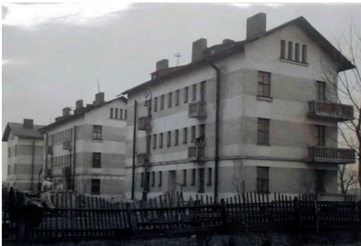
Илл. 11. Невский район. Рабочий поселок 5-й ГЭС. Перспектива фасада. Конец 1920-х - 1940-е гг. ФГБУК «Государственный научно-исследовательский музей архитектуры имени А.В. Щусева». ГНИМА ОФ-5338/22.
