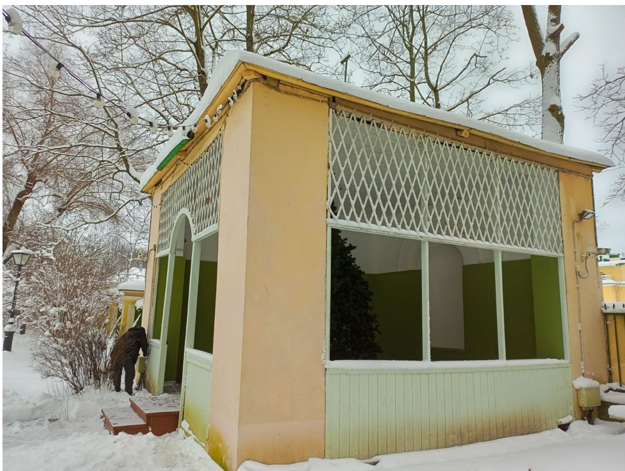
4. Западный и северный фасады объекта культурного наследия федерального значения «Особняк Кочубея В.П. Сад», расположенного по адресу: Санкт-Петербург, г. Пушкин, ул. Радищева, д. 4, литера А. 04.12.2024
