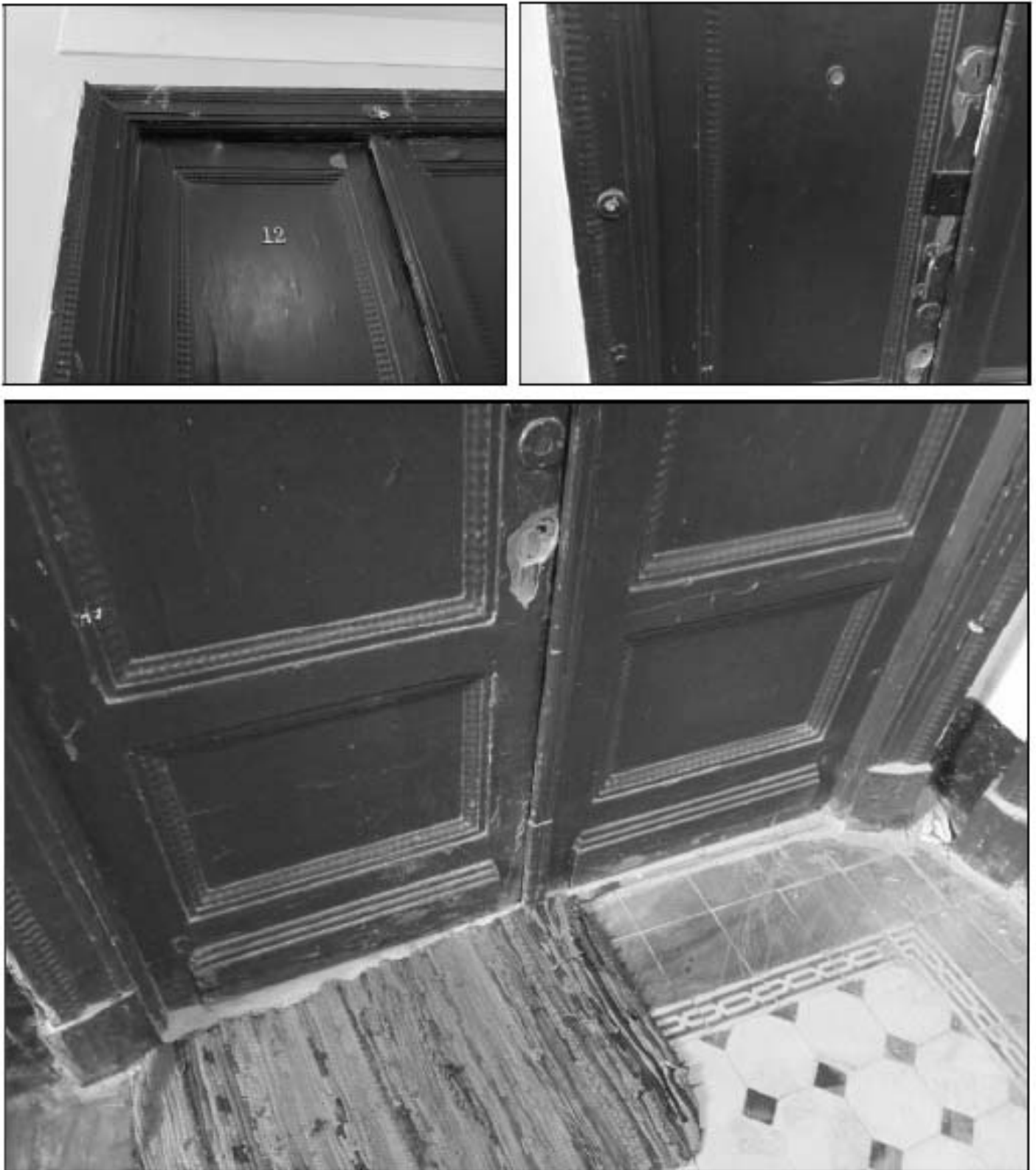
7. Шестой этаж, лестничная клетка (1 ЛК). Детали входной двери в квартиру №12.
