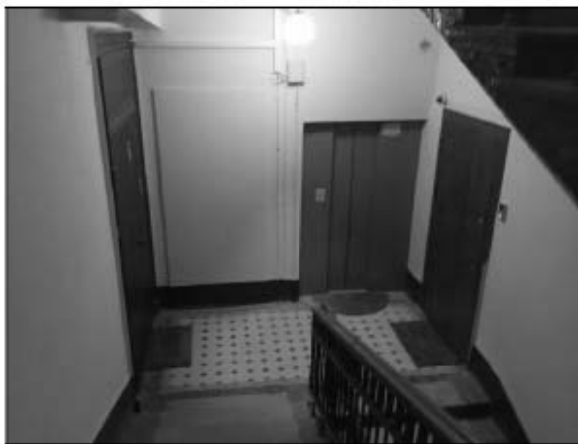
5. Лестничная клетка парадной лестницы (1 ЛК). Фрагменты интерьера с дверными заполнениями.
