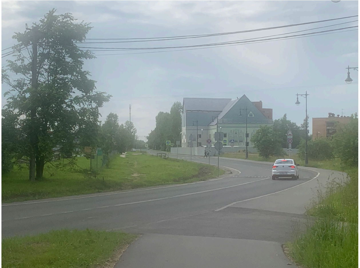
Фото 14. ОКН федерального значения «Павильон «Царский вокзал». Вид на Академический проспект. Июнь 2024 г.
