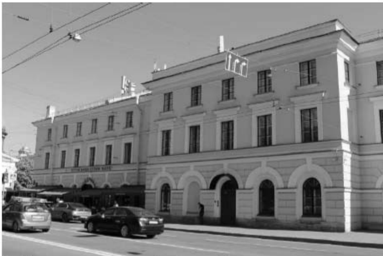
31. Вид на северо-западный фасад объекта культурного наследия федерального значения «Казармы (Трехэскадронный корпус)».
