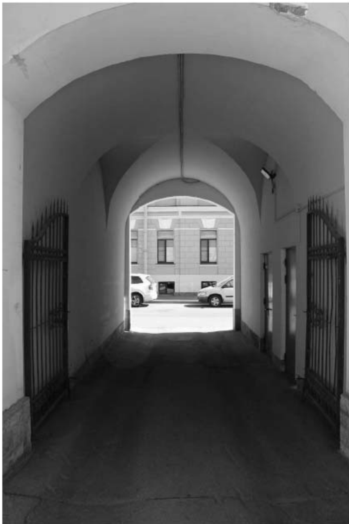
33. Вид на воротный проезд в северо-восточной трехэтажной части объекта культурного наследия федерального значения «Казармы (Трехэскадронный корпус)».
