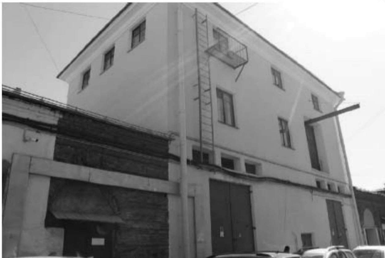
56. Вид на юго-восточный дворовый фасад объекта культурного наследия федерального значения «Казармы (Трехэскадронный корпус)».
