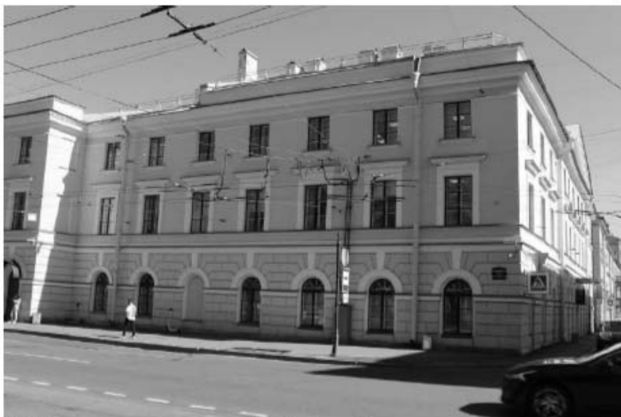
19. Вид на северо-западный фасад объекта культурного наследия федерального значения «Казармы (Трехэскадронный корпус)».
