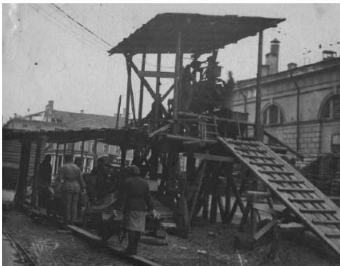
38. Работы по восстановлению города. 1944 г. (источник: госкаталог.рф № 38853820).
