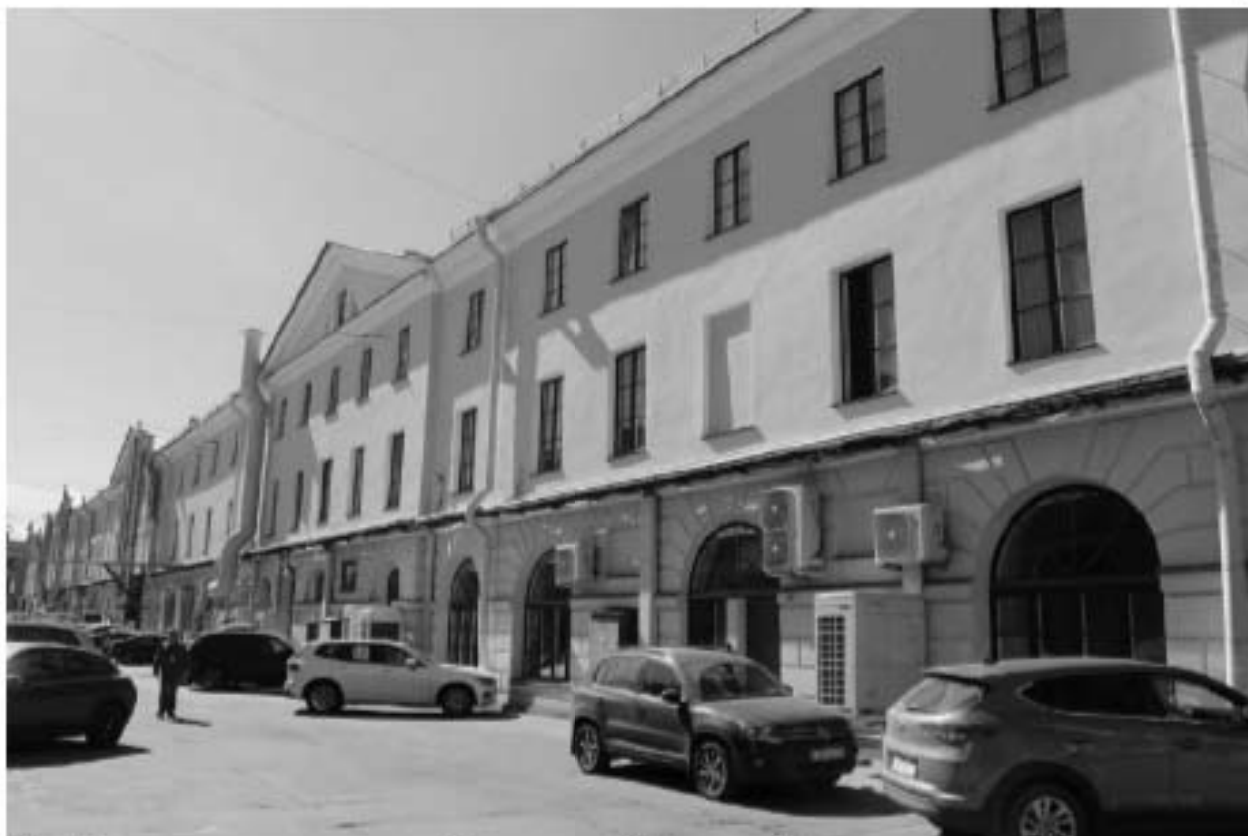
42. Вид на северо-западный дворовый фасад объекта культурного наследия федерального значения «Казармы (Трехэскадронный корпус)».
