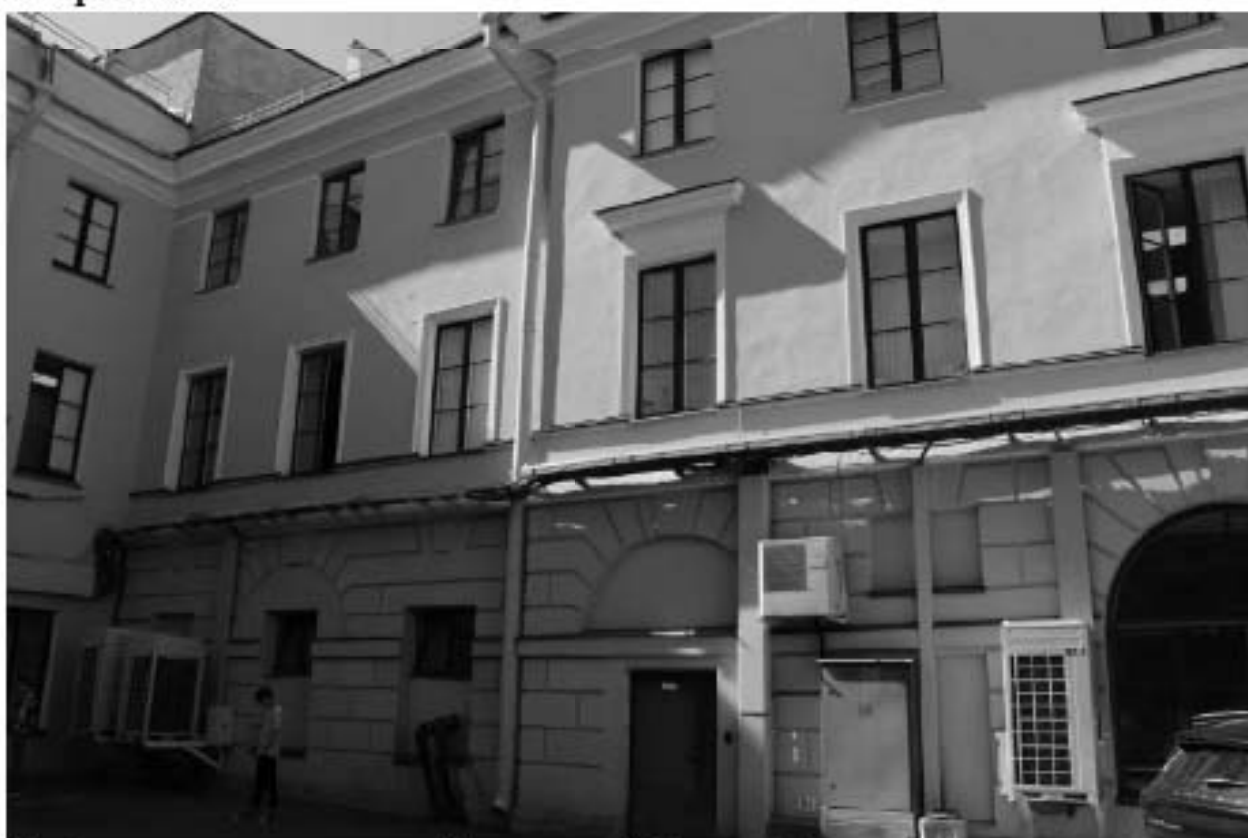
63. Вид на северо-западный дворовый фасад объекта культурного наследия федерального значения «Казармы (Трехэскадронный корпус)».
