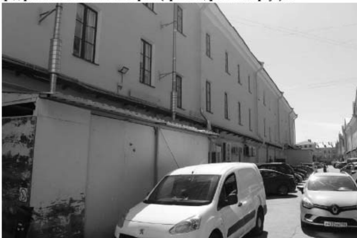
35. Вид на юго-восточный дворовый фасад объекта культурного наследия федерального значения «Казармы (Трехэскадронный корпус)».
