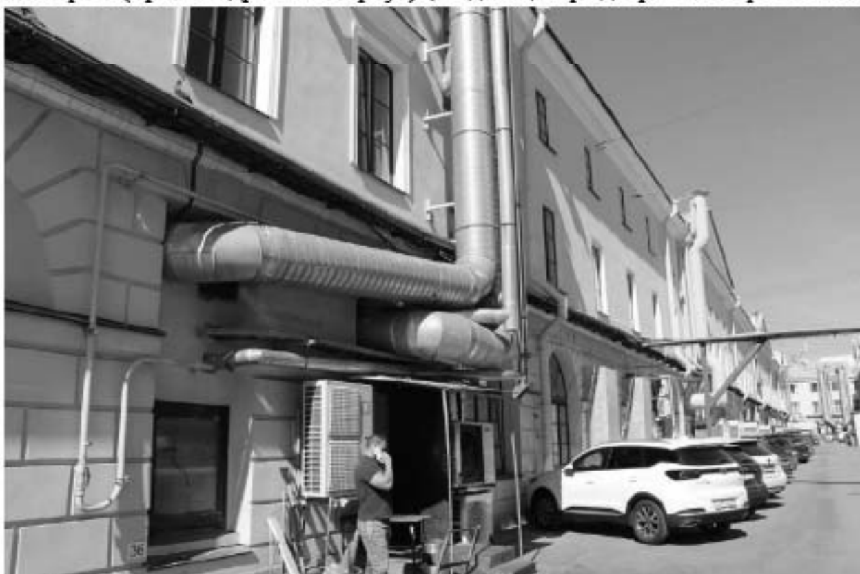
53. Вид на северо-западный дворовый фасад объекта культурного наследия федерального значения «Казармы (Трехэскадронный корпус)».
