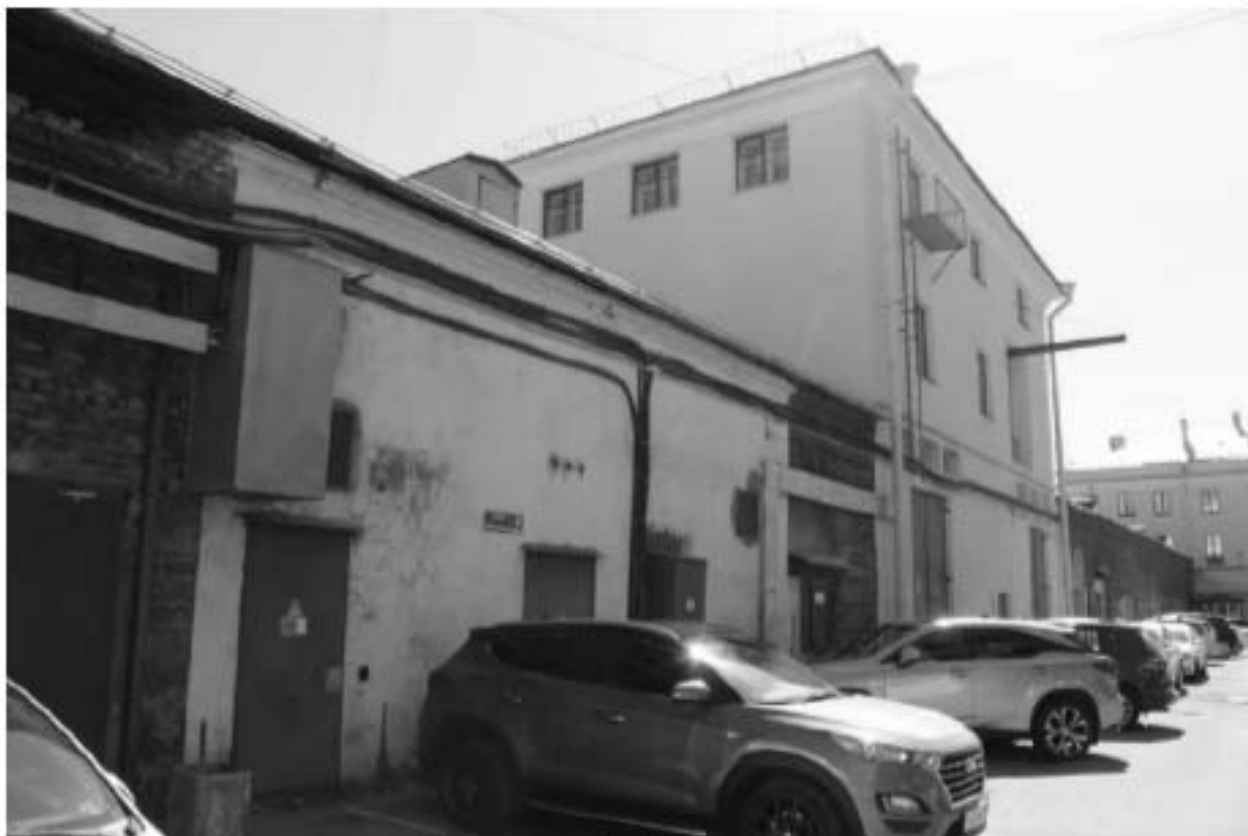
54. Вид на юго-восточный дворовый фасад объекта культурного наследия федерального значения «Казармы (Трехэскадронный корпус)».
