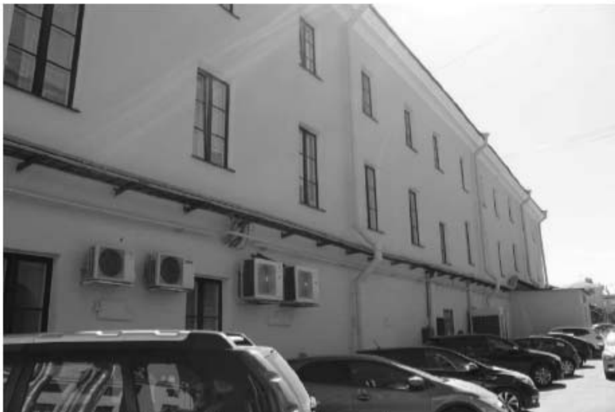
38. Вид на юго-восточный дворовый фасад объекта культурного наследия федерального значения «Казармы (Трехэскадронный корпус)».
