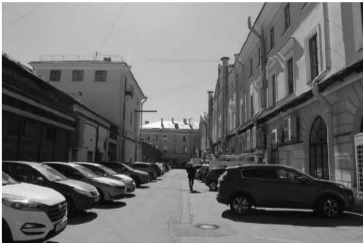
50. Дворовые фасады объекта культурного наследия федерального значения «Казармы (Трехэскадронный корпус)», вид из центра двора на юго-запад.
