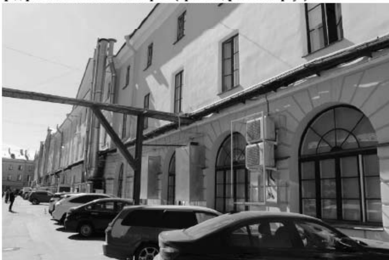
47. Вид на северо-западный дворовый фасад объекта культурного наследия федерального значения «Казармы (Трехэскадронный корпус)».
