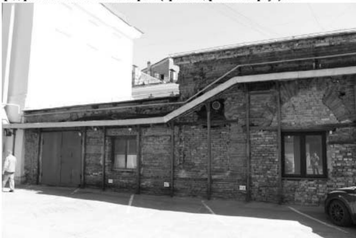
45. Вид на юго-восточный дворовый фасад объекта культурного наследия федерального значения «Казармы (Трехэскадронный корпус)».
