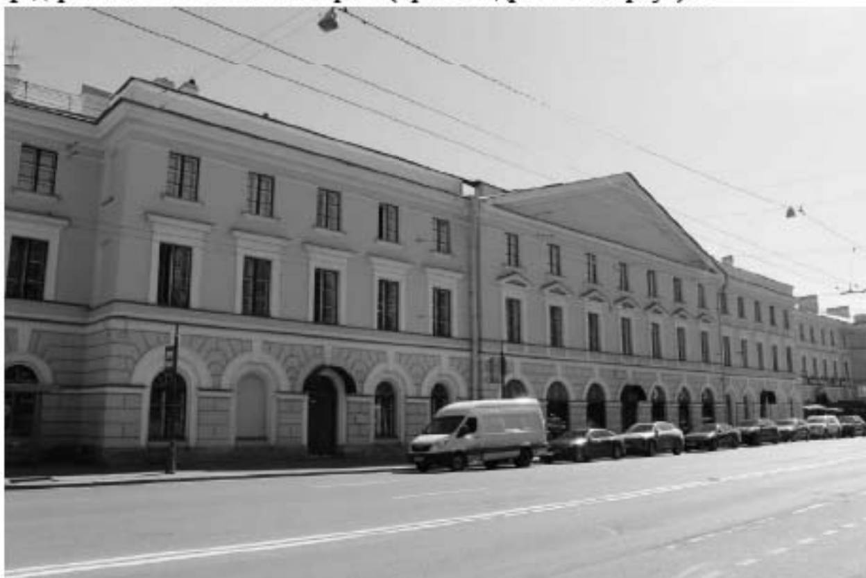
28. Вид на северо-западный фасад объекта культурного наследия федерального значения «Казармы (Трехэскадронный корпус)».
