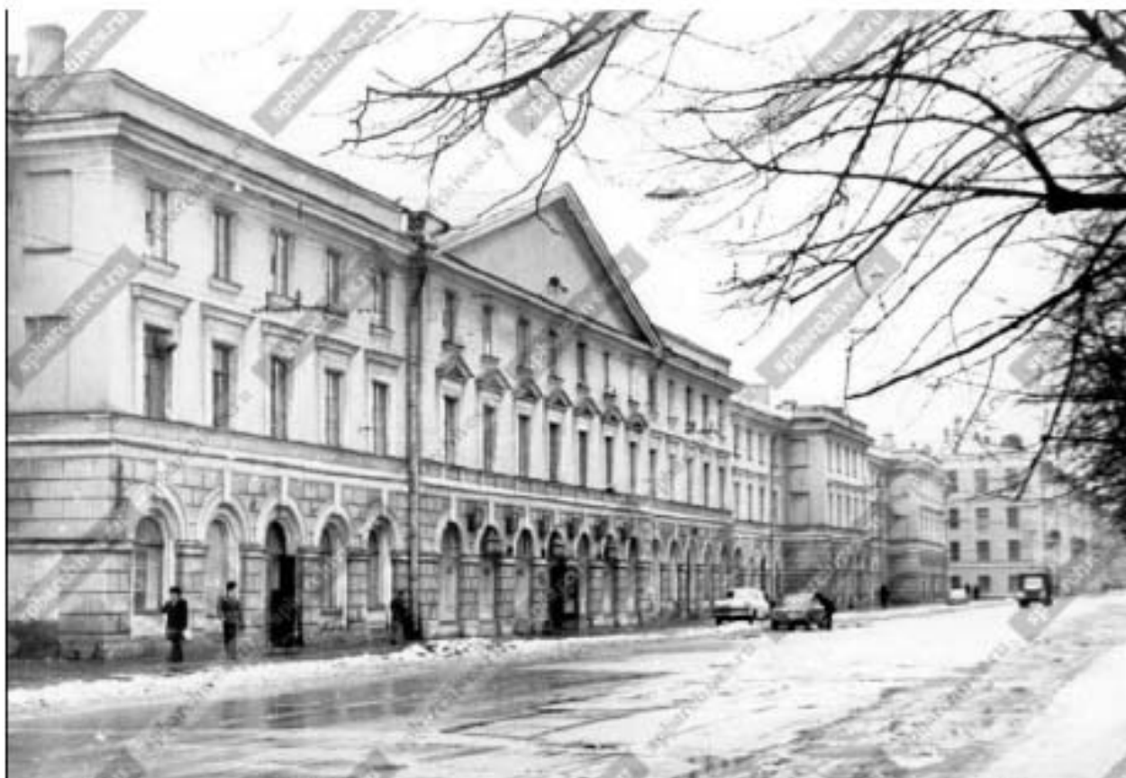
42. Фасад дома № 4 (бывшие казармы Кексгольмского полка) на бульваре Профсоюзов. 1982 г. (источник: ЦГАКФФД СПб. Фотодокументы. Опись 1АР-81. Ед.хр.122298).
