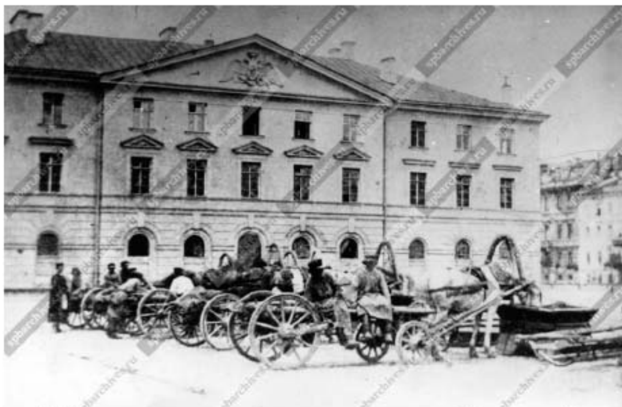
27. Ломовые повозки с извозчиками у здания казарм Конногвардейского полка на Конногвардейском бульваре. До 1900 г. (источник: ЦГАКФФД СПб. Фотодокументы. Опись 1Б-2. Ед.хр.1256).
