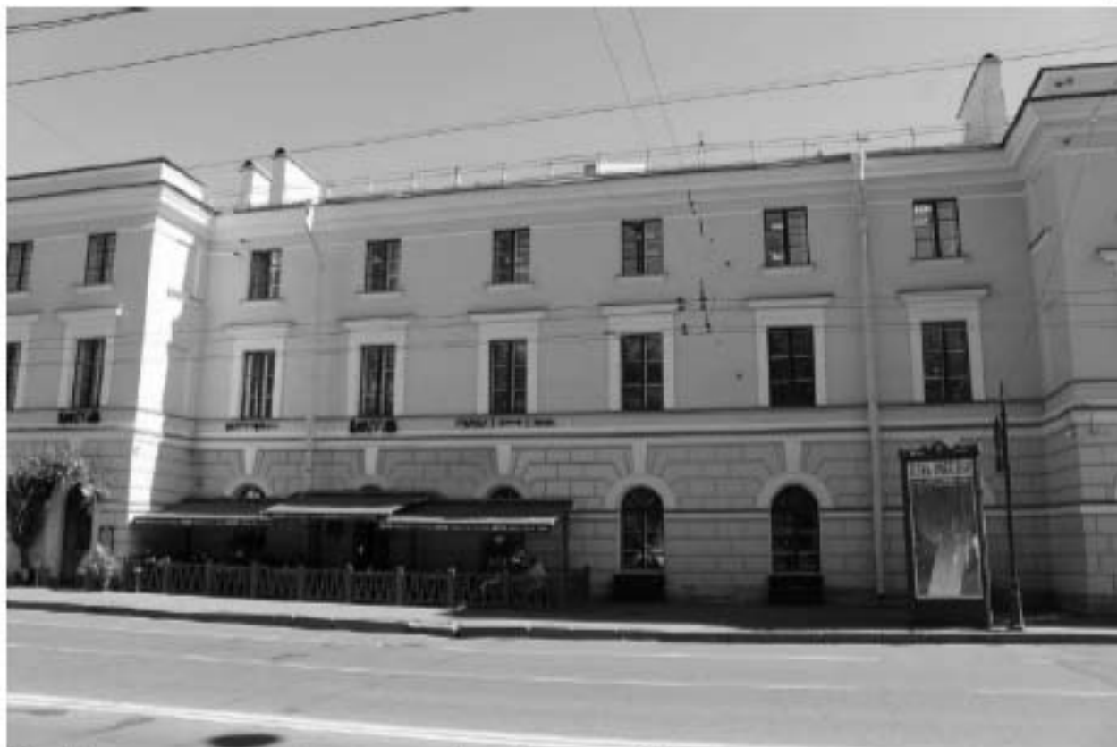
21. Вид на северо-западный фасад объекта культурного наследия федерального значения «Казармы (Трехэскадронный корпус)».
