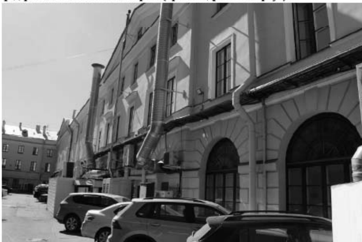
55. Вид на северо-западный дворовый фасад объекта культурного наследия федерального значения «Казармы (Трехэскадронный корпус)».
