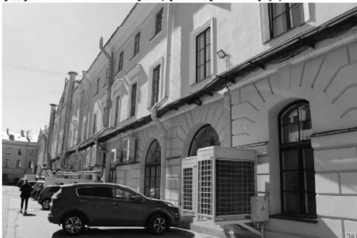
49. Вид на северо-западный дворовый фасад объекта культурного наследия федерального значения «Казармы (Трехэскадронный корпус)».
