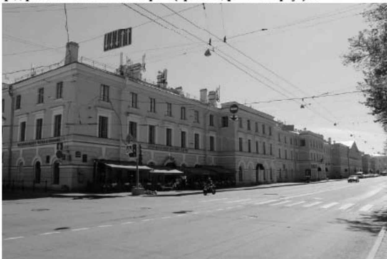
32. Вид на северо-западный фасад объекта культурного наследия федерального значения «Казармы (Трехэскадронный корпус)».
