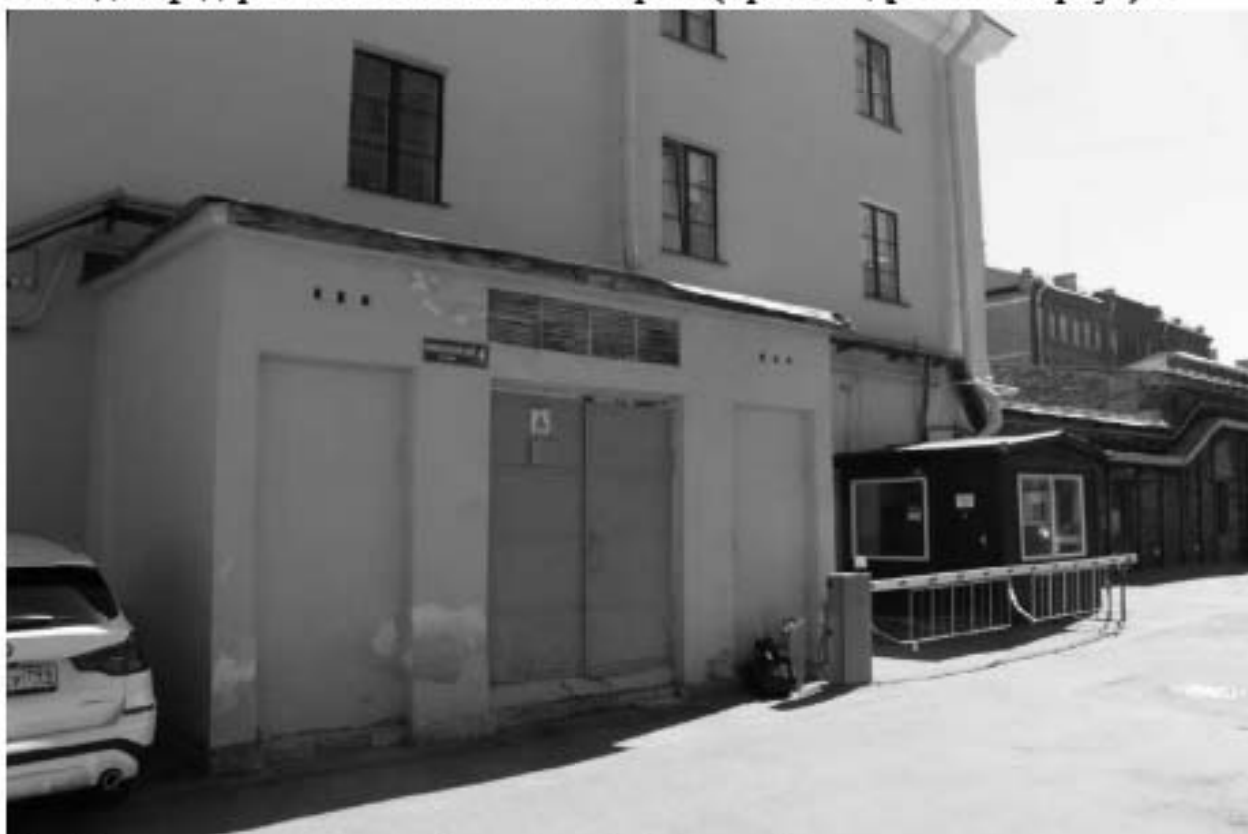
41. Вид на юго-восточный дворовый фасад объекта культурного наследия федерального значения «Казармы (Трехэскадронный корпус)».
