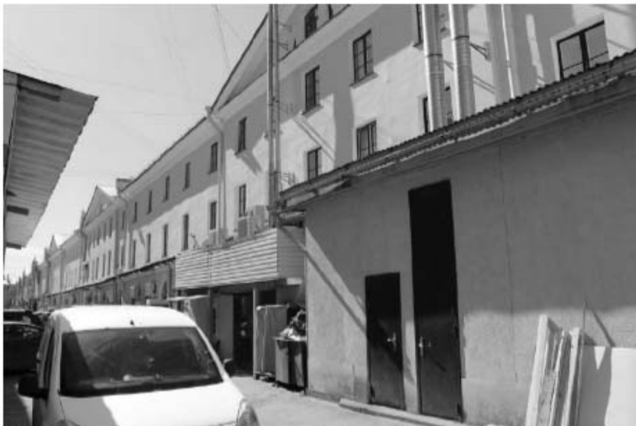
36. Вид на северо-западный дворовый фасад объекта культурного наследия федерального значения «Казармы (Трехэскадронный корпус)».
