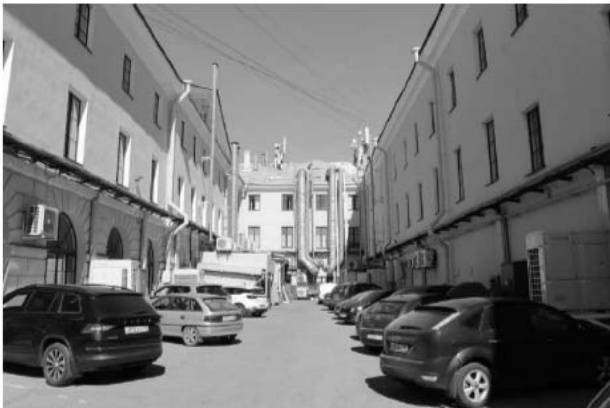
40. Вид на дворовые фасады в северо-восточной части объекта культурного наследия федерального значения «Казармы (Трехэскадронный корпус)».
