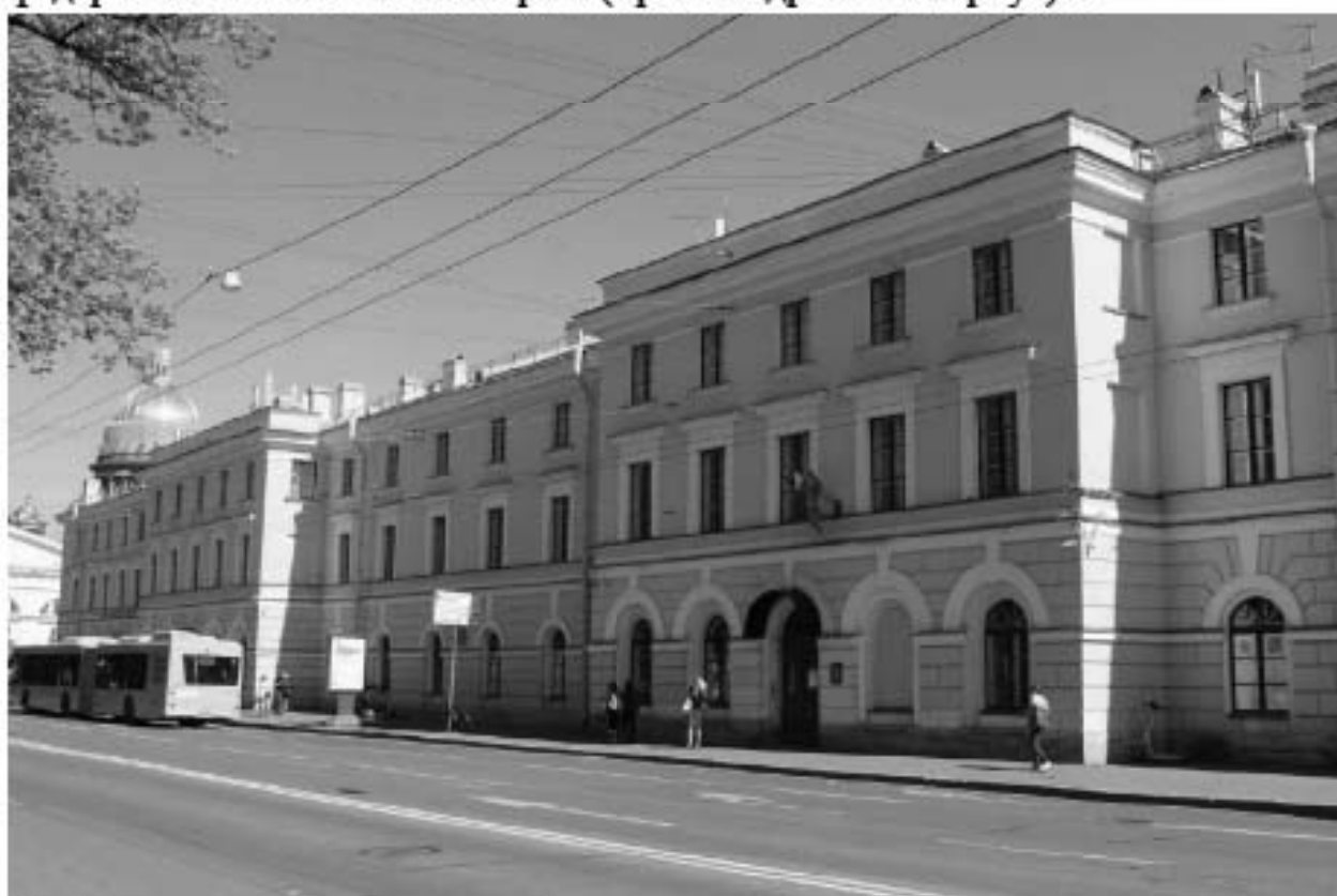
30. Вид на северо-западный фасад объекта культурного наследия федерального значения «Казармы (Трехэскадронный корпус)».
