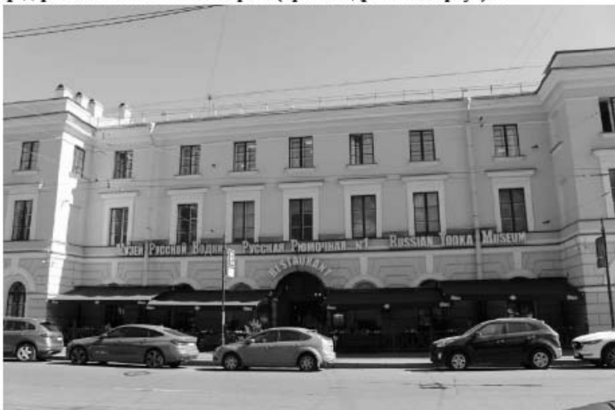
24. Вид на северо-западный фасад объекта культурного наследия федерального значения «Казармы (Трехэскадронный корпус)».
