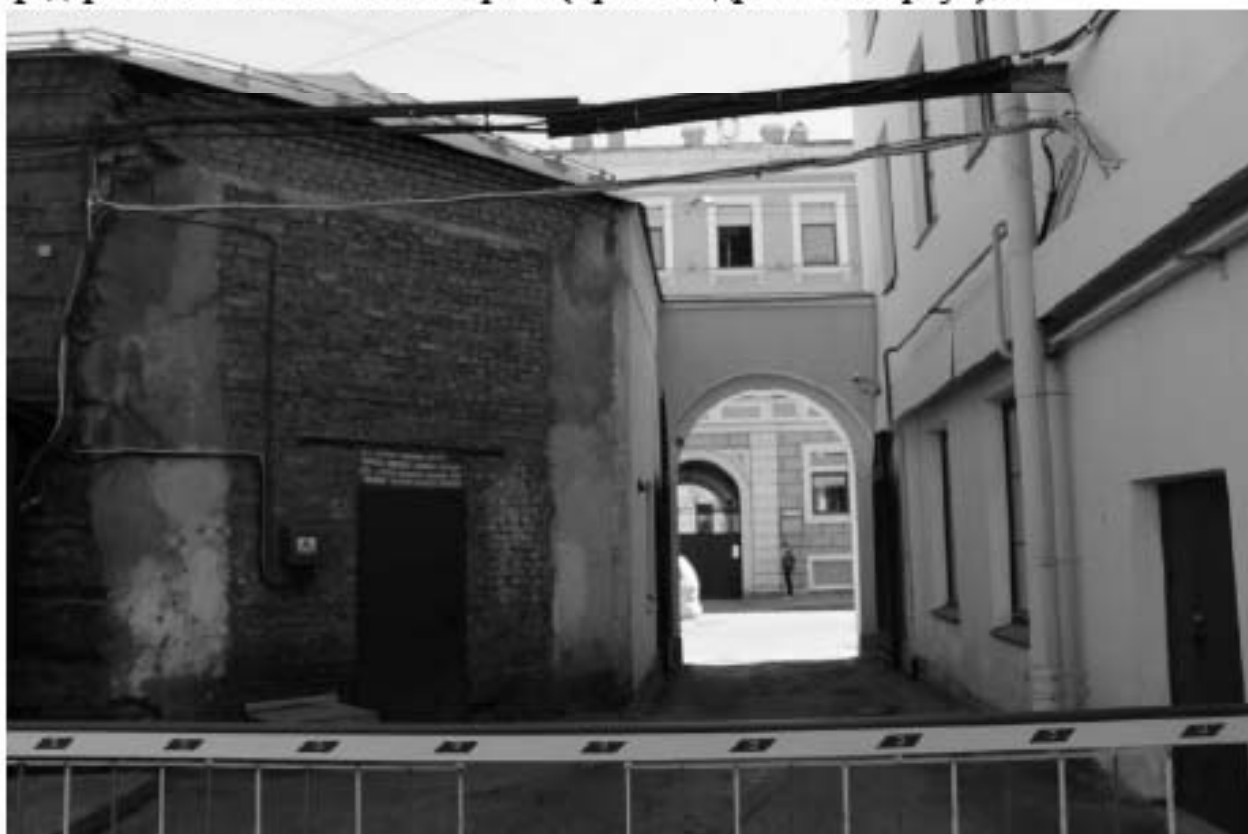
65. Вид на вход во двор объекта культурного наследия федерального значения «Казармы (Трехэскадронный корпус)» в юго-западной части.
