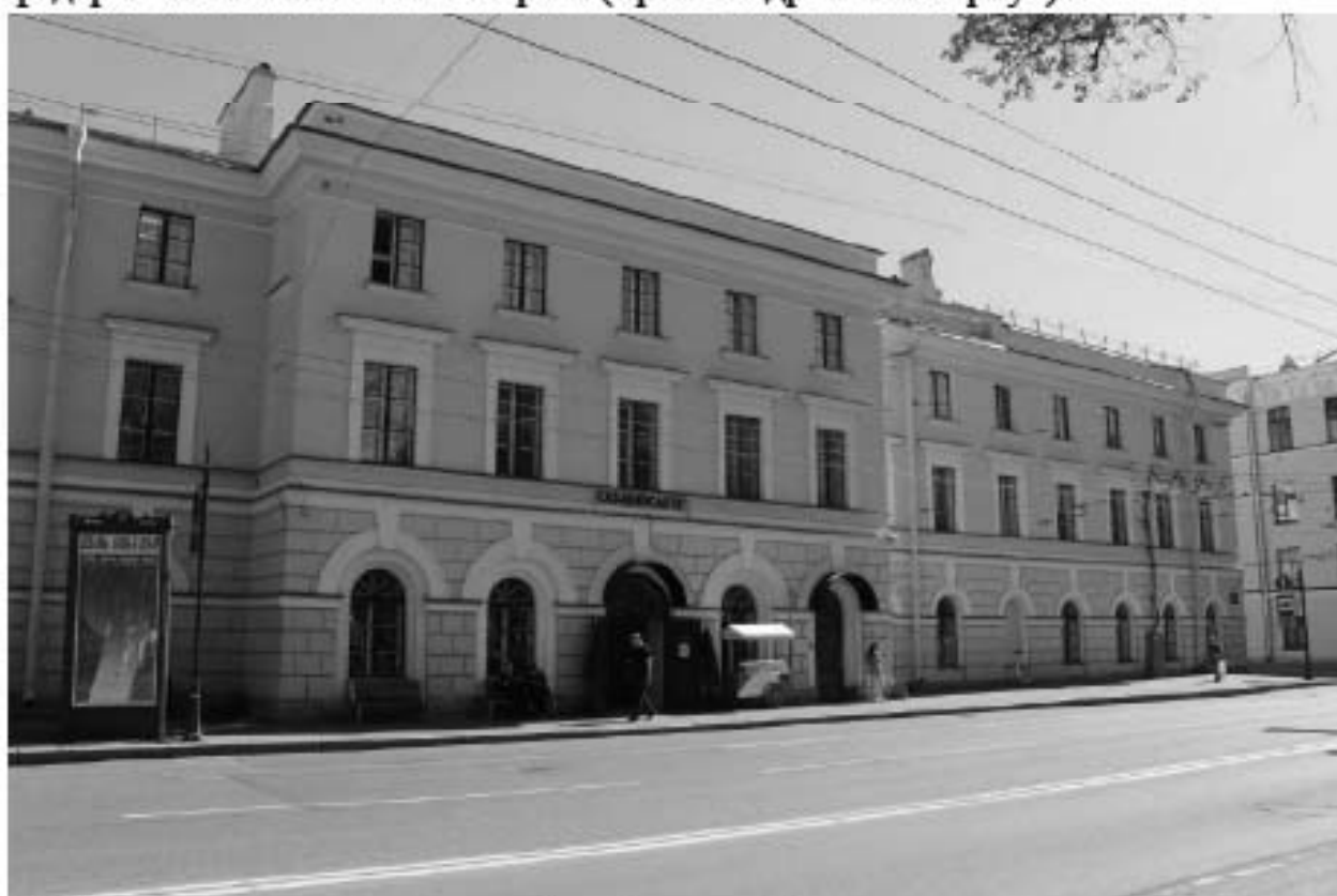
20. Вид на северо-западный фасад объекта культурного наследия федерального значения «Казармы (Трехэскадронный корпус)».
