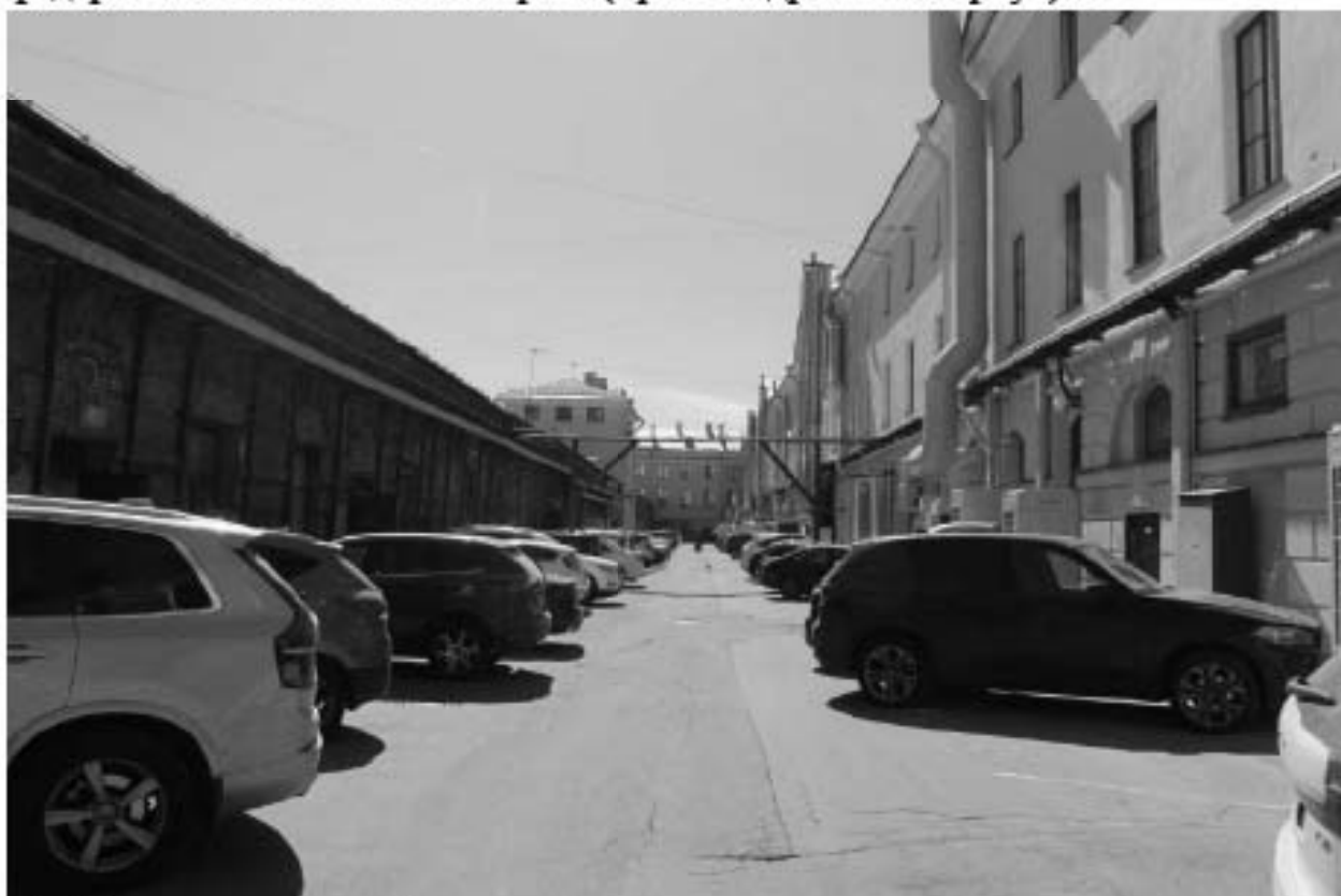
43. Вид на дворовые фасады объекта культурного наследия федерального значения «Казармы (Трехэскадронный корпус)» с северо-востока.
