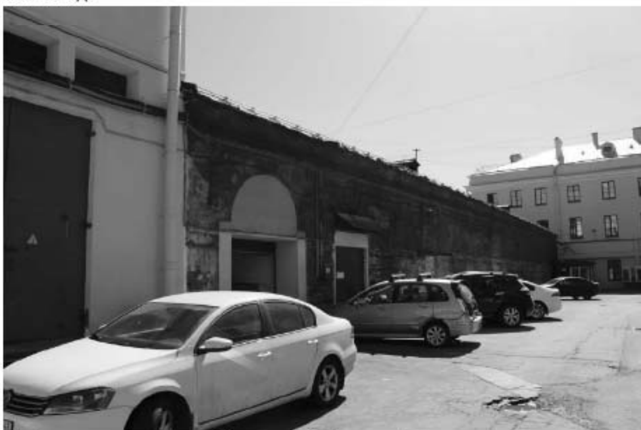
59. Вид на юго-восточный дворовый фасад объекта культурного наследия федерального значения «Казармы (Трехэскадронный корпус)».
