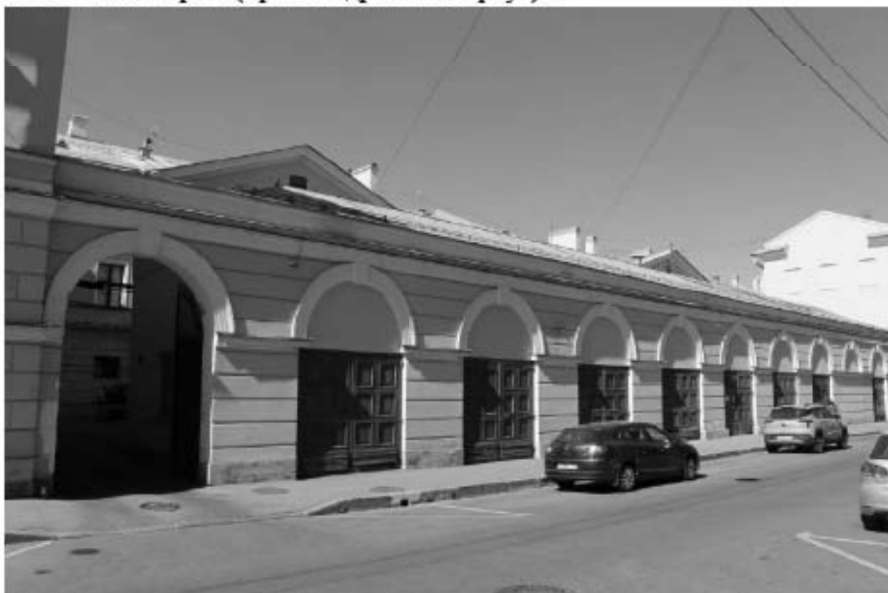
14. Вид на юго-восточный фасад объекта культурного наследия федерального значения «Казармы (Трехэскадронный корпус)».
