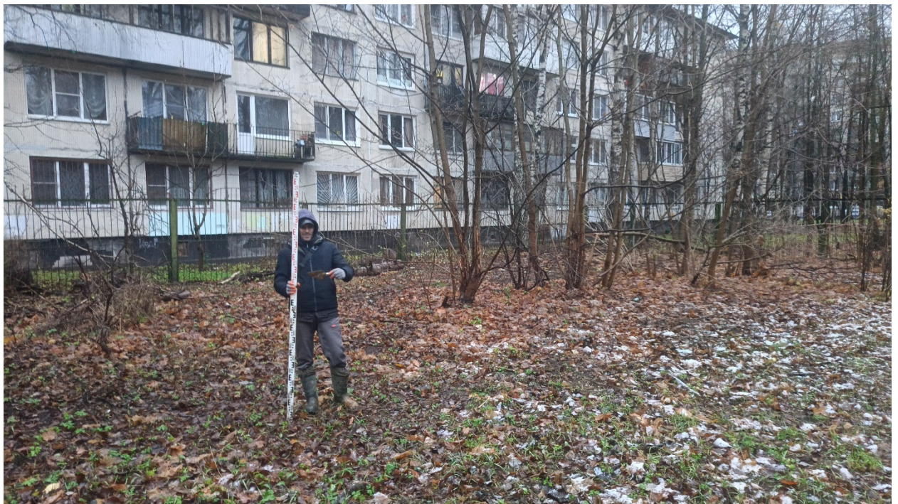
Рис. 16. СПб-2024. Черкасова ул., 19, к. 2, лит. А. Точка фотофиксации 1, вид с запада.
