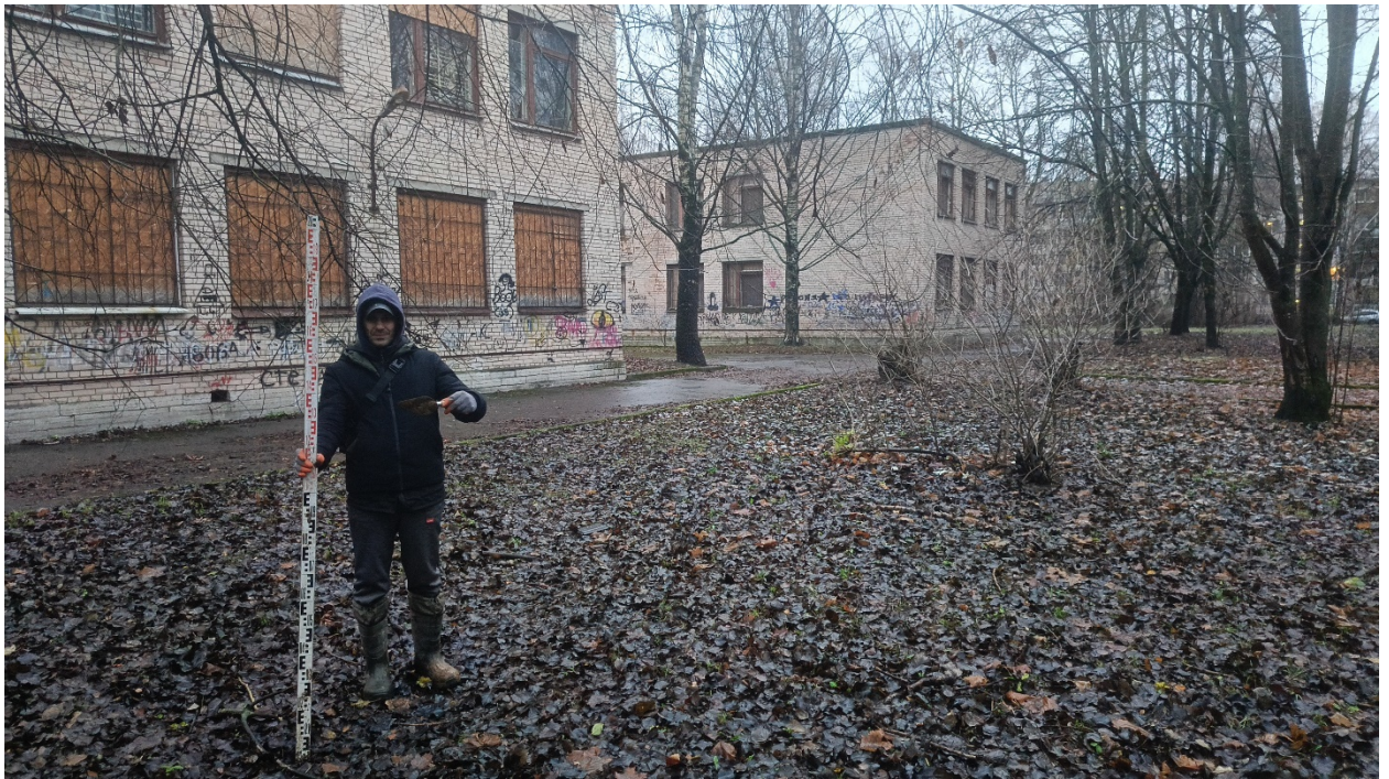
Рис. 24. СПб-2024. Черкасова ул., 19, к. 2, лит. А. Точка фотофиксации 3, вид с запада.
