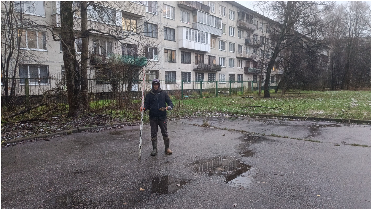
Рис. 20. СПб-2024. Черкасова ул., 19, к. 2, лит. А. Точка фотофиксации 2, вид с запада.
