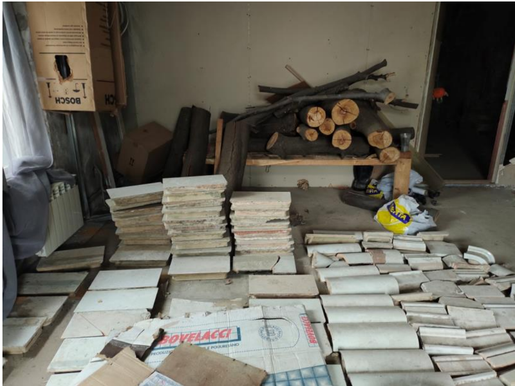
41. ОКН регионального значения «Особняк Кудрявцева с участком», Санкт-Петербург, Выборгское шоссе, д 32.Первый этаж. Печь № 5.
