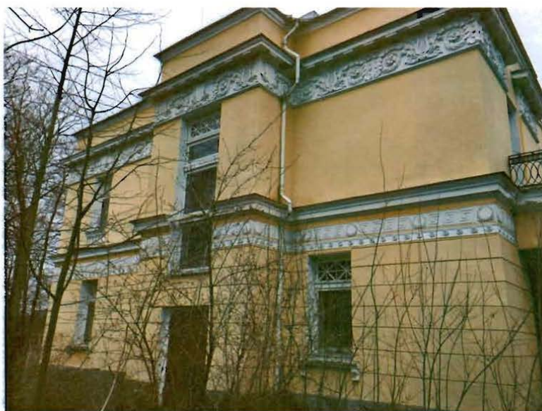
4. Юго-восточный фасад здания.
