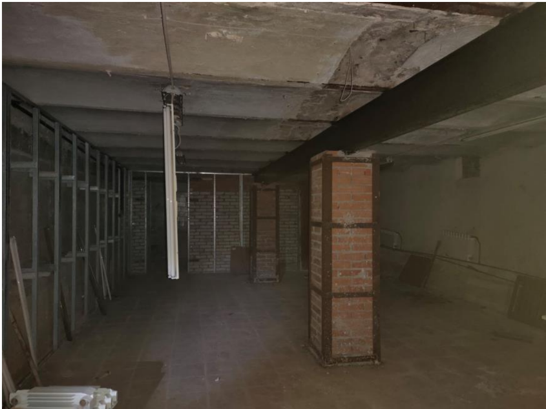
16. ОКН регионального значения «Особняк Кудрявцева с участком», Санкт-Петербург, Выборгское шоссе, д 32. Подвал.
