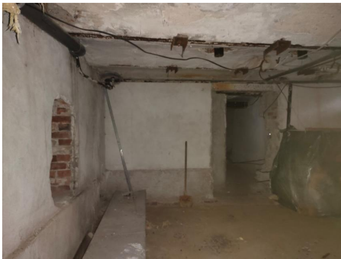
21. ОКН регионального значения «Особняк Кудрявцева с участком», Санкт-Петербург, Выборгское шоссе, д 32. Подвал.
