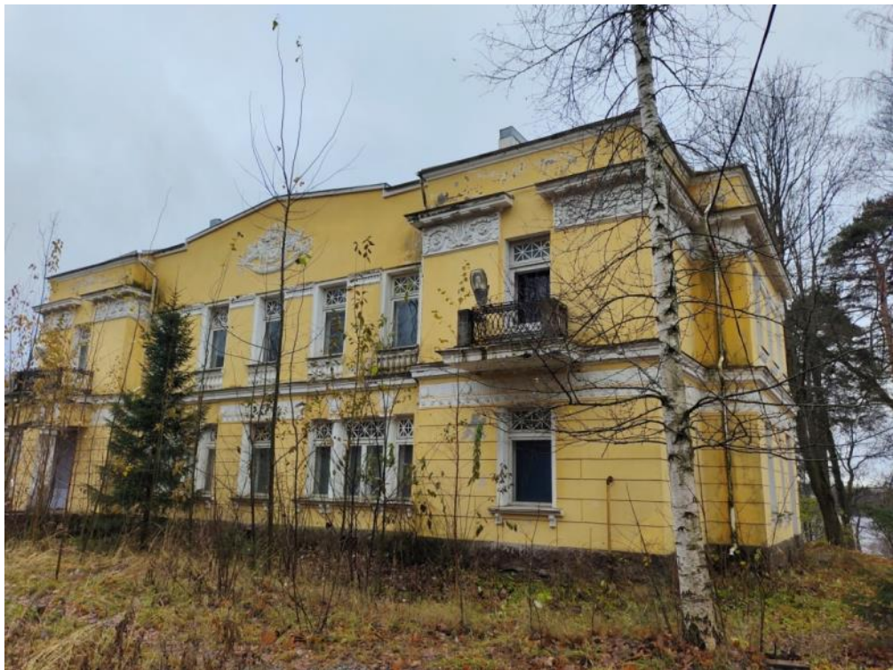
3. ОКН регионального значения «Особняк Кудрявцева с участком», Санкт-Петербург, Выборгское шоссе, д 32.
