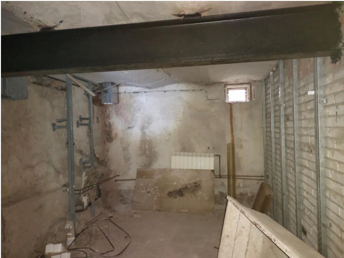
18. ОКН регионального значения «Особняк Кудрявцева с участком», Санкт-Петербург, Выборгское шоссе, д 32. Подвал.
