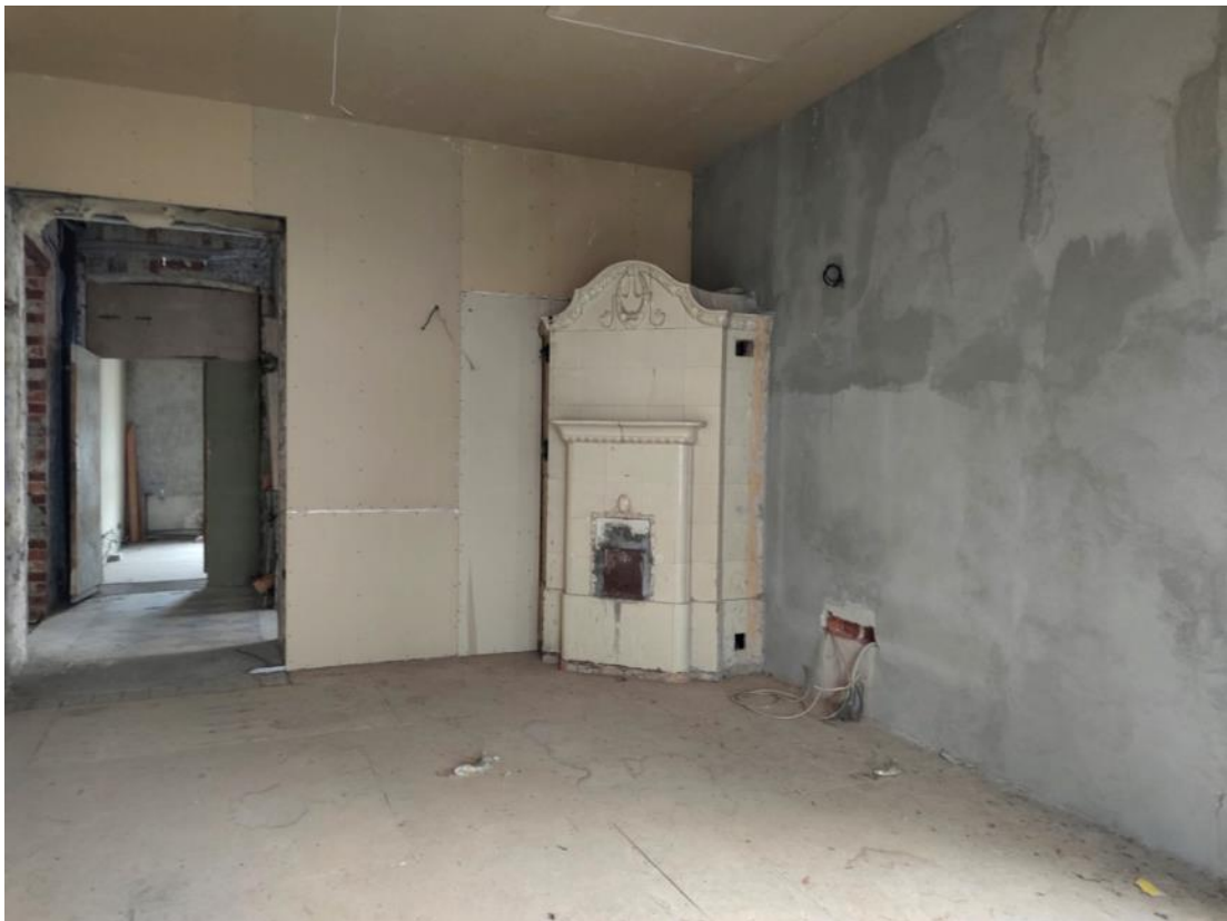
48. ОКН регионального значения «Особняк Кудрявцева с участком», Санкт-Петербург, Выборгское шоссе, д 32. Второй этаж. Печь № 7.
