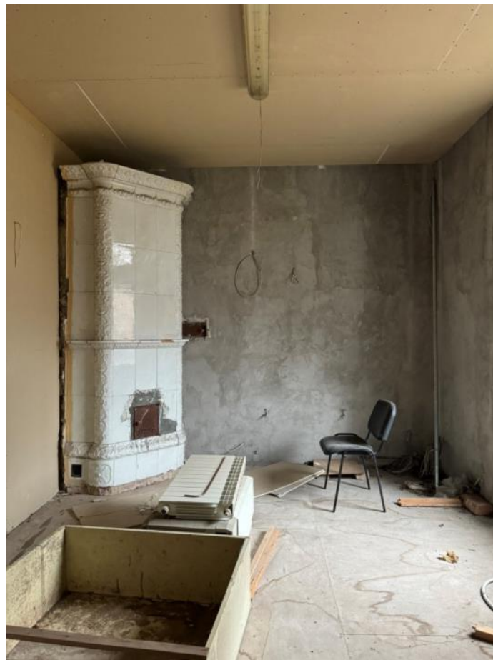
55. ОКН регионального значения «Особняк Кудрявцева с участком», Санкт-Петербург, Выборгское шоссе, д 32. Второй этаж. Печь № 8.
