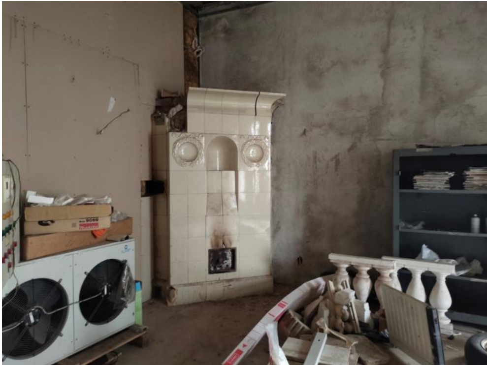
37. ОКН регионального значения «Особняк Кудрявцева с участком», Санкт-Петербург, Выборгское шоссе, д 32.Первый этаж. Печь № 6.
