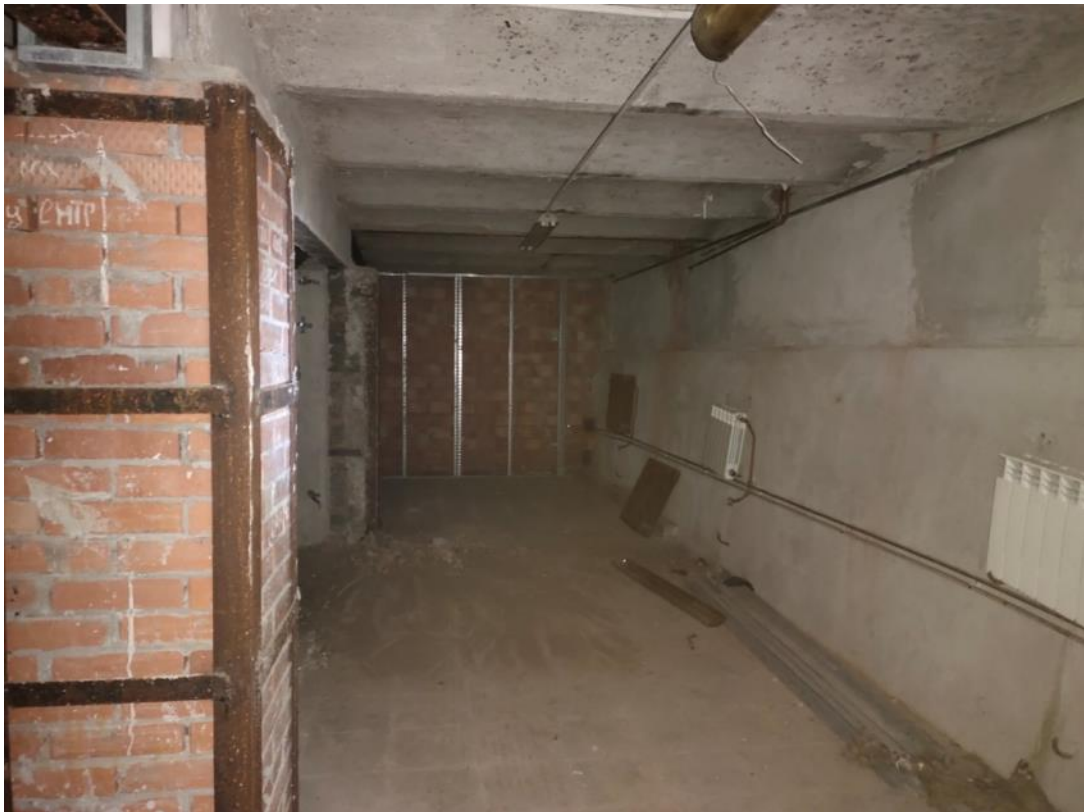
22. ОКН регионального значения «Особняк Кудрявцева с участком», Санкт-Петербург, Выборгское шоссе, д 32. Подвал.
