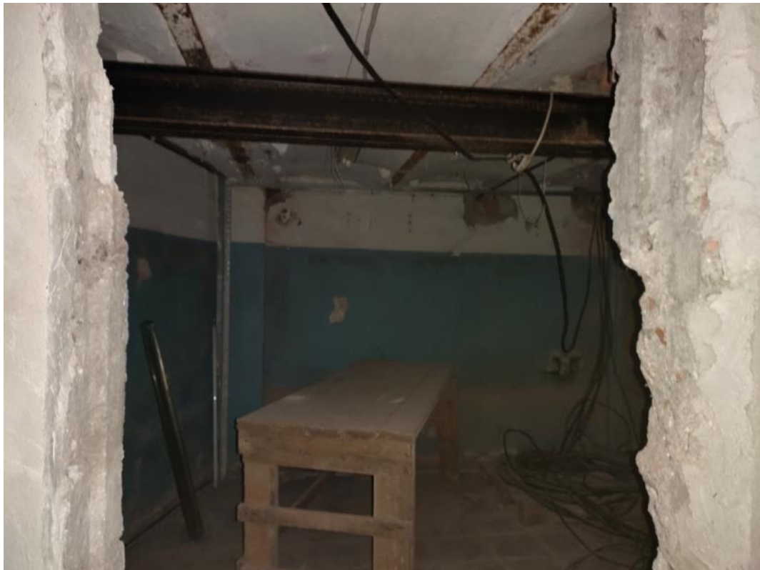
20. ОКН регионального значения «Особняк Кудрявцева с участком», Санкт-Петербург, Выборгское шоссе, д 32. Подвал.
