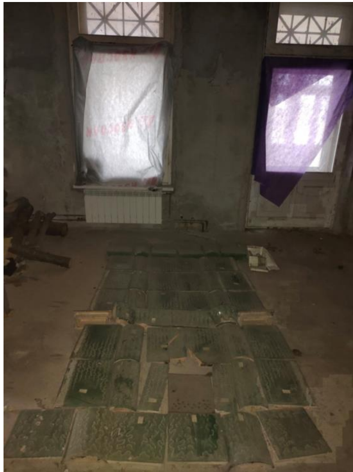
40. ОКН регионального значения «Особняк Кудрявцева с участком», Санкт-Петербург, Выборгское шоссе, д 32.Первый этаж. Печь № 4.
