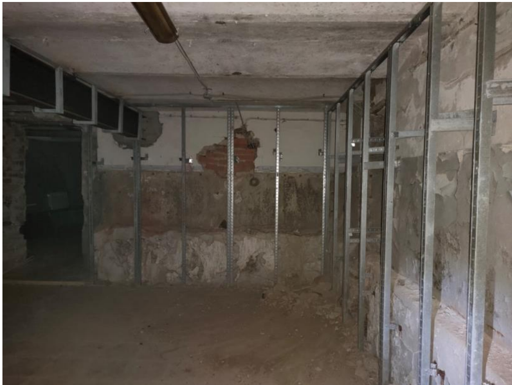
19. ОКН регионального значения «Особняк Кудрявцева с участком», Санкт-Петербург, Выборгское шоссе, д 32. Подвал.
