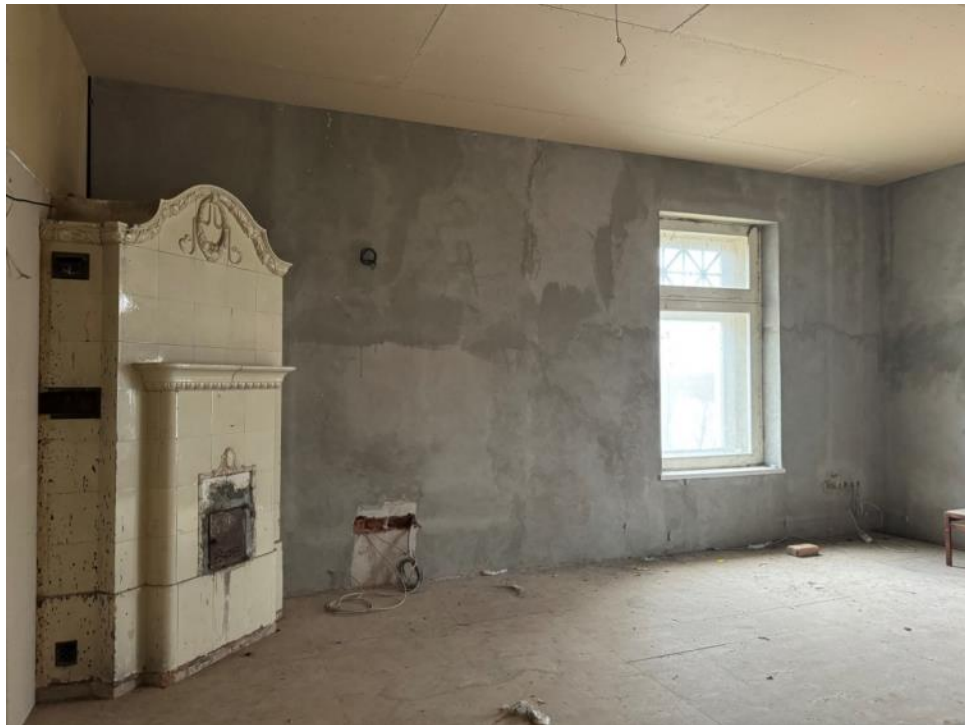
45. ОКН регионального значения «Особняк Кудрявцева с участком», Санкт-Петербург, Выборгское шоссе, д 32. Второй этаж. Печь № 7.
