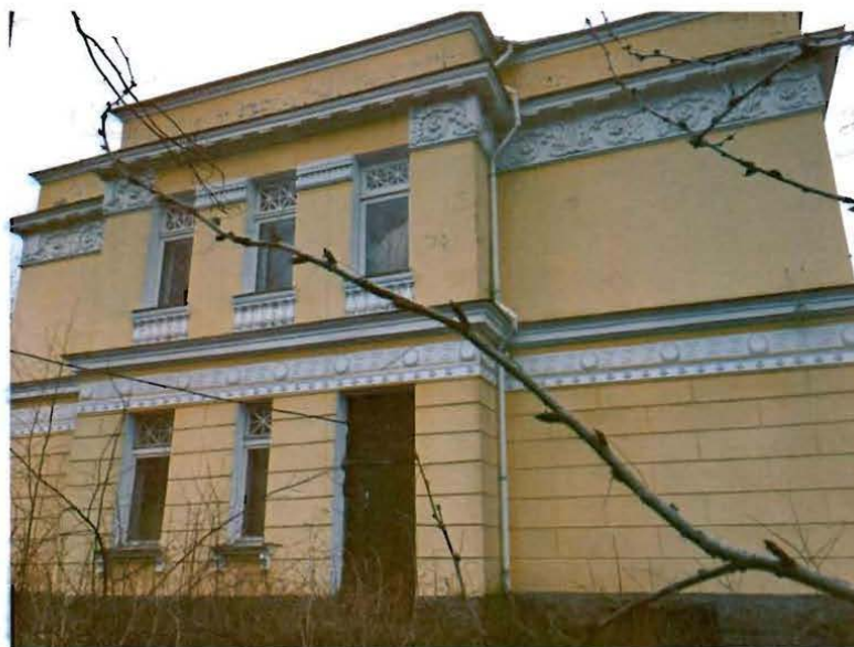
3. Северо-западный фасад здания.
