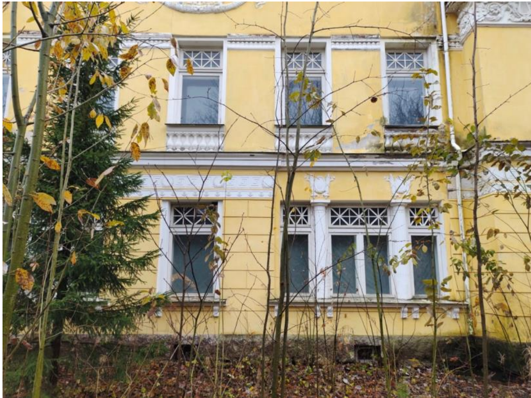
15. ОКН регионального значения «Особняк Кудрявцева с участком», Санкт-Петербург, Выборгское шоссе, д 32.
