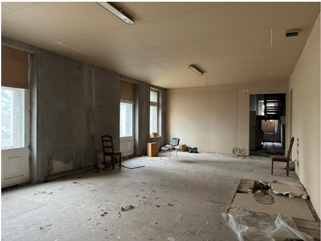
43. ОКН регионального значения «Особняк Кудрявцева с участком», Санкт-Петербург, Выборгское шоссе, д 32.Второй этаж.
