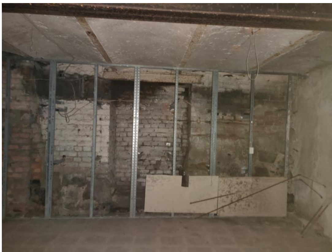
23. ОКН регионального значения «Особняк Кудрявцева с участком», Санкт-Петербург, Выборгское шоссе, д 32. Подвал.
