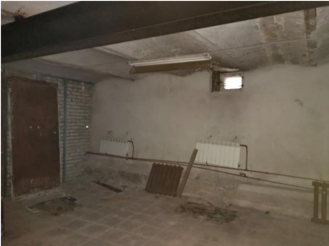
17. ОКН регионального значения «Особняк Кудрявцева с участком», Санкт-Петербург, Выборгское шоссе, д 32. Подвал.
