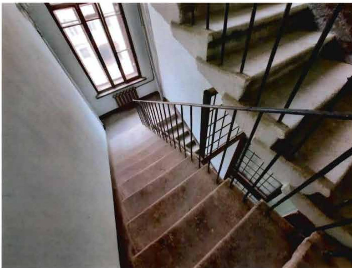
15. Интерьеры объекта культурного наследия. Лестница 3ЛК
