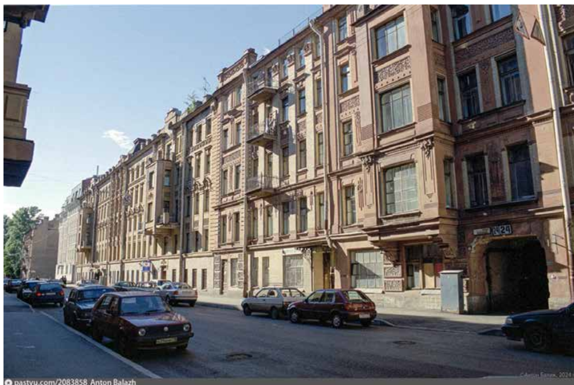
Илл.38. Фасады по Введенской ул. Фото А. Балажа, 2000 г. URL: https://pastvu.com/p/2083858 ;
