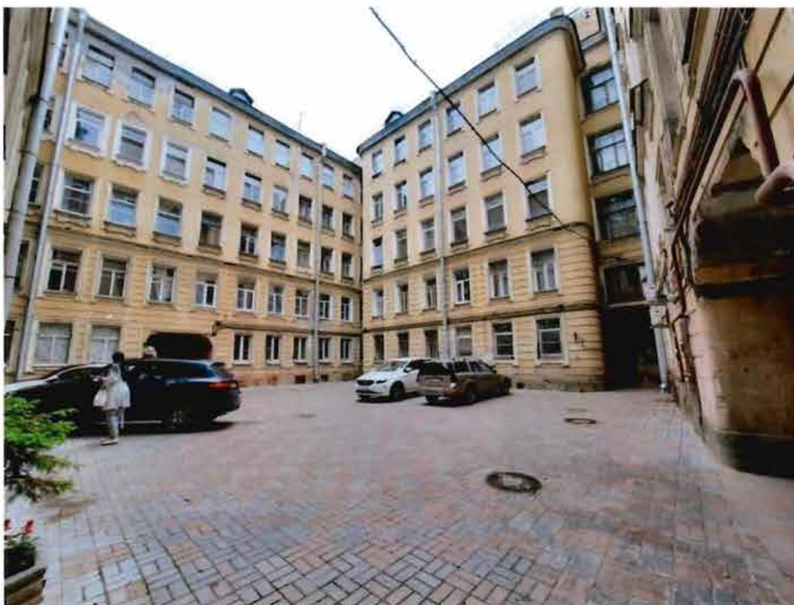
5. Общий вид на южный внутренний двор объекта культурного наследия (северо-восточный и юго-восточный фасады)
