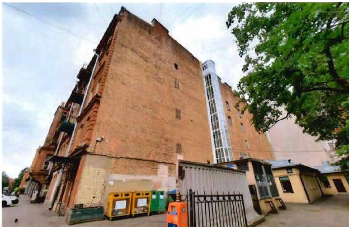
8. Общий вид на юго-восточный фасад объекта культурного наследия
