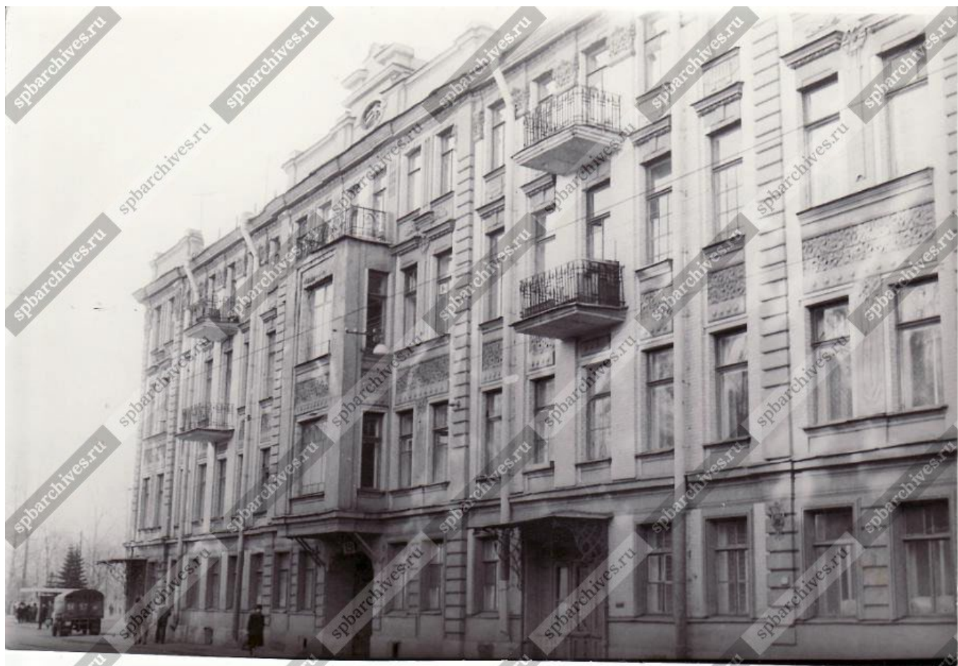
Илл. 34. Общий вид фасада жилого дома №19 на улице Олега Кошевого (совр. Введенская ул.). 14.02.1989 г. Автор: К.В. Овчинников // ЦГАКФД СПб. Фотодокументы. Оп.1АР- 155. Ед.хр.220766
