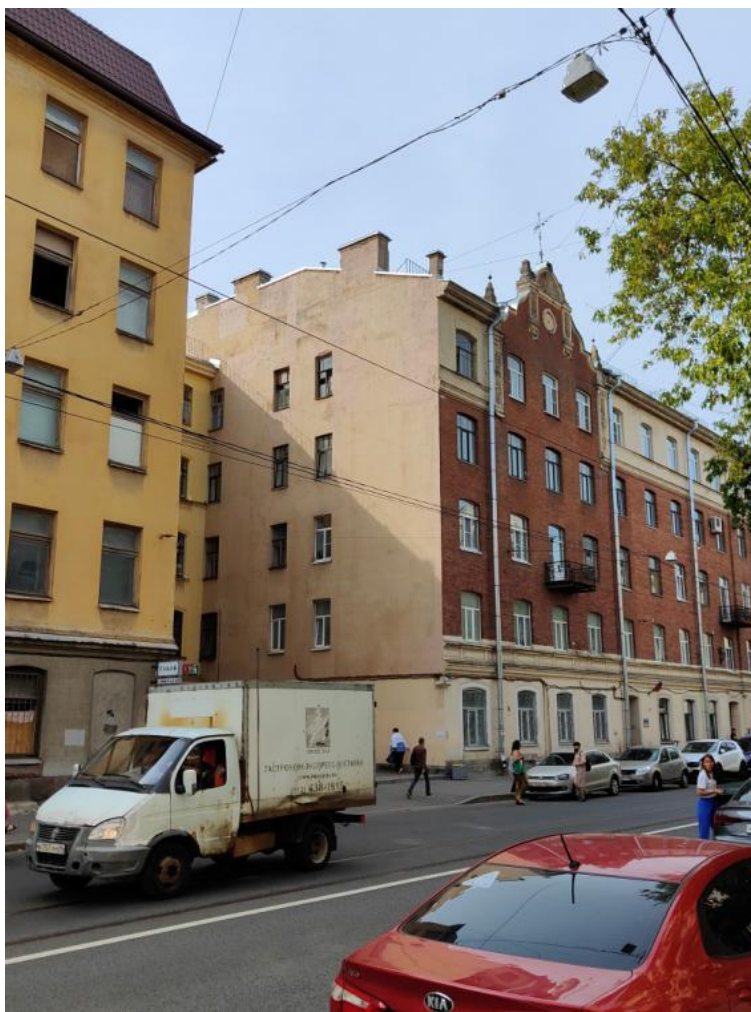
Фото 1 Лицевой фасад выявленного объекта культурного наследия «Дом Б.Е. Фурмана»
