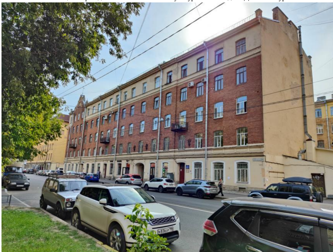
Фото 2 Лицевой фасад выявленного объекта культурного наследия «Дом Б.Е. Фурмана»
