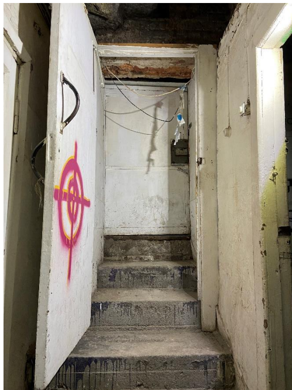
Фото 2. Вид на входную дверь в пом. 1-Н изнутри.
