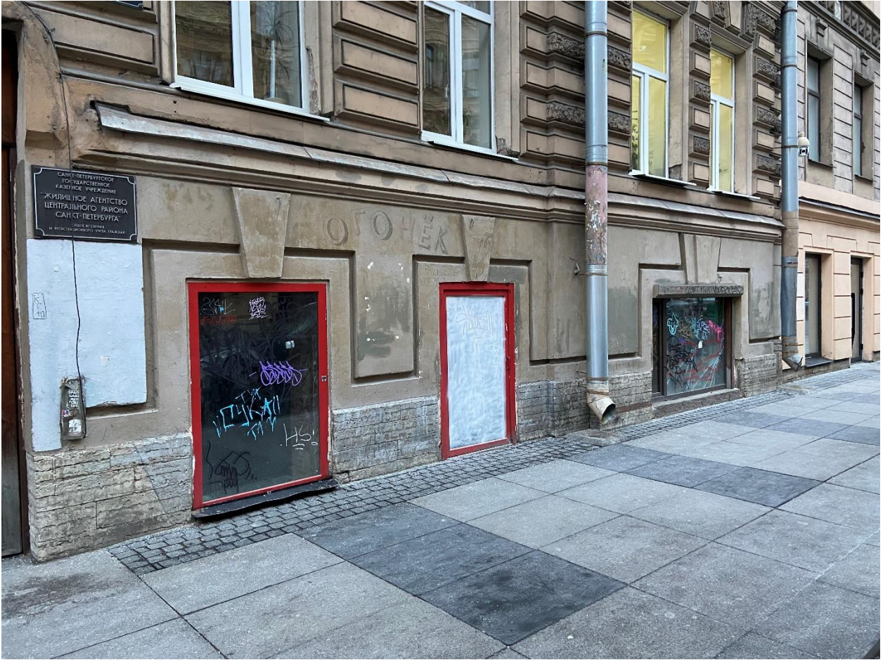
Фото 3. Заполнения оконных проемов помещения 1-Н дома № 8 по улице Рубинштейна.
