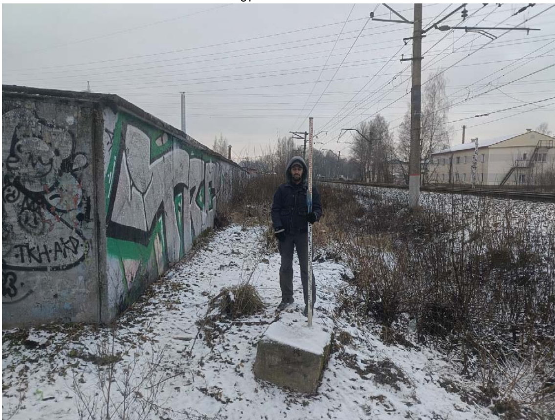
Рис. 27. СПб-2024. Транспортная развязка Северный-Руставели. Точка фотофиксации 5, вид с юга.
