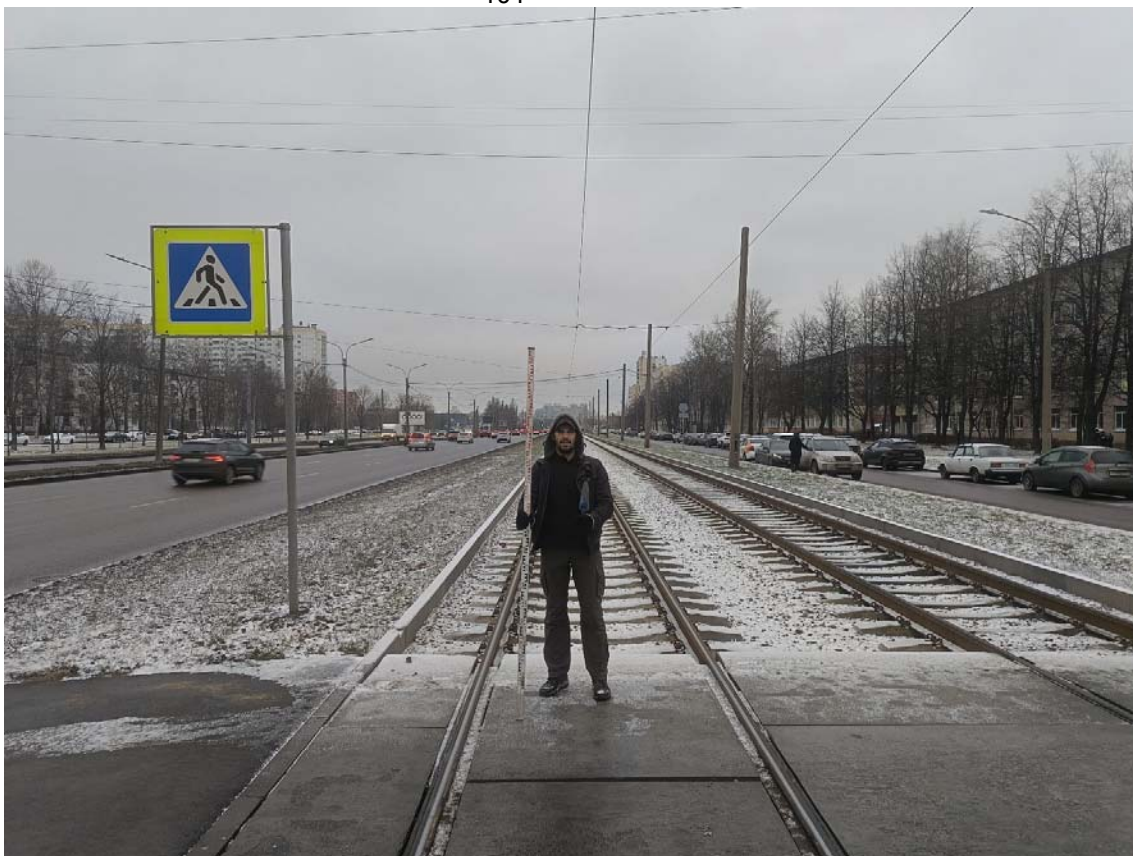
Рис. 35. СПб-2024. Транспортная развязка Северный-Руставели. Точка фотофиксации 7, вид с юга.
