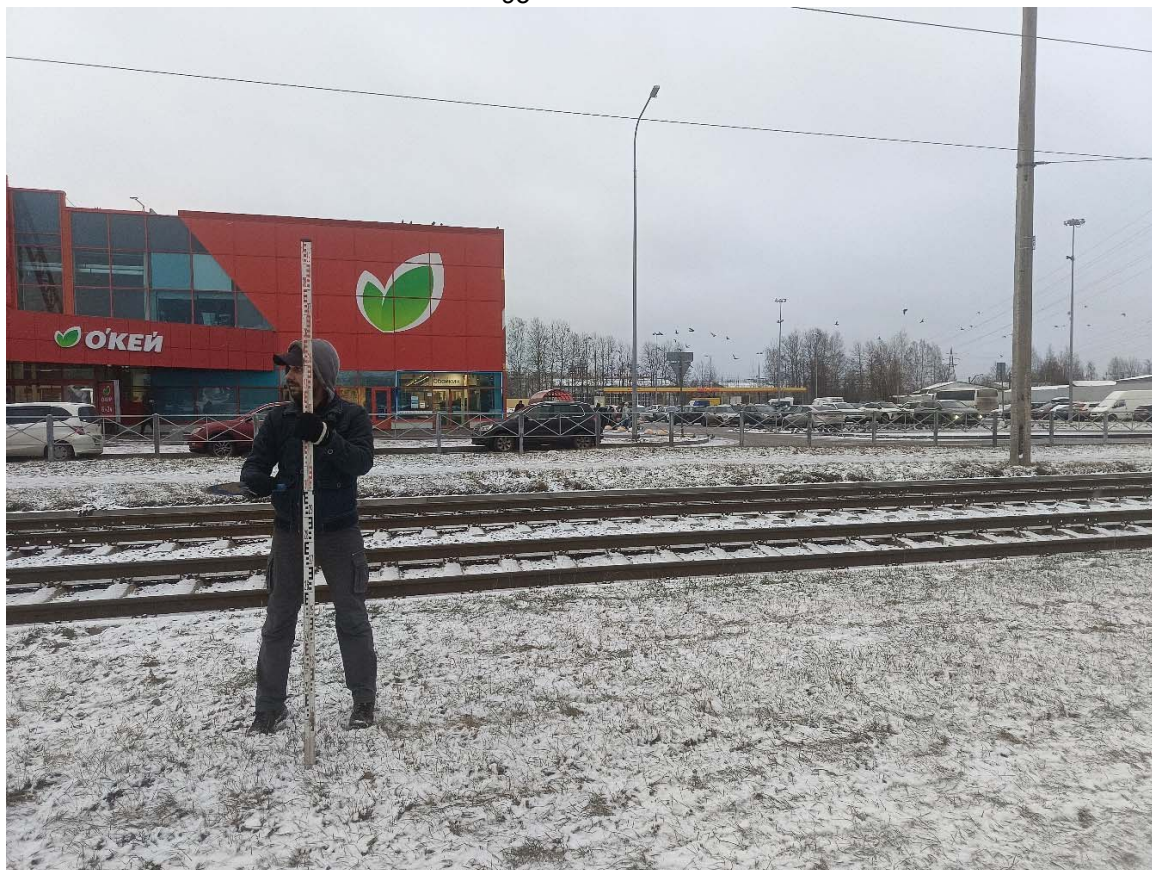
Рис. 23. СПб-2024. Транспортная развязка Северный-Руставели. Точка фотофиксации 3, вид с запада.
