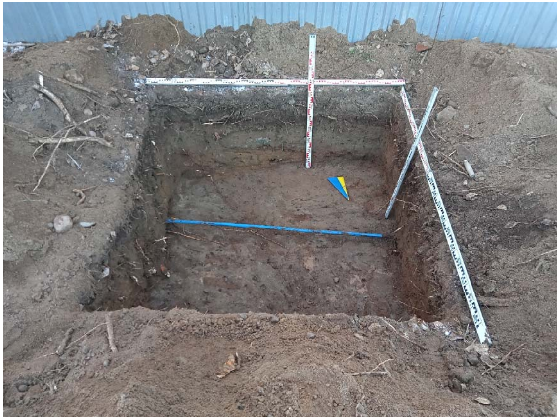
Рис. 72. СПб-2024. Транспортная развязка Северный-Руставели. Шурф 2, фиксация по уровню материковой поверхности, вид с севера.
