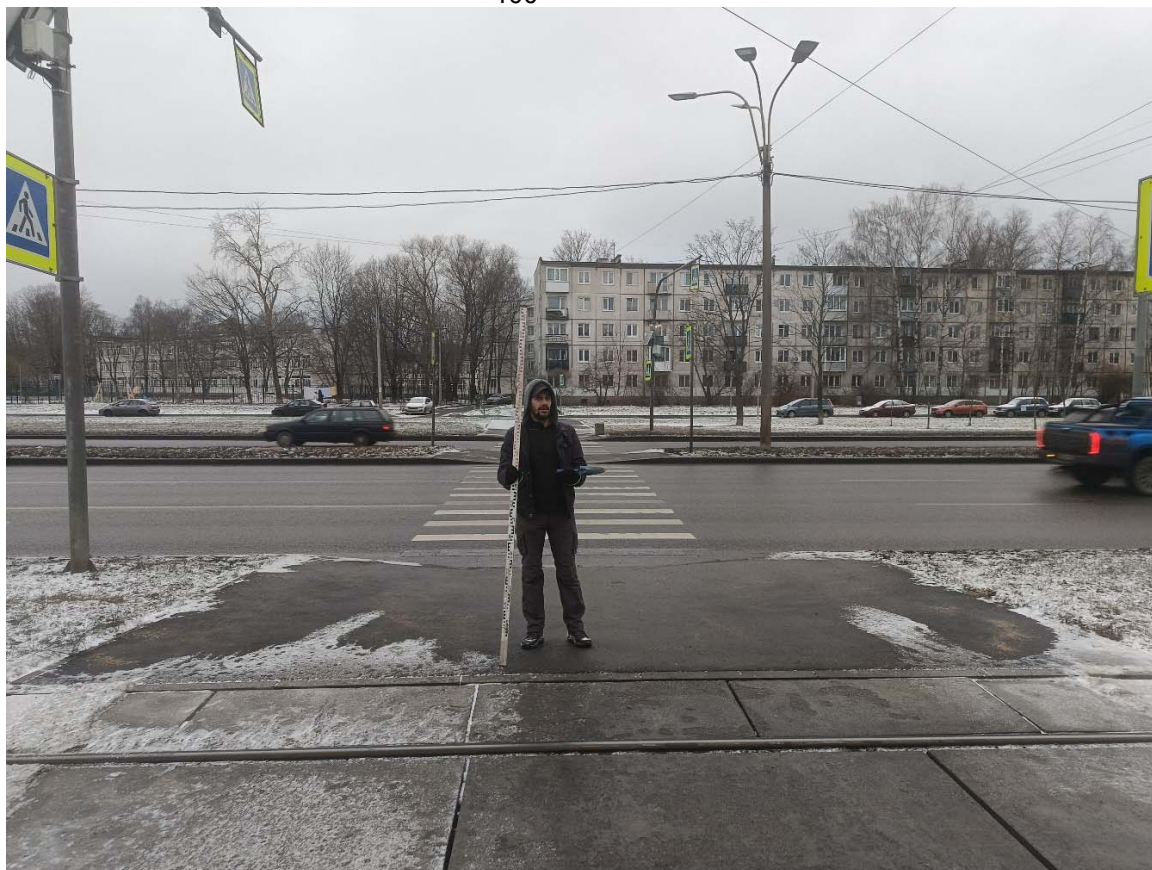
Рис. 33. СПб-2024. Транспортная развязка Северный-Руставели. Точка фотофиксации 7, вид с востока.
