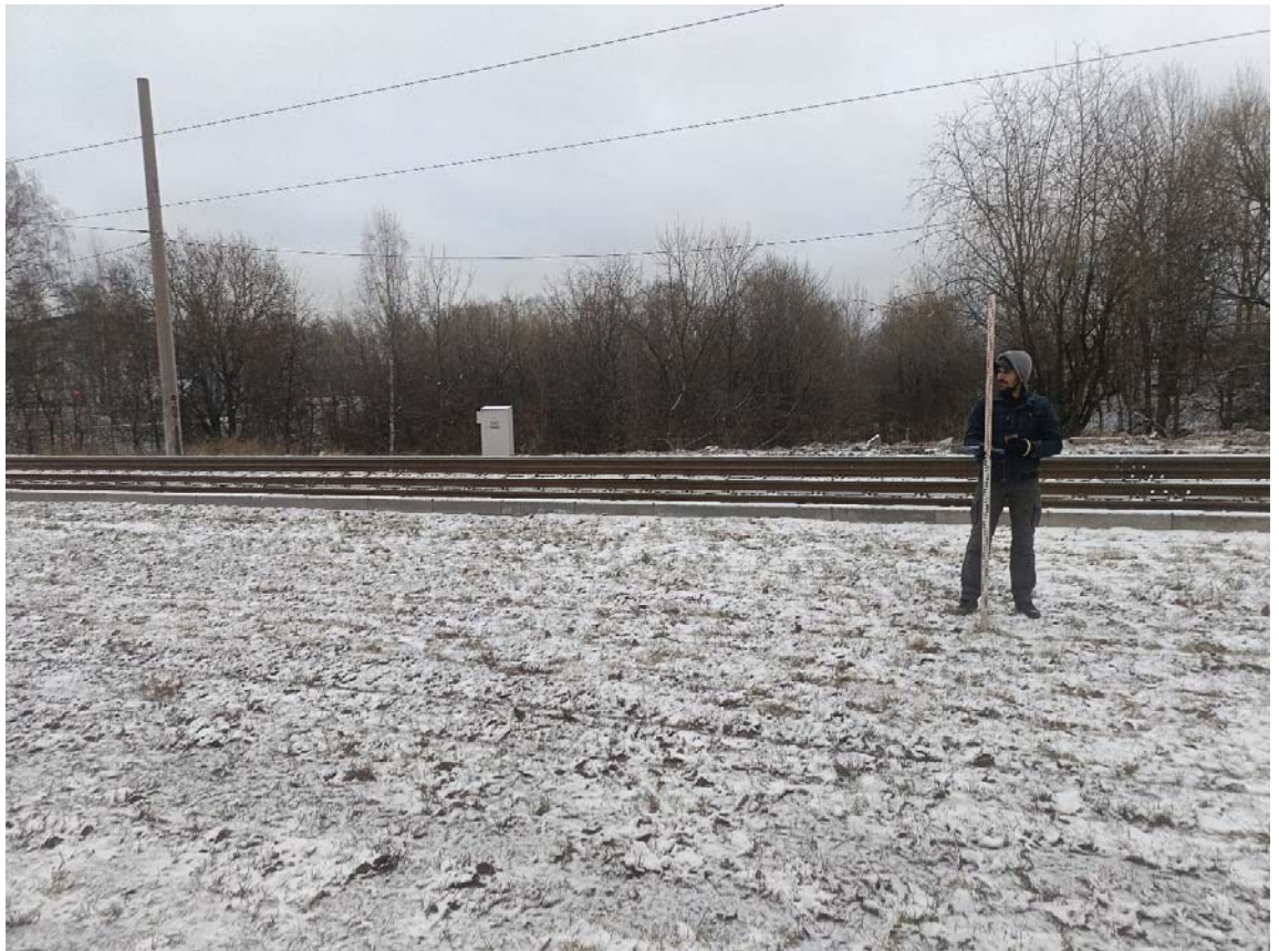
Рис. 18. СПб-2024. Транспортная развязка Северный-Руставели. Точка фотофиксации 2, вид с запада.
