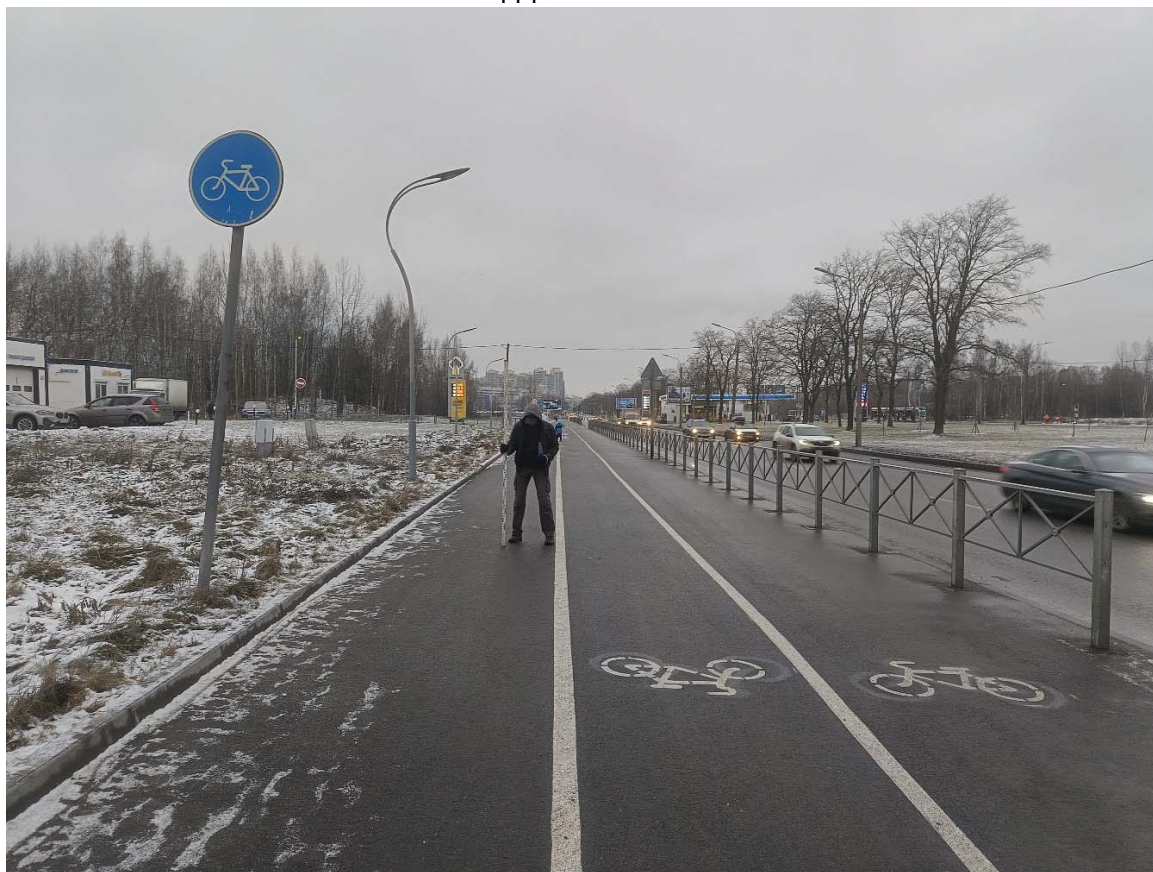
Рис. 61. СПб-2024. Транспортная развязка Северный-Руставели. Точка фотофиксации 14, вид с юга.
