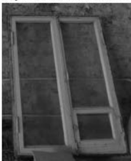
Рис. 2. Историческая расстекловка оконного заполнения ОК – 2 кв. № 12 (окно было окрашено с внутренней стороны)
