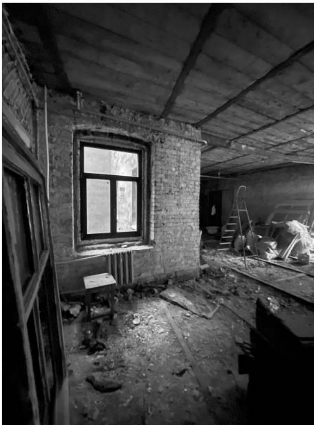
8. Фрагмент интерьера коридора (помещение 11/14.9);
