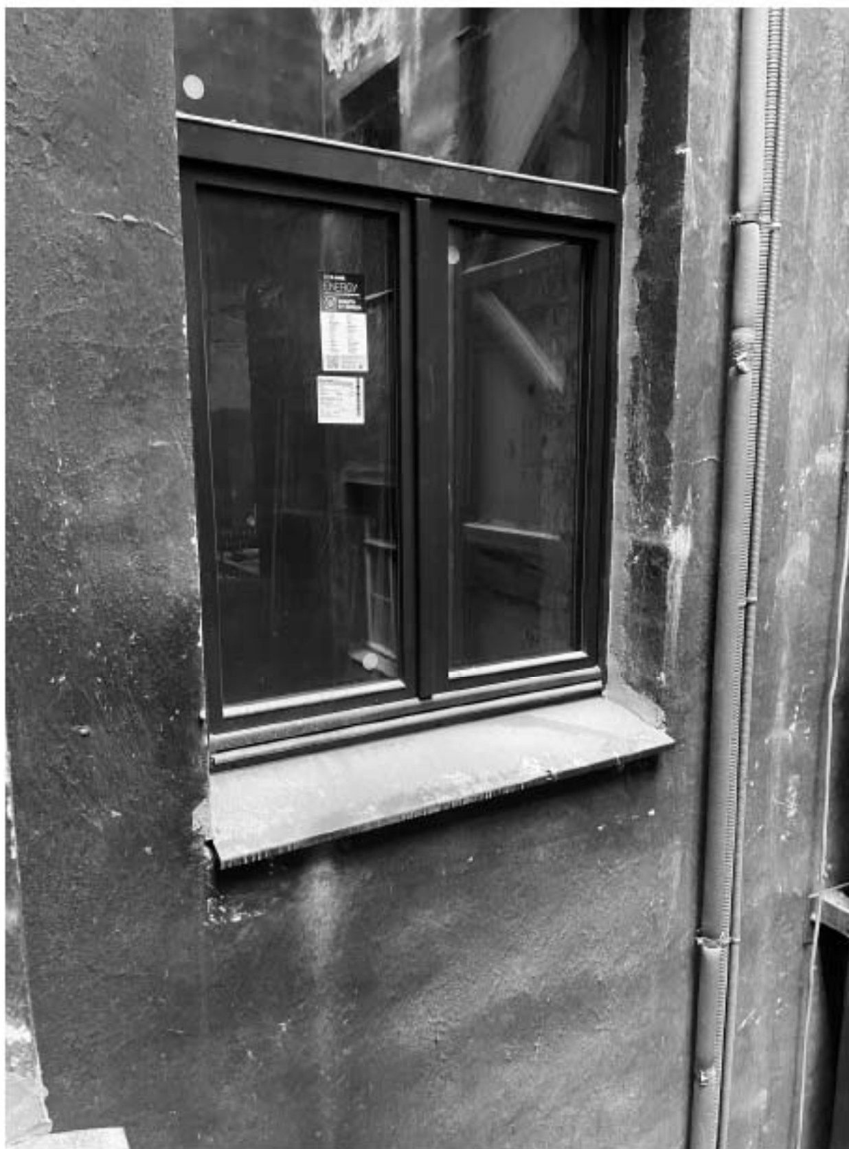
9. Вид на оконное заполнение из квартиры,
