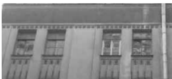
Рис. 3. Исторический цвет оконных заполнений
