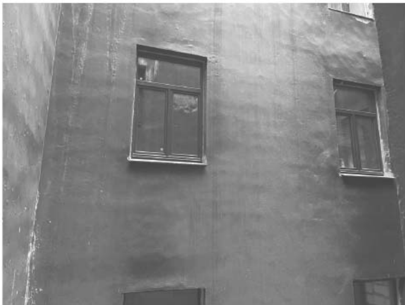
9.1. Вид на оконные заполнения квартиры со стороны подъезда;
