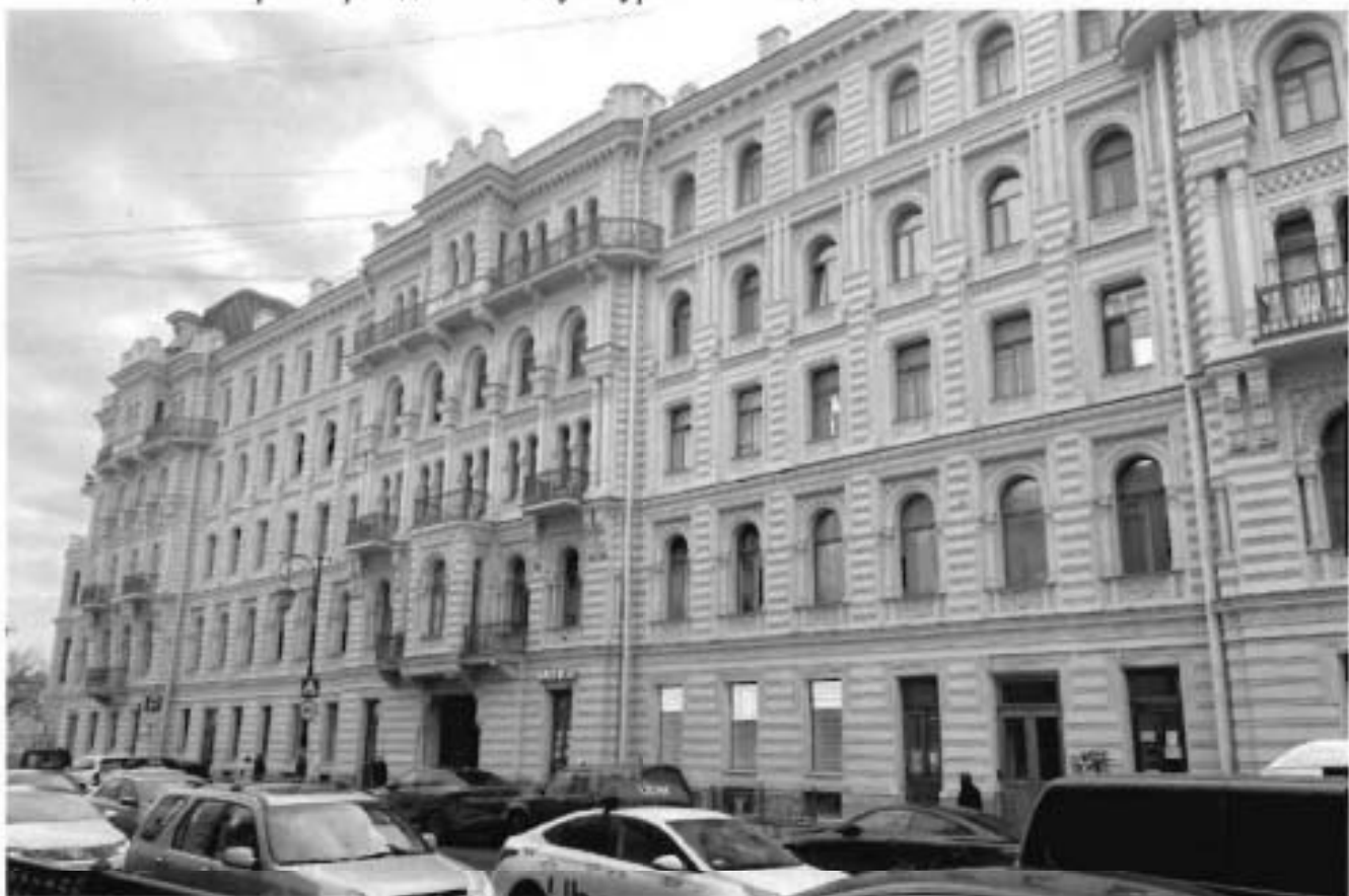
2. Вид на северный фасад объекта культурного наследия.
