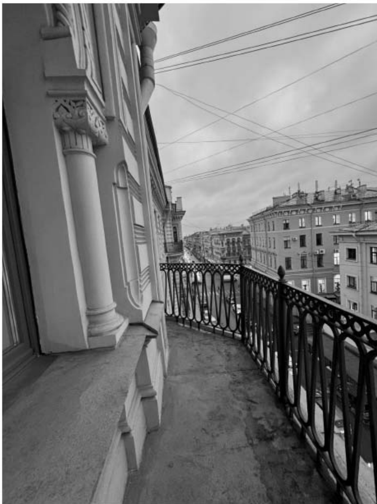
Фото 33. Южный балкон квартиры № 34 объекта культурного наследия.
