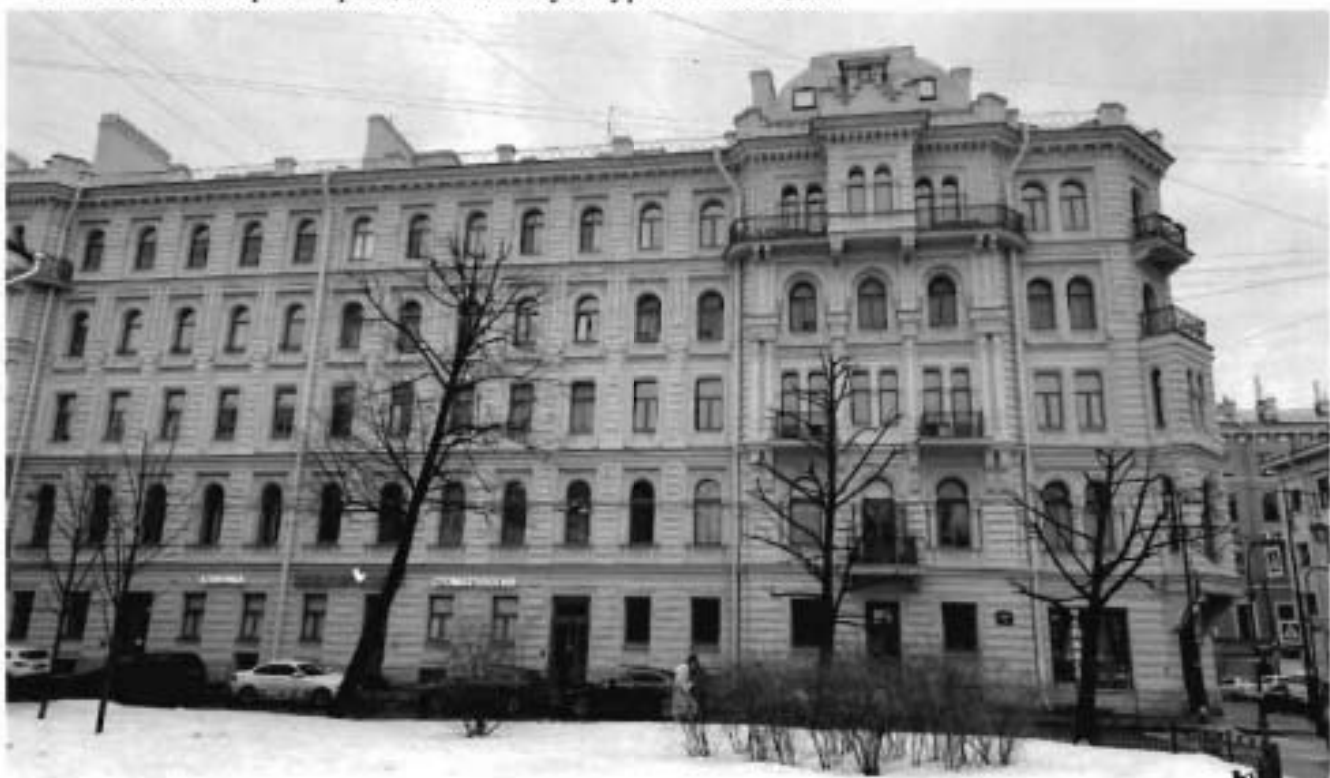
3. Вид на северный фасад объекта культурного наследия.
