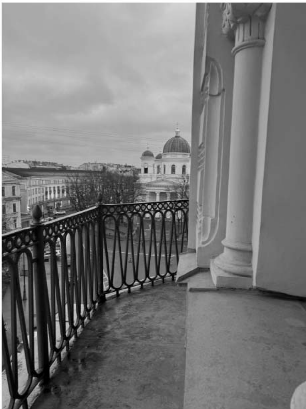
Фото 26. Северный балкон квартиры № 34 объекта культурного наследия.
