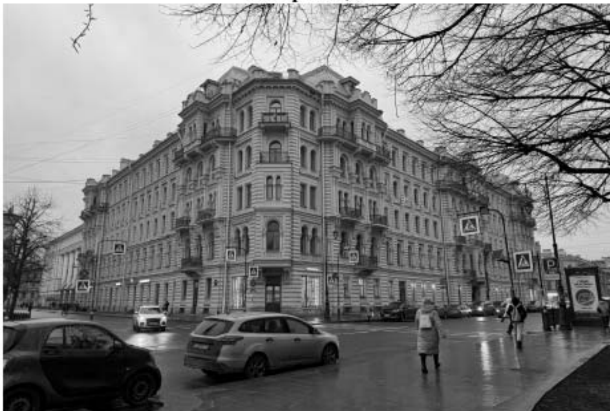
Фото 1. Фасады объекта культурного наследия на перекрестке улицы Короленко и улицы Пестеля.
