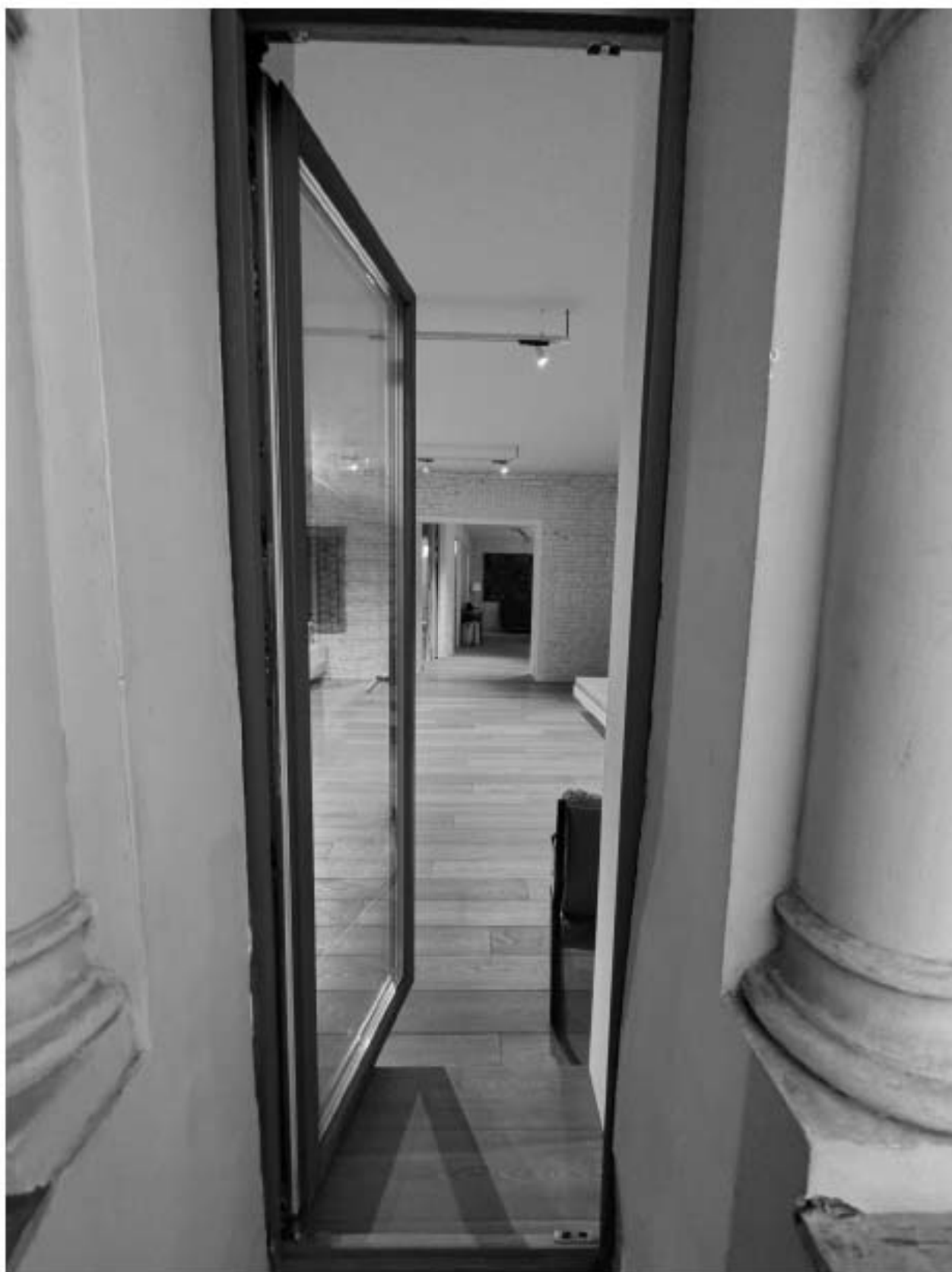
Фото 34. Дверное заполнение южного балкона квартиры № 34 объекта культурного наследия.
