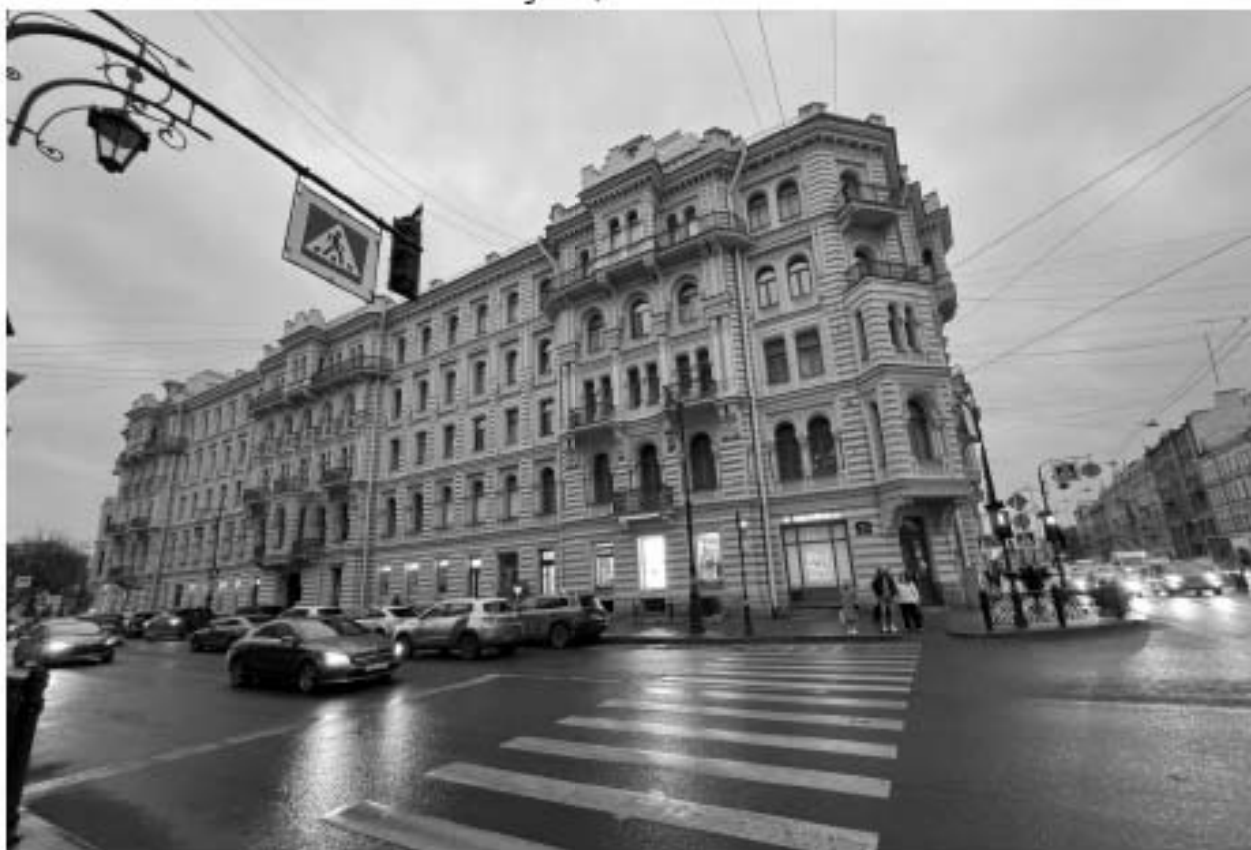
Фото 2. Фасад объекта культурного наследия на улице Пестеля.
