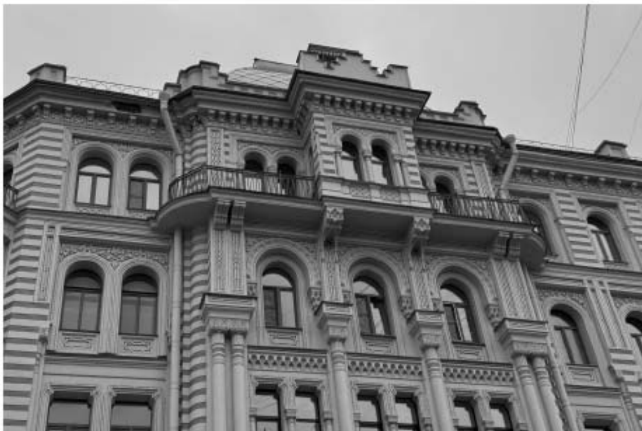
Фото 5. Фрагмент фасада объекта культурного наследия по улице Пестеля.
