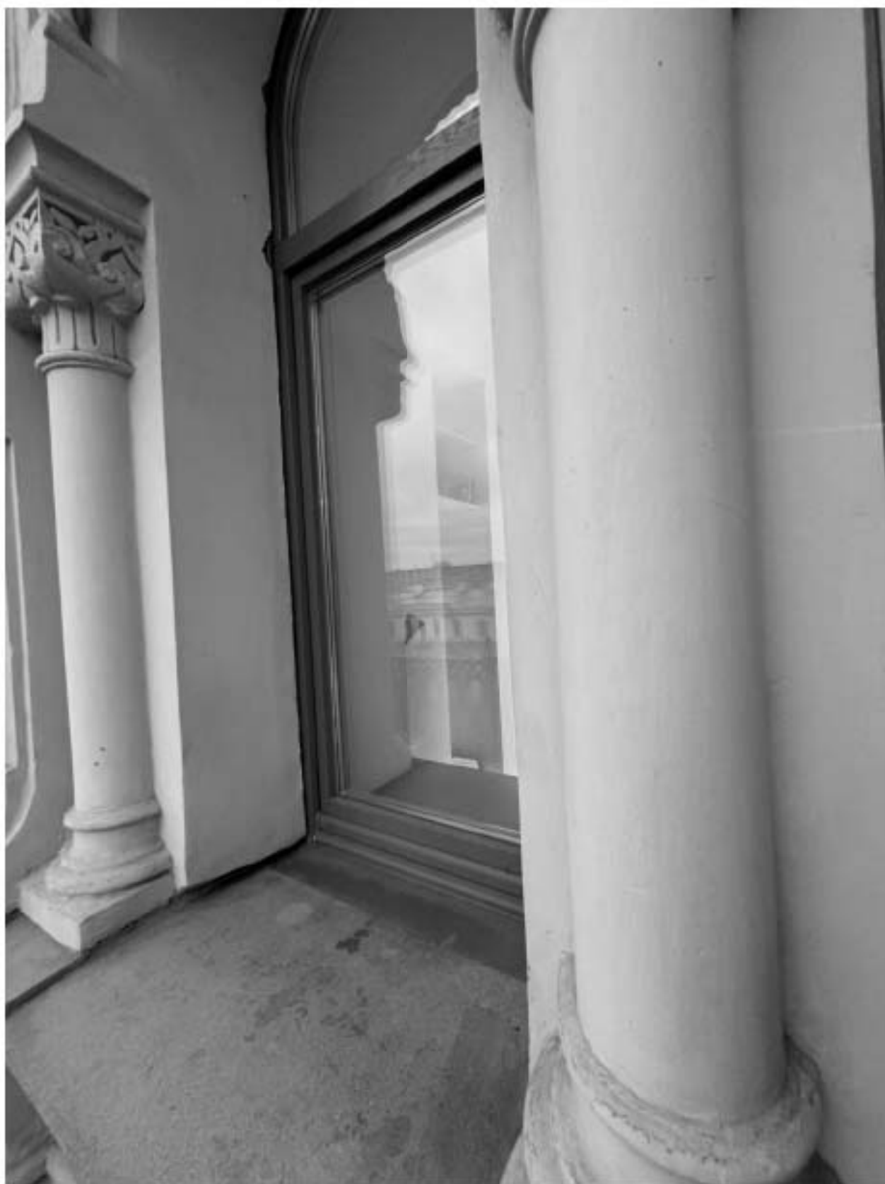
Фото 28. Оконное заполнение северного балкона квартиры № 34 объекта культурного наследия.
