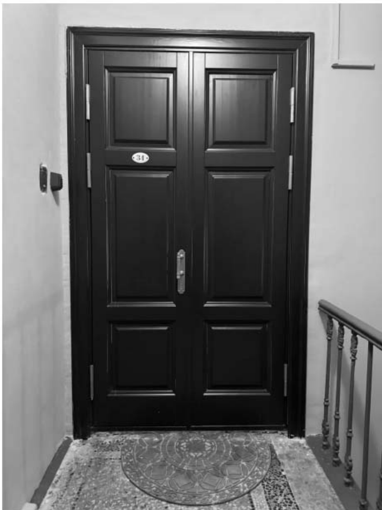
Фото 10. Входное дверное заполнение, ведущее в квартиру № 34 объекта культурного наследия.
