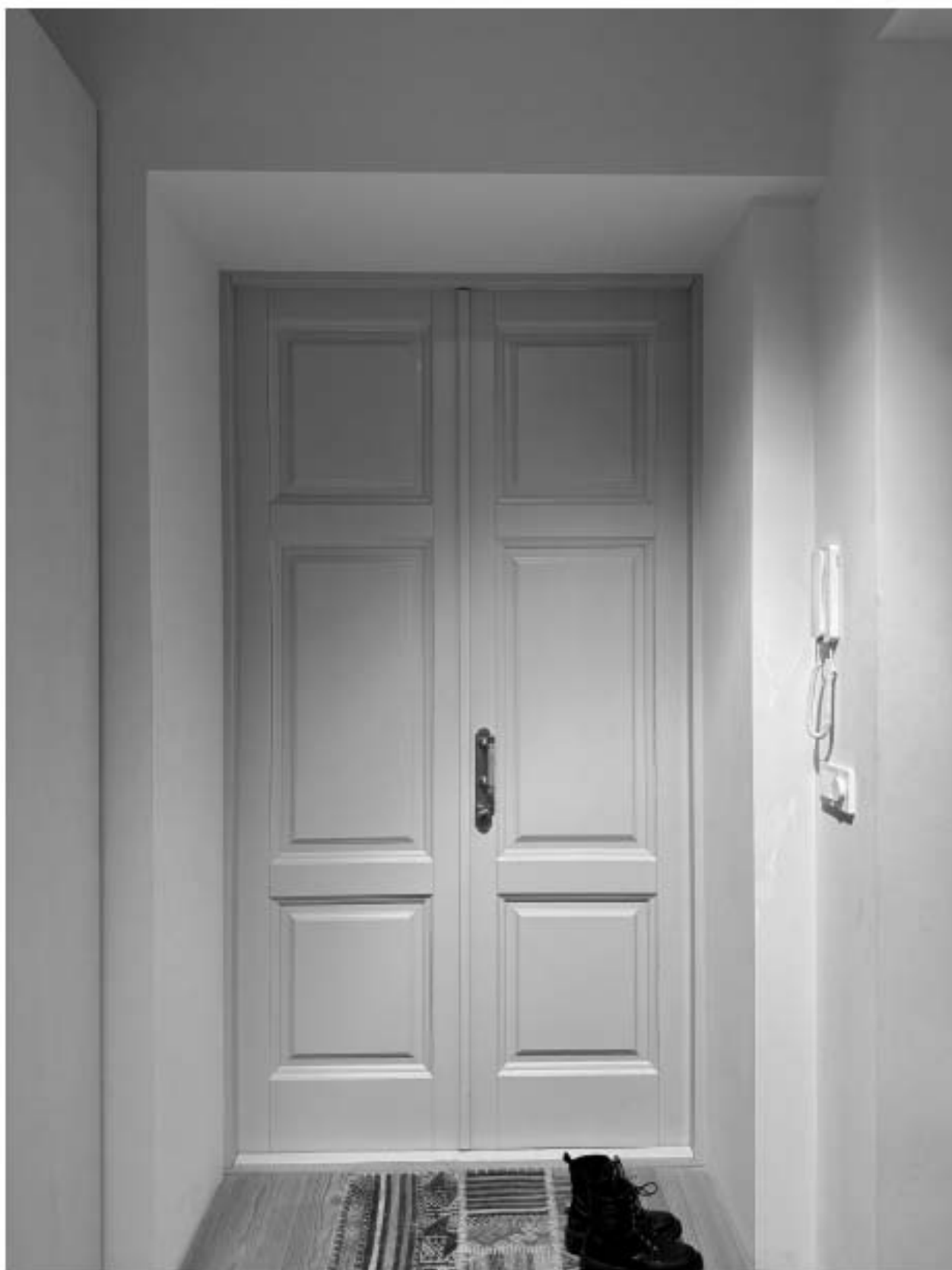
Фото 11. Вид на входное дверное заполнение квартиры № 34 объекта культурного наследия.
