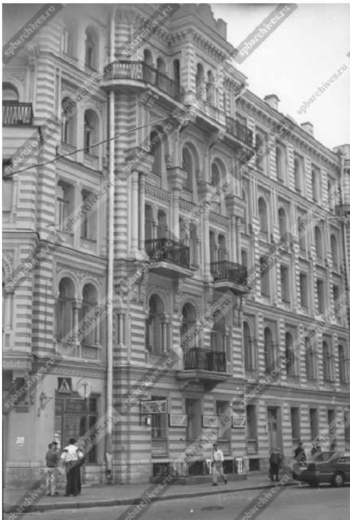
34. Фрагмент главного фасада Дома Мурузи (Литейный проспект, 24) со стороны ул. Пестеля, 1996 г. Источник: ЦГАКФФД СПб. Опись 1АР-204. Ед.хр.264801
