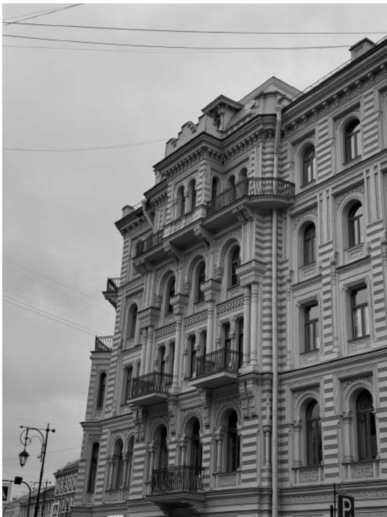
Фото 4. Фрагмент фасада объекта культурного наследия по улице Пестеля.
