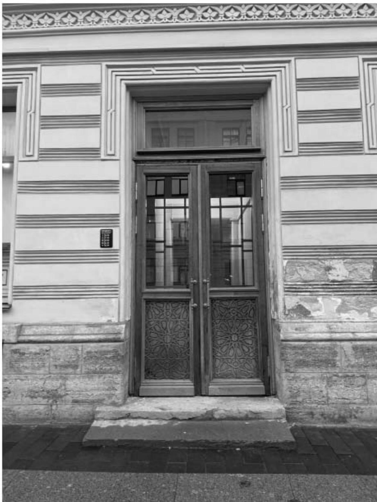
Фото 6. Фрагмент фасада со входной группой объекта культурного наследия по улице Пестеля.
