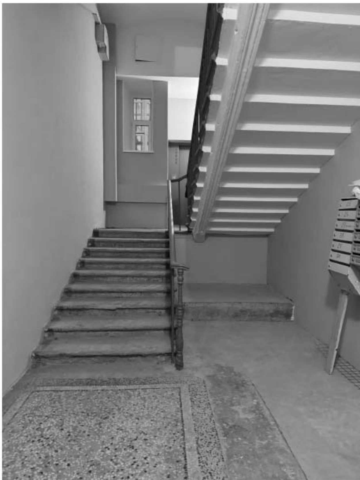
Фото 8. Общий вид лестницы объекта культурного наследия, ведущей в квартиру № 34, в уровне 1-го этажа.
