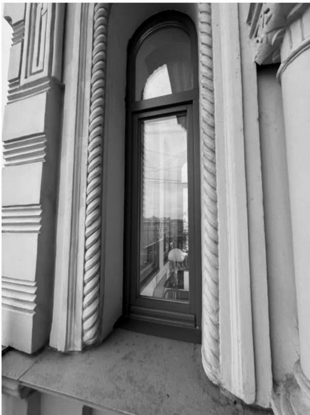
Фото 31. Оконное заполнение южного балкона квартиры № 34 объекта культурного наследия.
