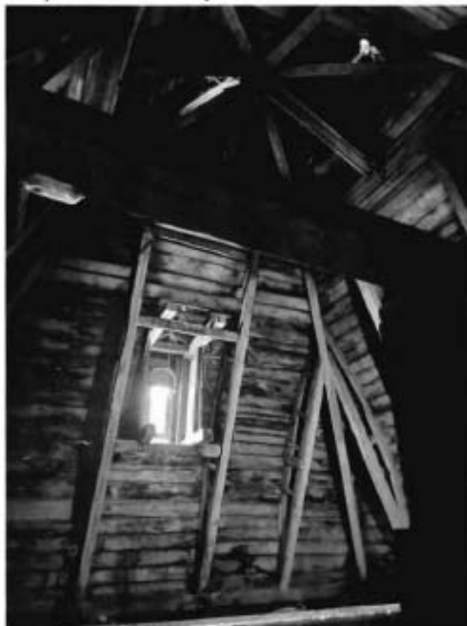
24. Мансардный объем по ул. Пестеля с восточной стороны.
