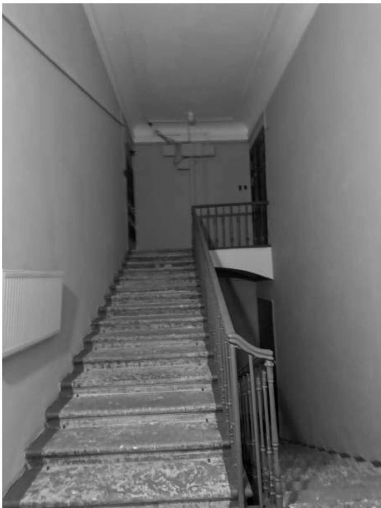
Фото 9. Общий вид лестницы объекта культурного наследия, ведущей в квартиру № 34, в уровне 4-го этажа.
