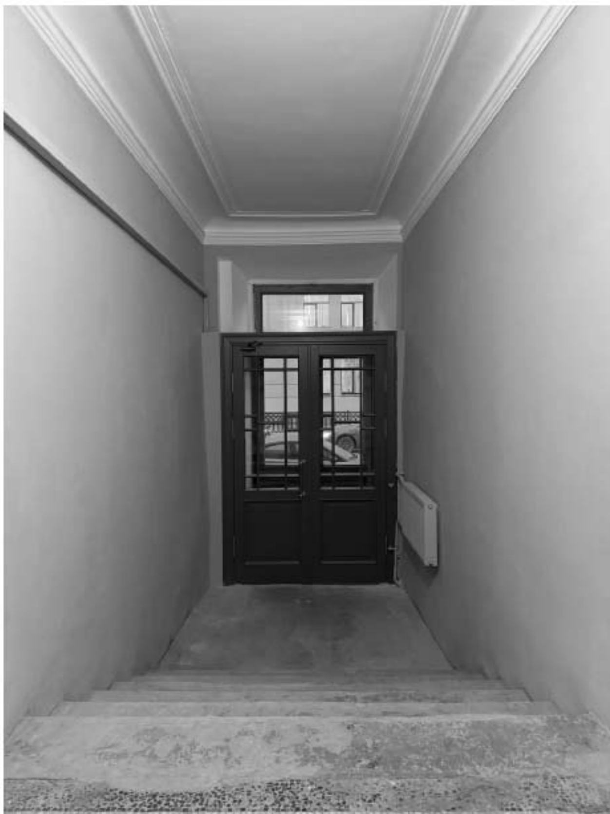
Фото 7. Интерьер вестибюля и лестницы всхода парадной объекта культурного наследия, ведущей в квартиру № 34.
