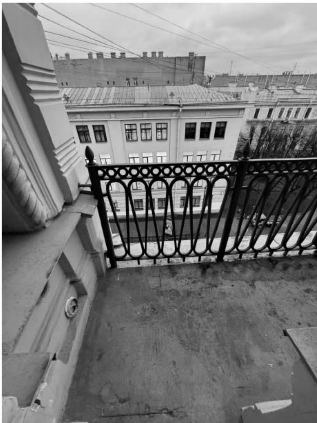
Фото 27. Северный балкон квартиры № 34 объекта культурного наследия.
