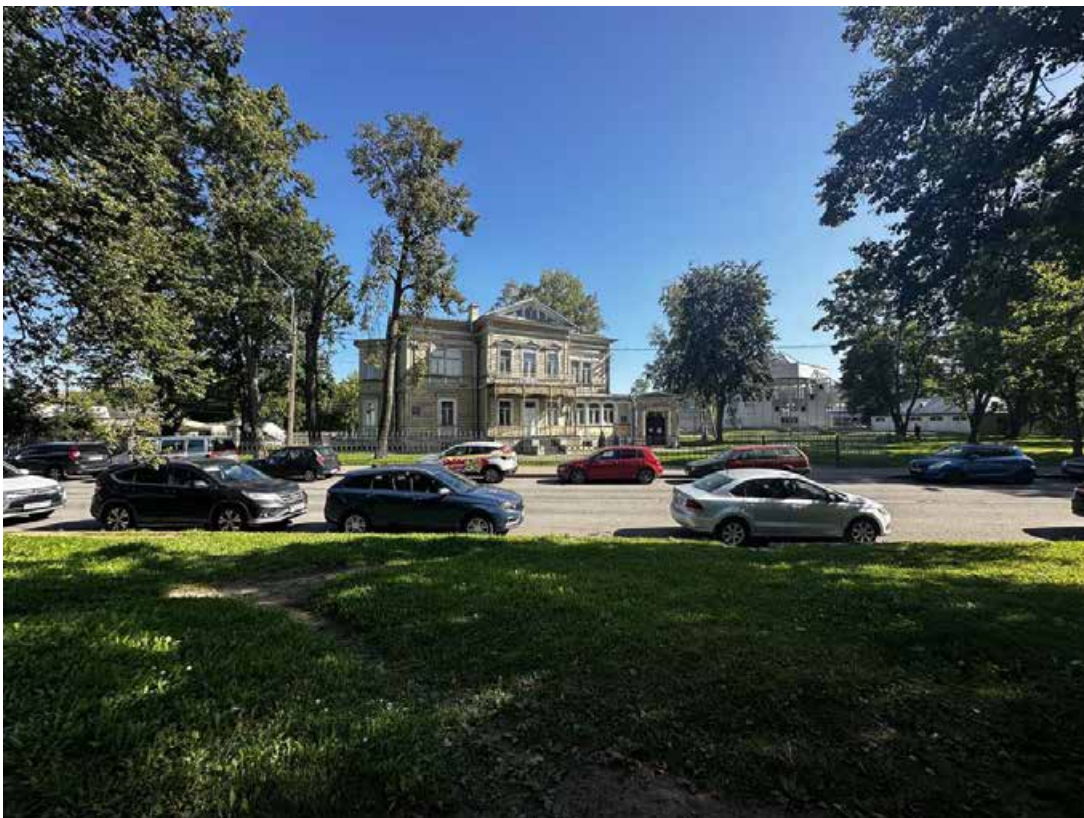
Фото 3. Общий вид объекта культурного наследия регионального значения «Дом А. Гейрота с беседкой, садом и оградой», СПб, г. Петергоф, ул. Бородачева, д. 12, литера А (быв. ул. Пролетарская, 1). Фото с севера. Дата съемки: 01.08.2024 г. Автор съемки: Быков А.М.
