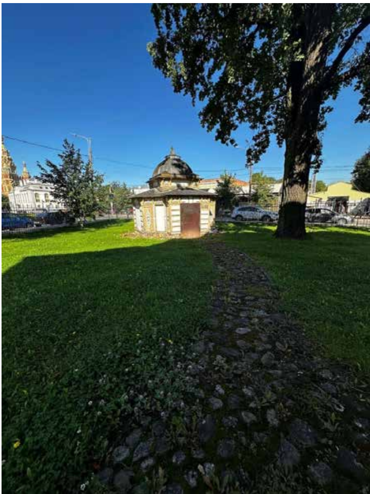
Фото 31. Территория объекта культурного наследия «Дом А. Гейрота с беседкой, садом и оградой». Северная часть участка. Брусчатая дорожка, проложенная от дома А. Гейрота к беседке. Фото с юга. Дата съемки: 01.08.2024 г. Автор съемки: Быков А.М.
