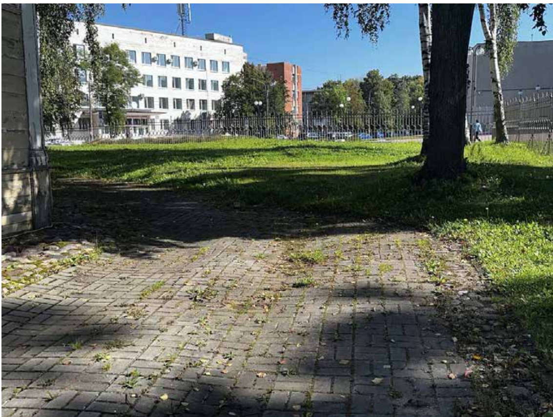
Фото 16. Территория объекта культурного наследия «Дом А. Гейрота с беседкой, садом и оградой». Брусчатая отмостка и покрытие из тротуарной плитки в южной части участка. Фото с запада. Дата съемки: 01.08.2024 г. Автор съемки: Быков А.М.
