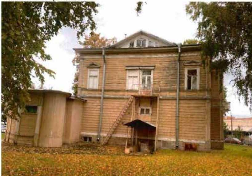
4. Общий вид на южный фасад здания.
