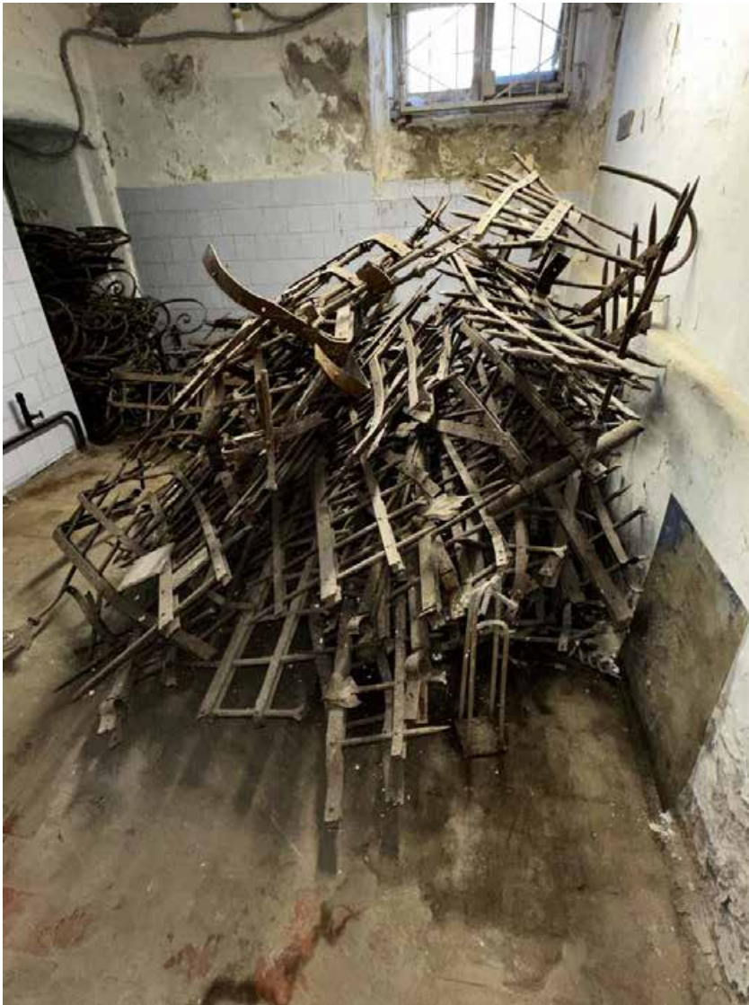
Фото 39. Фрагменты исторической металлической ограды объекта культурного наследия «Дом А. Гейрота с беседкой, садом и оградой», хранящиеся в подвале здания. Дата съемки: 01.08.2024 г. Автор съемки: Быков А.М.
