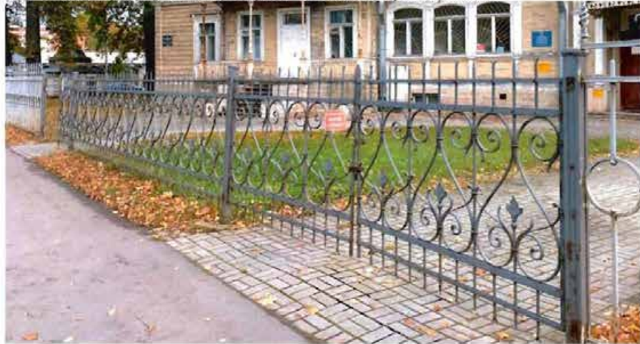
34. Общий вид на ограду, расположенную с западной стороны участка.
