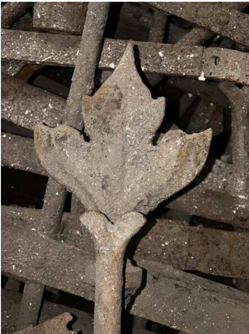
Фото 41. Декоративный элемент фрагмента исторической металлической ограды объекта культурного наследия «Дом А. Гейрота с беседкой, садом и оградой», хранящийся в подвале здания. Дата съемки: 01.08.2024 г. Автор съемки: Быков А.М.
