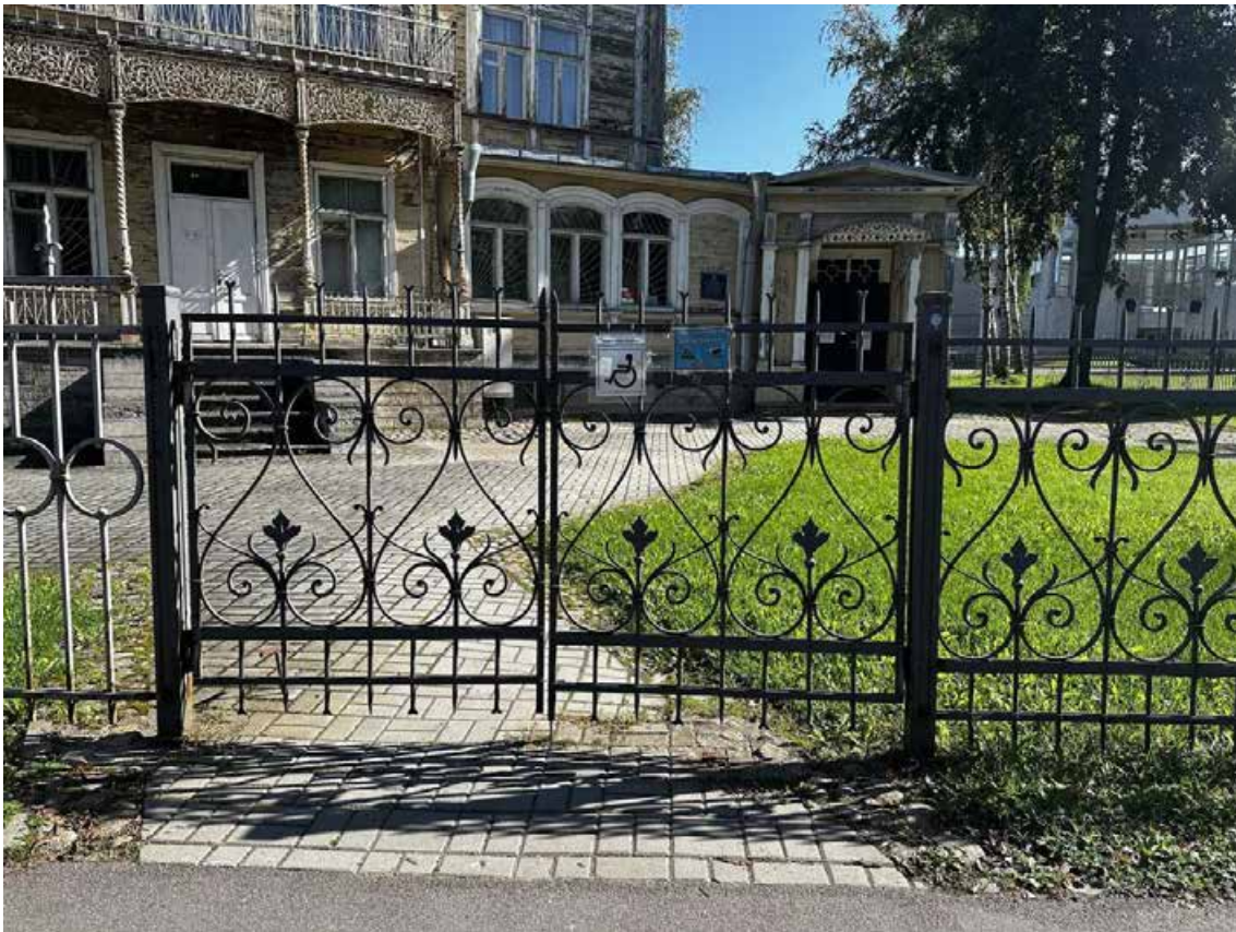
Фото 35. Металлическая ограда объекта культурного наследия «Дом А. Гейрота с беседкой, садом и оградой». Фрагмент ограды (калитка), восстановленный с включением исторических элементов. Фото с запада. Дата съемки: 01.08.2024 г. Автор съемки: Быков А.М.
