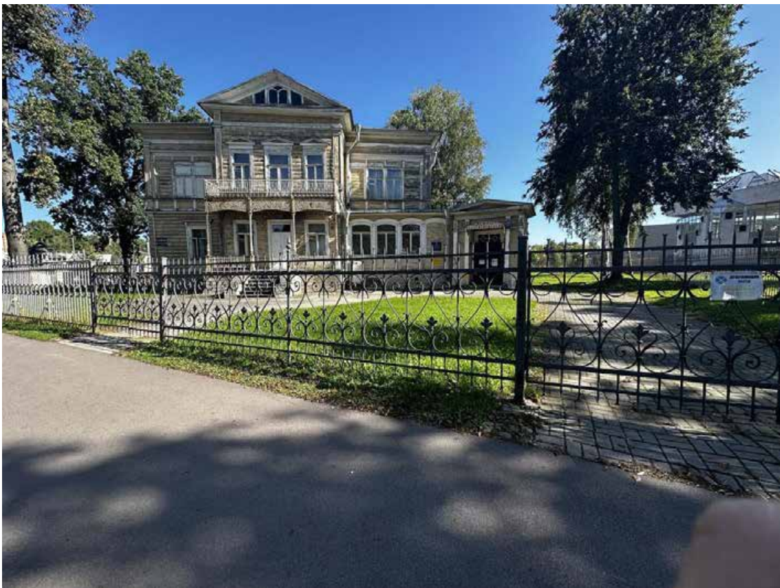
Фото 5. Общий вид дома А. Гейрота с запада. Дата съемки: 01.08.2024 г. Автор съемки: Быков А.М.
