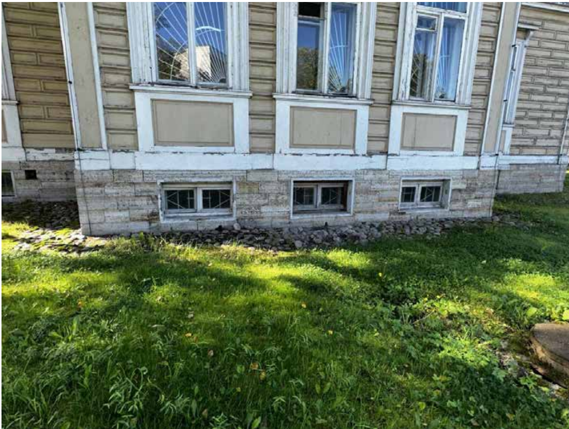
Фото 23. Территория объекта культурного наследия «Дом А. Гейрота с беседкой, садом и оградой». Брусчатая отмостка и газон перед северо-восточным фасадом здания. Фото с востока. Дата съемки: 01.08.2024 г. Автор съемки: Быков А.М.
