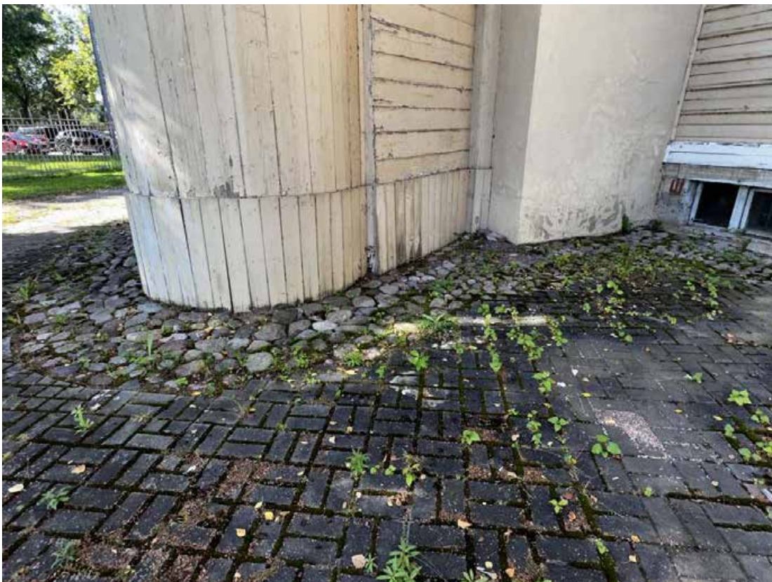
Фото 19. Территория объекта культурного наследия «Дом А. Гейрота с беседкой, садом и оградой». Брусчатая отмостка и покрытие из тротуарной плитки в южной части участка. Фото с юго-востока. Дата съемки: 01.08.2024 г. Автор съемки: Быков А.М.
