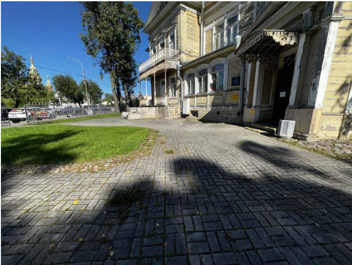
Фото 15. Территория объекта культурного наследия «Дом А. Гейрота с беседкой, садом и оградой». Брусчатая отмостка и покрытие из тротуарной плитки в юго-западной части участка. Фото с юга. Дата съемки: 01.08.2024 г. Автор съемки: Быков А.М.
