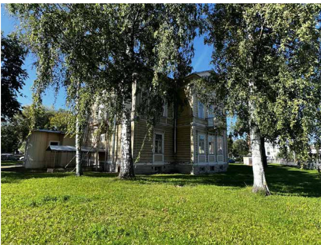
Фото 28. Территория объекта культурного наследия «Дом А. Гейрота с беседкой, садом и оградой». Газон в восточной части участка. Фото с востока. Дата съемки: 01.08.2024 г. Автор съемки: Быков А.М.
