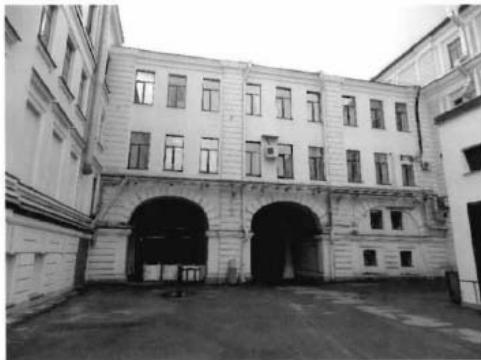
17. Вид на северный фасад (корпус 20).
