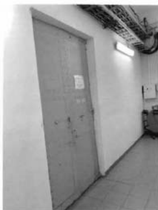
23. Дверное заполнение коридора 1-го этажа.
