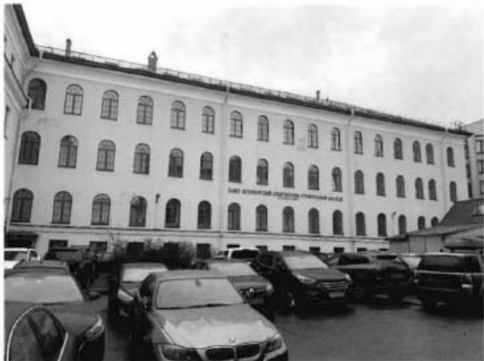
3. Вид на южный фасад.
