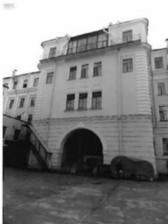
19. Вид на северный фасад (корпус 1).
