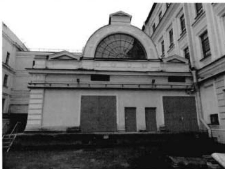
2. Вид на северный фасад объекта культурного наследия.
