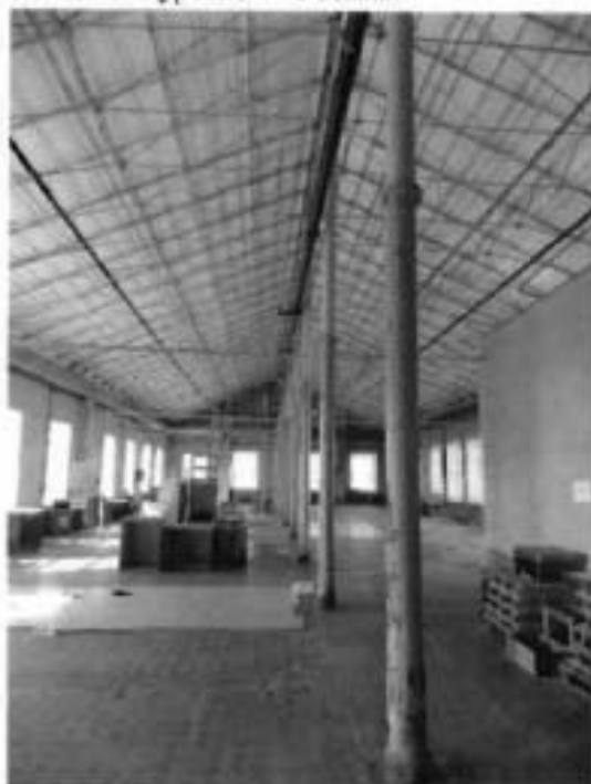
22. Конструкции крыши. Колонны в уровне 4-го этажа.
