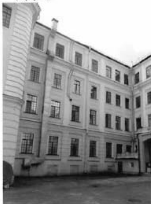
21. Вид на северный (дворовый) фасад (корпус 1).
