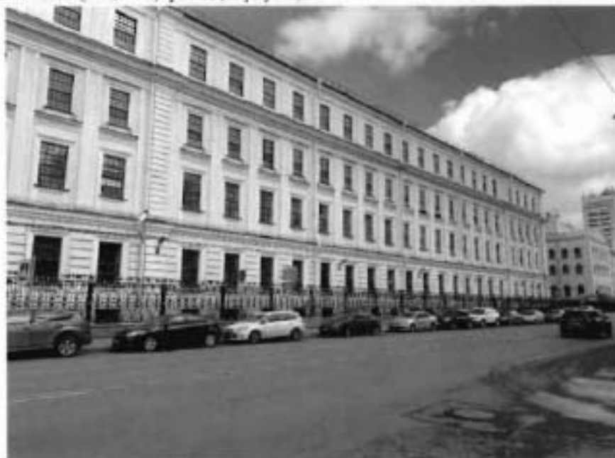
15. Вид на южный (лицевой) фасад (корпус 1).
