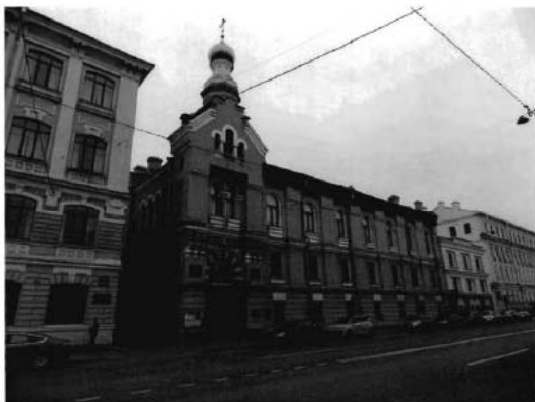
1. Вид на лицевой (южный) фасад.
