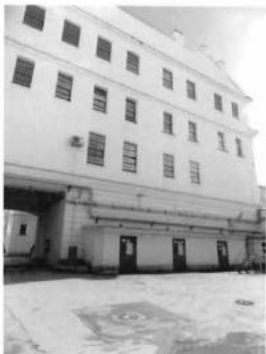
18. Вид на западный фасад (корпус 1).
