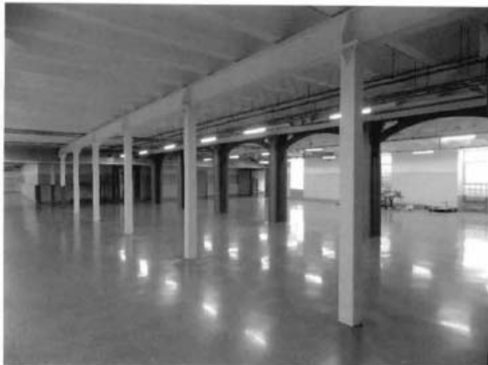
33. Колонны 2-го этажа.
