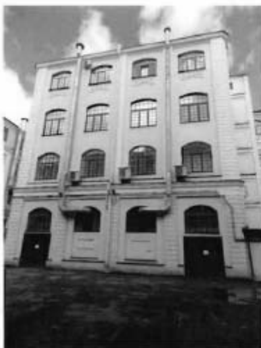
24. Вид на южный фасад (корпус 7).
