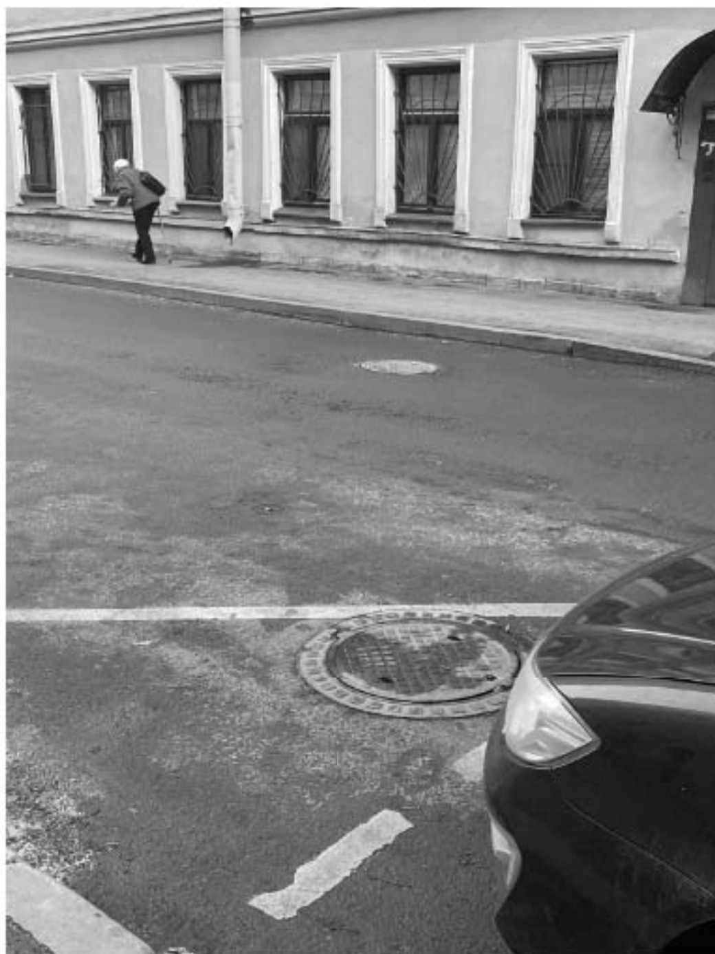
Фото 4. Дерзгский переулок. Существующие смотровые колодцы. Фото Васильева Н. В. (03.12.2024 г.)
