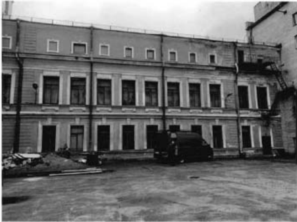
2. Вид на северный фасад объекта культурного наследия.
