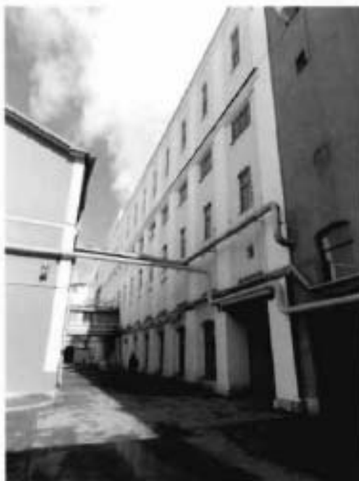
34. Вид на западный дворовый фасад.
