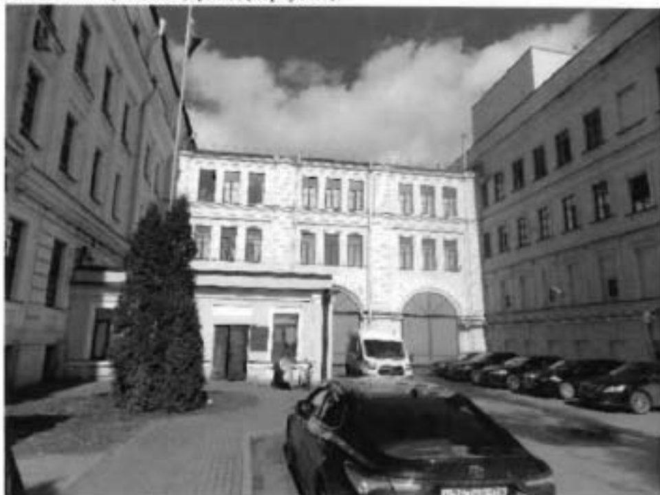
16. Вид на южный (лицевой) фасад (корпус 20).
