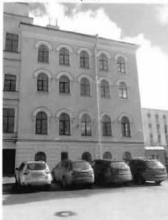
10. Вид на западный фасад
