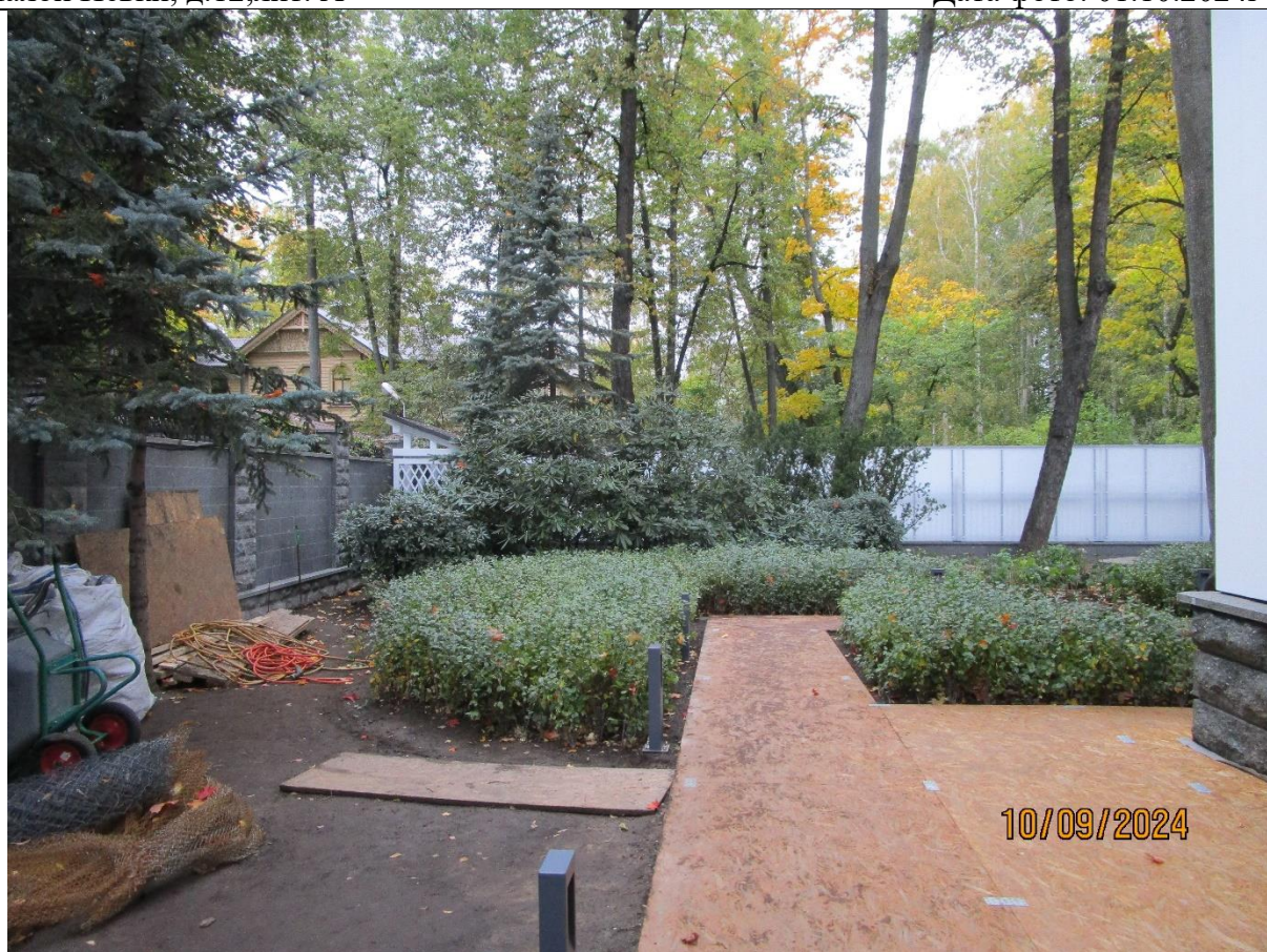
18. Северо-западная часть территории. Вид на северную ограду. Объект культурного наследия регионального значения «Парк «Тихий отдых», по адресу: г. Санкт-Петербург, наб. реки Малой Невки, д.12,лит. А Дата фото: 01.10.2024г
