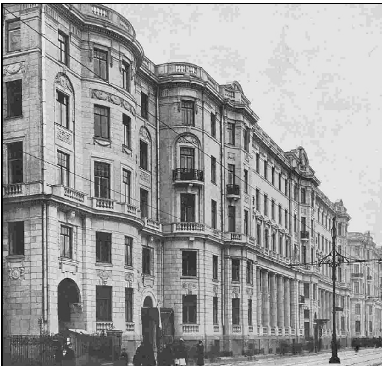
Илл. 35. Объект культурного наследия федерального значения «Дом, где в 1926-1934 гг. в квартире 20 жил секретарь Ленинградского губкома ВКП(б) Киров С.М.» по адресу: г. Санкт-Петербург, Каменноостровский пр., д. 26-28, лит. А. Лицевой корпус Доходного дома Первого Российского страхового общества. Общий вид здания с Каменноостровского проспекта. Фотография. 1913 г. Журнал «Зодчий».
