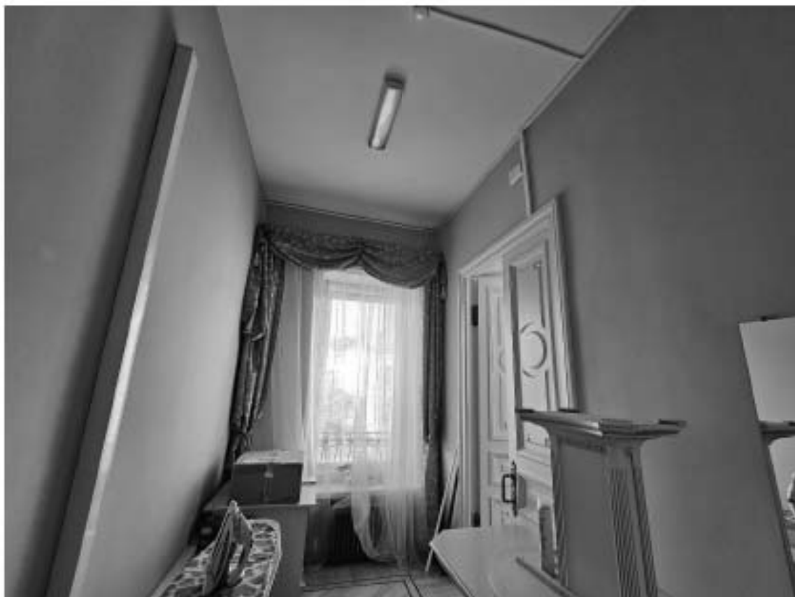
45. Объект культурного наследия регионального значения «Особняк с флигелем инженера А.А. Экарева», по адресу: г. Санкт-Петербург, Суворовский проспект, дом 41, литера А. Общий вид пом. 4-Н (23) в уровне 2-го этажа.
