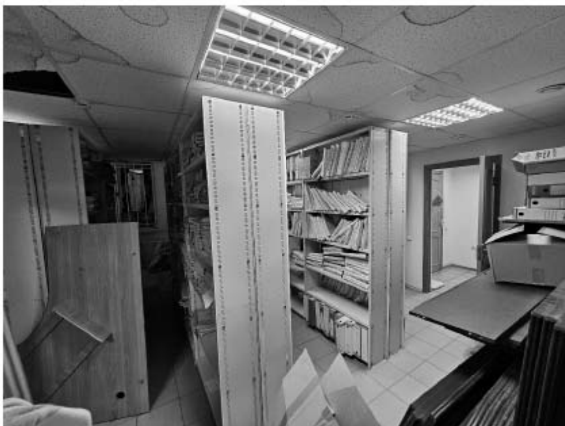
20. Объект культурного наследия регионального значения «Особняк с флигелем инженера А.А. Экарева», по адресу: г. Санкт-Петербург, Суворовский проспект, дом 41, литера А. Общий вид пом. 1-Н (2-4) в уровне цокольного этажа.
