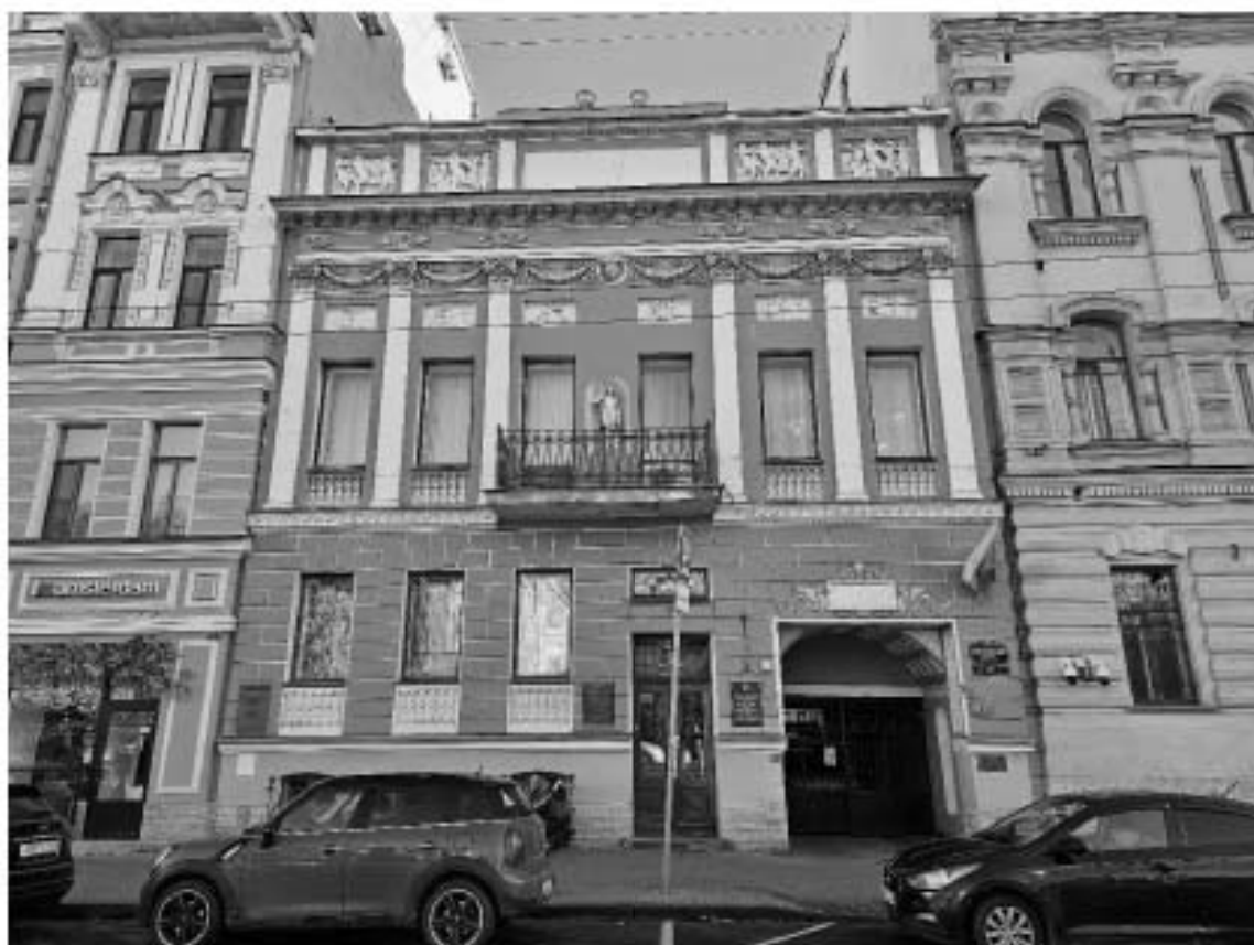
3. Объект культурного наследия регионального значения «Особняк с флигелем инженера А.А. Экарева», по адресу: г. Санкт-Петербург, Суворовский проспект, дом 41, литера А. Общий вид лицевого северо-западного фасада по Суворовскому проспекту.
