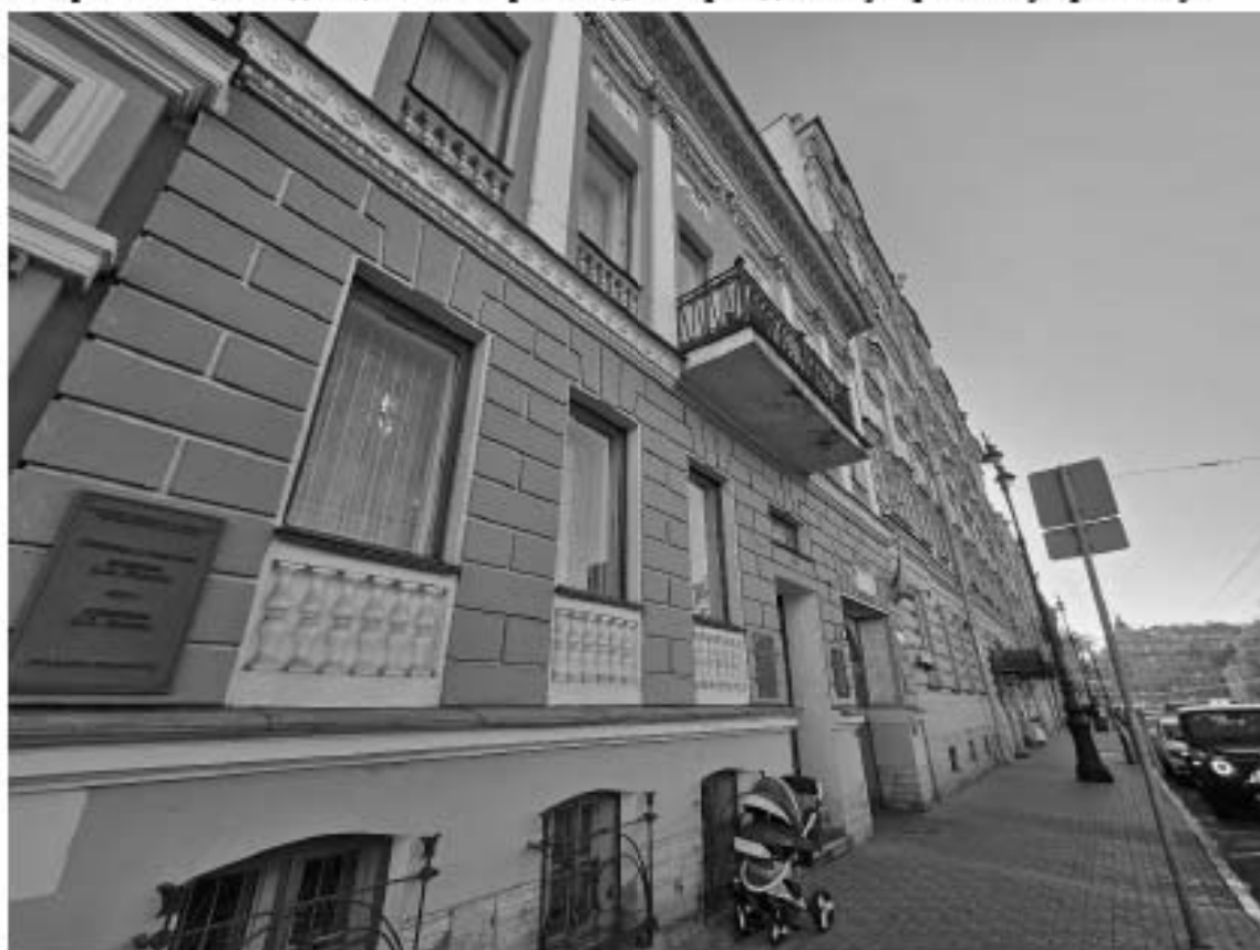
4. Объект культурного наследия регионального значения «Особняк с флигелем инженера А.А. Экарева», по адресу: г. Санкт-Петербург, Суворовский проспект, дом 41, литера А. Общий вид лицевого северо-западного фасада по Суворовскому проспекту.
