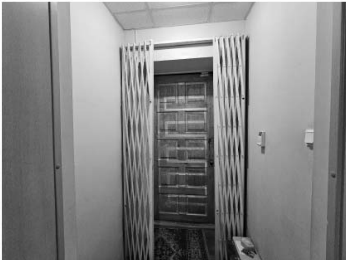
37. Объект культурного наследия регионального значения «Особняк с флигелем инженера А.А. Экарева», по адресу: г. Санкт-Петербург, Суворовский проспект, дом 41, литера А. Общий вид пом. 4-Н (14) в уровне 1-го этажа.
