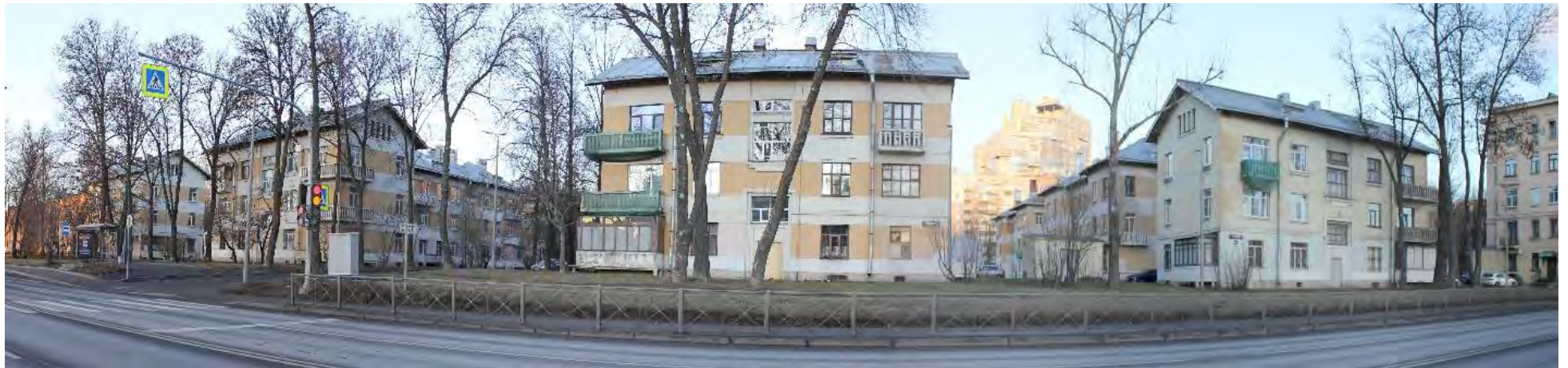
3. Объект культурного наследия регионального значения «Рабочий городок при ГРЭС “Красный Октябрь” (ТЭЦ № 5)». Панорама объекта с Октябрьской набережной. Дата фотофиксации: 26 декабря 2024 г.
