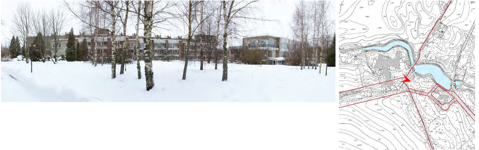
64. Земельный участок с кадастровым номером 78:42:1852102:3. Вид на существующее здание с территории ОКН (Ф) «Баболовский парк». Дата фотофиксации: 28 декабря 2024 г.
